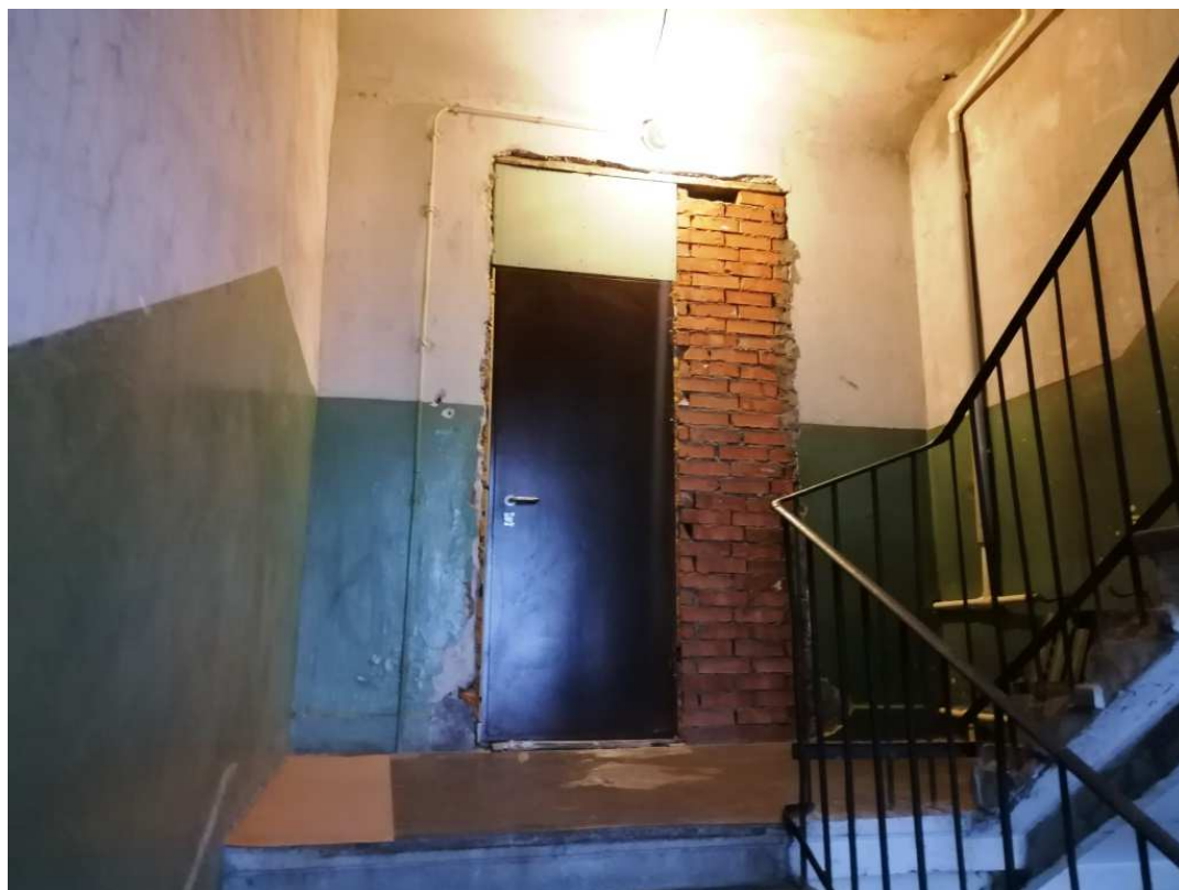
2. Вход в пом.11-Н с лестничной клетки.
