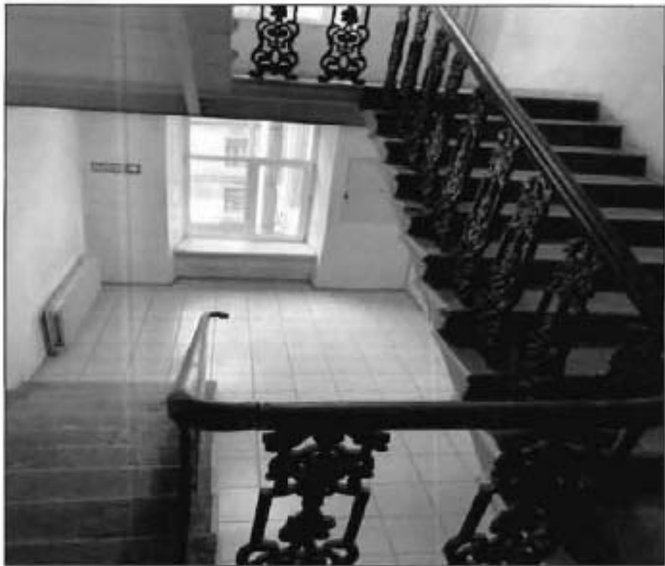
45. Двухмаршевая служебная лестница в юго-западной части корпуса по пл. Островского пом. 37-Н в уровне 3-го этажа. Фото от 19.11.2021 г.
