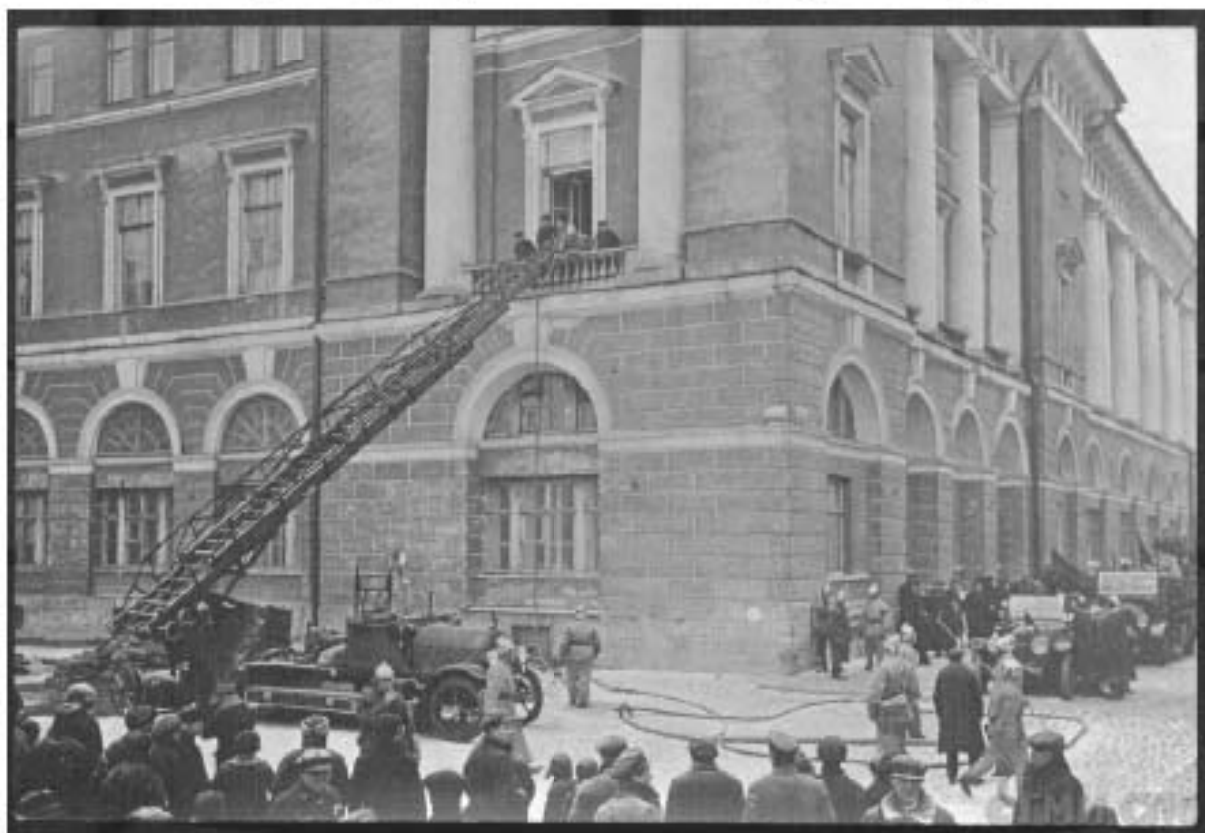
Илл. 40. Здание на углу площади Островского и улицы Зодчего Росси во время пожарной тревоги. Период создания: 1927 г. // https://goskatalog.ru/portal/#/collections?id=34747358
