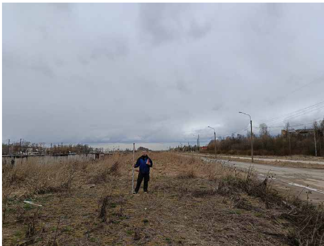
Рис. 23. Пушкин-2024. НВ. Детскосельский бульвар, ул. Подбельского. Точка фотофиксации 6, вид на север.
