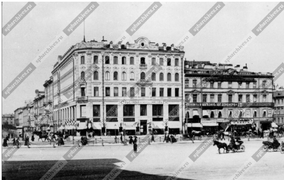
47. Фасады домов №№ 26 и 28 по Невскому проспекту. До 1902 года. ЦГАКФФД СПб. Фотодокумент А 3995.
