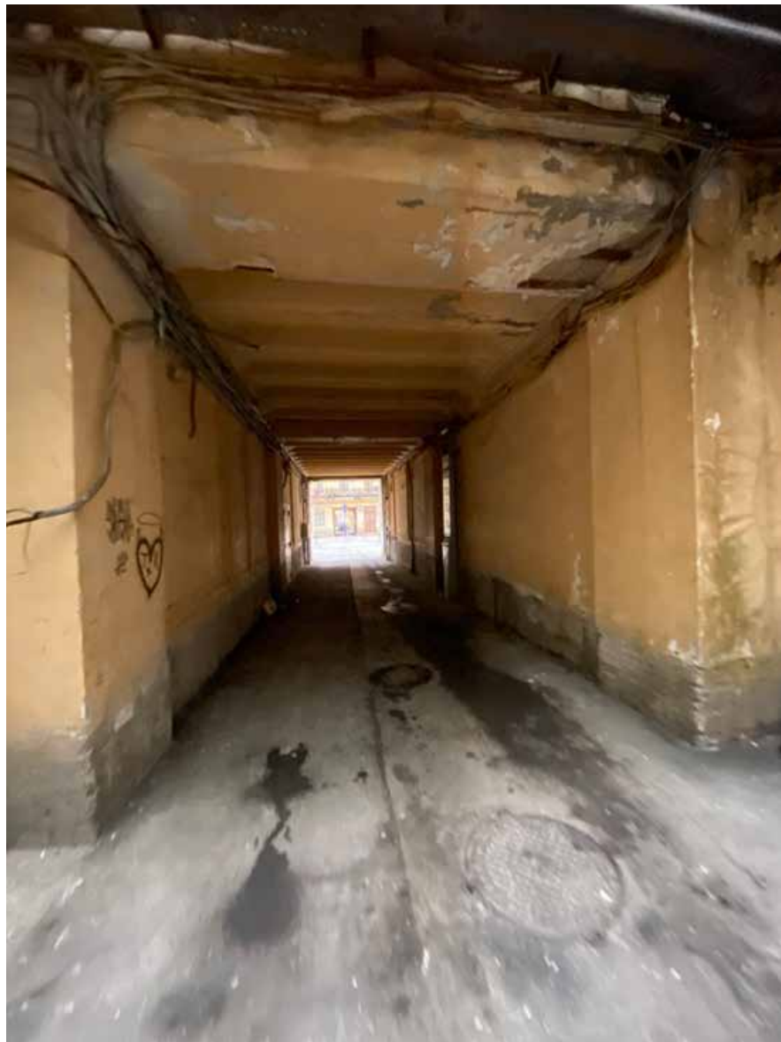
3. Здание по адресу: г. Санкт-Петербург, Малая Конюшенная улица, дом 16/26, литера А. Арка проезда
