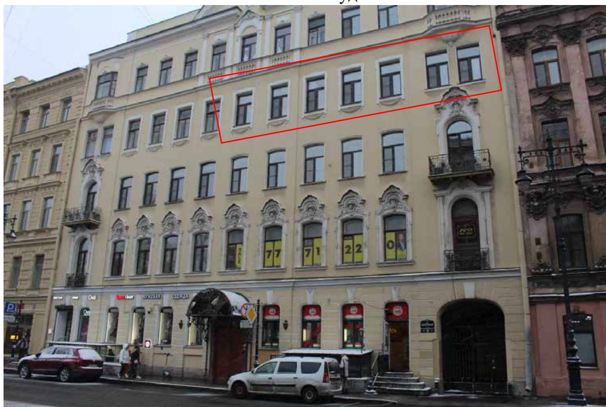
Фото 2. Вид на лицевой выявленного объекта культурного наследия регионального значения «Дом, в котором в 1892-1913 годах жил ученый-баллист Н.А. Забудский». Красным отмечены оконные проемы квартиры № 8.
