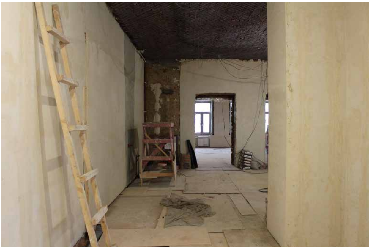
Фото 11. Выявленный объект культурного наследия «Дом, в котором в 1892-1913 годах жил ученый-баллист Н.А. Забудский». Квартира № 8. Помещения №№ 8, 9.
