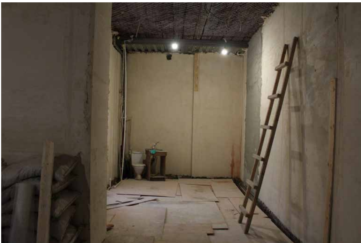
Фото 10. Выявленный объект культурного наследия «Дом, в котором в 1892-1913 годах жил ученый-баллист Н.А. Забудский». Квартира № 8. Помещения №№ 10, 11, 12, 13.
