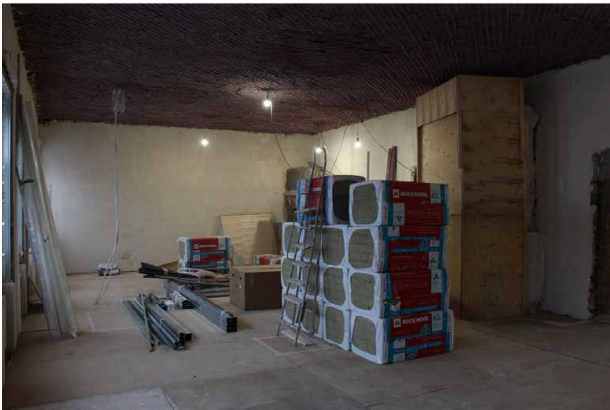
Фото 14. Выявленный объект культурного наследия «Дом, в котором в 1892-1913 годах жил ученый-баллист Н.А. Забудский». Квартира № 8. Помещения №№ 2, 3, 4, 5.
