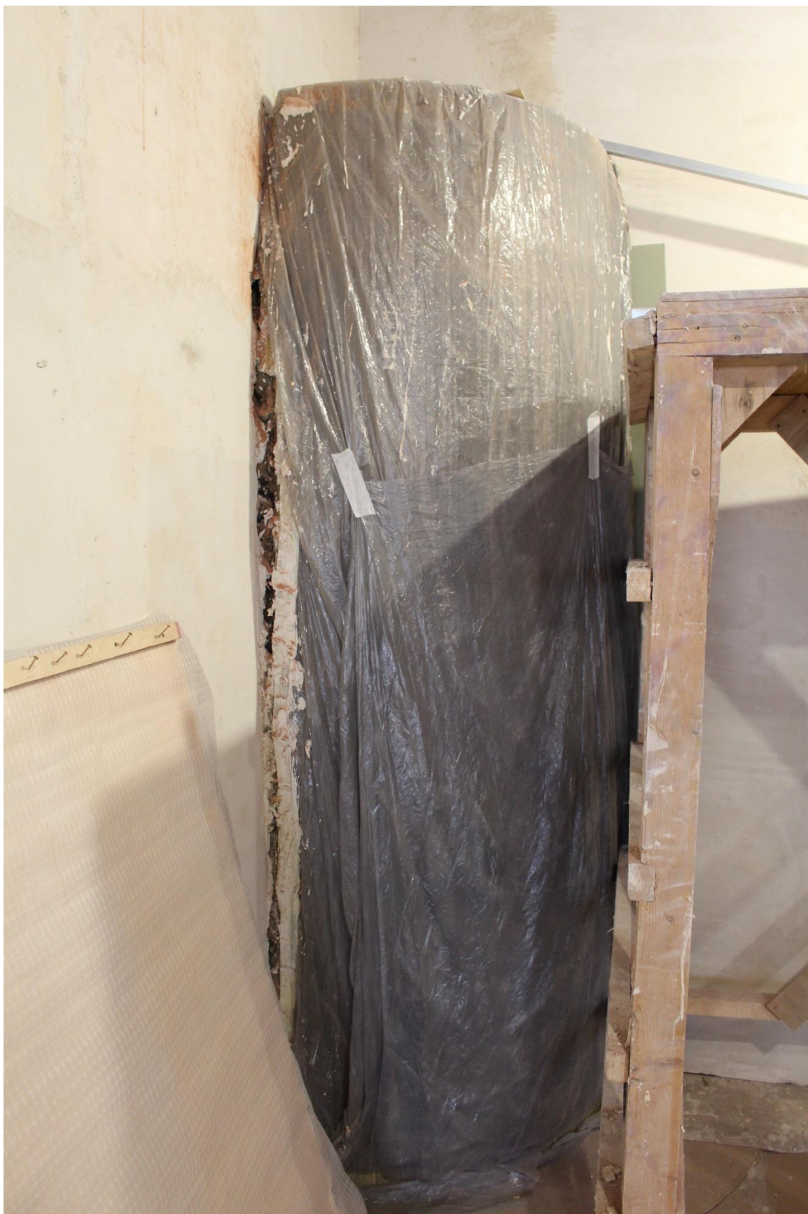
Фото 16. Выявленный объект культурного наследия «Дом, в котором в 1892-1913 годах жил ученый-баллист Н.А. Забудский». Квартира № 8. Вид на печь в помещении № 5.
