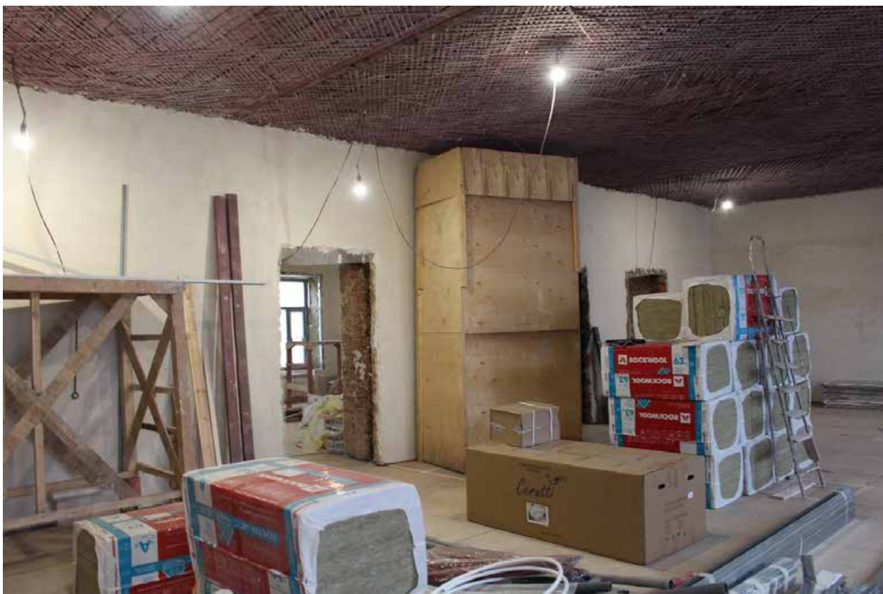
Фото 13. Выявленный объект культурного наследия «Дом, в котором в 1892-1913 годах жил ученый-баллист Н.А. Забудский». Квартира № 8. Помещения №№ 2, 3, 4, 5.
