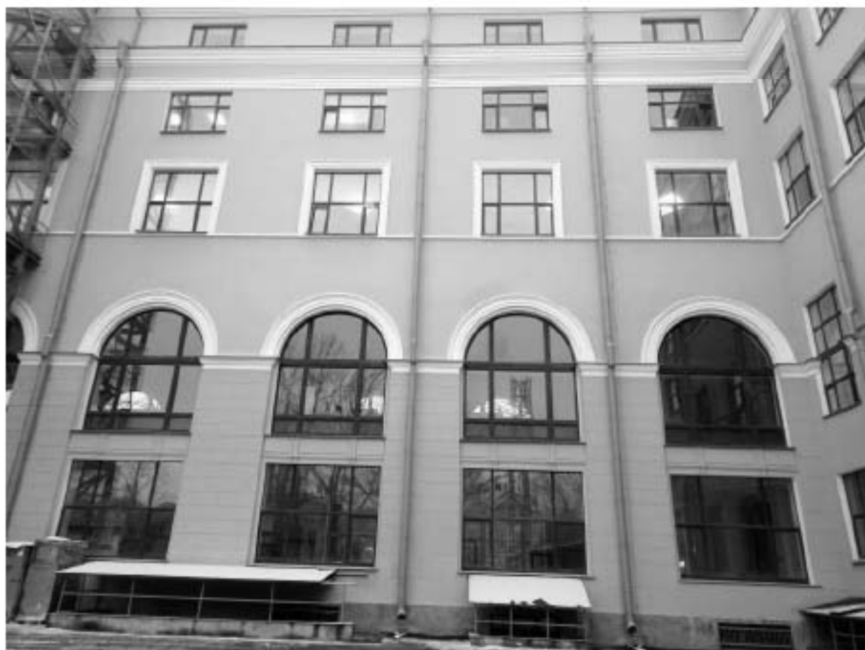
38. ОКНРЗ «Дворец пушкинъ». Фрагмент северной части восточного фасада. 15.01.2024г.
