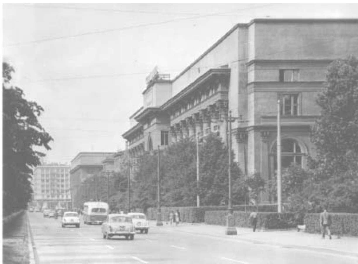
87. Общий вид здания Ленинградского отделения Всесоюзного объединения «Союзпушнина» на Московском проспекте, дом № 98. 1970г. ЦГАКФФД СПб. Бр 62000.
