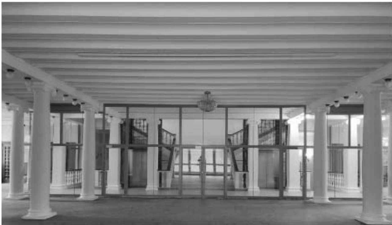
7. ОКНРЗ «Дворец пушкинъ». Интерьеры 3-го этажа. Пилоны и пилястры стилизованного ионического ордера. Оформление потолка – балки с профилем по краю. 15.01.2024г.
