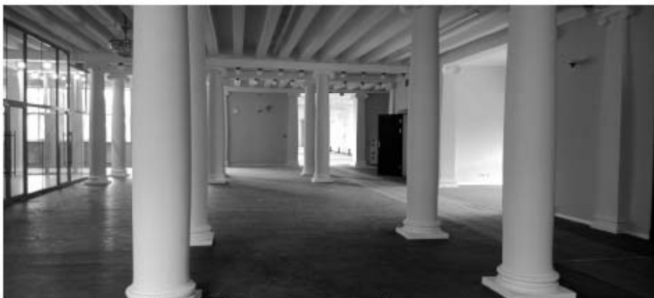
2. ОКНРЗ «Дворец пушкинъ». Интерьеры 3-го этажа. Пилоны и пилястры стилизованного ионического ордера. 15.01.2024г.
