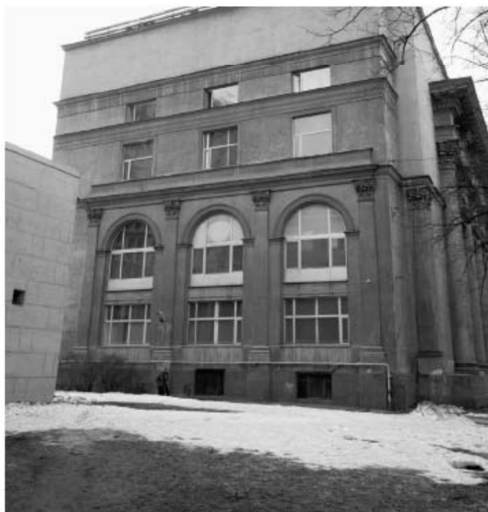
94. Северный фасад. 2010г. ООО «БРК».
