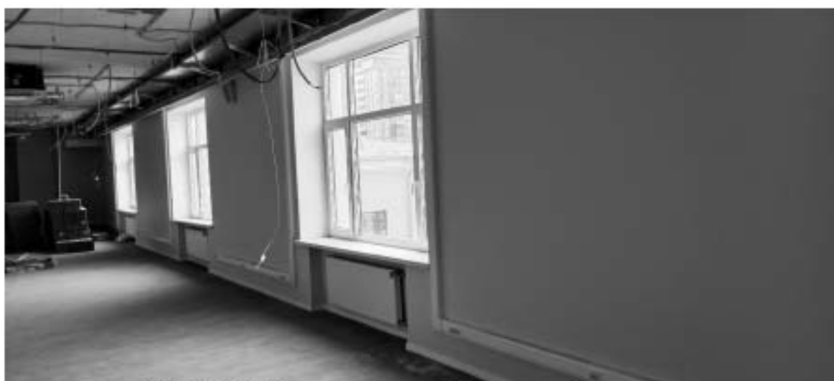
26. ОКНРЗ «Дворец пушкинъ». Интерьеры 4-го этажа. Оконные проемы с прямым завершением. 15.01.2024г.
