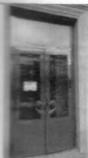
9. Деревянное заполнение парадного входа
