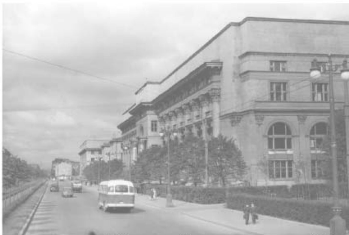
85. Вид на здание Дворца пушкины с юго-запада. 1960-е гг. ЦГАКФФД СПб. Вр 35578.
