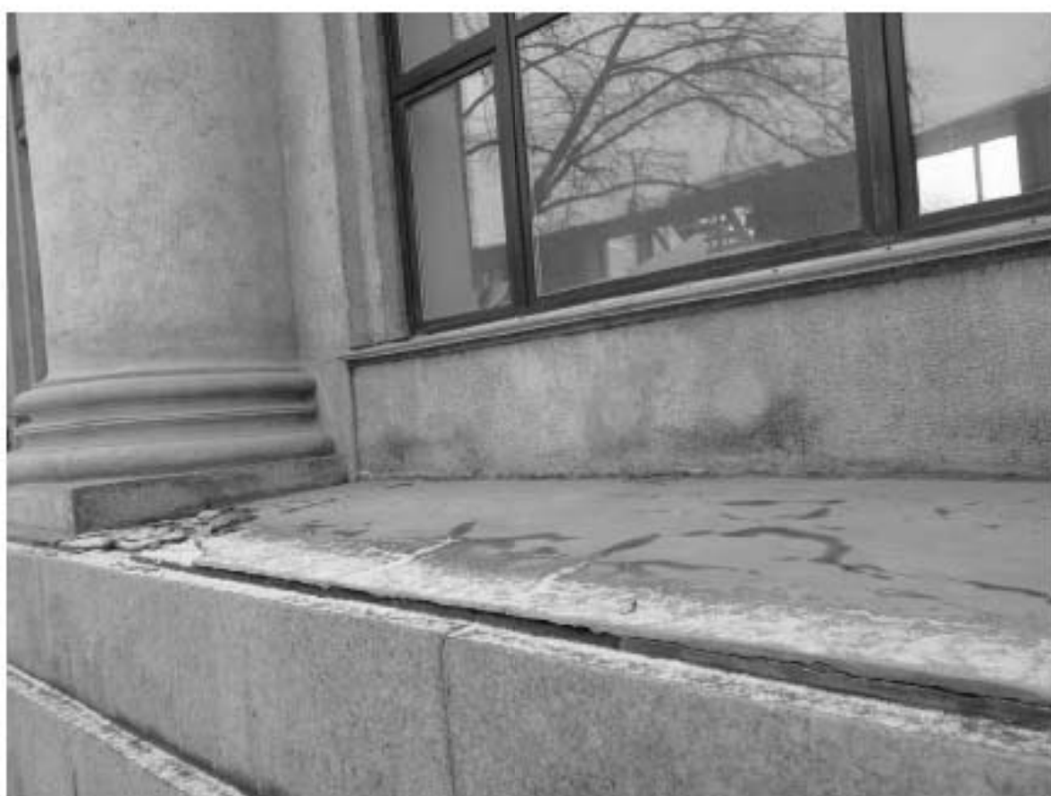
9. ОКНРЗ «Дворец пушкины». Фрагмент южной части западного фасада. 15.01.2024г.
