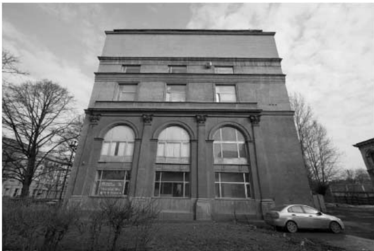
95. Южный фасад. 2010г. ООО «БРК».
