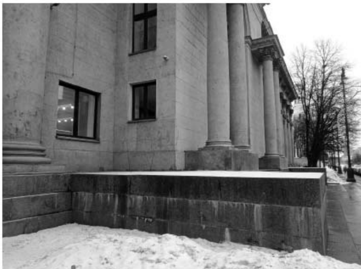
16. ОКНРЗ «Дворец пушкинъ». Центральная часть западного фасада. Вид на юго-восток. 15.01.2024г.
