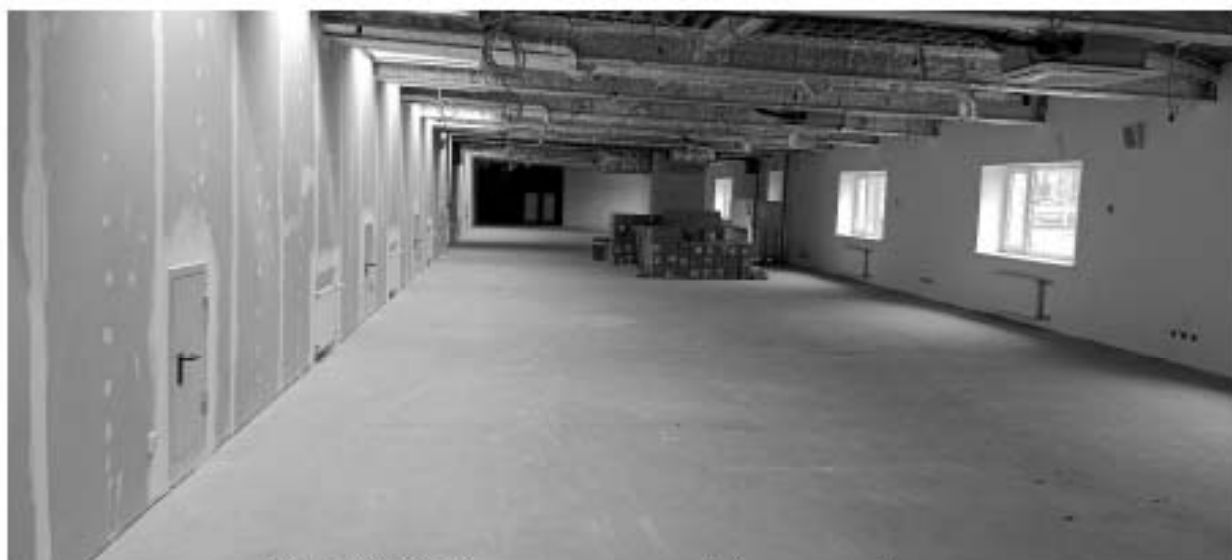
32. ОКНРЗ «Дворец пушкины». Интерьеры 5-го этажа. Оконные проемы с прямым завершением. 15.01.2024г.
