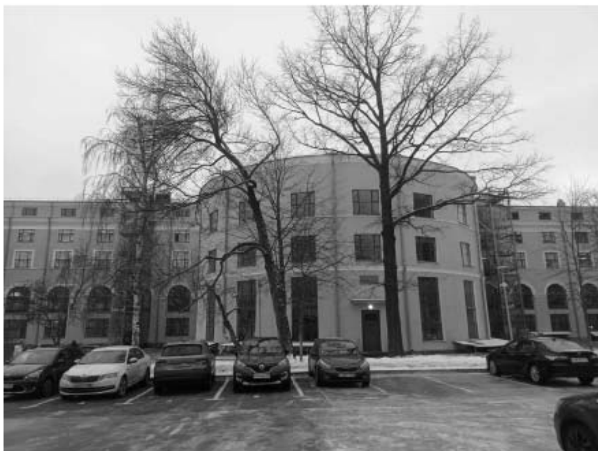
33. ОКНРЗ «Дворец пушкинъ». Центральная часть восточного фасада. Вид на запад. 15.01.2024г.
