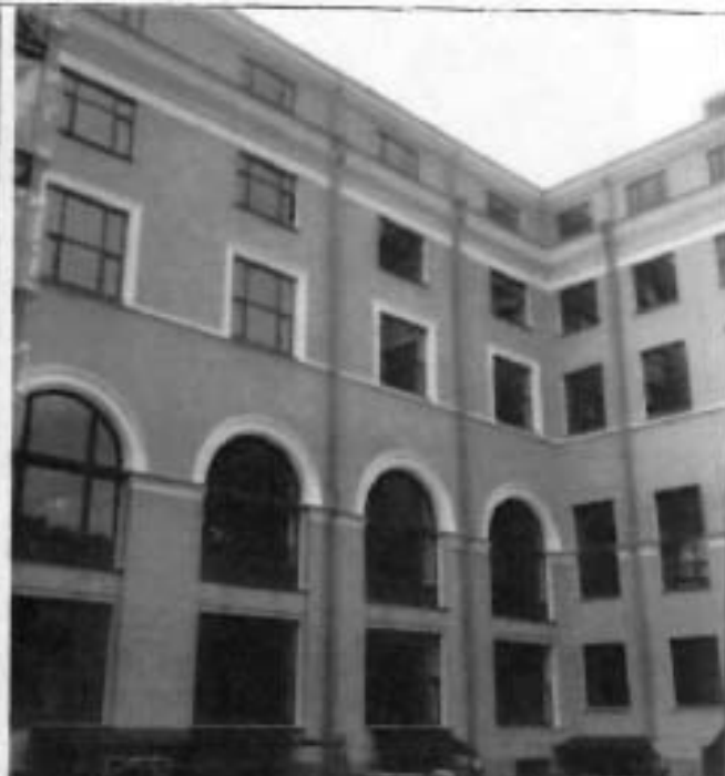
3. Фрагмент восточного фасада
