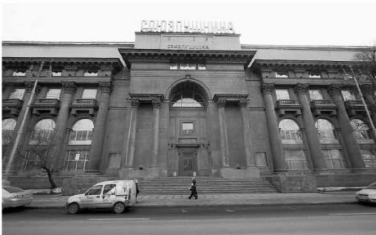
91. Лицевой фасад. Главный вход. 2010г. ООО «БРК».
