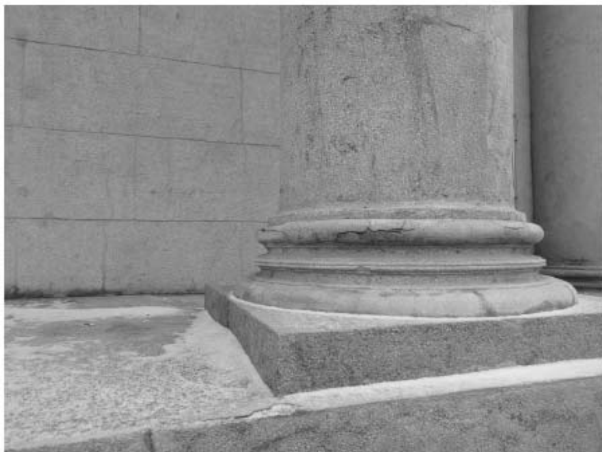
10. ОКНРЗ «Дворец пушкинъ». Фрагмент южной части западного фасада. 15.01.2024г.
