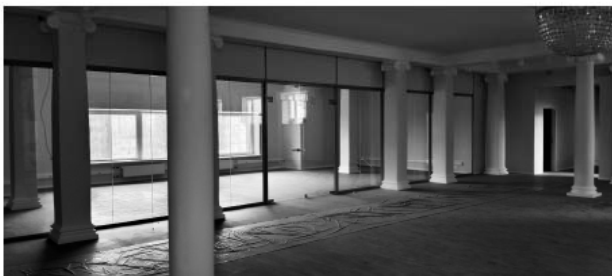
28. ОКНРЗ «Дворец пушкинъ». Интерьеры 4-го этажа. Колонны, поддерживающие потолочные балки с профилем по краю, и пилястры ионического ордера. 15.01.2024г.
