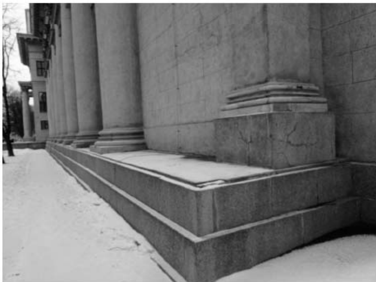
29. ОКНРЗ «Дворец пушкинъ». Фрагмент западной части южного фасада. Вид на север. 15.01.2024г.
