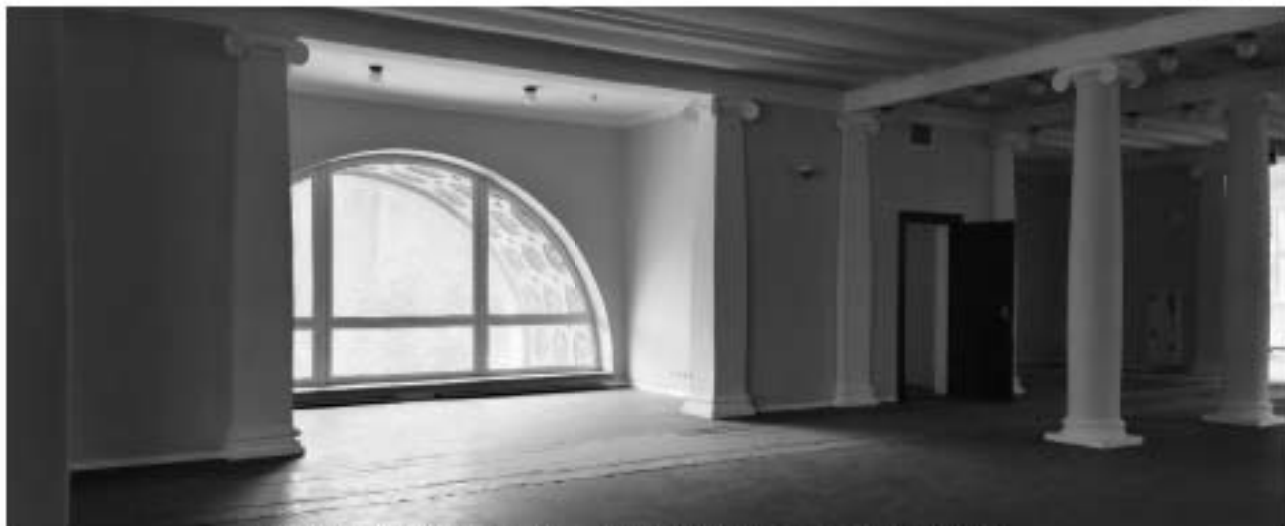
3. ОКНРЗ «Дворец пушкинъ». Интерьеры 3-го этажа. Оконный проем с полуциркульным завершением. Пилоны и пилястры стилизованного ионического ордера. 15.01.2024г.
