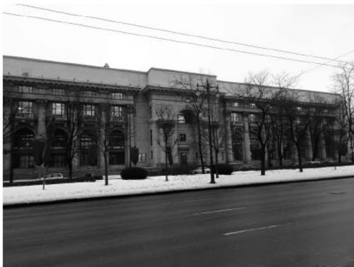
5. ОКНРЗ «Дворец пушкинъ». Центральная часть западного фасада. Вид на юго-восток с Московского проспекта. 15.01.2024г.
