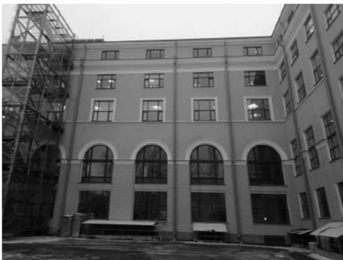
37. ОКНРЗ «Дворец пушкинъ». Северная часть восточного фасада. Вид на запад. 15.01.2024г.
