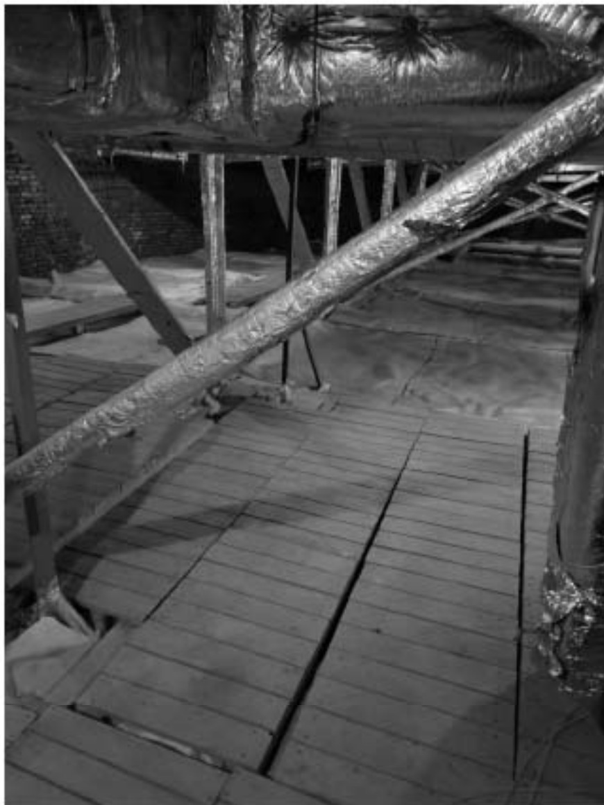
17. ОКНРЗ «Дворец пушкинъ». Интерьеры 4-го этажа. Чердак над аукционным залом. 15.01.2024г.
