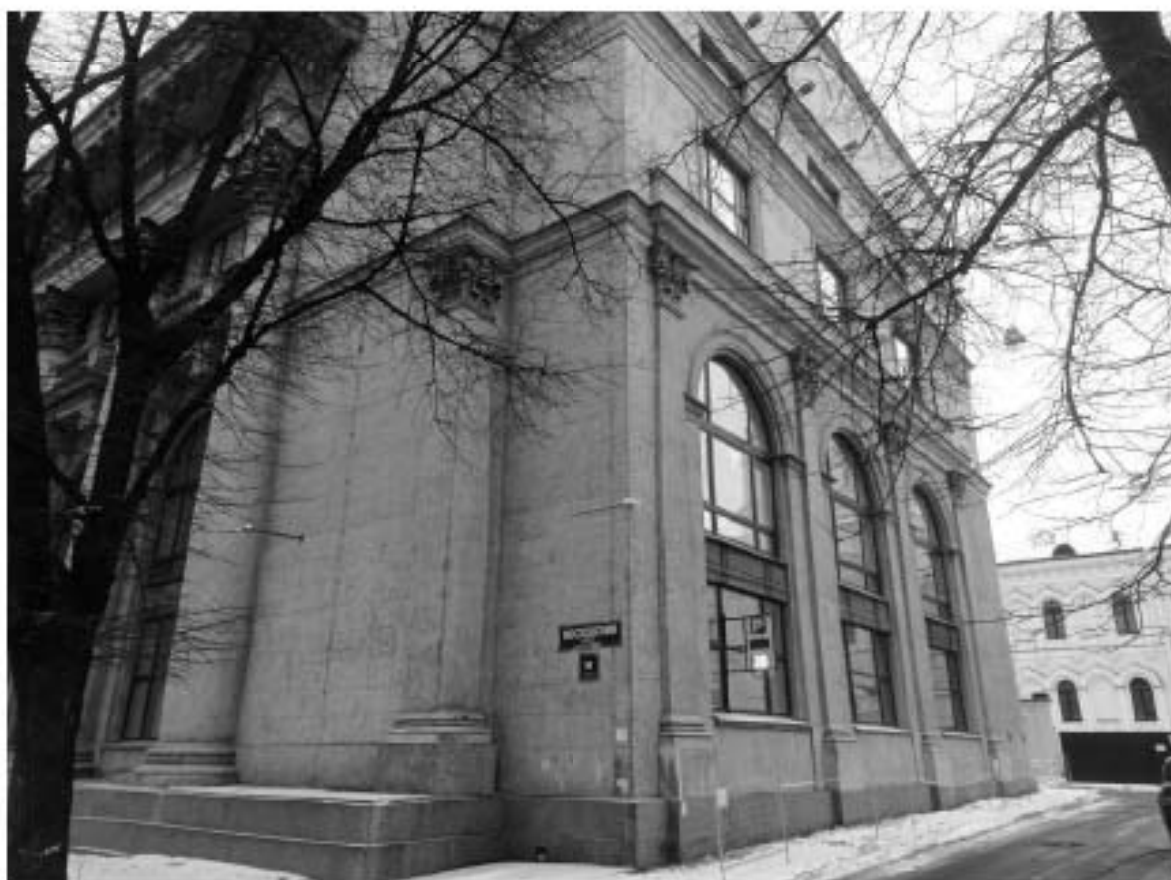
28. ОКНРЗ «Дворец пушкинъ». Южный фасад. Вид на северо-восток от Московского проспекта. 15.01.2024г.
