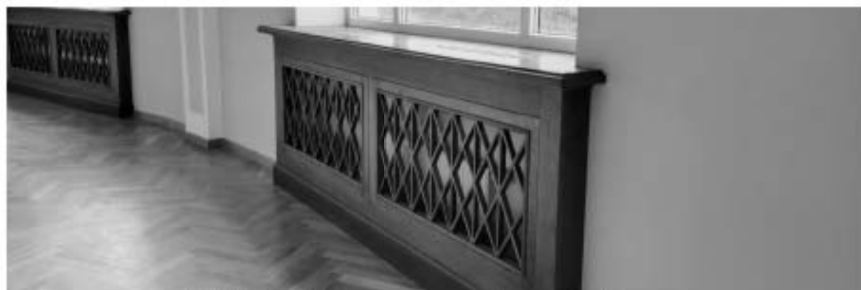
16. ОКНРЗ «Дворец пушнина». Аукционный зал. Деревянные решетки радиатора с рисунком в виде ромбовидной сетки. 15.01.2024г.
