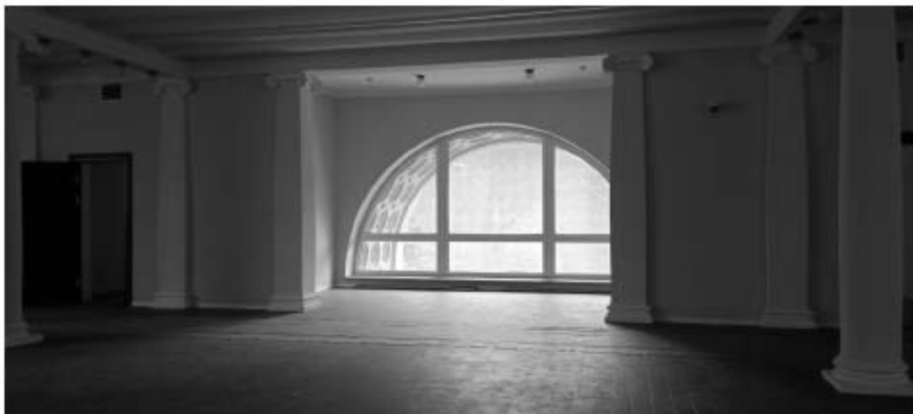
1. ОКНРЗ «Дворец пушкинъ». Интерьеры 3-го этажа. Оконный проем с полуциркульным завершением. Пилоны и пилястры стилизованного ионического ордера. 15.01.2024г.
