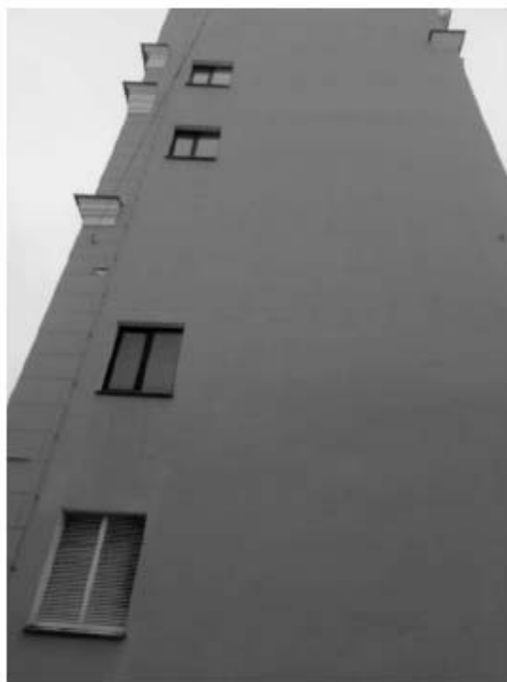
40. ОКНРЗ «Дворец пушкинъ». Торец южного ризалита восточного фасада. Вид на запад. 15.01.2024г.
