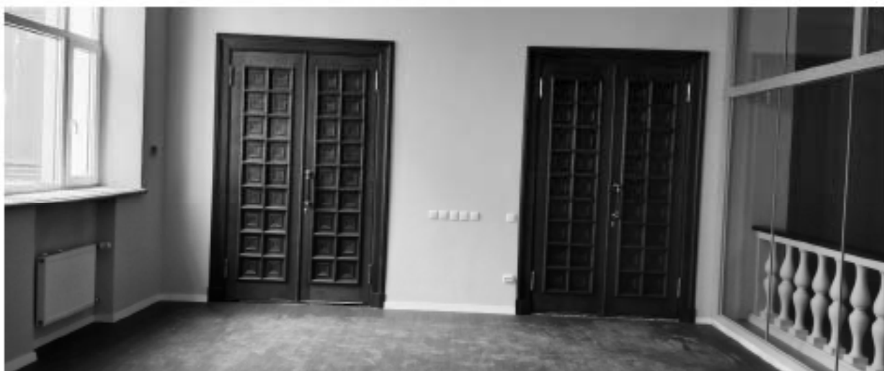
6. ОКНРЗ «Дворец пушкинъ». Интерьеры 3-го этажа. Дверные проемы с деревянным филенчатым двустворчатым заполнением и исторической фурнитурой (ручка-скоба). 15.01.2024г.
