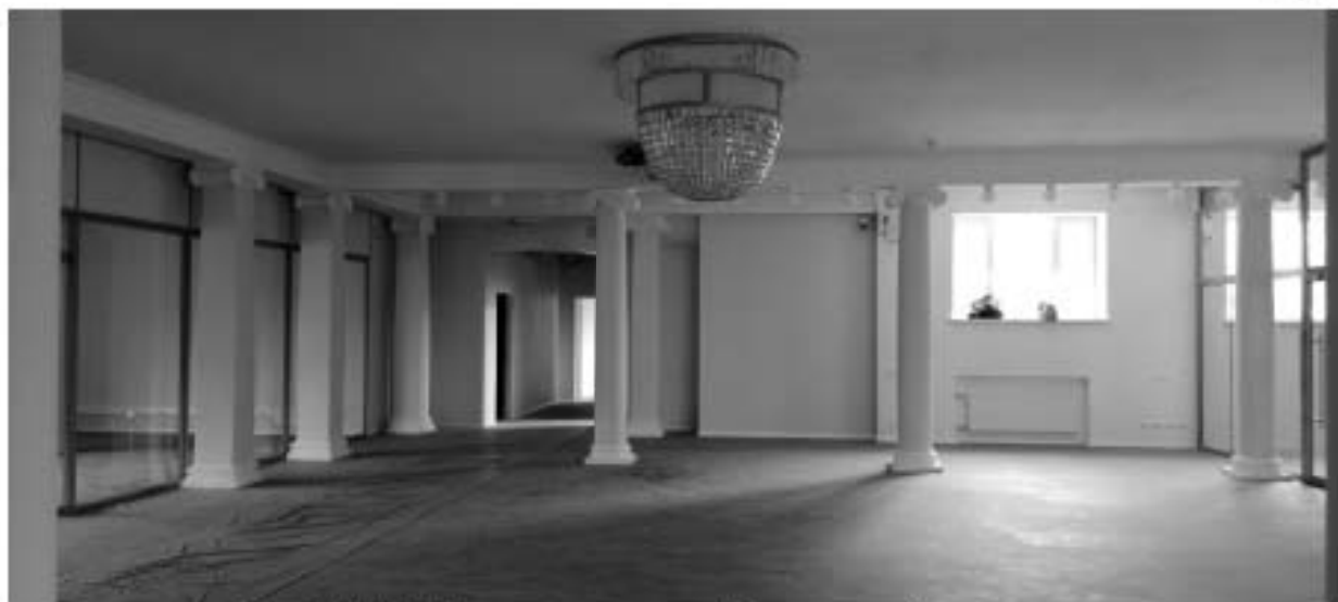
27. ОКНРЗ «Дворец пушкинъ». Интерьеры 4-го этажа. Колонны, поддерживающие потолочные балки с профилем по краю, и пилястры ионического ордера. 15.01.2024г.
