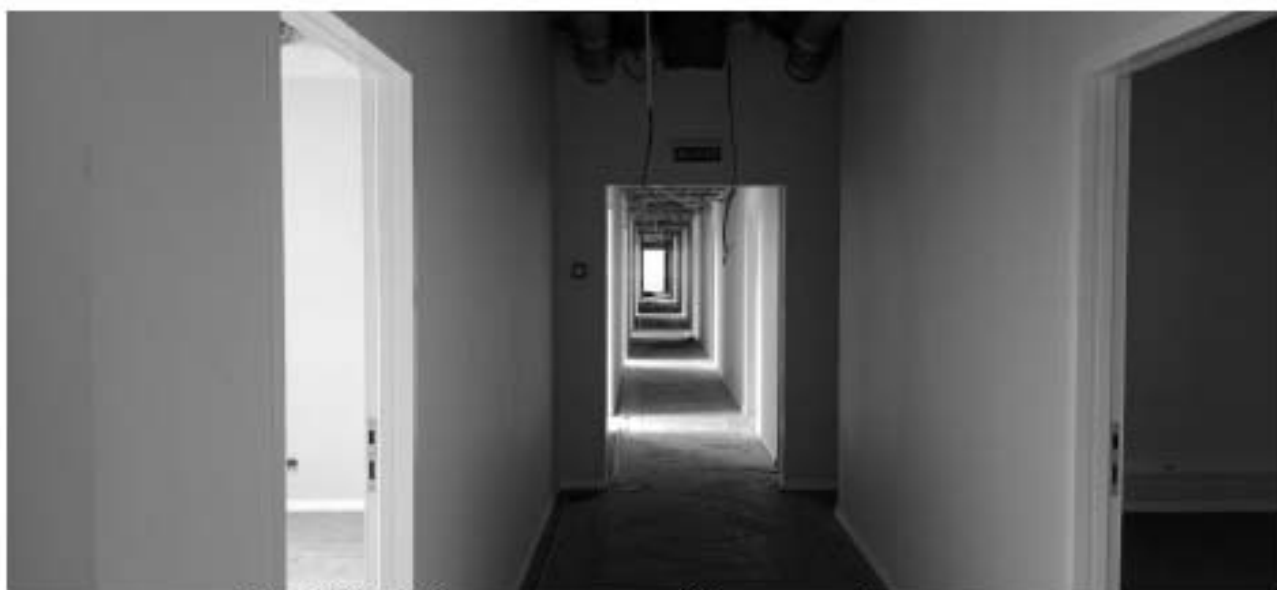
18. ОКНРЗ «Дворец пушкинъ». Интерьеры 4-го этажа. Южное крыло. Вид в южном направлении. 15.01.2024г.
