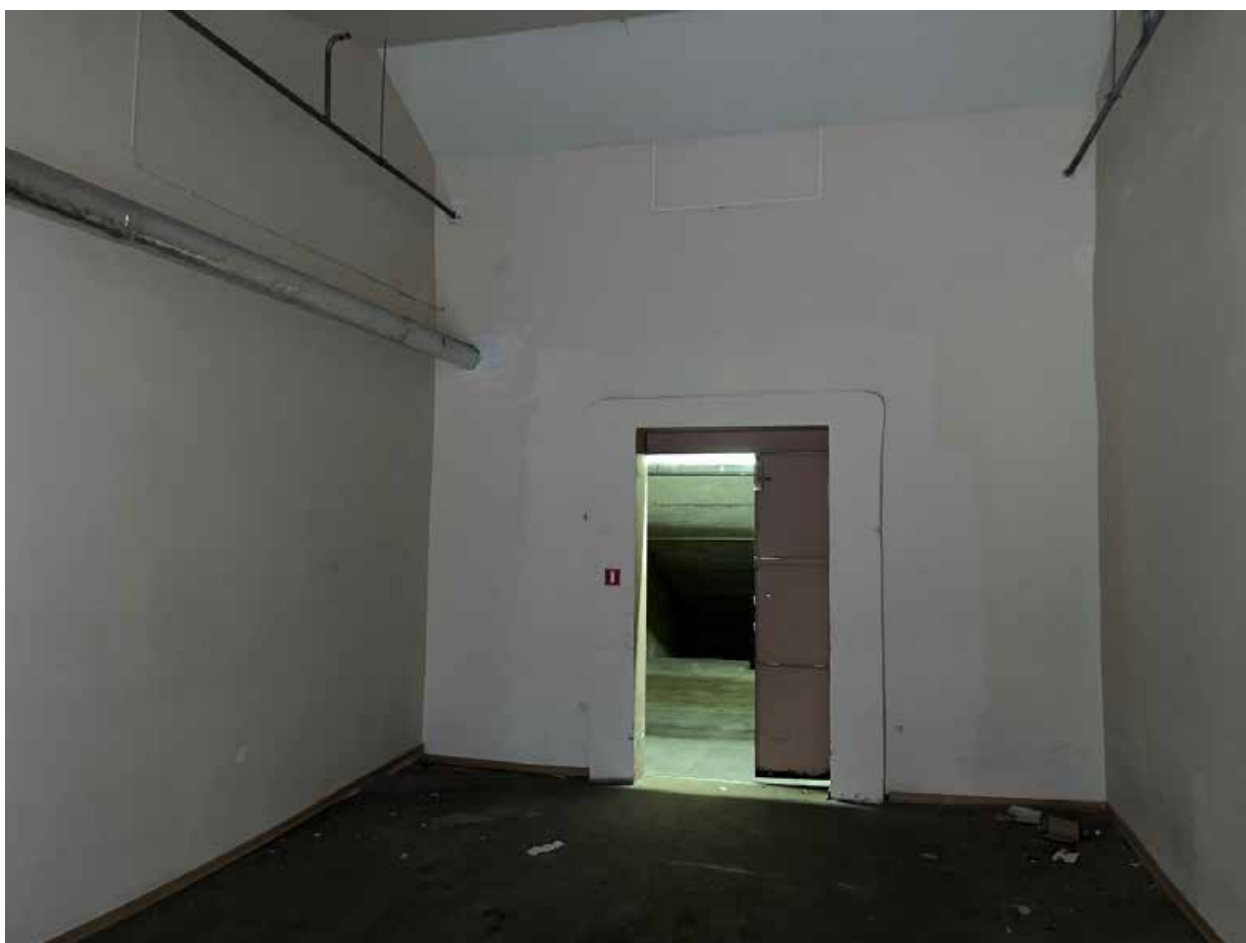
Фото №39. Помещение третьего этажа (мансарда).
