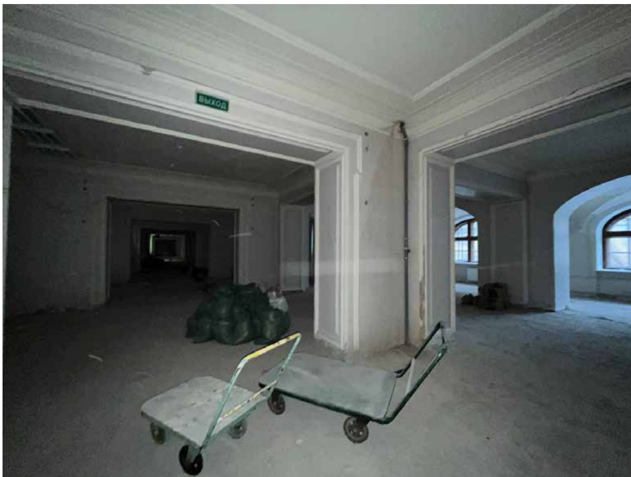
Фото №10. Первый этаж. Общий вид помещений.
