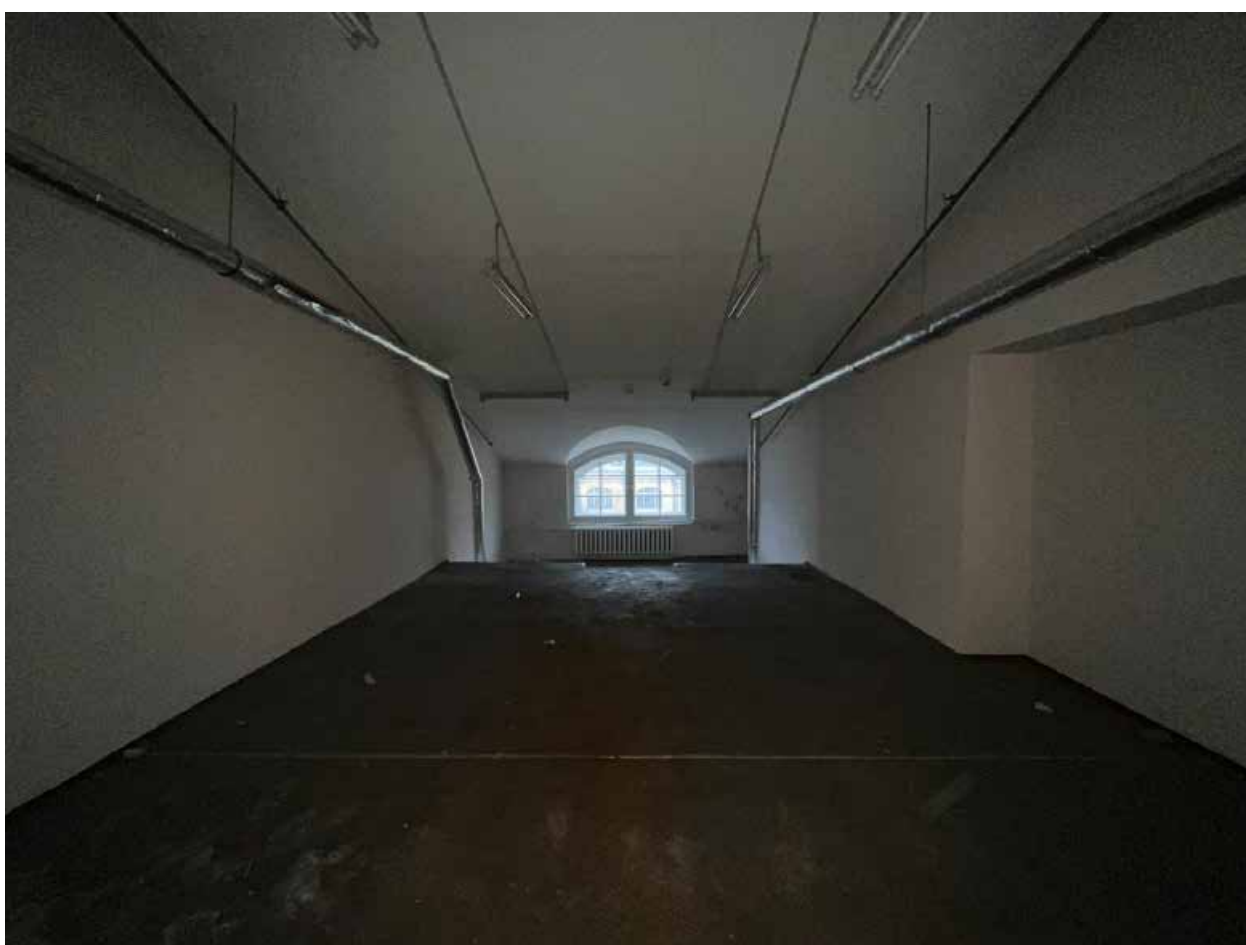
Фото №46. Помещение третьего этажа (мансарда).
