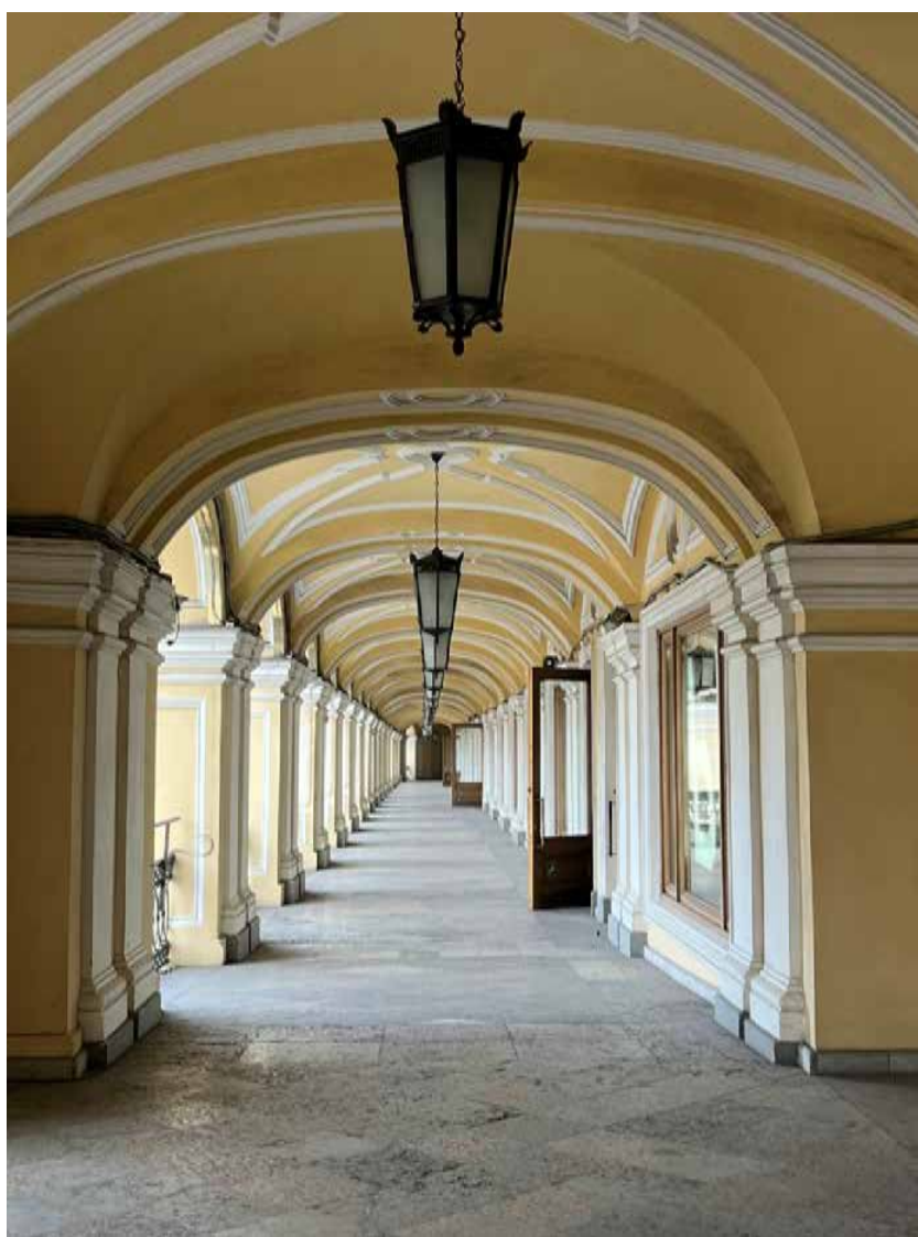
Фото №3. Галерея первого этажа по Ломоносовской улице.
