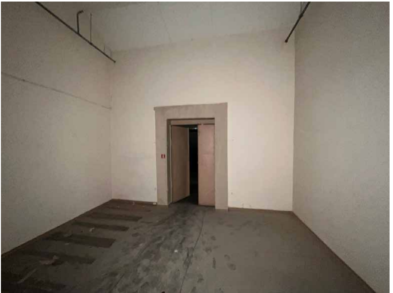
Фото №36. Помещение третьего этажа (мансарда).
