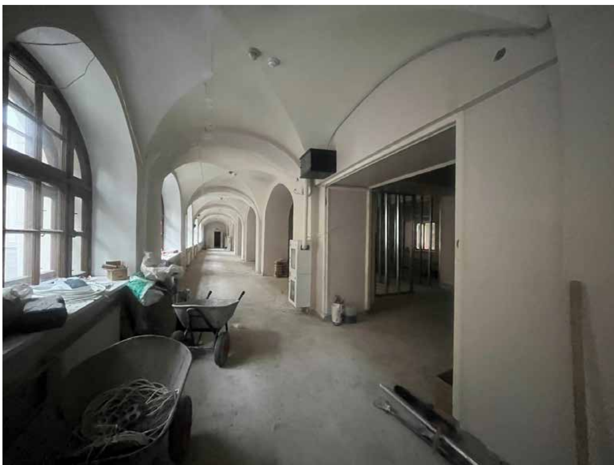
Фото №7. Первый этаж, галерея вдоль стены дворового фасада.
