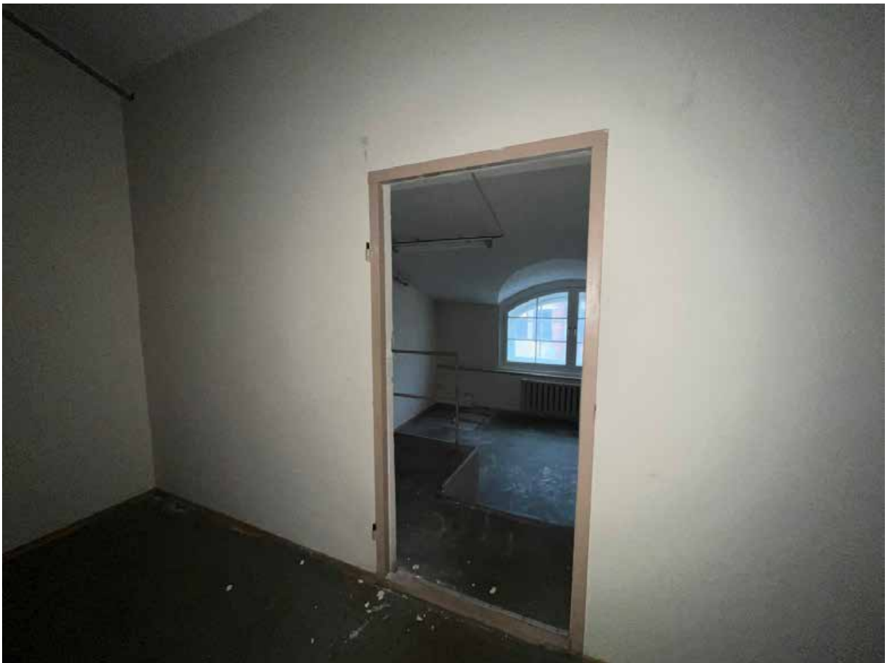
Фото №33. Помещение третьего этажа (мансарда).
