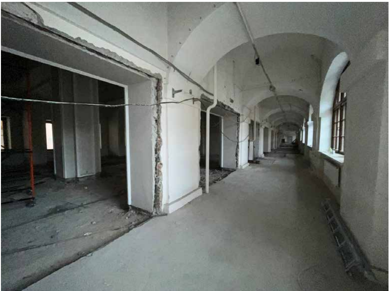
Фото №15. Второй этаж. Галерея, вдоль стены дворового фасада.
