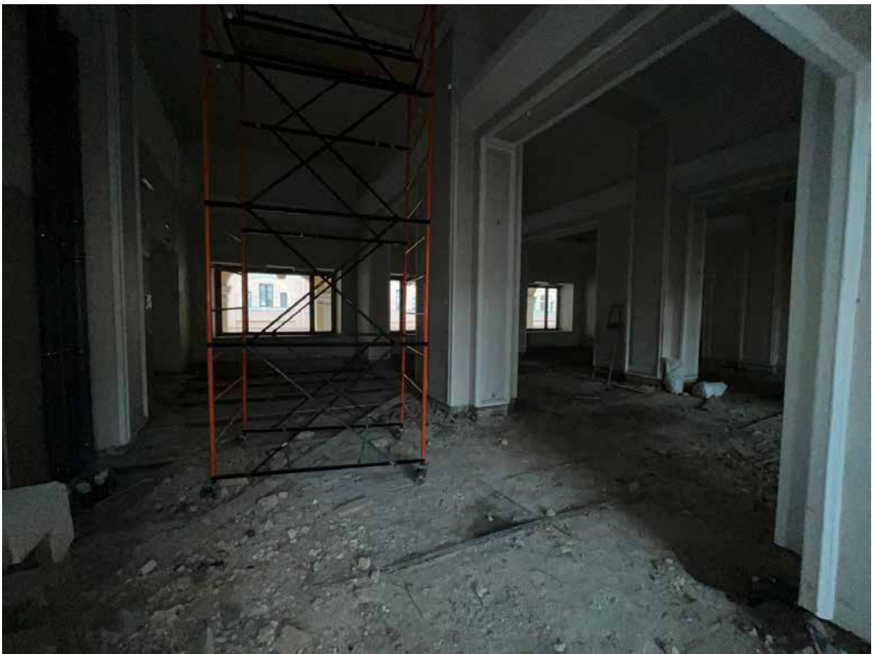
Фото №16. Второй этаж. Общий вид помещений.
