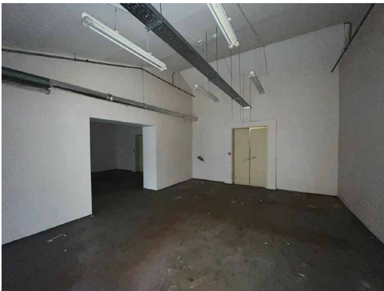
Фото №42. Помещение третьего этажа (мансарда).
