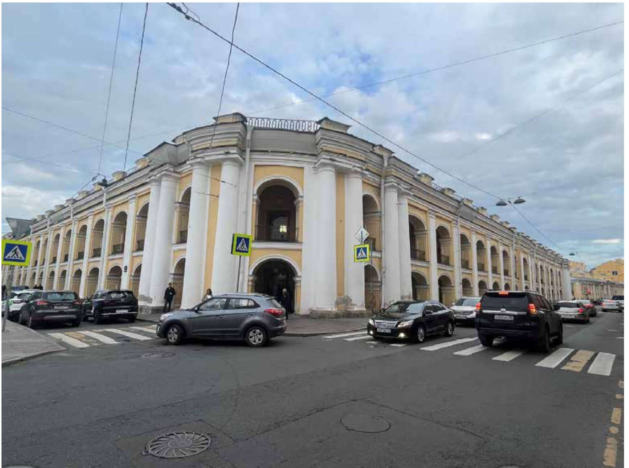
Фото №2. Угол здания на пересечении Ломоносовской улицы и Перинной линии.
