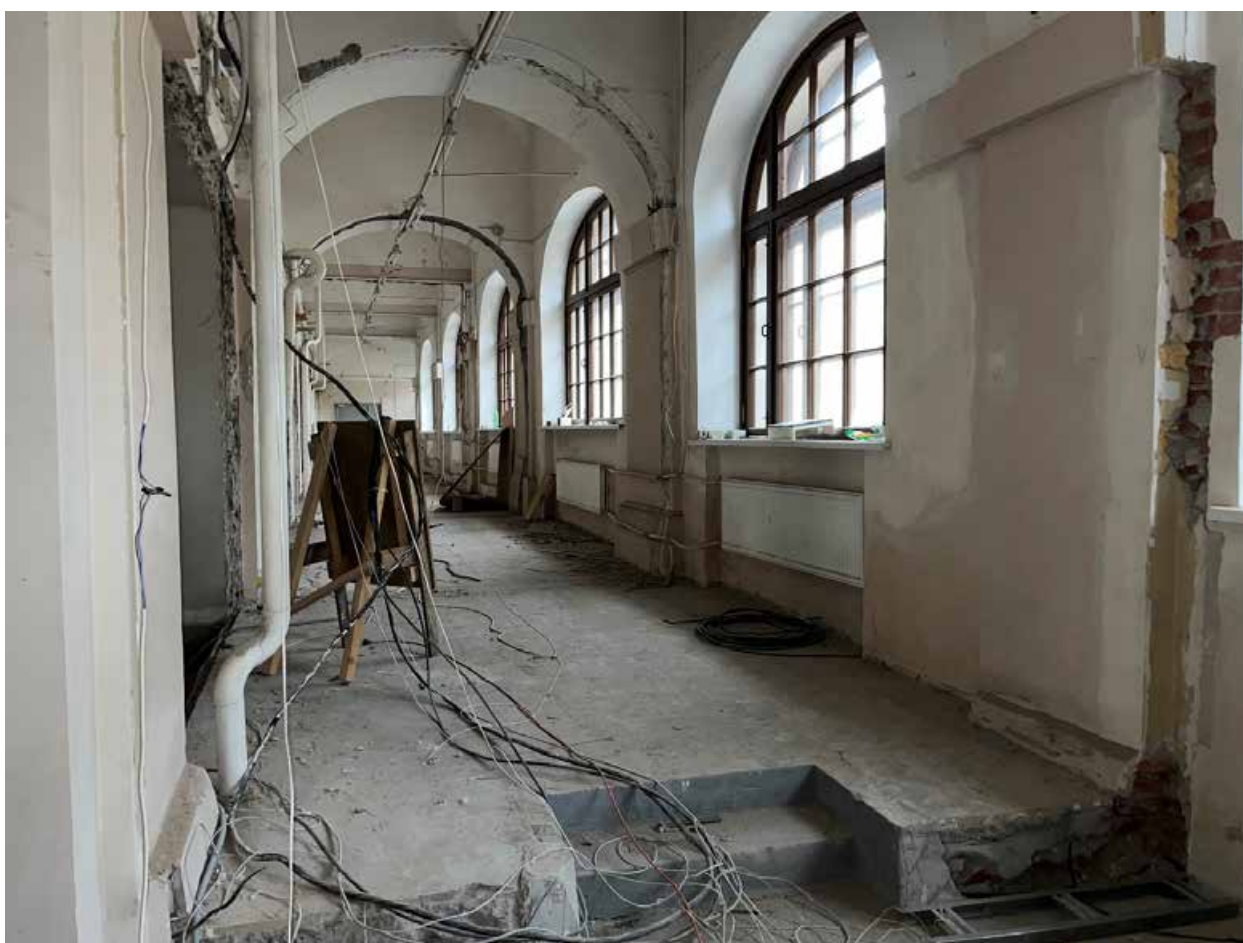
Фото №22. Второй этаж. Галерея вдоль стены дворового фасада.
