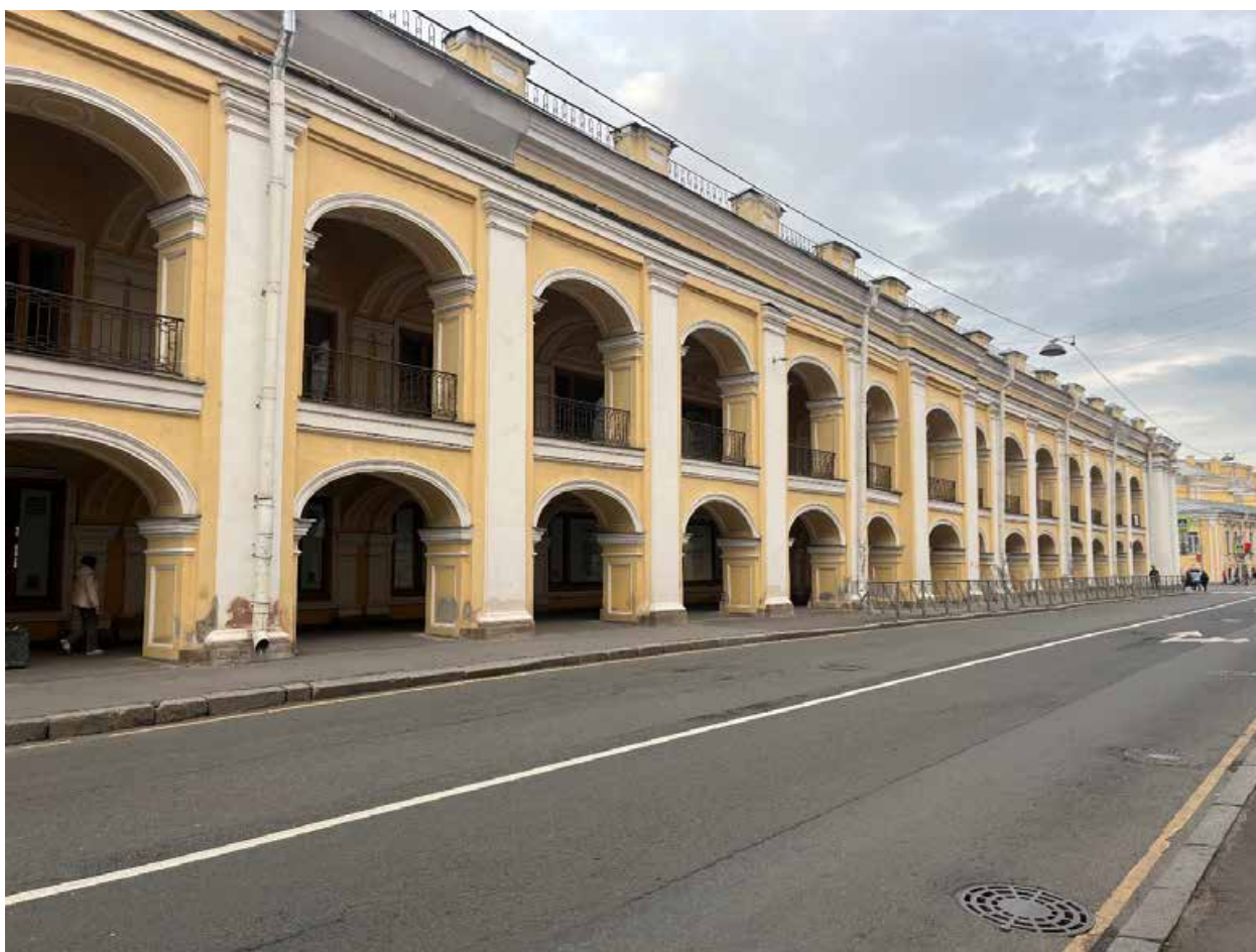
Фото №4. Лицевой фасад Ломоносовской улице.
