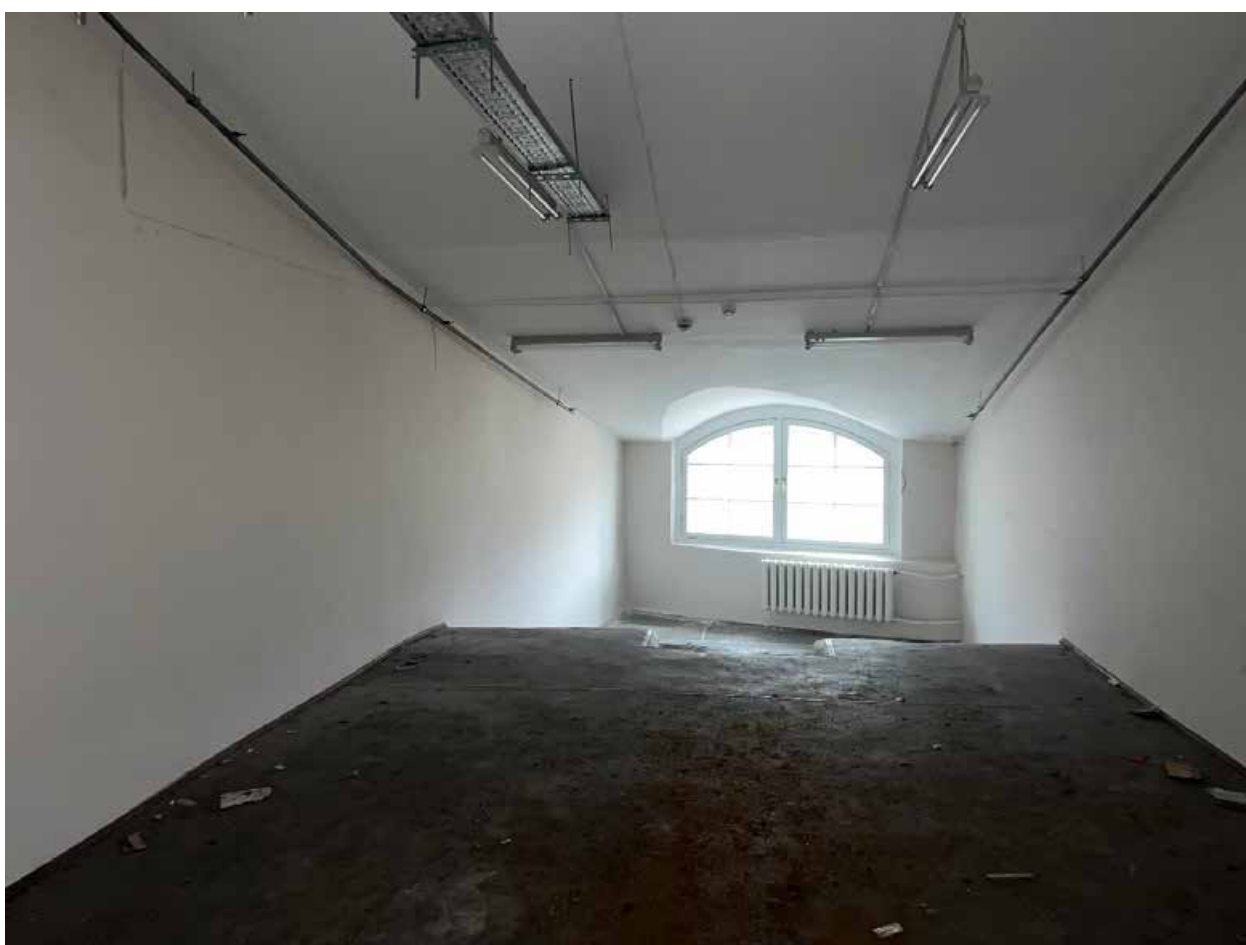
Фото №48. Помещение третьего этажа (мансарда).
