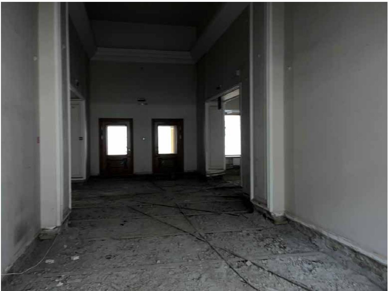
Фото №20. Второй этаж. Выход на галерею второго этажа лицевого фасада.
