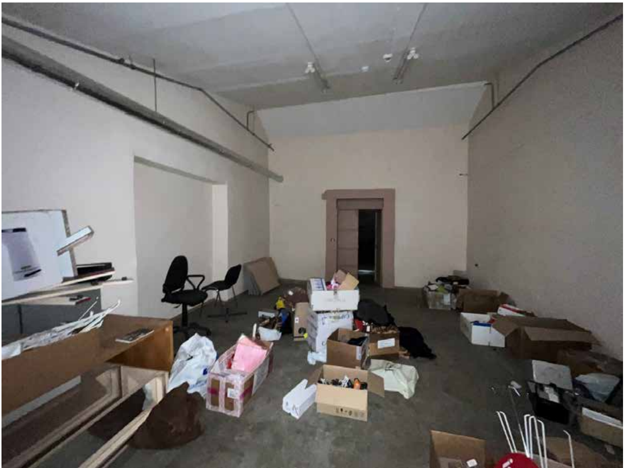
Фото №30. Помещение третьего этажа (мансарда).
