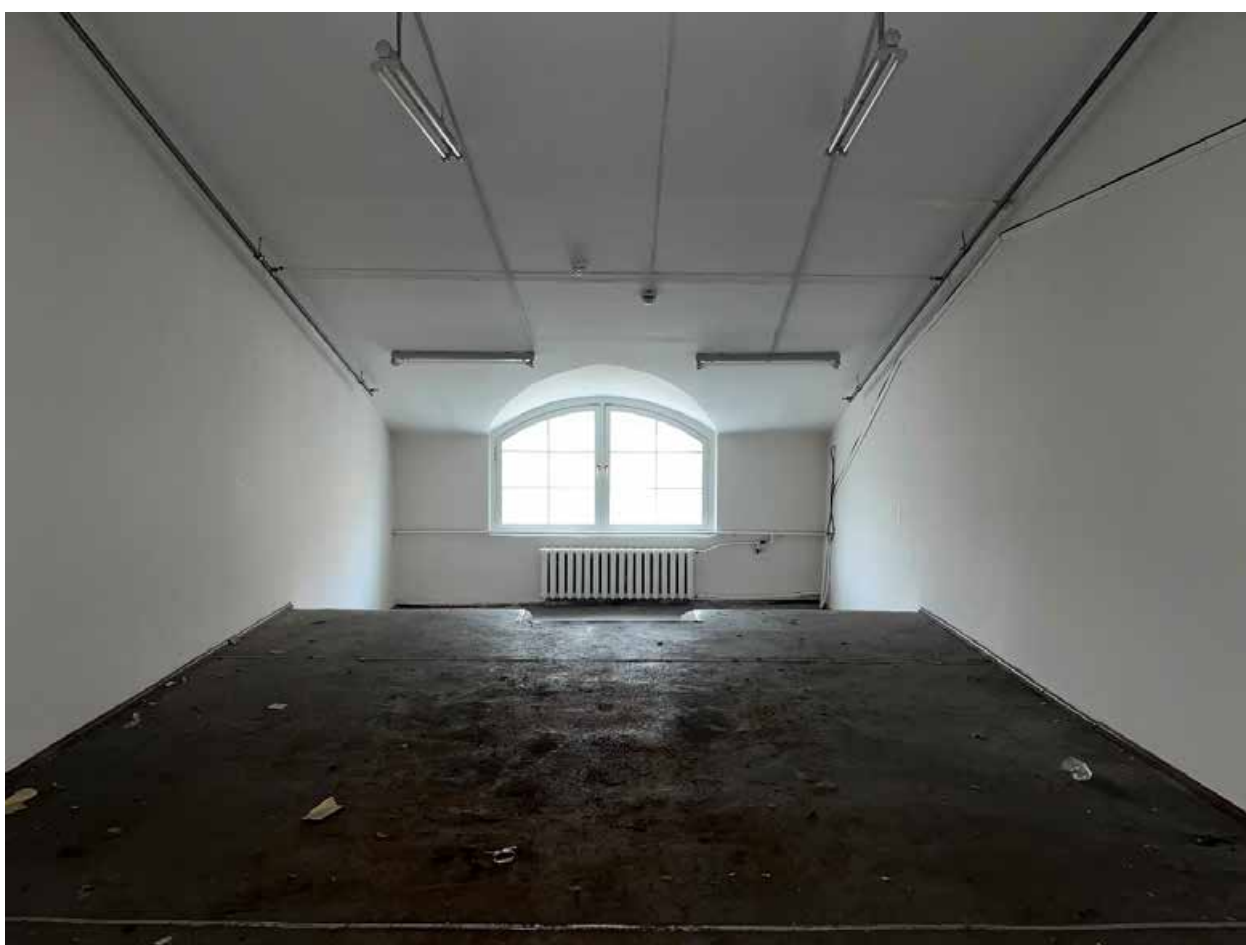
Фото №44. Помещение третьего этажа (мансарда).
