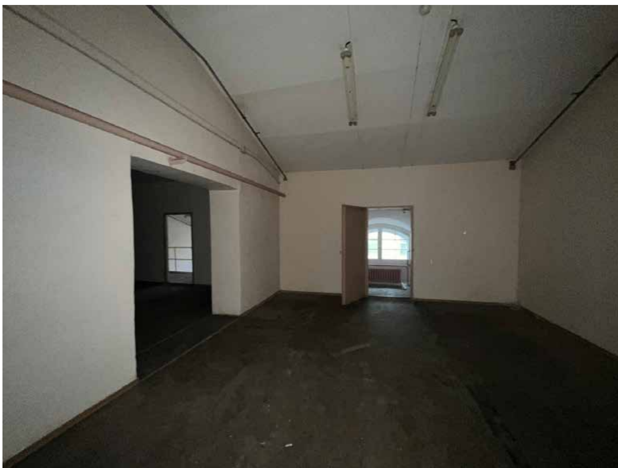
Фото №31. Помещение третьего этажа (мансарда).
