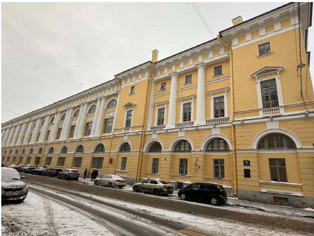
Общий вид здания
