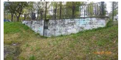
Водосливная плотина на пруду
