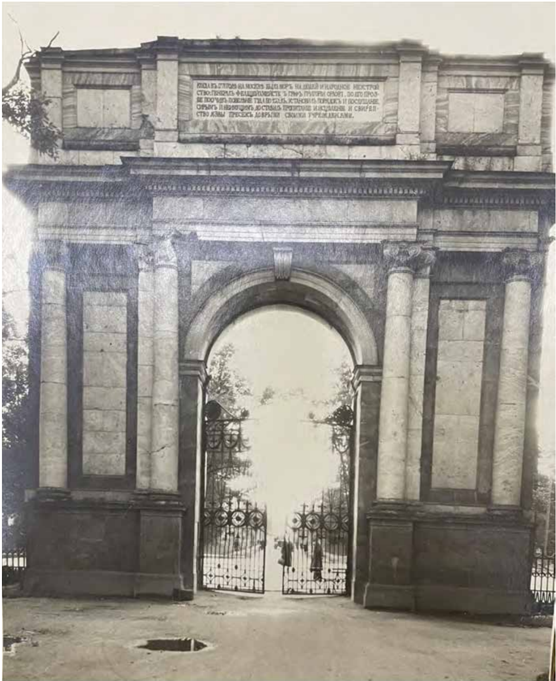
Илл. 26. Орловские ворота. Общий вид с северной стороны парка. Фото 1963, Архив КГИОП 226-37
