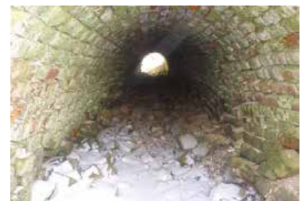
вид кирпичной галереи
