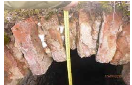
свод кирпичной галереи
