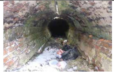
вид кирпичной галереи
