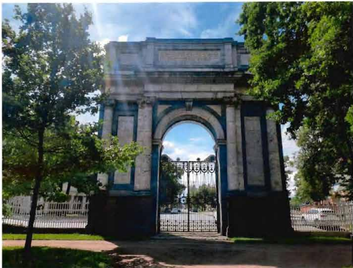
2. Общий вид на северо-восточный фасад объекта культурного наследия
