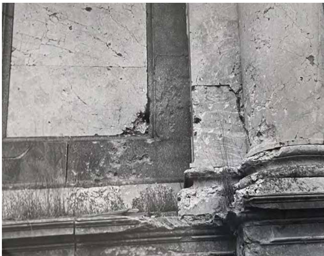
Илл. 22. Орловские ворота. Северный фасад. Левая сторона. Фото 1952 г. Архив КГИОП 226-37. Н-688
