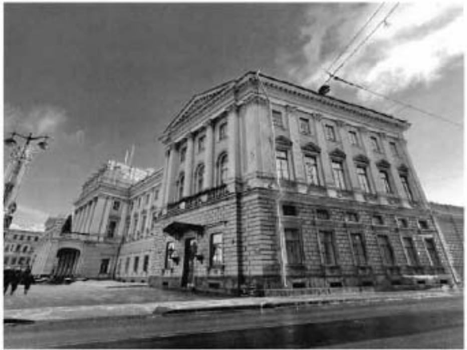
2. Общій вид на объект культурного наследия («Дворец»). Фото от 28.12.2022.
