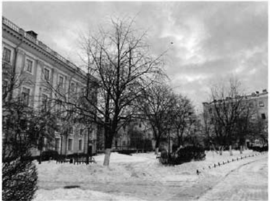
4. Общий вид на объект культурного наследия («Сад»). Фото от 28.12.2022.
