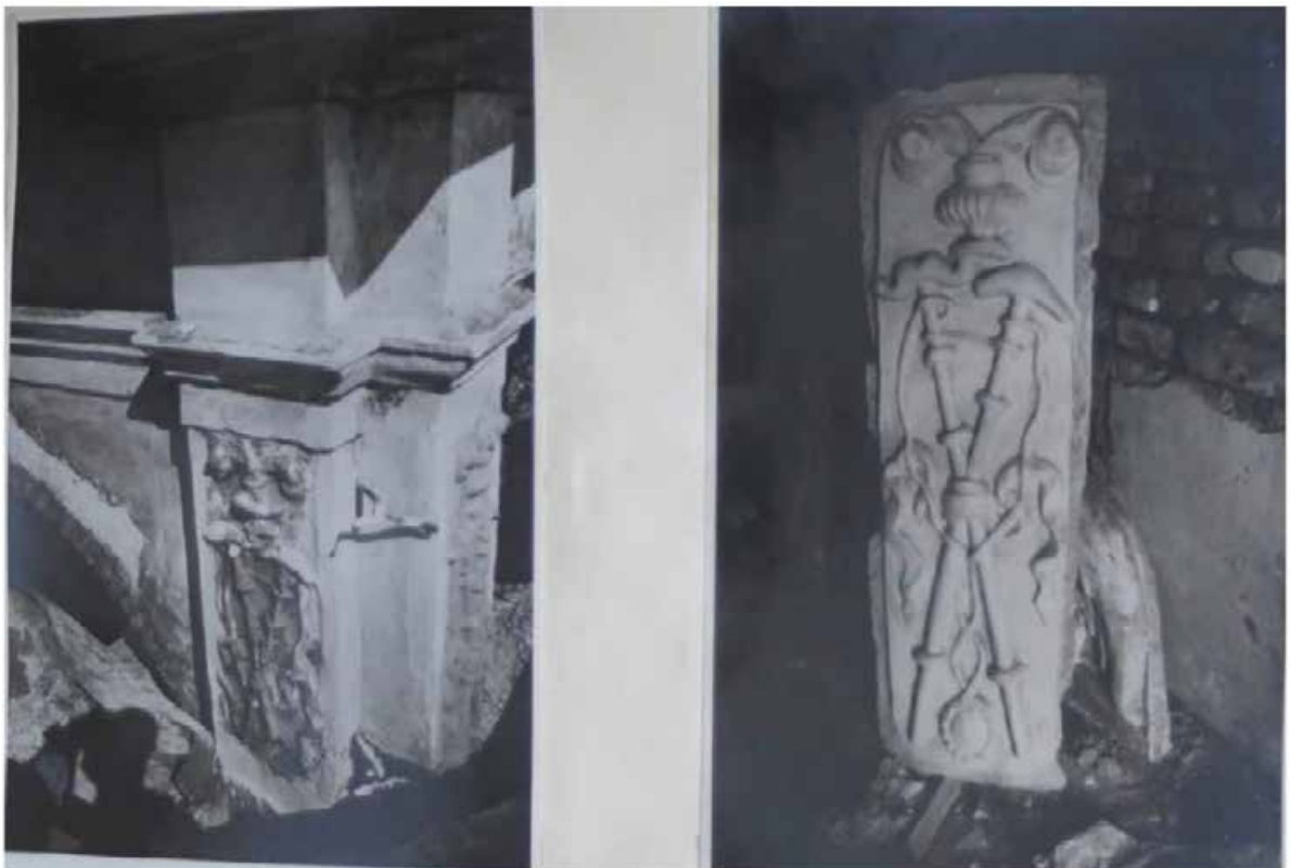
Илл. 90. Здание усыпальницы Суворова. Барельеф фасада до и после реставрации. Фотография. 1950 г. Неизвестный автор. // Архив КГИОП. П-155. (Фотоальбом А 847. Фото № б/н).
