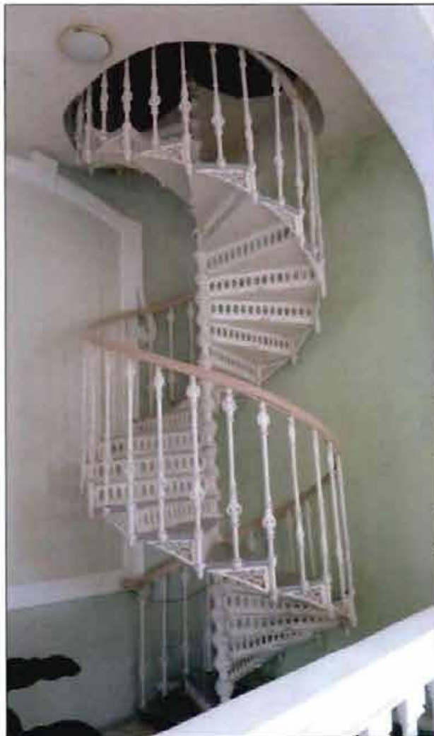
8. Винтовая лестница в уровне второго этажа.
