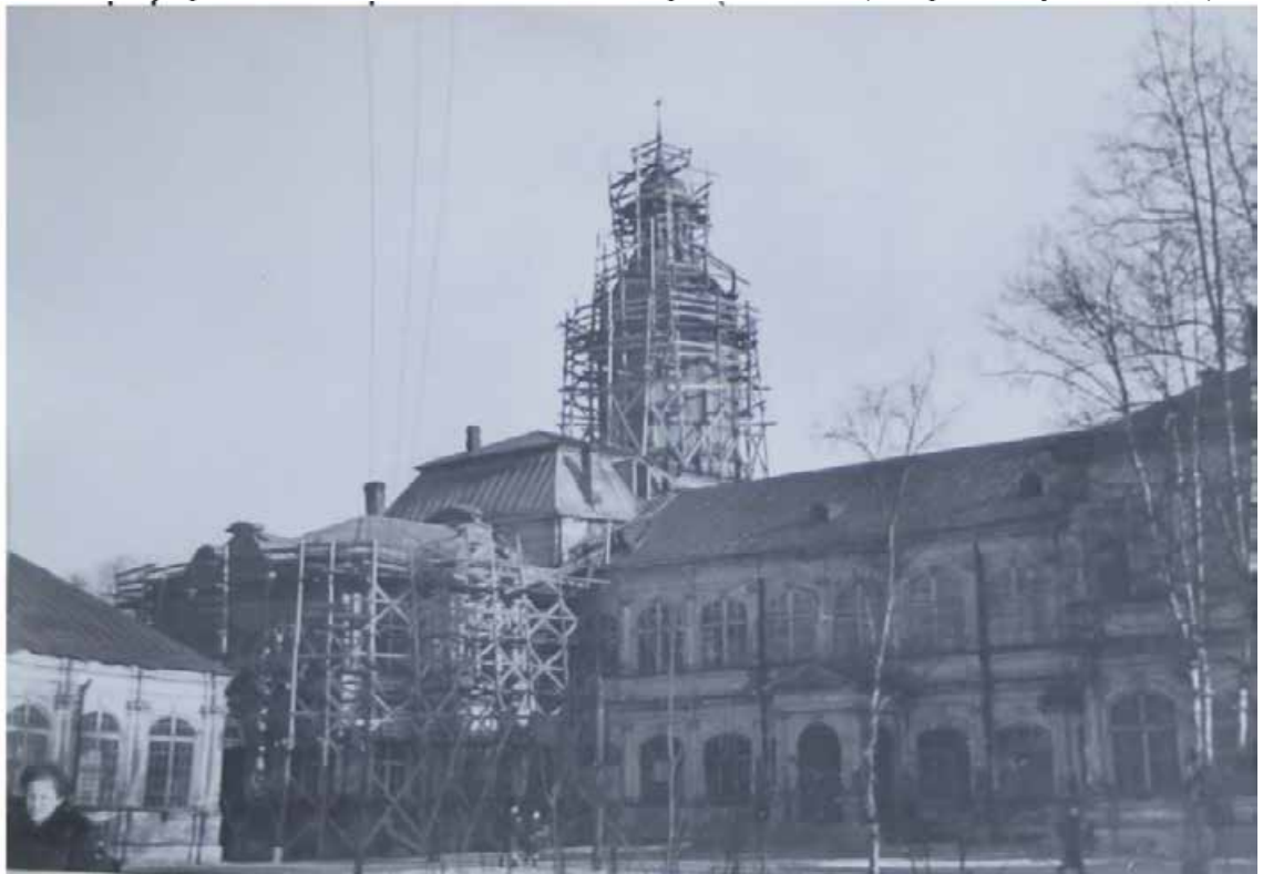
Илл. 52. Здание усыпальницы Суворова. В процессе фасадно-реставрационных работ. Фотография. 1950 г. Неизвестный автор. // Архив КГИОП. П-155. (Фотоальбом А 847.Фото № 31775).
