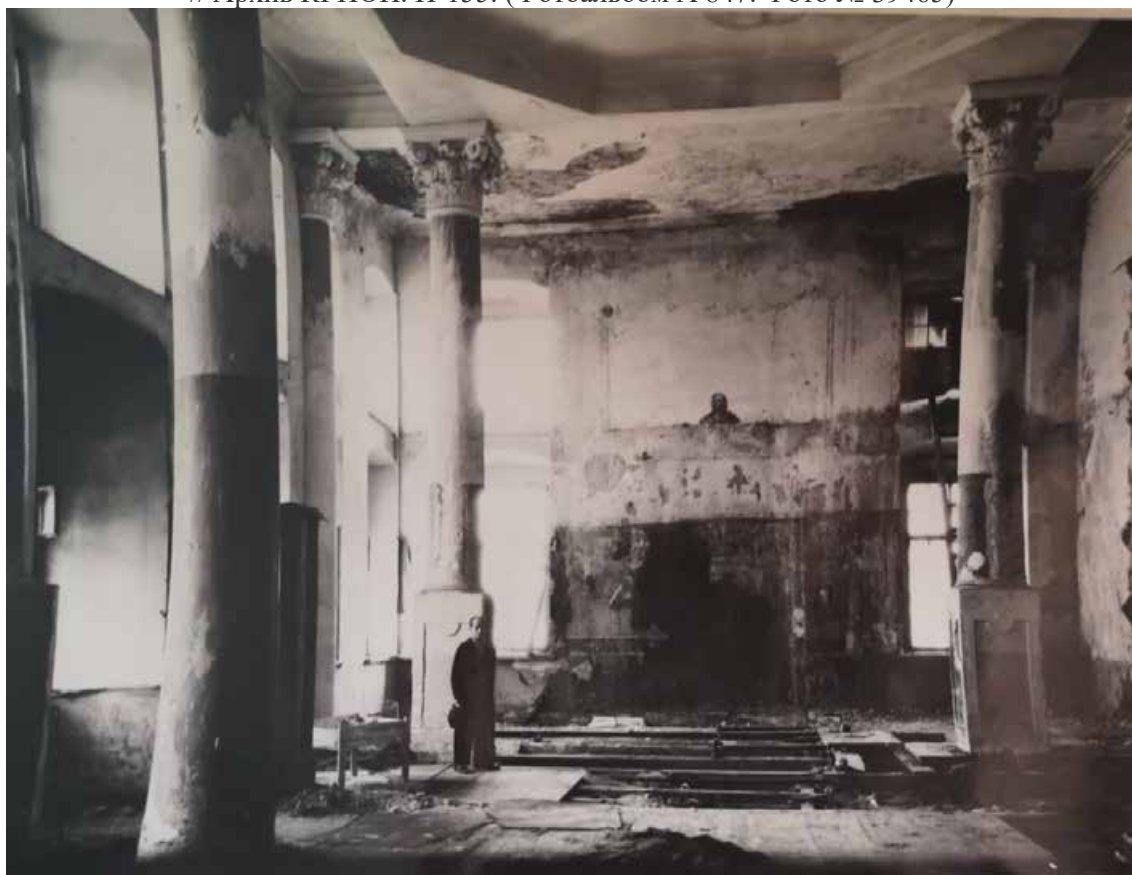
Илл. 83. Александро-Невская лавра. Быв. Церковь Александра Невского. Вид на алтарь. 1947 г. // ЦГАНТД СПб. Фонд Р-488. Опись 324. Дело 114. Фотофиксация видов, частей и фрагментов фасадов и интерьеров Благовещенской церкви Александро-Невской лавры в процессе и после реставрации. 1947–1950 гг.
