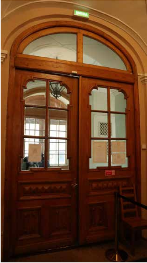
Фото 3. Входная дверь из вестибюля.
