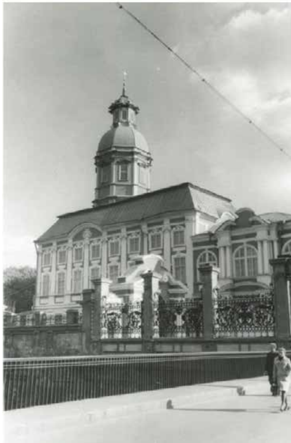
Илл. 56. Вид на церковь Благовещения Пресвятой Богородицы и Святого Благоверного князя Александра Невского и решётку ограды Свято-Троицкой Александро-Невской лавры со стороны реки Монастырки. Дата съёмки: [1980-е - 1990-е гг.]. Автор съёмки не установлен // ЦГАКФФД СПб. Фотодокумент Ар 196010
