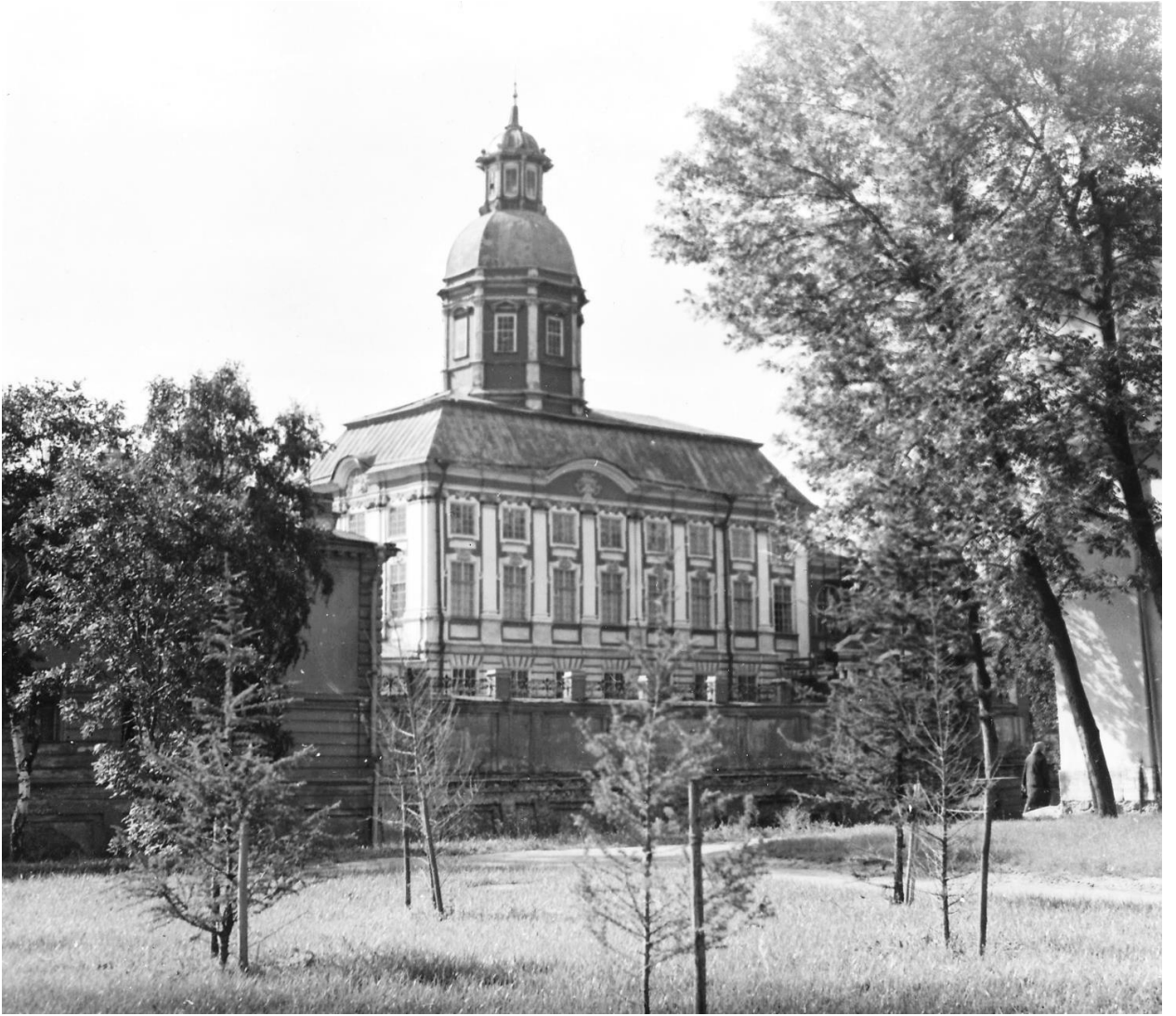
Илл. 59. Вид на здание Благовещенской церкви лавры (набережная реки Монастырки, 1.1717-1725 гг., архитектор Д.Трезини). Дата съёмки: начало 1980-х гг. Автор съёмки: Глевицкий Анатолий Иванович. // ЦГАКФФД СПб. Фотодокумент Бр 54550
