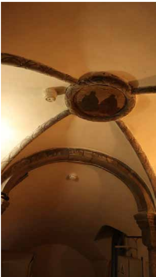
Фото 24. Оформление потолка в подсобном помещении (пом. 3).
