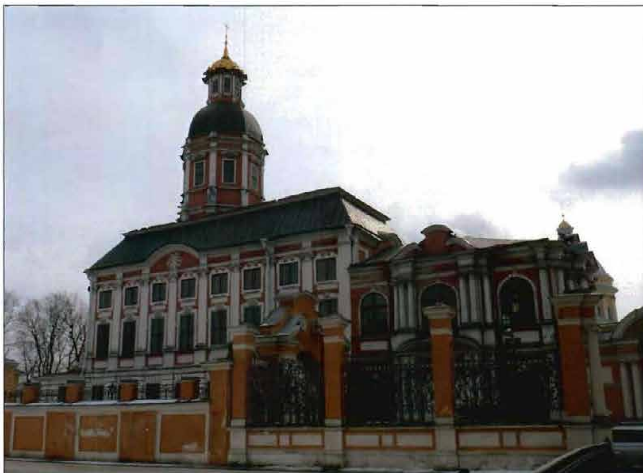
1. Общий вид с северо-запада.
