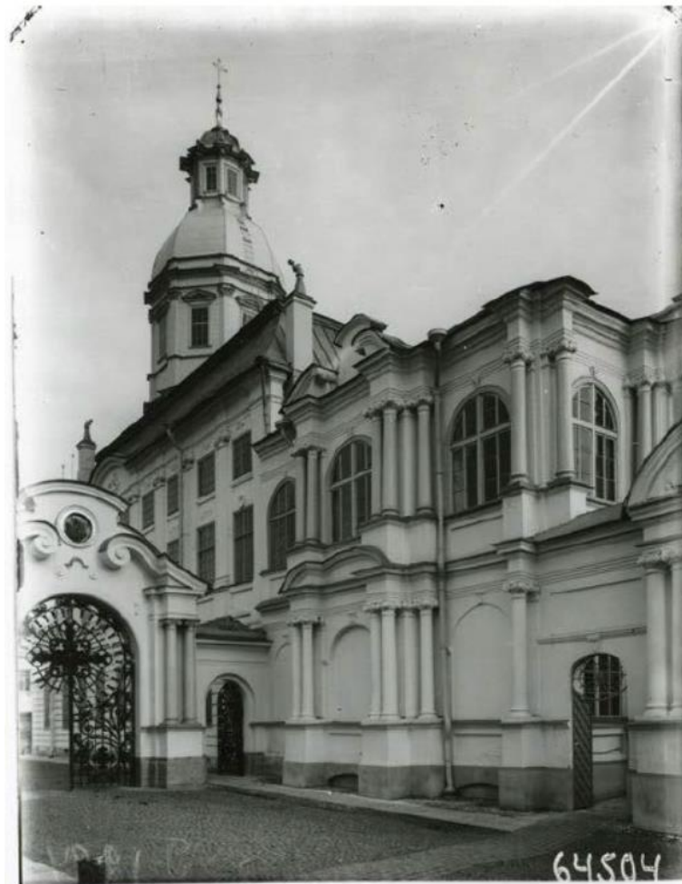
Илл. 49. Внешний вид церкви Благовещения Пресвятой Богородицы в лавре. Дата съёмки: 1915 г. Фотография ателье Буллы // ЦГАКФФД СПб. Фотодокумент Г 1284
