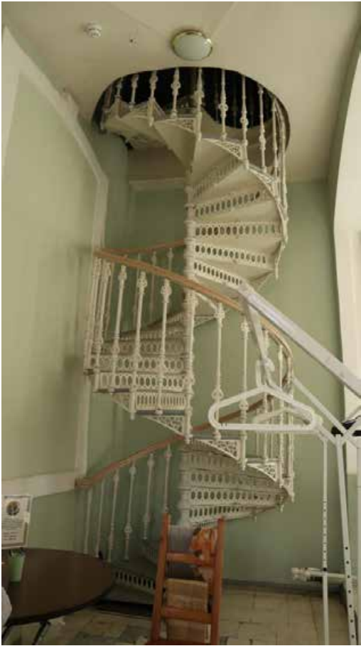
Фото 63. Винтовая лестница на чердак.
