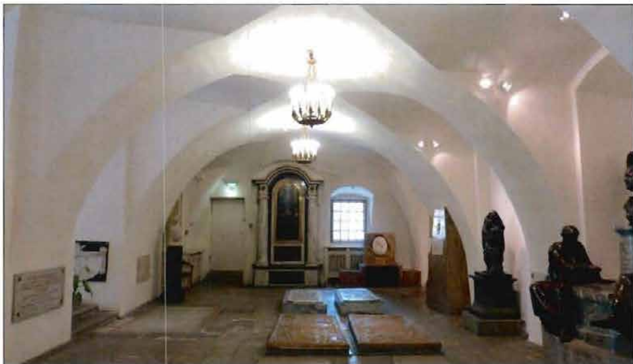
4. Сводчатые перекрытия в уровне первого этажа.
