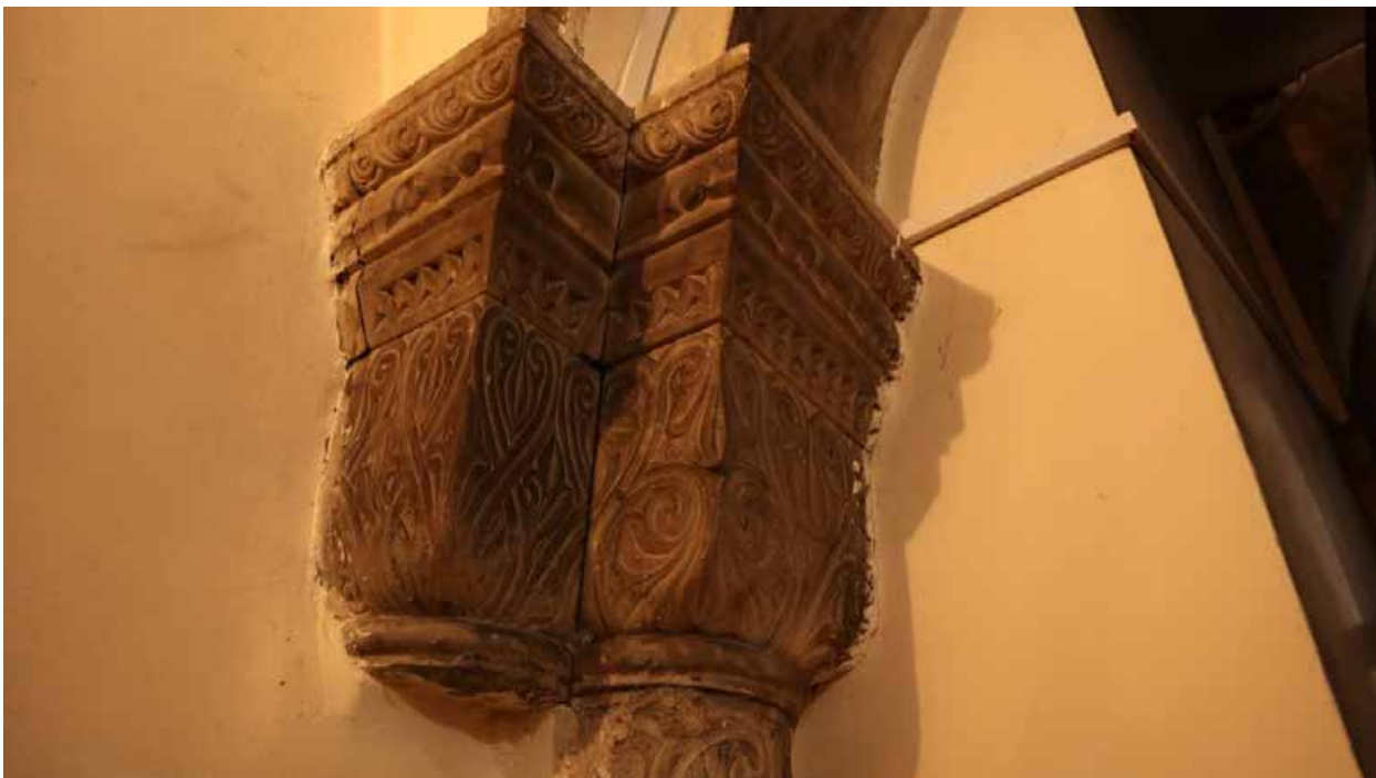
Фото 25. Оформление проема в помещении 3. Капители полуколонн.
