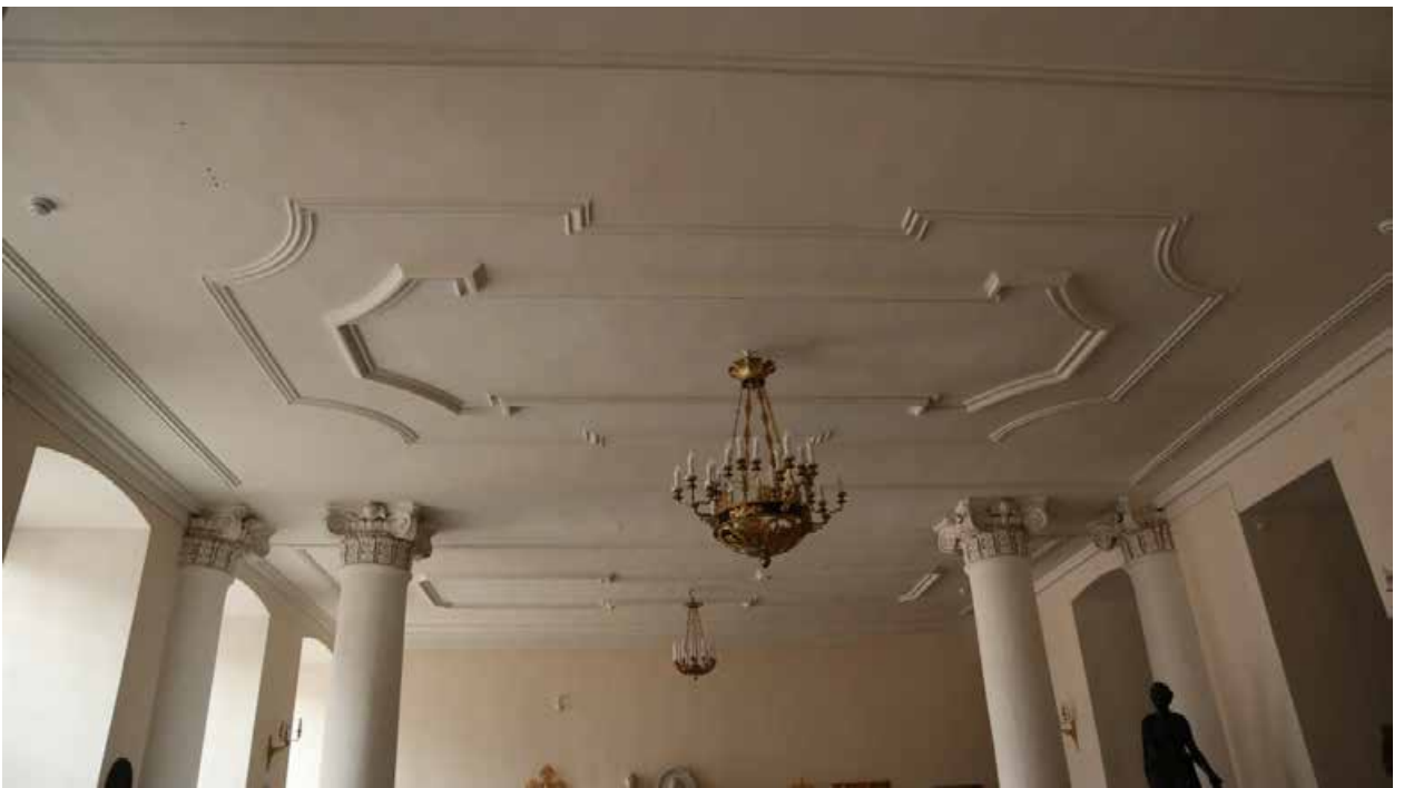
Фото 34. Основное помещение (пом. 5)
