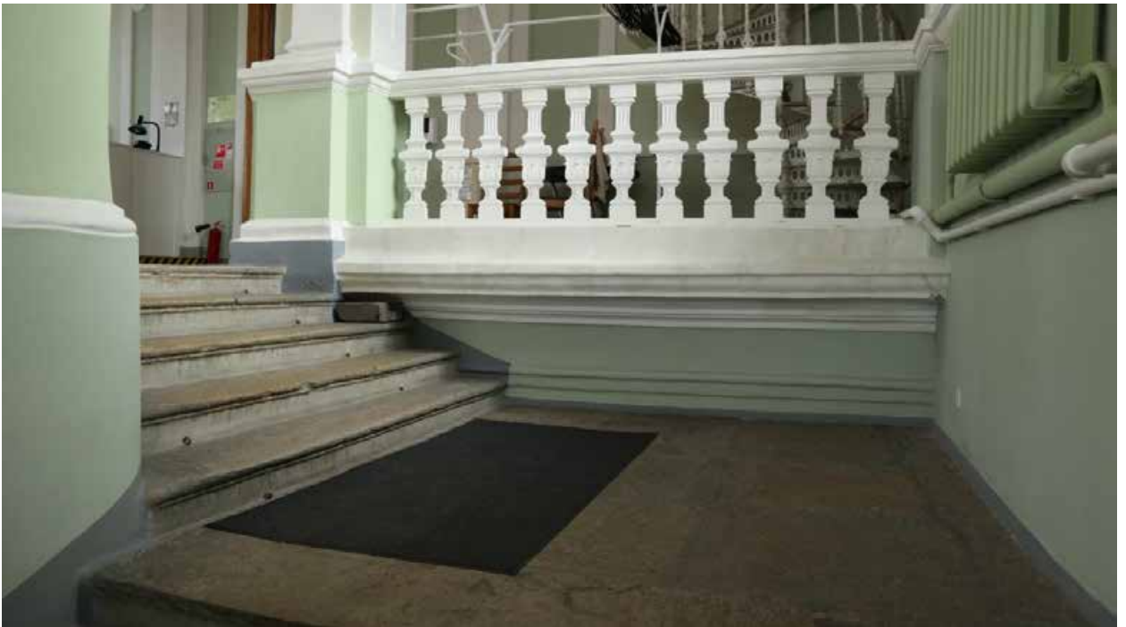
Фото 60. Площадка лестницы на 2 этаж.
