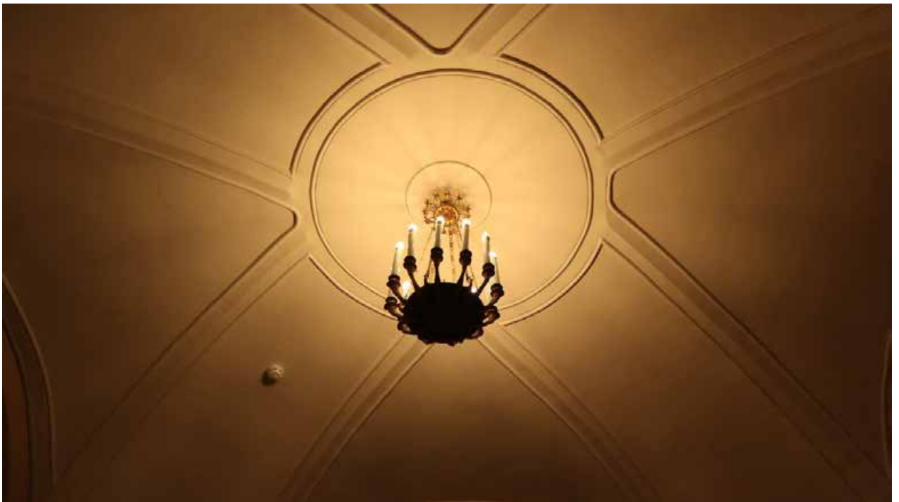
Фото 8. Оформление потолка помещения 2.
