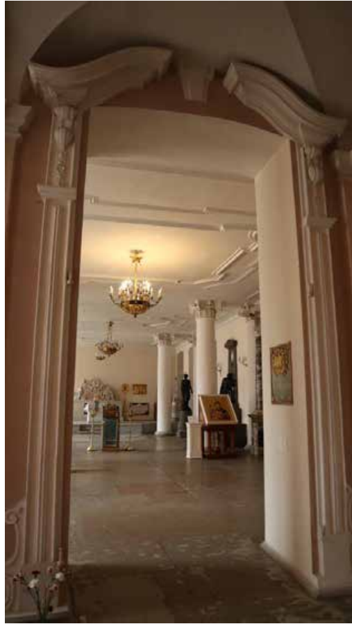
Фото 28. Оформление проема, ведущего в осн.пом.
