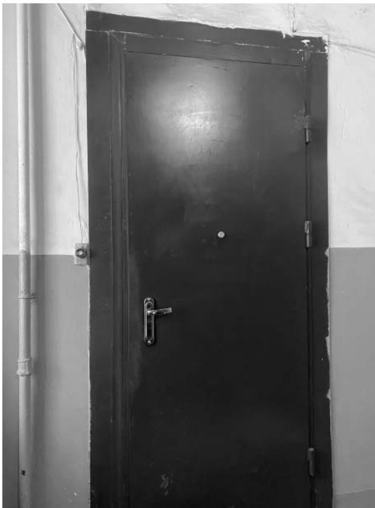
2. Вид на входную дверь в квартиру;
