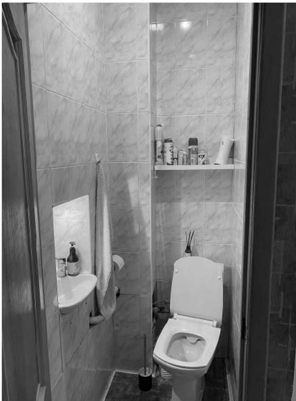
9. Фрагмент интеръера санузла (помещение 2);
