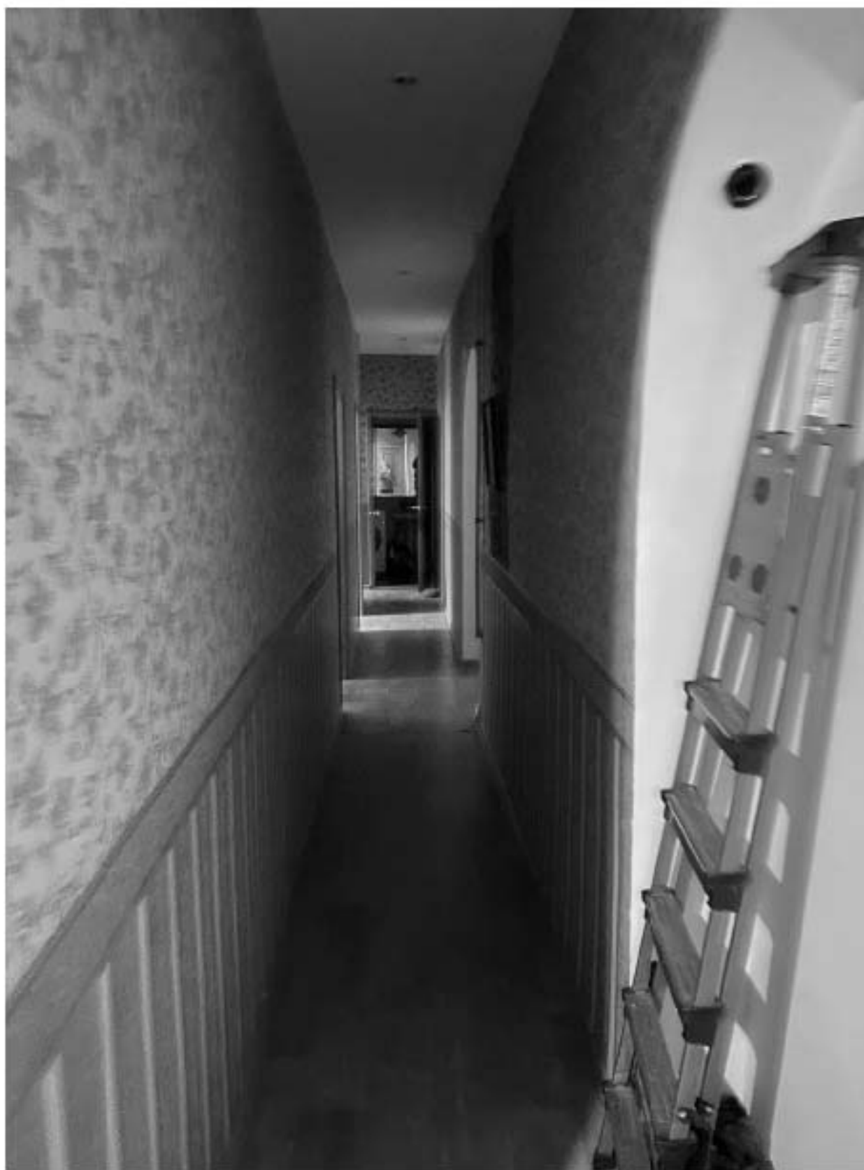
8. Вид на коридор (помещение 3);
