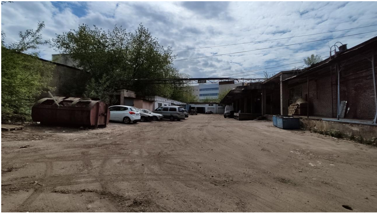
Фото 8. Точка фотофиксации Ф5. Вид на юго-запад, вдоль юго-восточного края Участка.
