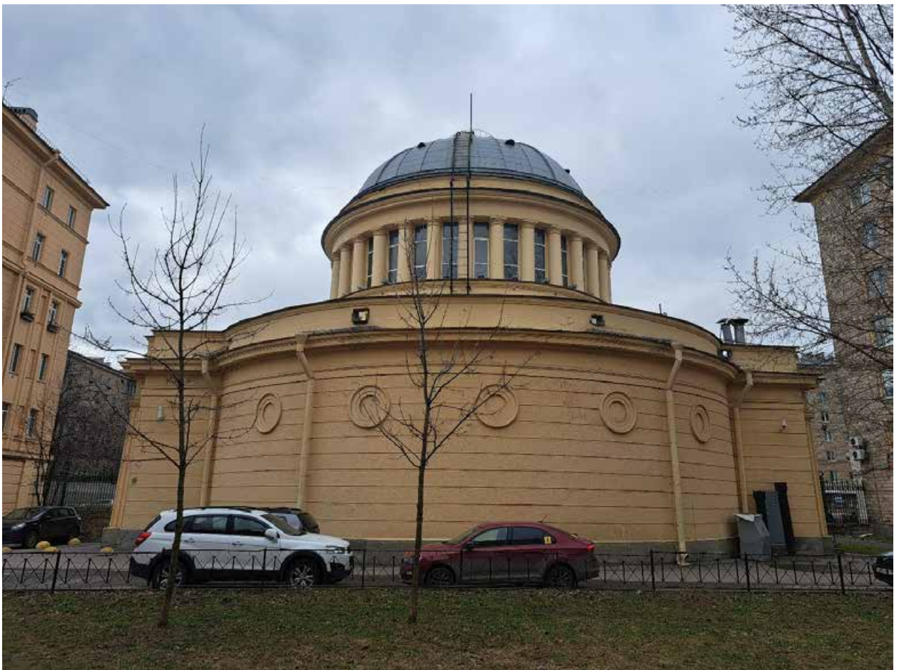
Фото №3. Восточный фасад, общий вид.
