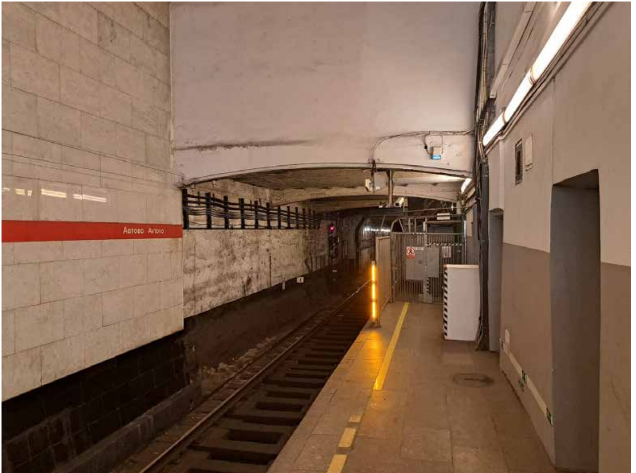
Фото №37. Вестибюль перронного зала.
