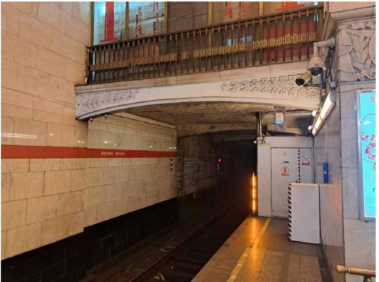
Фото №46. Вестибюль перронного зала.
