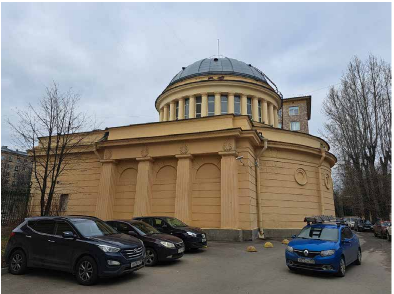
Фото №2. Южный фасад, общий вид.
