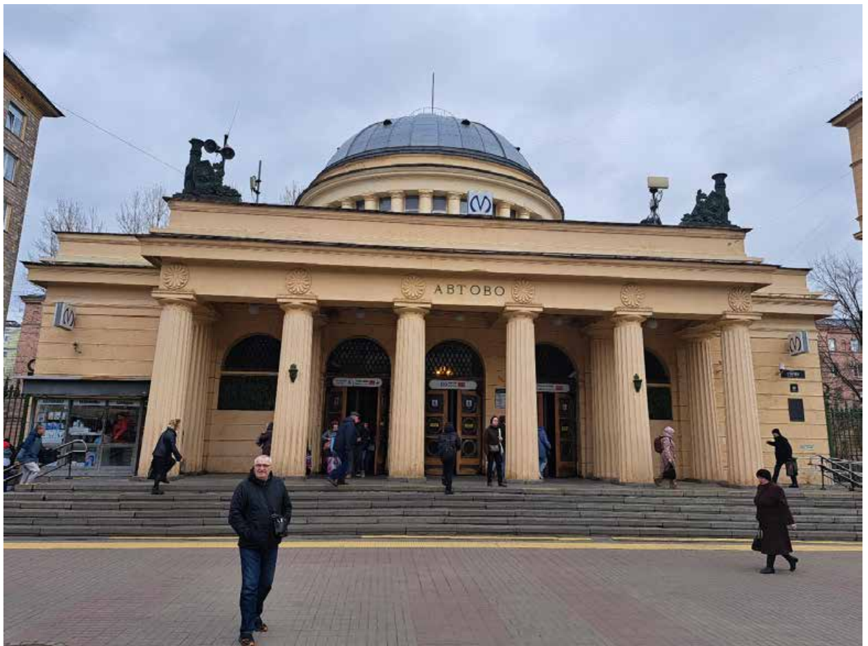
Фото №1. Западный фасад, общий вид.
