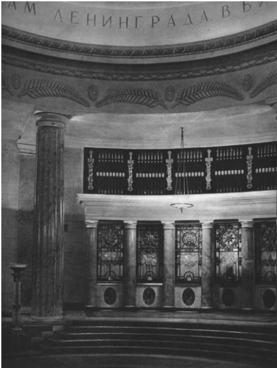
Илл. 10. Станция метро «Автово». Верхний кассовый зал. 1950-е гг. Citywalls: Архитектурный сайт Санкт-Петербурга [Электронный ресурс] URL: https://www.citywalls.ru/photo68112.html
