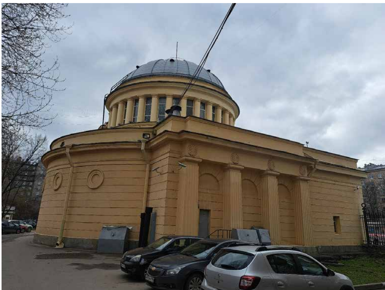
Фото №4. Северный фасад, общий вид.
