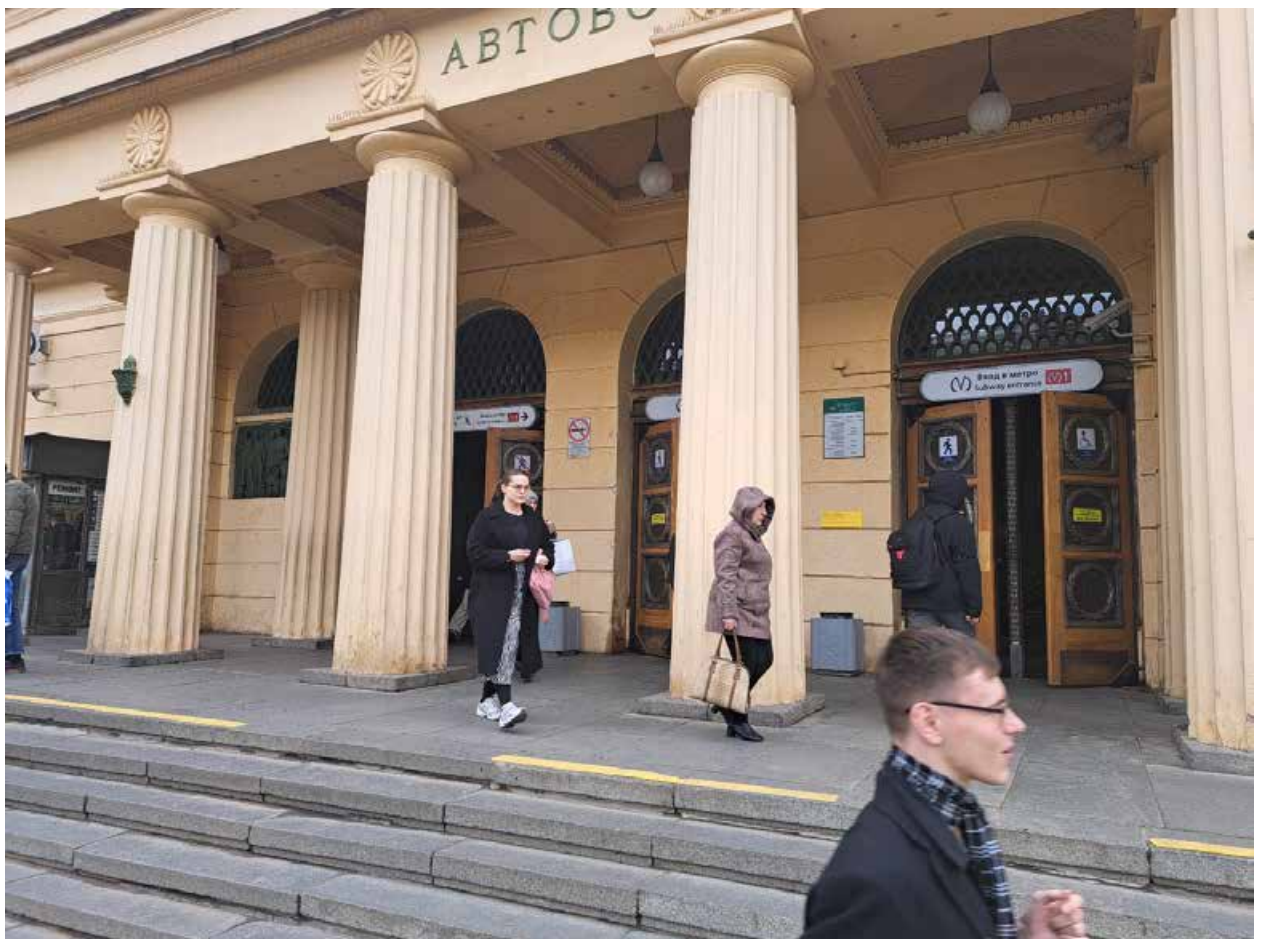
Фото №5. Западный фасад, вход.
