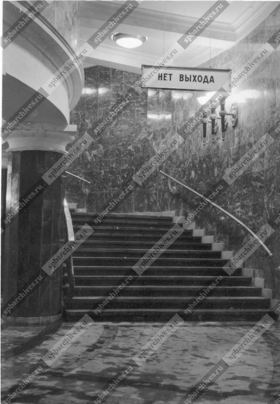
Илл. 11. Винтовая лестница с облицовкой из красного мрамора, ведущая в подземный зал станции метро «Автово». Архитекторы Е.А. Левинсон, А.А. Грушке, инж. С.М. Эпштейн, 1955 г. ЦГАКФФД СПб. Фотодокумент Бр 71161.
