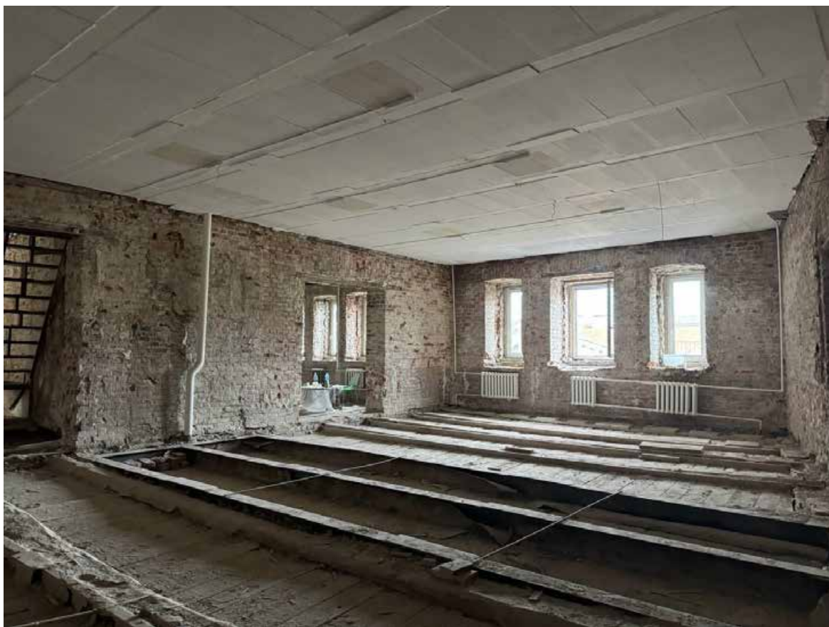
Фото 7. Вид на помещения №№ 8 и 9.
