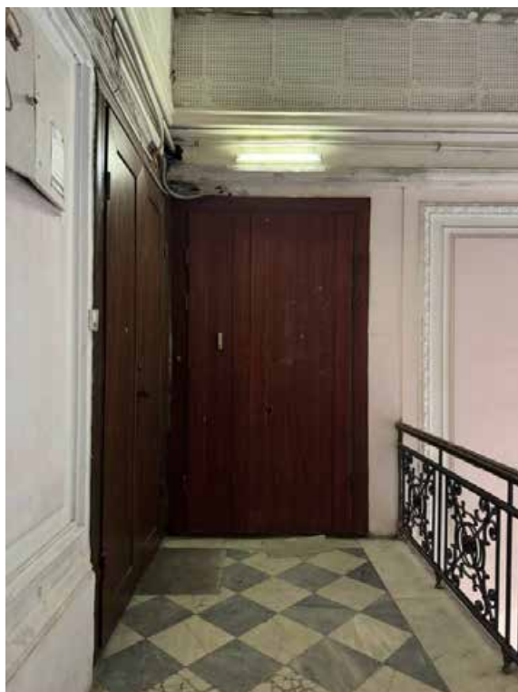
Фото 1. Вид на входную дверь.
