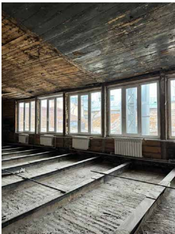
Фото 14. Окна в уровне мансардного этажа.
