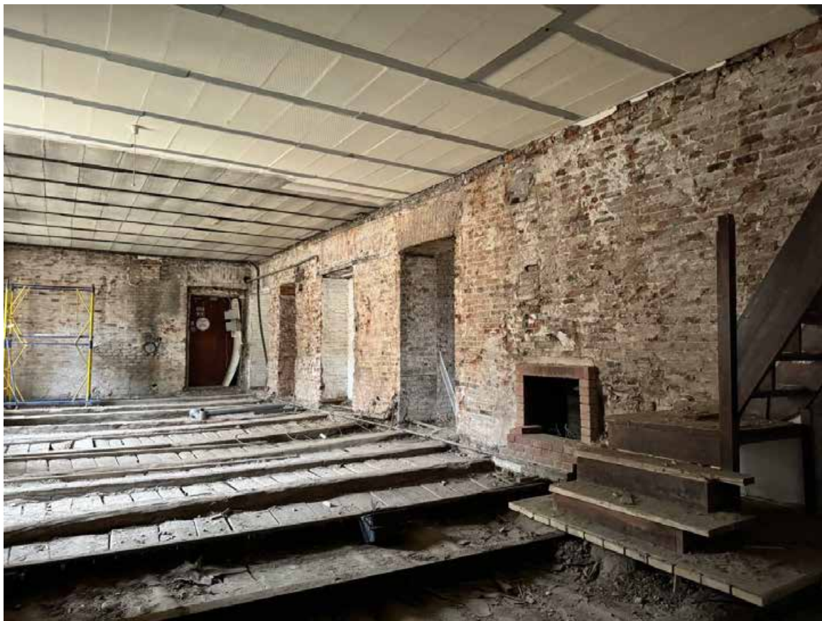
Фото 6. Вид на помещения №№ 1, 2, 3, 11.
