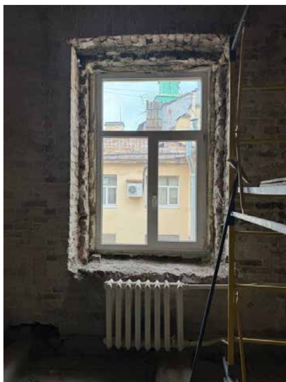
Фото 3. Окно в помещении № 3.
