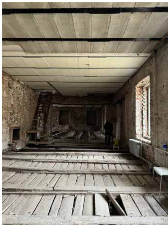
Фото 2. Вид на помещения №№ 1, 2, 3, 11.
