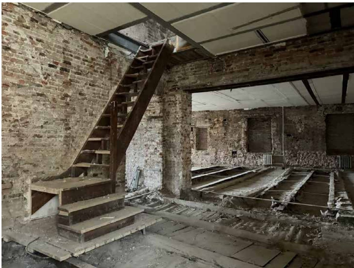
Фото 5. Лестница, ведущая на мансардный этаж.
