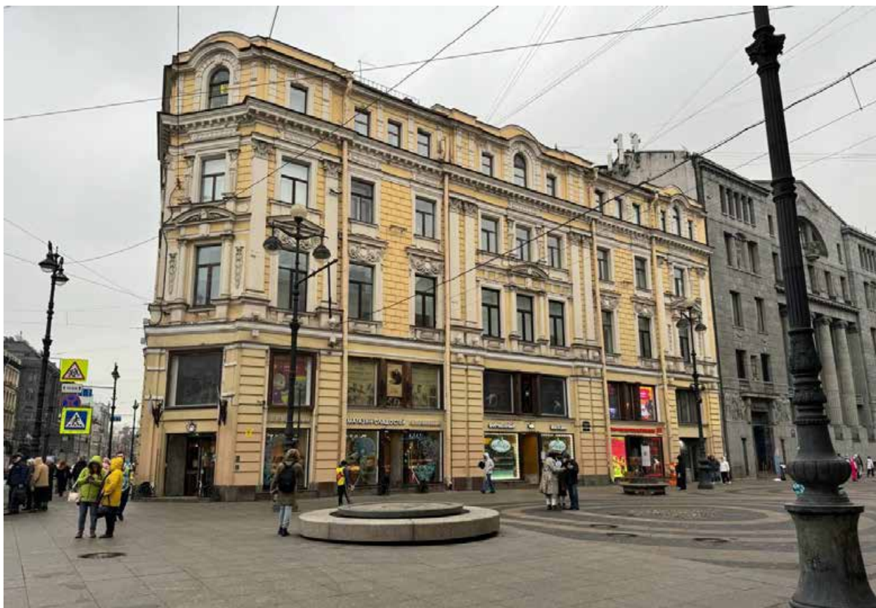
Фото 3. Перспективный вид исследуемого объекта с угла Невского проспекта и Большой Морской улицы.
