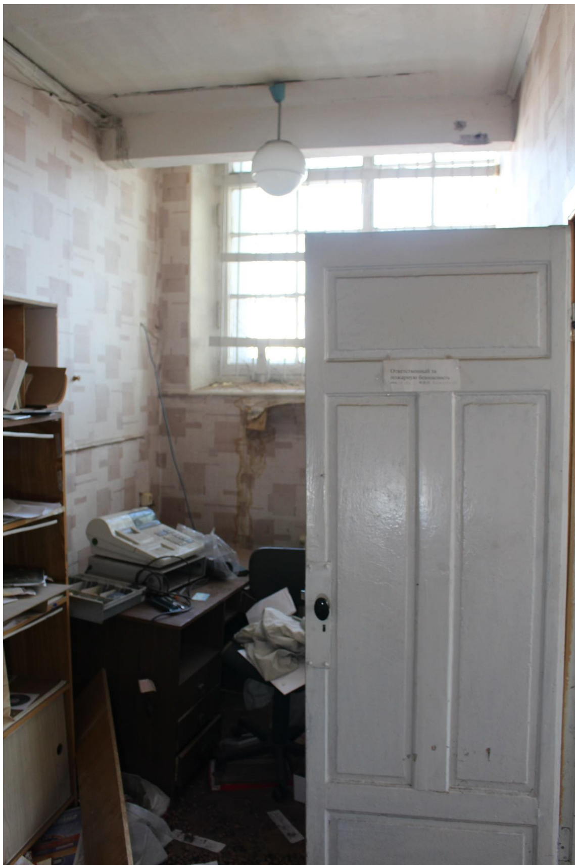
Фото 60. Здание по адресу: Санкт-Петербург, 17-я линия В.О., дом 54, корпус 5, литера Б объекта культурного наследия регионального значения «Блок цехов (с двумя трубами) и котельная с дымовой трубой». Внутренние помещения 2-го этажа.
