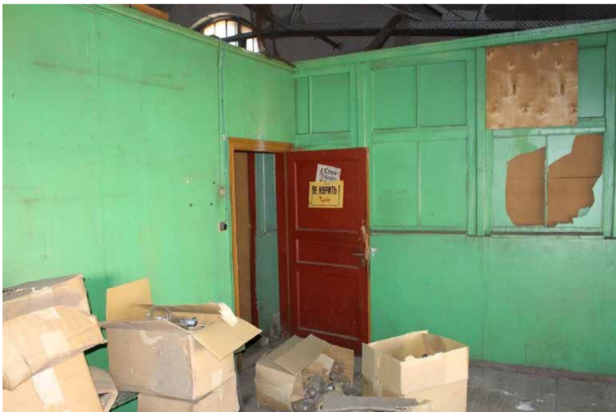
Фото 86. Здание по адресу: Санкт-Петербург, 17-я линия В.О., дом 54, корпус 5, литера Б объекта культурного наследия регионального значения «Блок цехов (с двумя трубами) и котельная с дымовой трубой». Внутренние помещения антресольного этажа.
