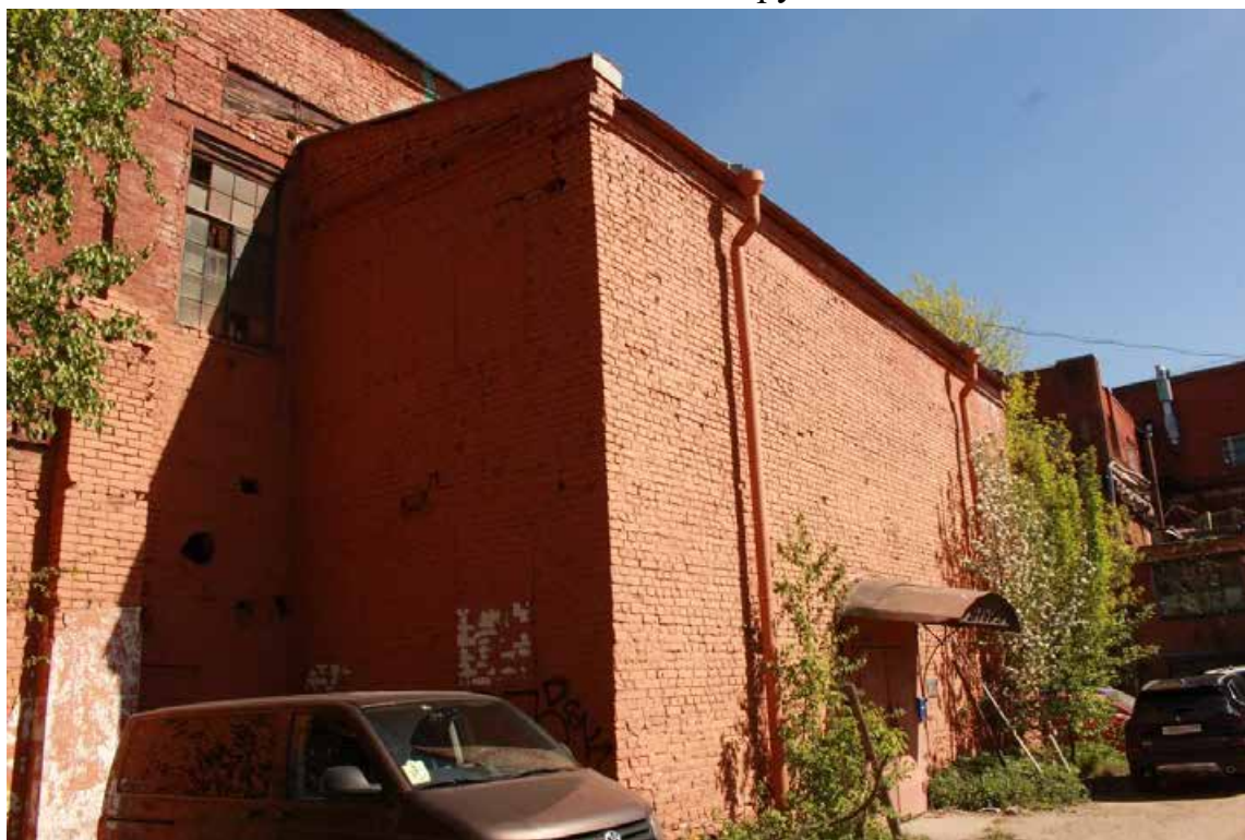
Фото 4. Вид на пристройку к юго-западному фасаду Вид на юго-восточный фасад здания по адресу: Санкт-Петербург, 17-я линия В.О., дом 54, корпус 5, литера Б объекта культурного наследия регионального значения «Блок цехов (с двумя трубами) и котельная с дымовой трубой».
