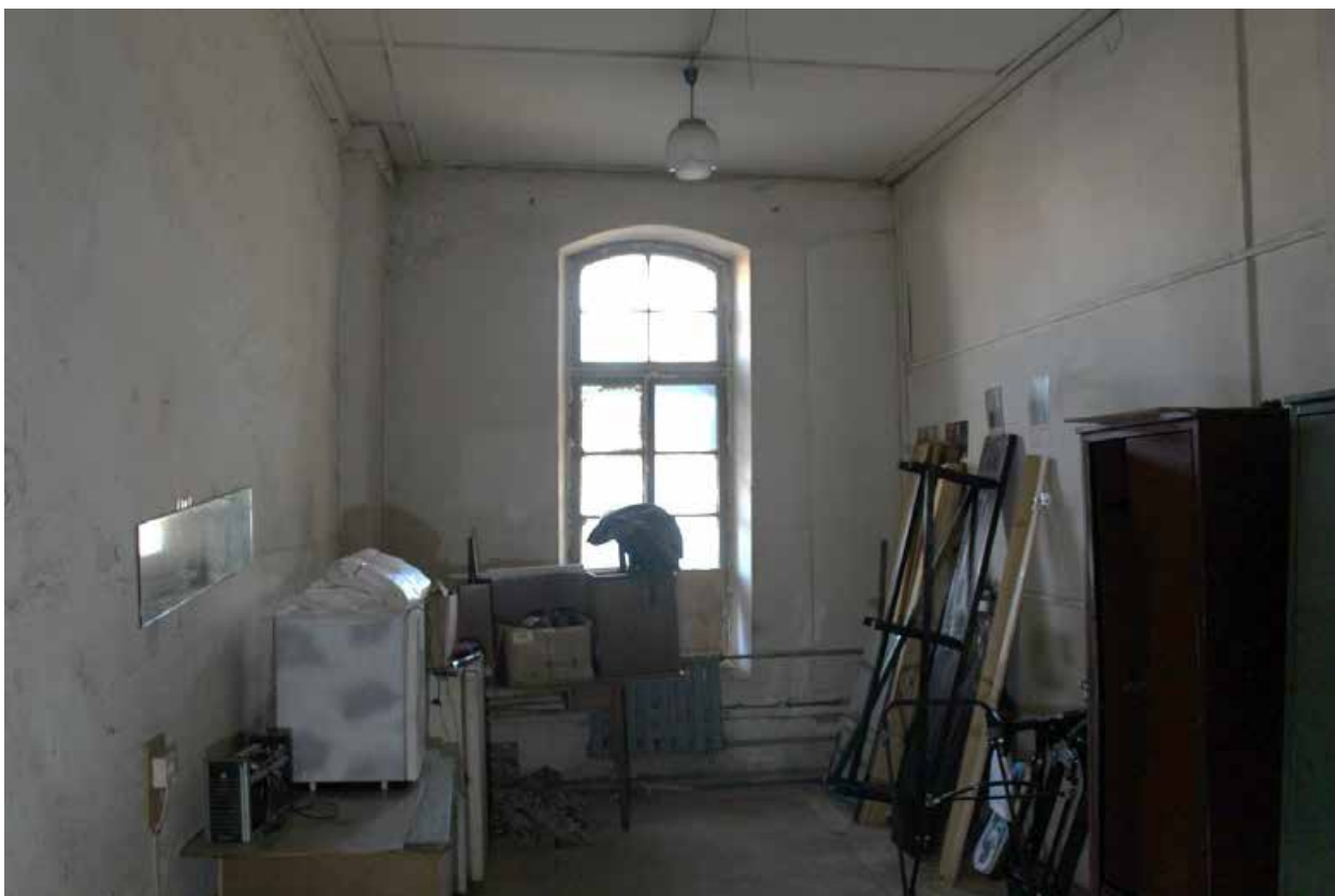
Фото 27. Здание по адресу: Санкт-Петербург, 17-я линия В.О., дом 54, корпус 5, литера Б объекта культурного наследия регионального значения «Блок цехов (с двумя трубами) и котельная с дымовой трубой». Внутренние помещения 1-го этажа.
