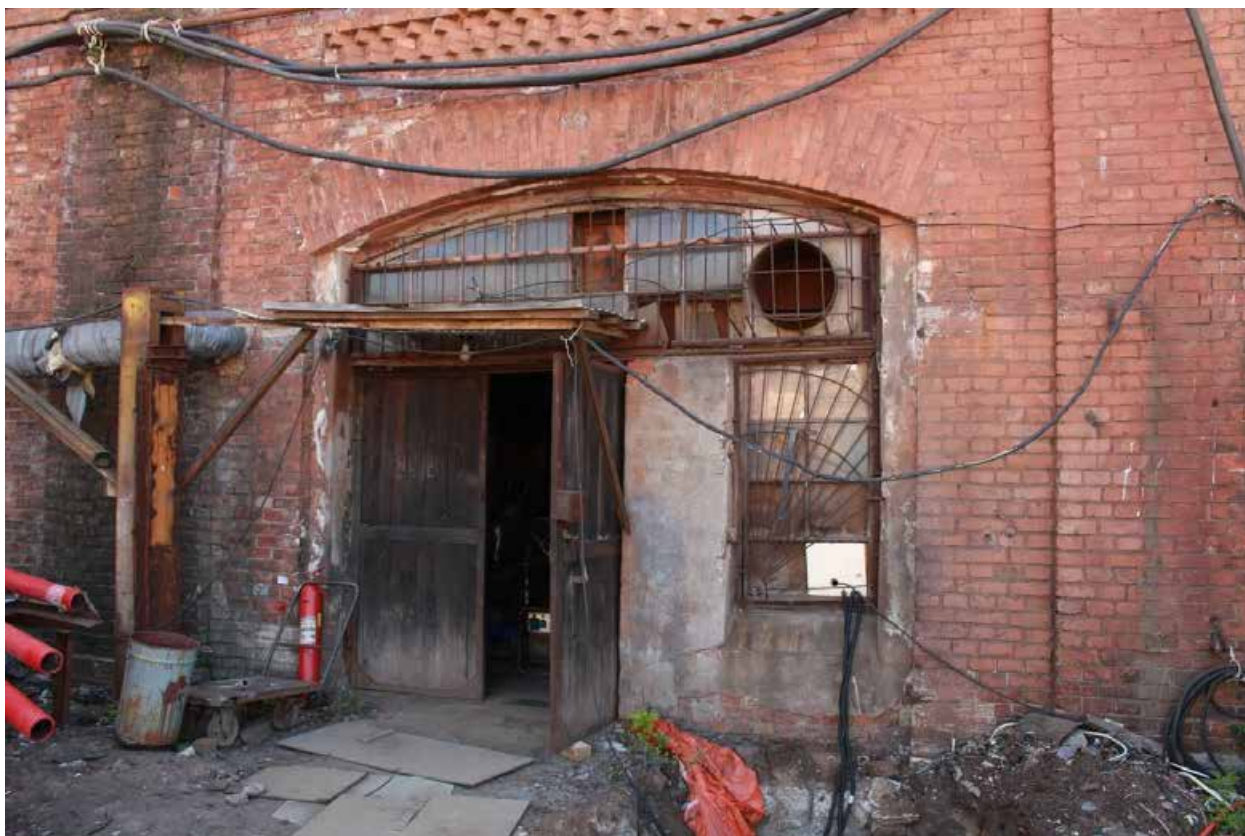
Фото 11. Фрагмент северо-восточного фасада здания по адресу: Санкт-Петербург, 17-я линия В.О., дом 54, корпус 5, литера Б объекта культурного наследия регионального значения «Блок цехов (с двумя трубами) и котельная с дымовой трубой».
