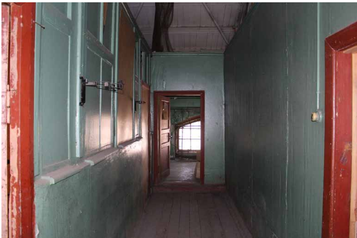
Фото 80. Здание по адресу: Санкт-Петербург, 17-я линия В.О., дом 54, корпус 5, литера Б объекта культурного наследия регионального значения «Блок цехов (с двумя трубами) и котельная с дымовой трубой». Внутренние помещения антресольного этажа.
