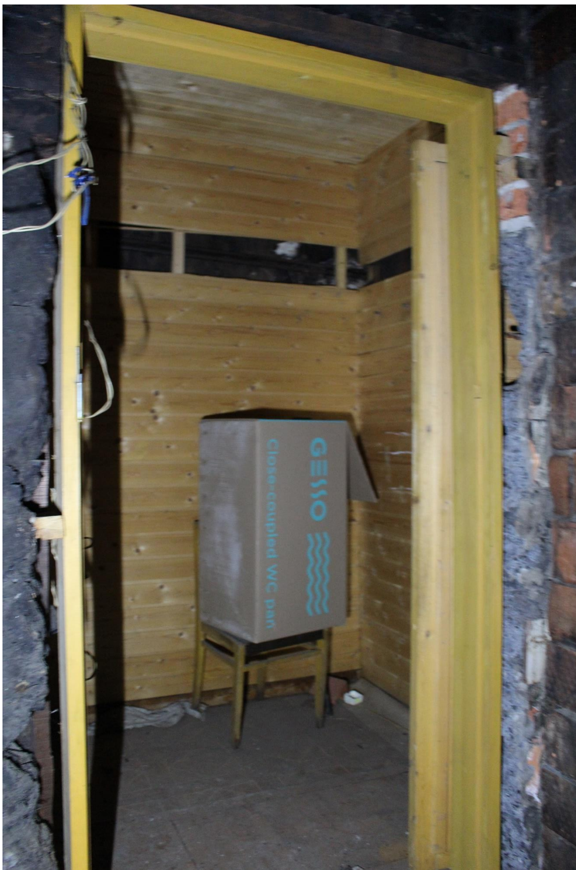
Фото 50. Здание по адресу: Санкт-Петербург, 17-я линия В.О., дом 54, корпус 5, литера Б объекта культурного наследия регионального значения «Блок цехов (с двумя трубами) и котельная с дымовой трубой». Внутренние помещения 2-го этажа.
