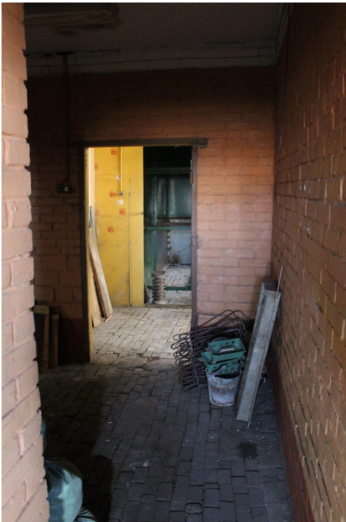
Фото 70. Здание по адресу: Санкт-Петербург, 17-я линия В.О., дом 54, корпус 5, литера Б объекта культурного наследия регионального значения «Блок цехов (с двумя трубами) и котельная с дымовой трубой». Внутренние помещения 2-го этажа.
