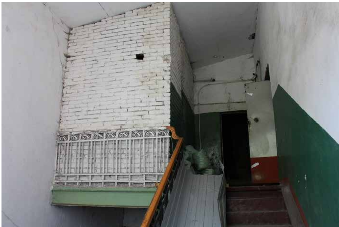
Фото 47. Здание по адресу: Санкт-Петербург, 17-я линия В.О., дом 54, корпус 5, литера Б объекта культурного наследия регионального значения «Блок цехов (с двумя трубами) и котельная с дымовой трубой». Вид на лестничную клетку на уровне 2-го этажа.
