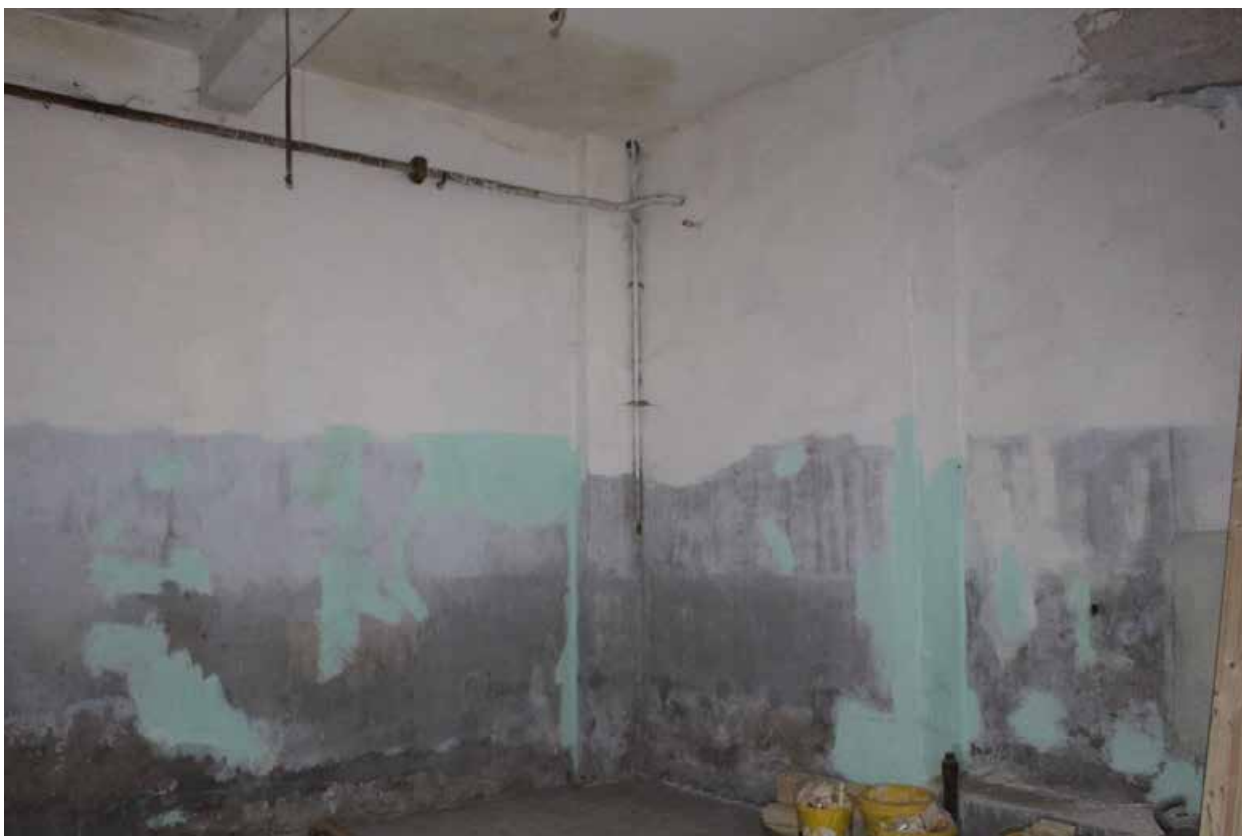
Фото 32. Здание по адресу: Санкт-Петербург, 17-я линия В.О., дом 54, корпус 5, литера Б объекта культурного наследия регионального значения «Блок цехов (с двумя трубами) и котельная с дымовой трубой». Внутренние помещения 1-го этажа.
