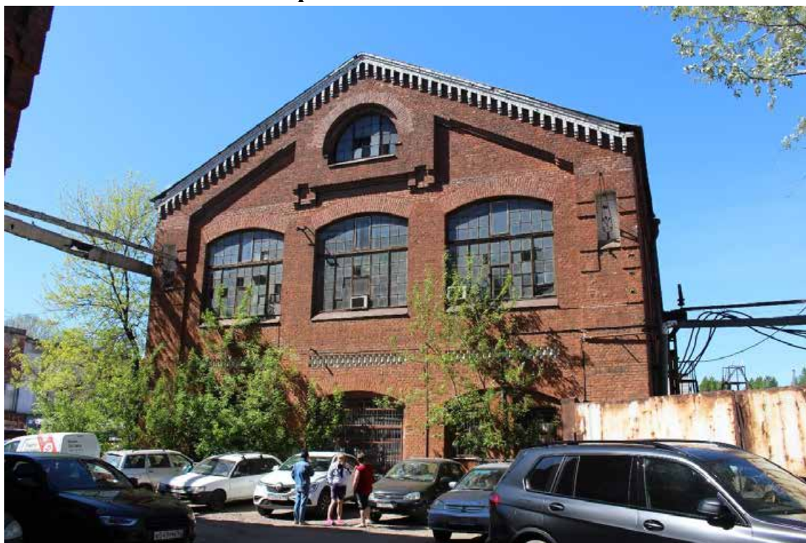
Фото 1. Вид на юго-восточный фасад здания по адресу: Санкт-Петербург, 17-я линия В.О., дом 54, корпус 5, литера Б объекта культурного наследия регионального значения «Блок цехов (с двумя трубами) и котельная с дымовой трубой».
