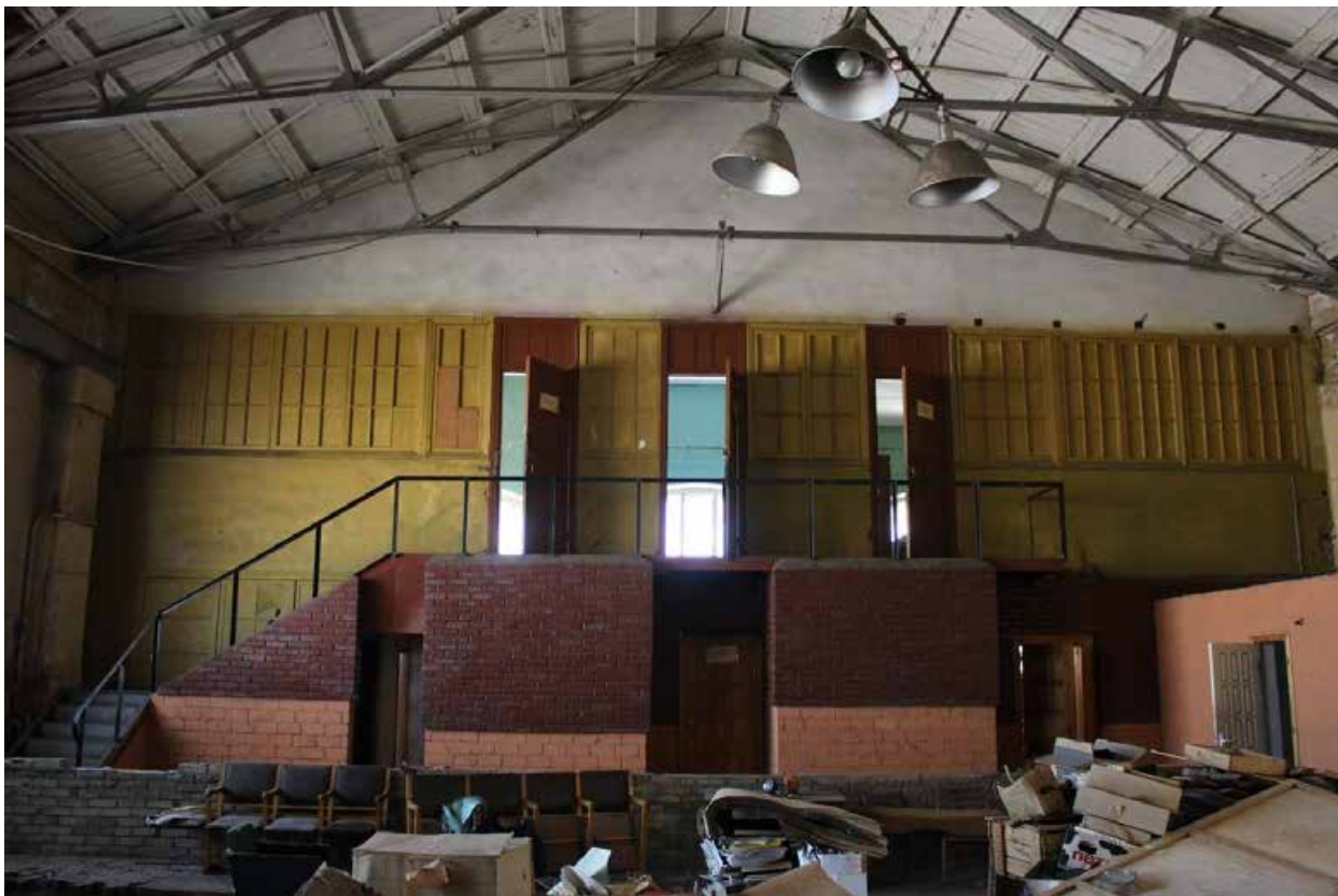
Фото 53. Здание по адресу: Санкт-Петербург, 17-я линия В.О., дом 54, корпус 5, литера Б объекта культурного наследия регионального значения «Блок цехов (с двумя трубами) и котельная с дымовой трубой». Внутренние помещения 2-го этажа.
