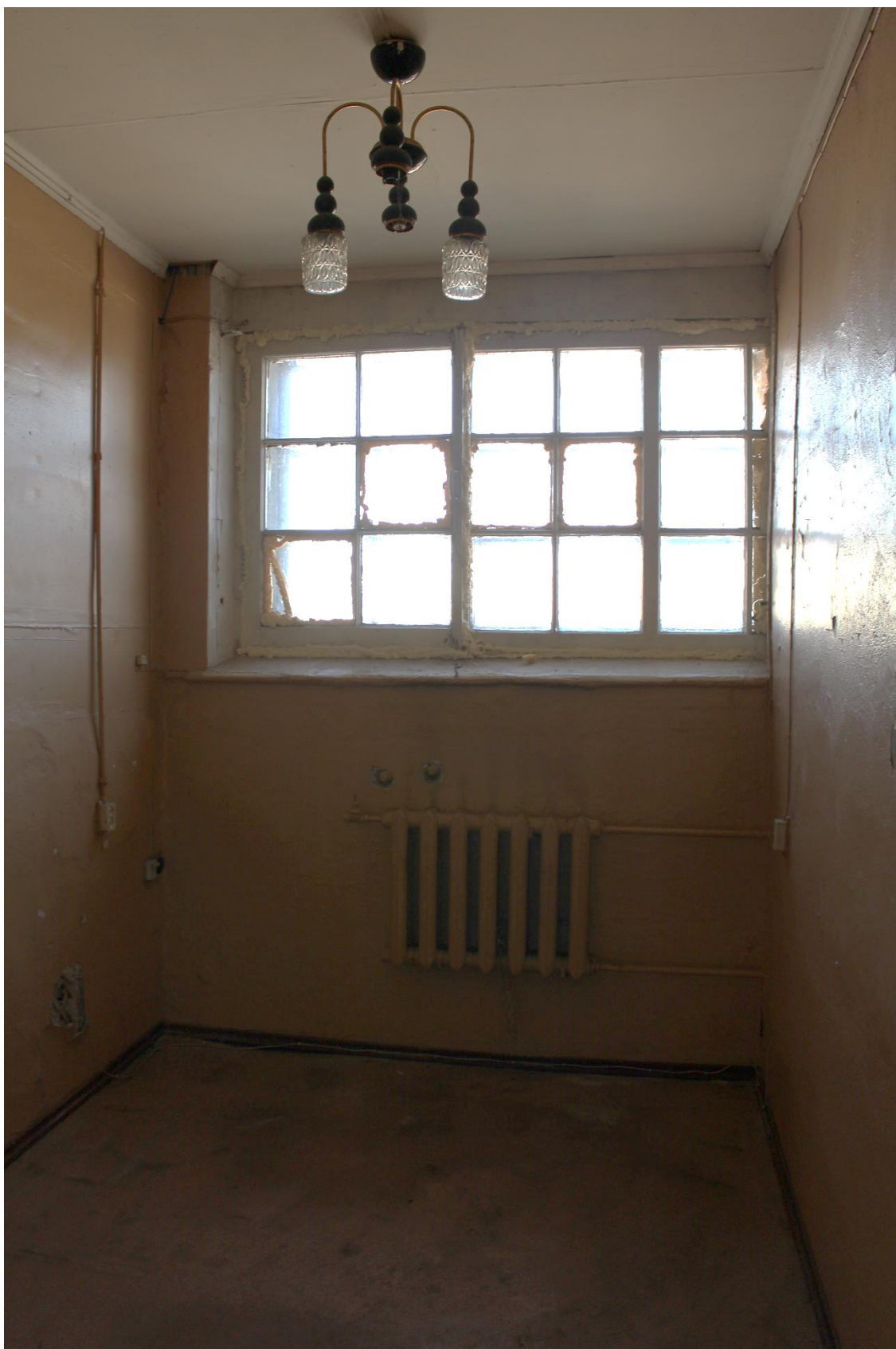
Фото 71. Здание по адресу: Санкт-Петербург, 17-я линия В.О., дом 54, корпус 5, литера Б объекта культурного наследия регионального значения «Блок цехов (с двумя трубами) и котельная с дымовой трубой». Внутренние помещения 2-го этажа.
