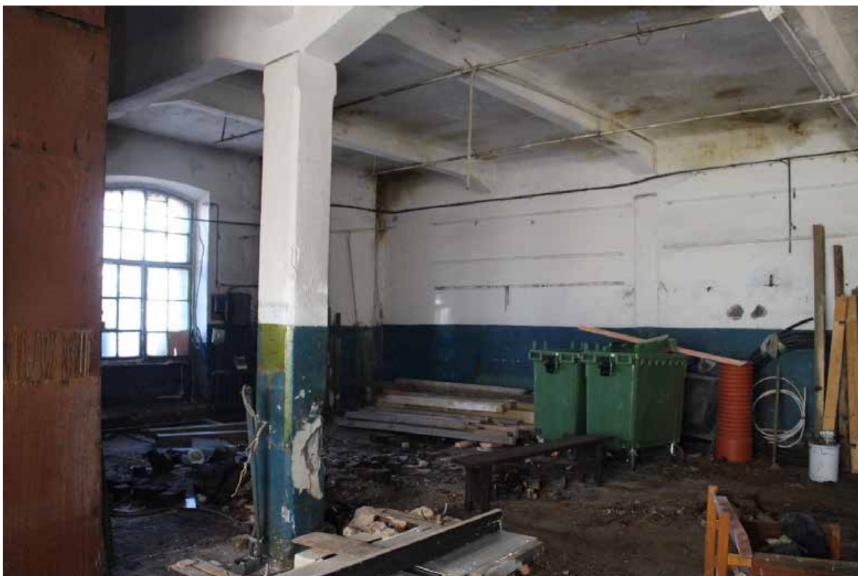
Фото 34. Здание по адресу: Санкт-Петербург, 17-я линия В.О., дом 54, корпус 5, литера Б объекта культурного наследия регионального значения «Блок цехов (с двумя трубами) и котельная с дымовой трубой». Внутренние помещения 1-го этажа.
