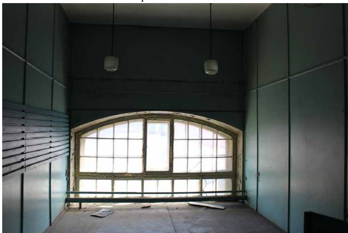
Фото 65. Здание по адресу: Санкт-Петербург, 17-я линия В.О., дом 54, корпус 5, литера Б объекта культурного наследия регионального значения «Блок цехов (с двумя трубами) и котельная с дымовой трубой». Внутренние помещения антресольного этажа.
