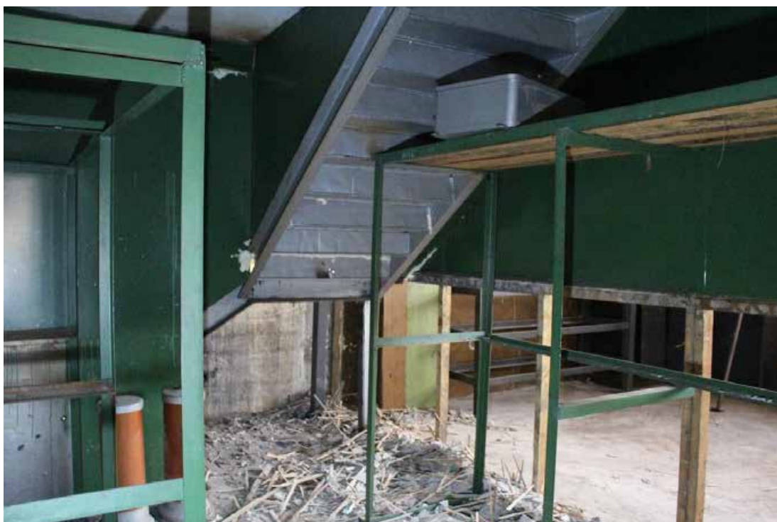
Фото 75. Здание по адресу: Санкт-Петербург, 17-я линия В.О., дом 54, корпус 5, литера Б объекта культурного наследия регионального значения «Блок цехов (с двумя трубами) и котельная с дымовой трубой». Внутренние помещения 2-го этажа.
