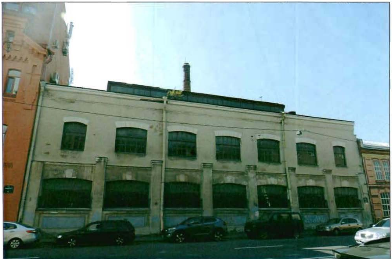
3. Лицевой фасад по 17-й линии В.О.
