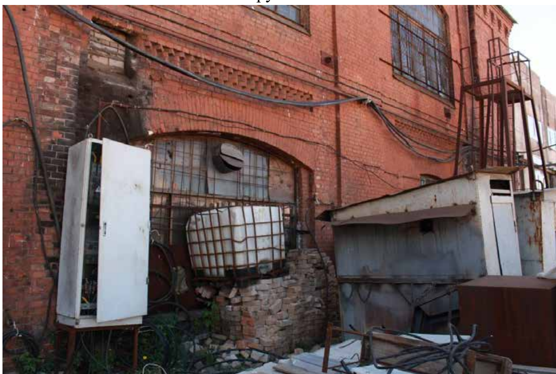
Фото 10. Фрагмент северо-восточного фасада здания по адресу: Санкт-Петербург, 17-я линия В.О., дом 54, корпус 5, литера Б объекта культурного наследия регионального значения «Блок цехов (с двумя трубами) и котельная с дымовой трубой».
