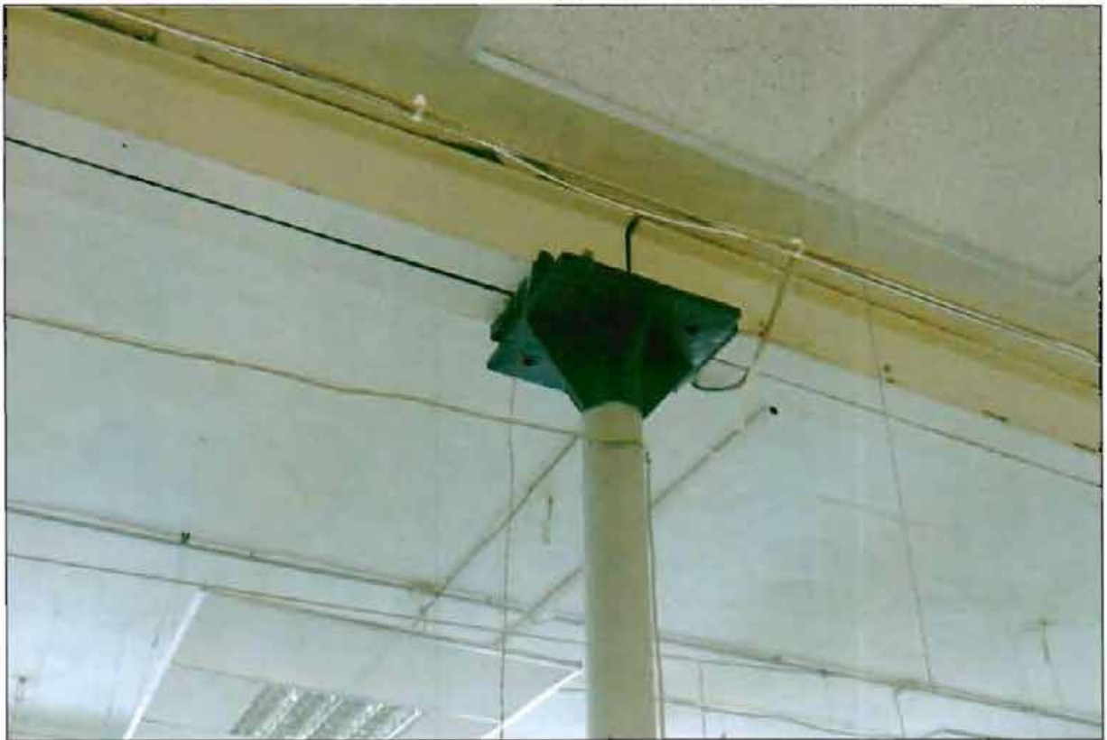
7. Интерьер. Фрагмент. Конструкция перекрытия.
