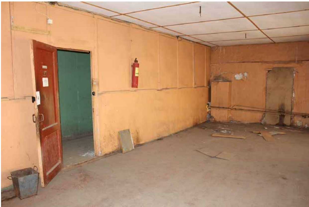
Фото 82. Здание по адресу: Санкт-Петербург, 17-я линия В.О., дом 54, корпус 5, литера Б объекта культурного наследия регионального значения «Блок цехов (с двумя трубами) и котельная с дымовой трубой». Внутренние помещения антресольного этажа.
