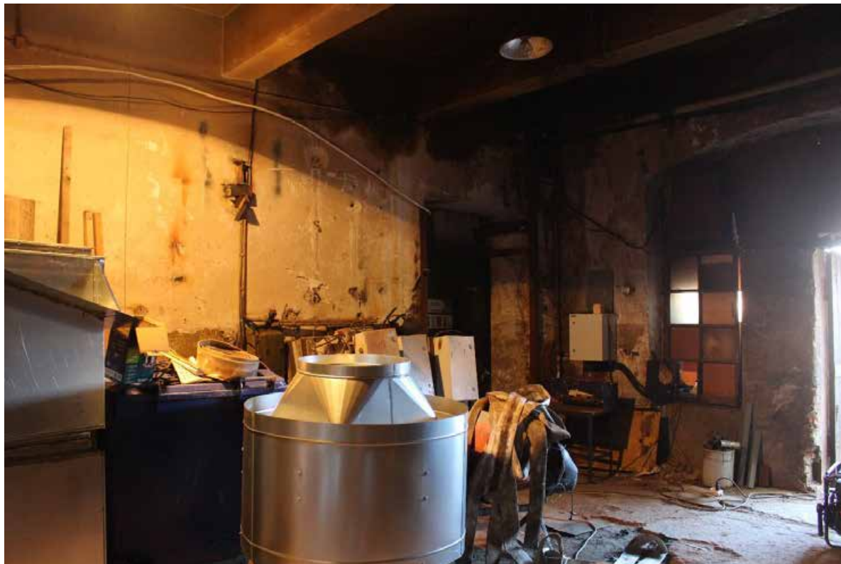
Фото 14. Здание по адресу: Санкт-Петербург, 17-я линия В.О., дом 54, корпус 5, литера Б объекта культурного наследия регионального значения «Блок цехов (с двумя трубами) и котельная с дымовой трубой». Внутренние помещения 1-го этажа.
