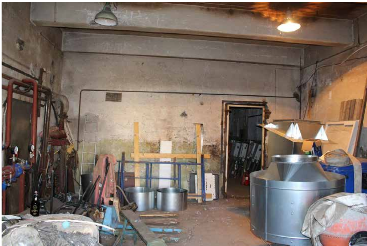
Фото 13. Здание по адресу: Санкт-Петербург, 17-я линия В.О., дом 54, корпус 5, литера Б объекта культурного наследия регионального значения «Блок цехов (с двумя трубами) и котельная с дымовой трубой». Внутренние помещения 1-го этажа.
