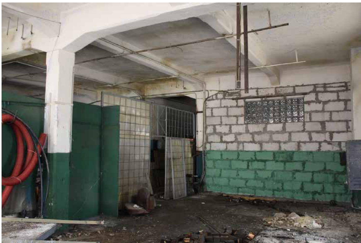
Фото 39. Здание по адресу: Санкт-Петербург, 17-я линия В.О., дом 54, корпус 5, литера Б объекта культурного наследия регионального значения «Блок цехов (с двумя трубами) и котельная с дымовой трубой». Внутренние помещения 1-го этажа.
