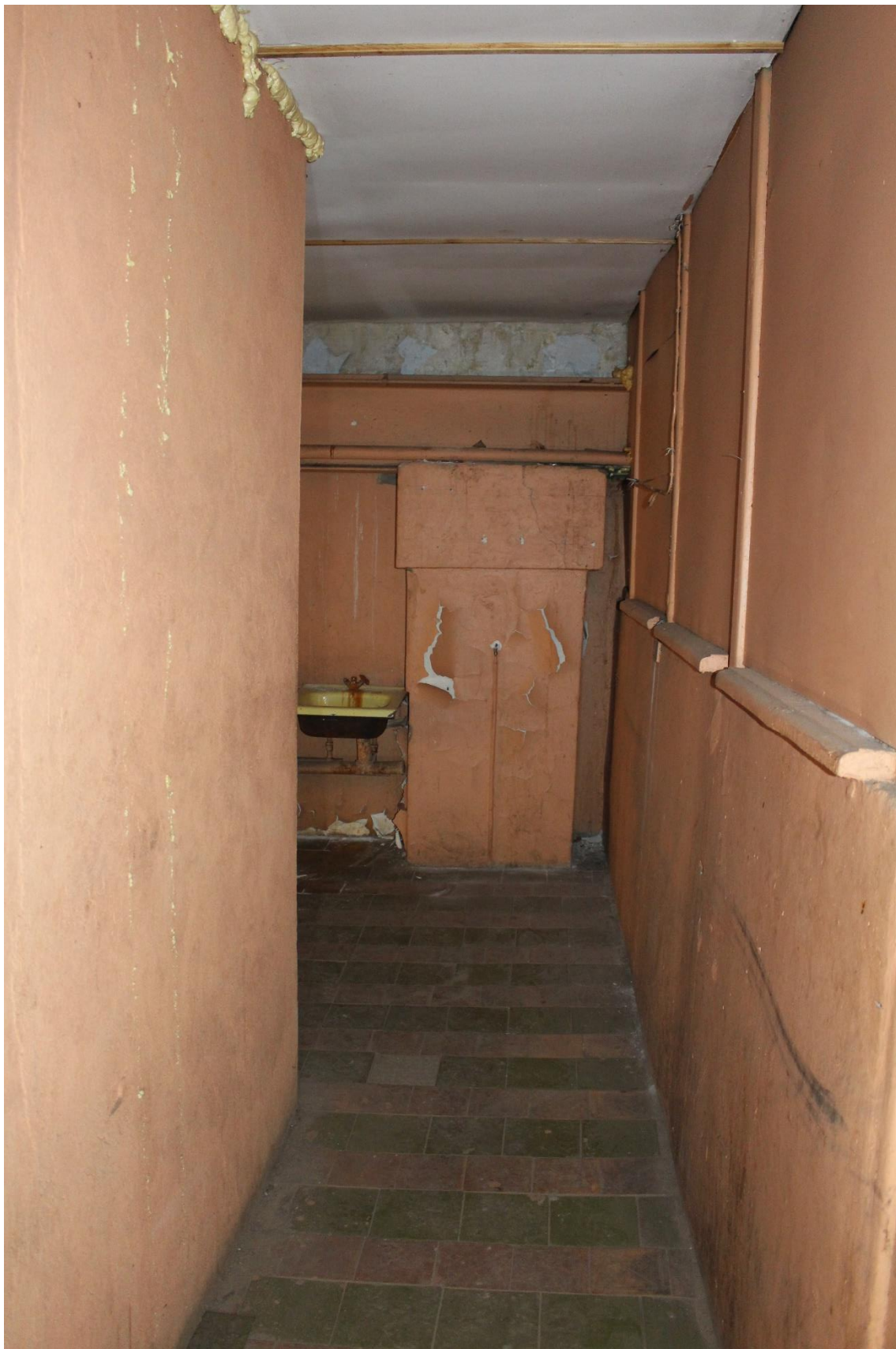
Фото 83. Здание по адресу: Санкт-Петербург, 17-я линия В.О., дом 54, корпус 5, литера Б объекта культурного наследия регионального значения «Блок цехов (с двумя трубами) и котельная с дымовой трубой». Внутренние помещения антресольного этажа.
