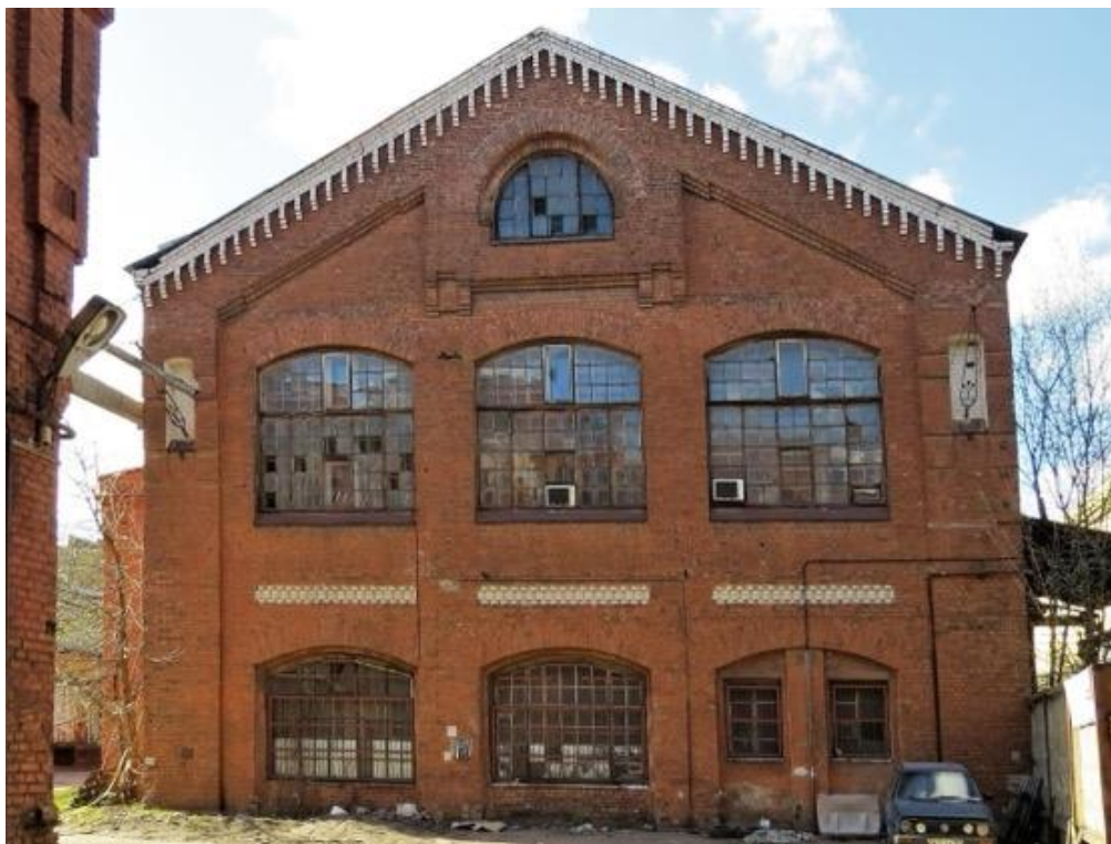
Илл. 177. Военно-подковный завод Посселя . Корпус (двор). 2017 г. (источник: https://www.citywalls.ru/photo592361.html ).
