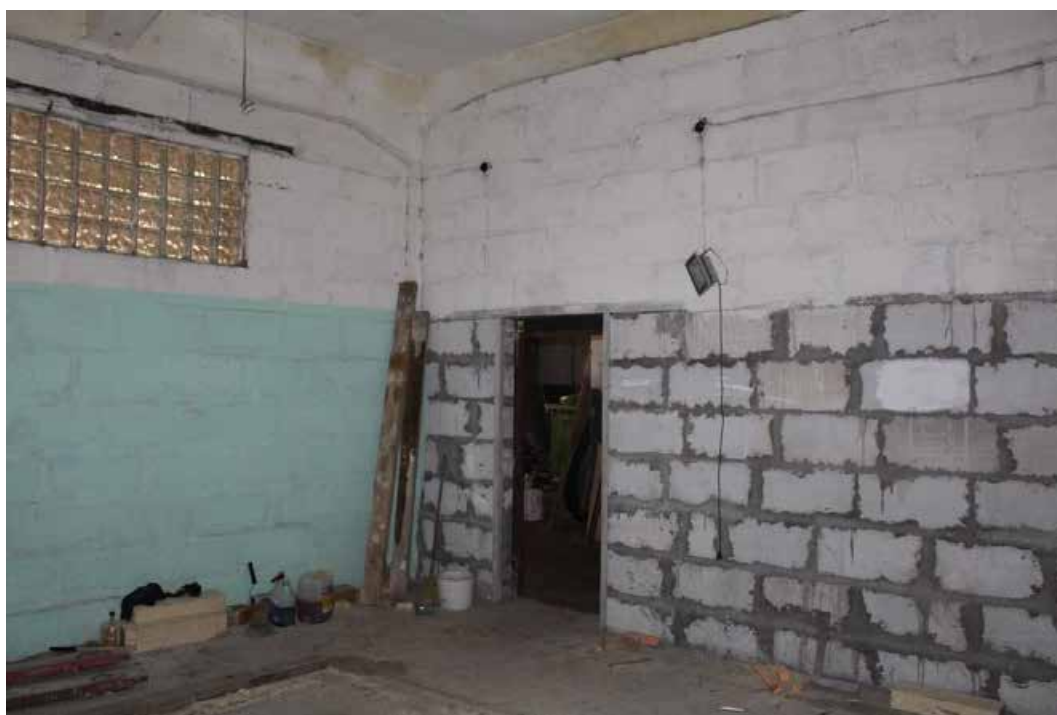
Фото 33. Здание по адресу: Санкт-Петербург, 17-я линия В.О., дом 54, корпус 5, литера Б объекта культурного наследия регионального значения «Блок цехов (с двумя трубами) и котельная с дымовой трубой». Внутренние помещения 1-го этажа.
