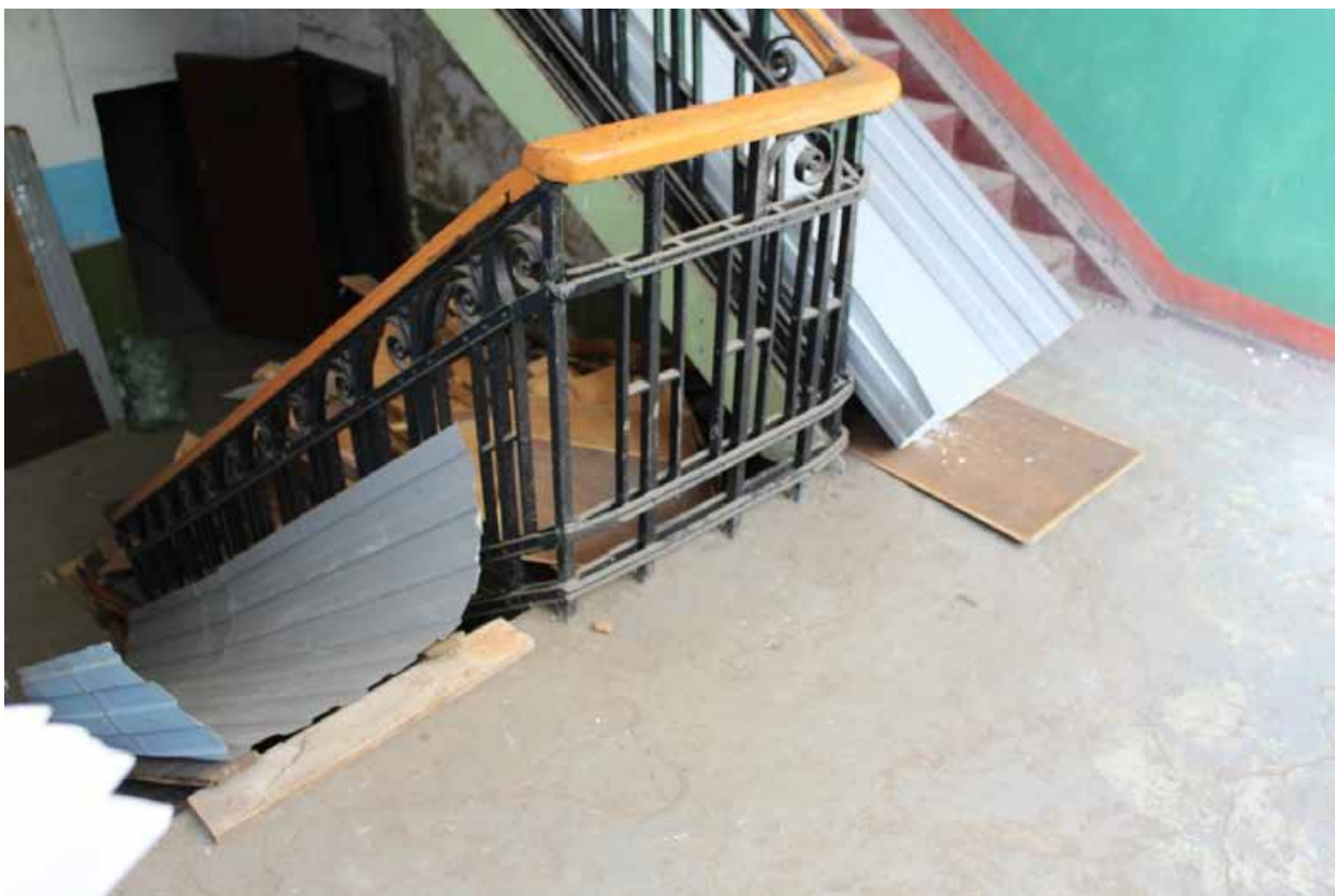
Фото 46. Здание по адресу: Санкт-Петербург, 17-я линия В.О., дом 54, корпус 5, литера Б объекта культурного наследия регионального значения «Блок цехов (с двумя трубами) и котельная с дымовой трубой». Вид на междуэтажную площадку.
