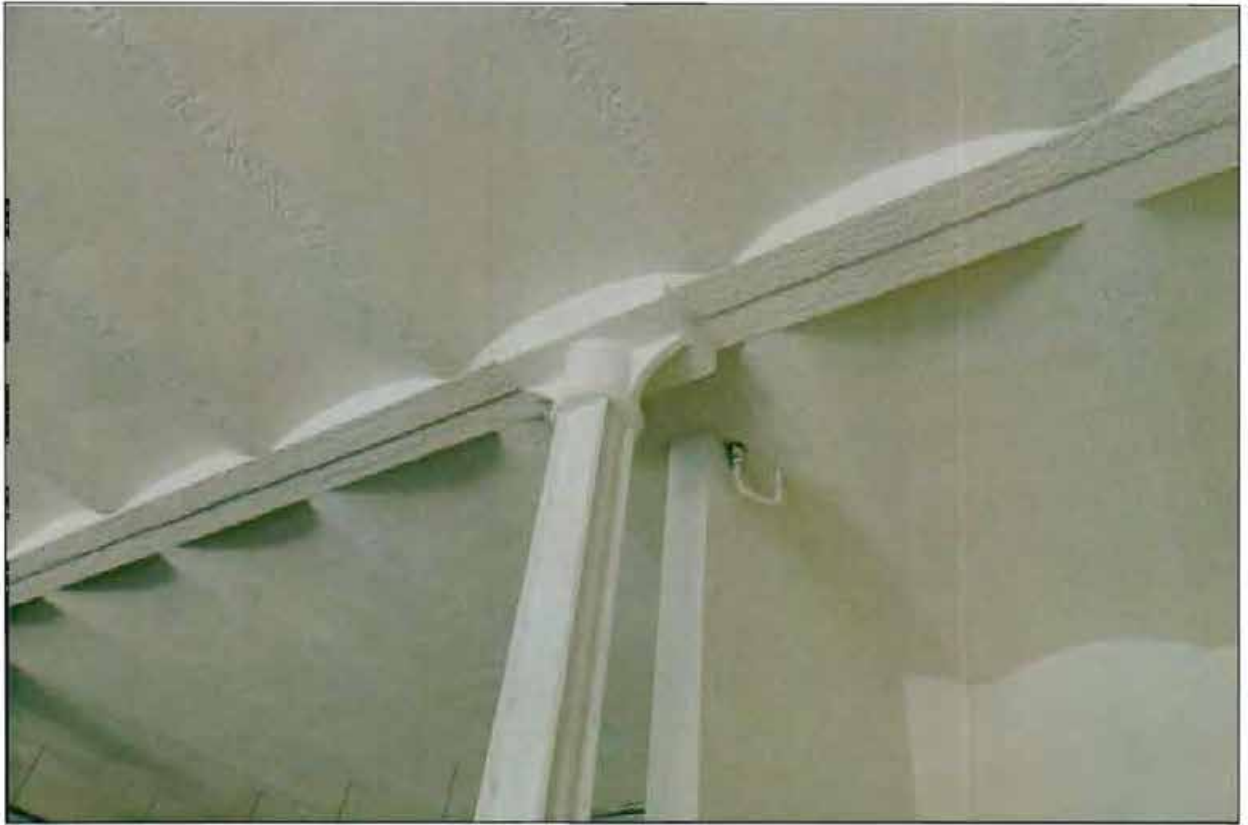
6. Интерьер. Фрагмент. Конструкция перекрытия.
