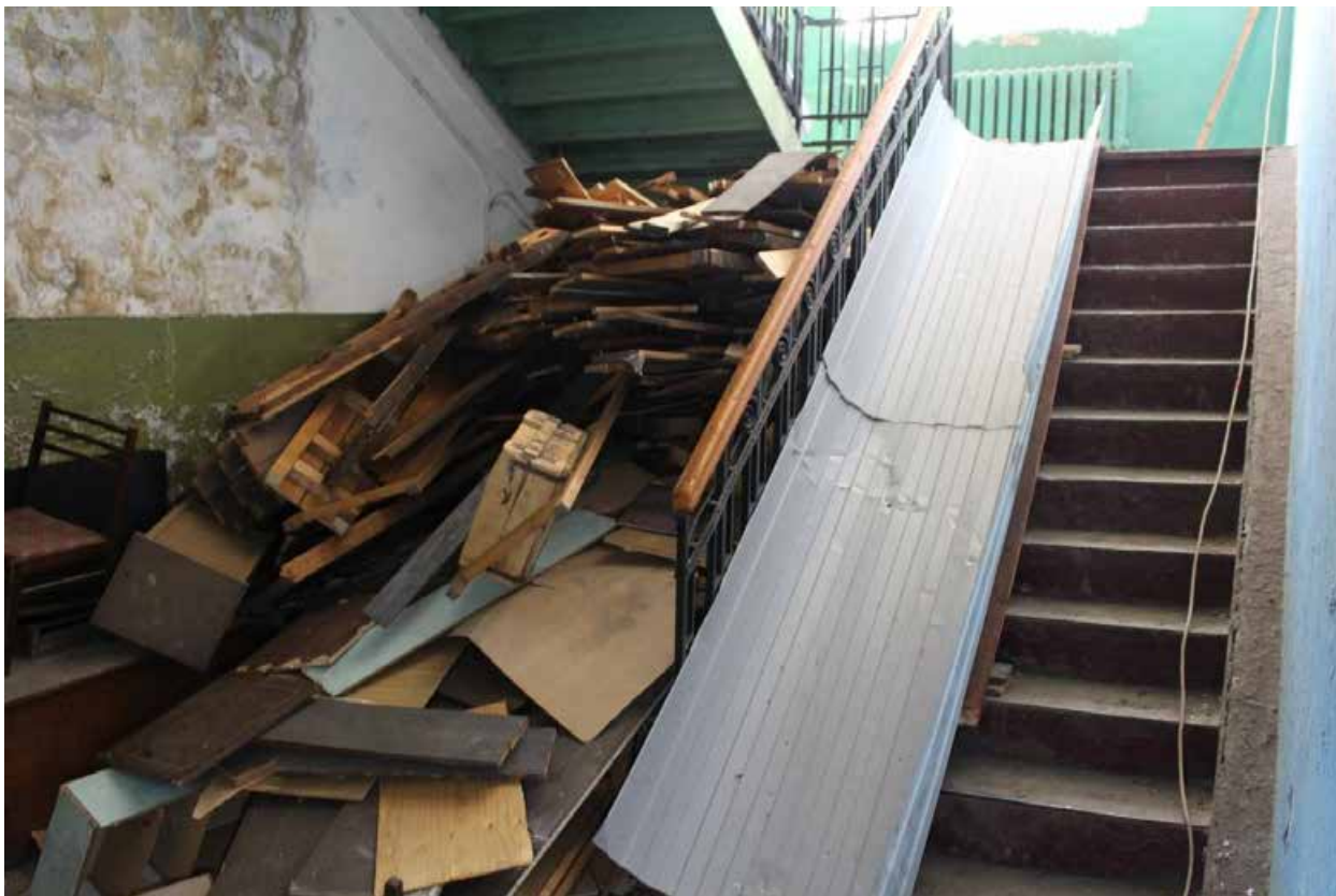
Фото 44. Здание по адресу: Санкт-Петербург, 17-я линия В.О., дом 54, корпус 5, литера Б объекта культурного наследия регионального значения «Блок цехов (с двумя трубами) и котельная с дымовой трубой». Вид на лестницу в уровне 1-го этажа.
