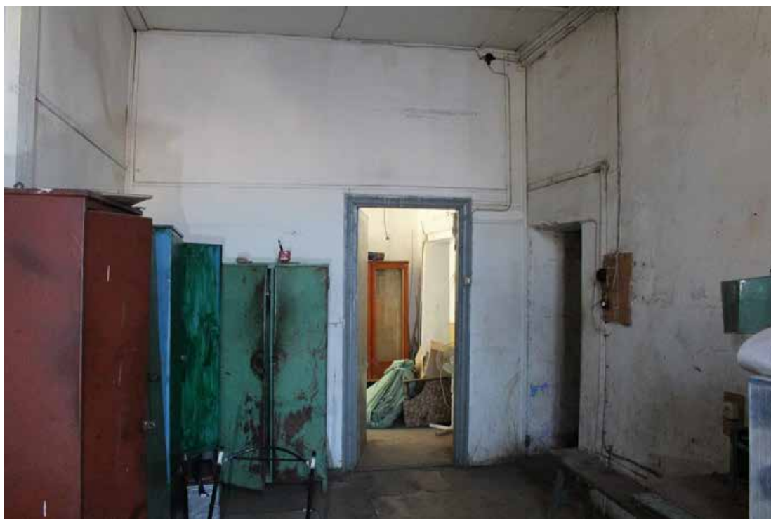
Фото 28. Здание по адресу: Санкт-Петербург, 17-я линия В.О., дом 54, корпус 5, литера Б объекта культурного наследия регионального значения «Блок цехов (с двумя трубами) и котельная с дымовой трубой». Внутренние помещения 1-го этажа.
