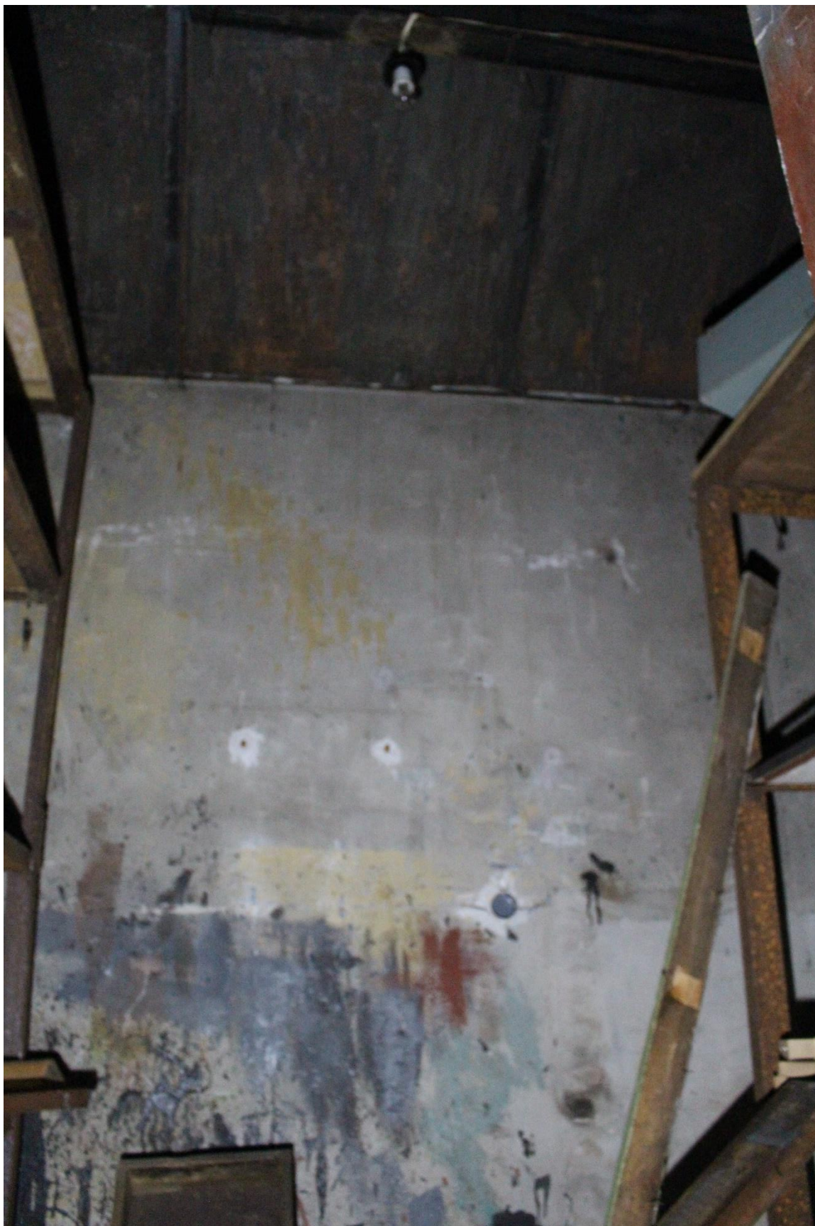
Фото 20. Здание по адресу: Санкт-Петербург, 17-я линия В.О., дом 54, корпус 5, литера Б объекта культурного наследия регионального значения «Блок цехов (с двумя трубами) и котельная с дымовой трубой». Внутренние помещения 1-го этажа.
