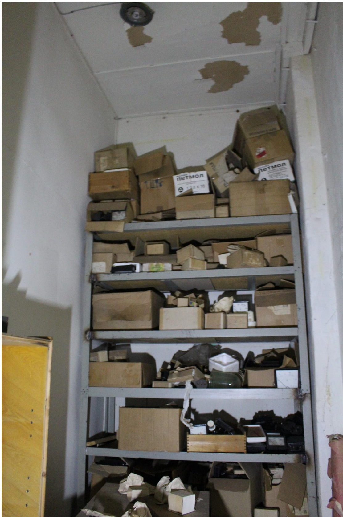
Фото 22. Здание по адресу: Санкт-Петербург, 17-я линия В.О., дом 54, корпус 5, литера Б объекта культурного наследия регионального значения «Блок цехов (с двумя трубами) и котельная с дымовой трубой». Внутренние помещения 1-го этажа.
