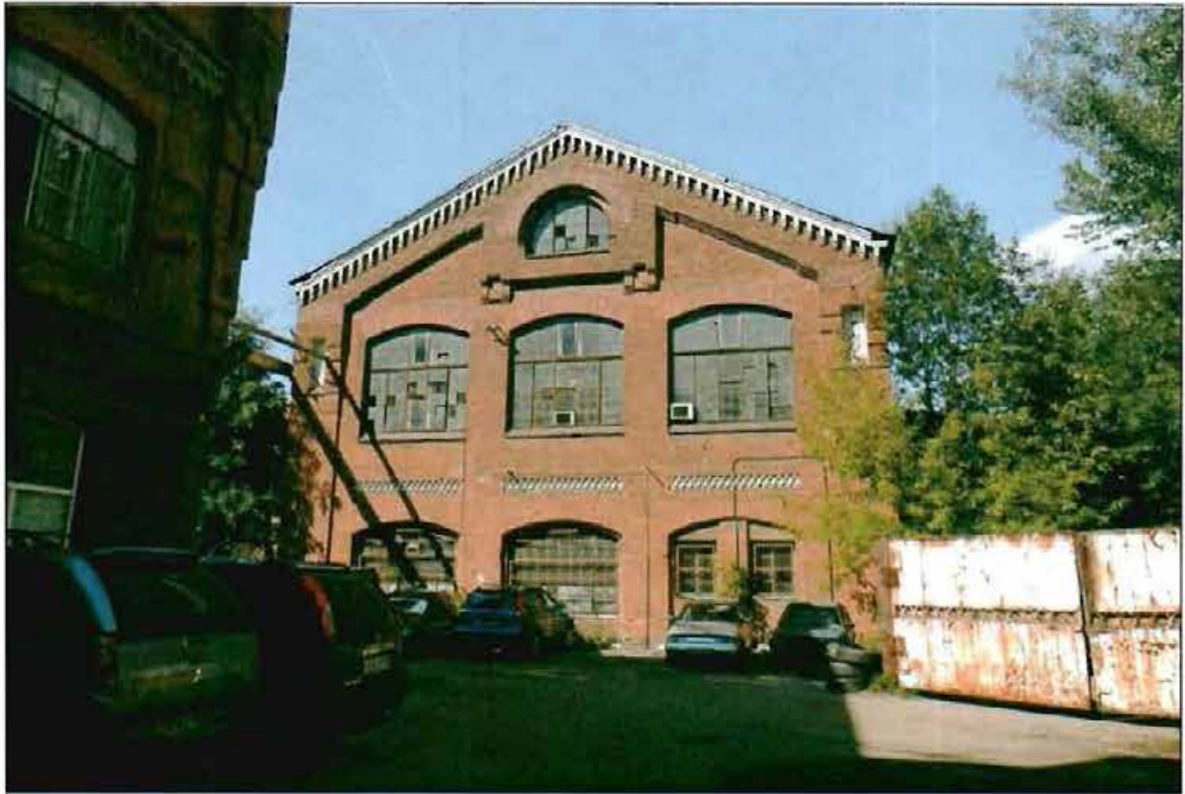
8. Общий вид юго-восточного фасада.
