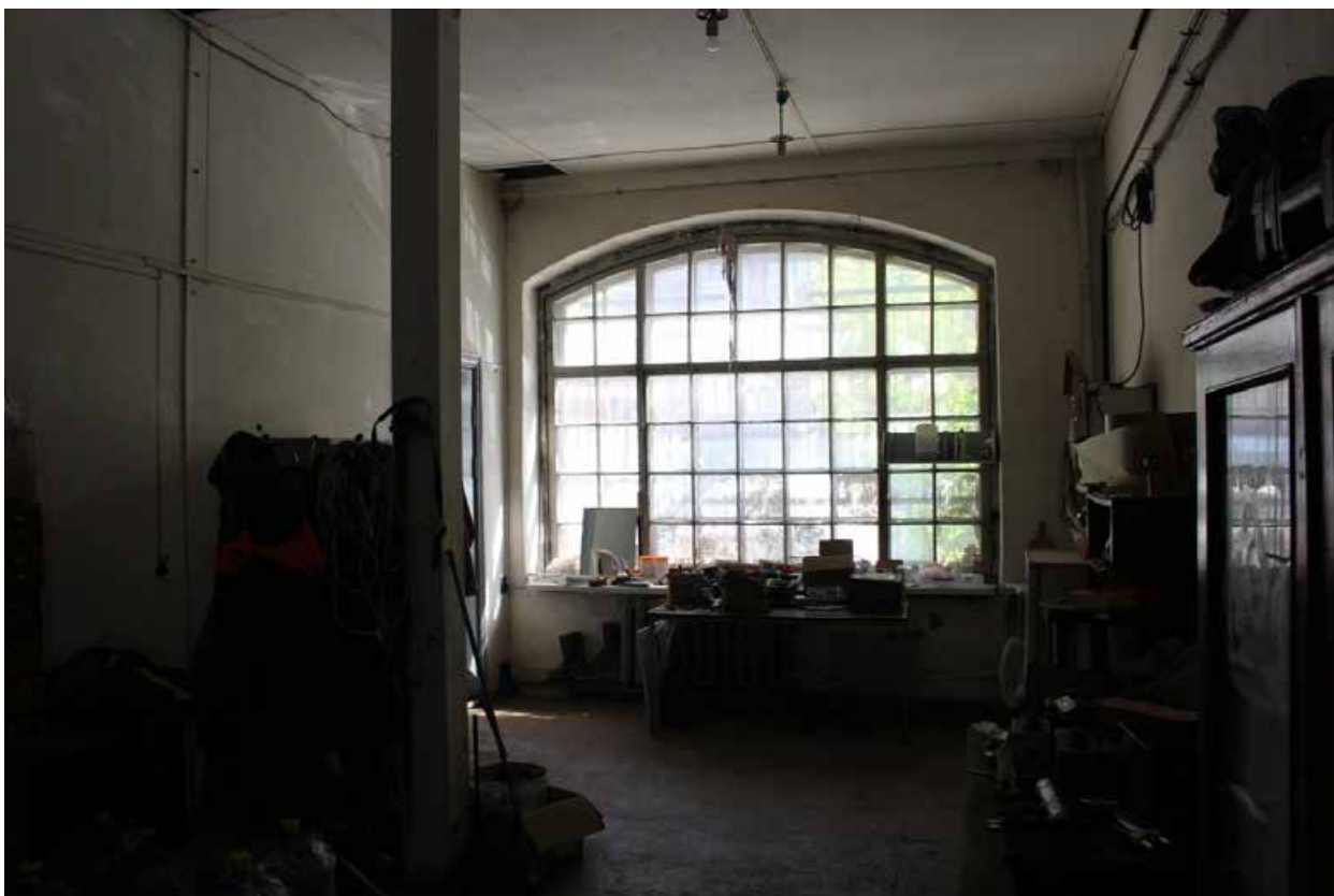
Фото 25. Здание по адресу: Санкт-Петербург, 17-я линия В.О., дом 54, корпус 5, литера Б объекта культурного наследия регионального значения «Блок цехов (с двумя трубами) и котельная с дымовой трубой». Внутренние помещения 1-го этажа.
