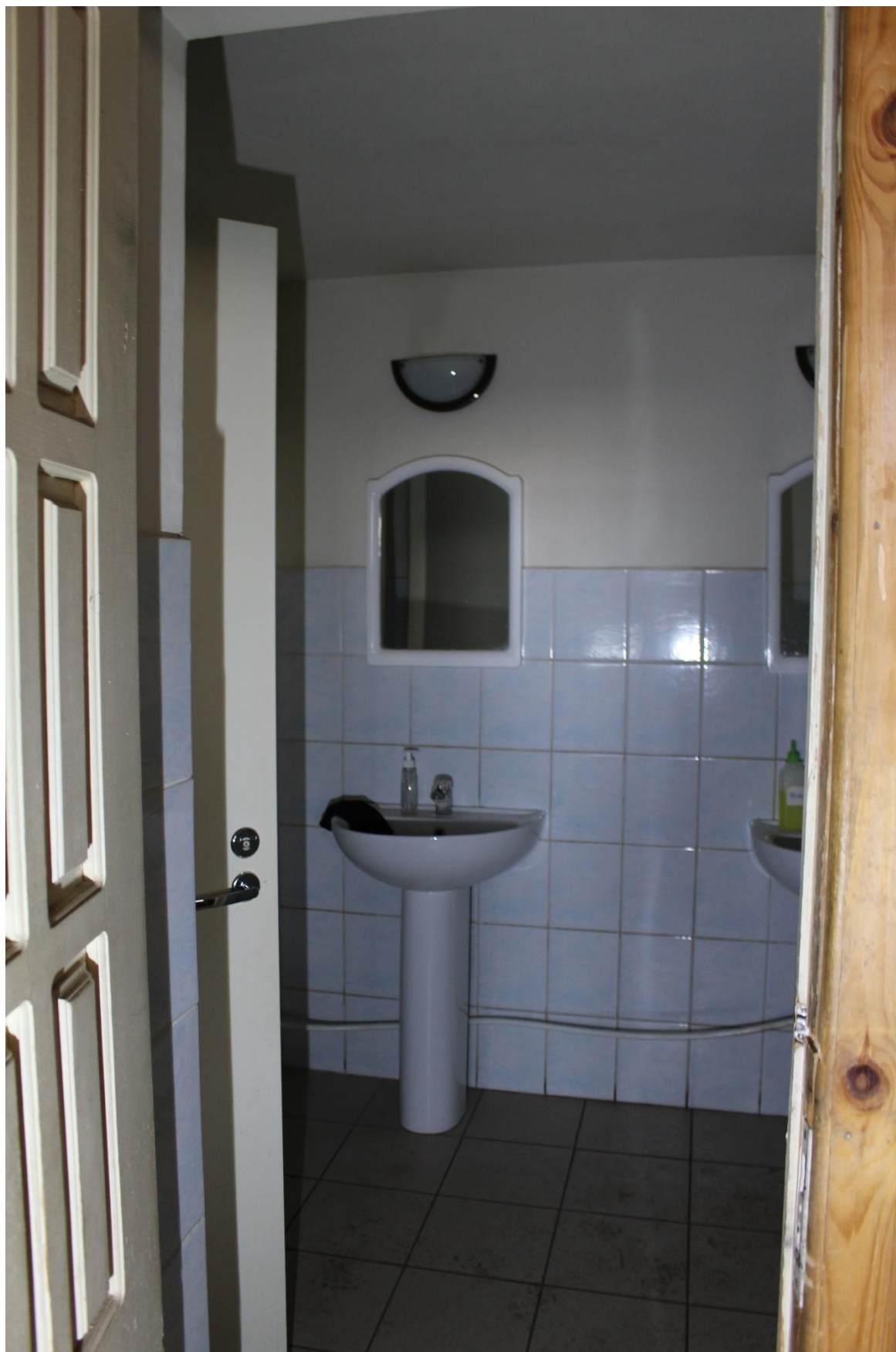
Фото 54. Здание по адресу: Санкт-Петербург, 17-я линия В.О., дом 54, корпус 5, литера Б объекта культурного наследия регионального значения «Блок цехов (с двумя трубами) и котельная с дымовой трубой». Внутренние помещения 2-го этажа.
