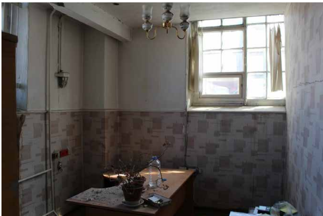
Фото 61. Здание по адресу: Санкт-Петербург, 17-я линия В.О., дом 54, корпус 5, литера Б объекта культурного наследия регионального значения «Блок цехов (с двумя трубами) и котельная с дымовой трубой». Внутренние помещения 2-го этажа.
