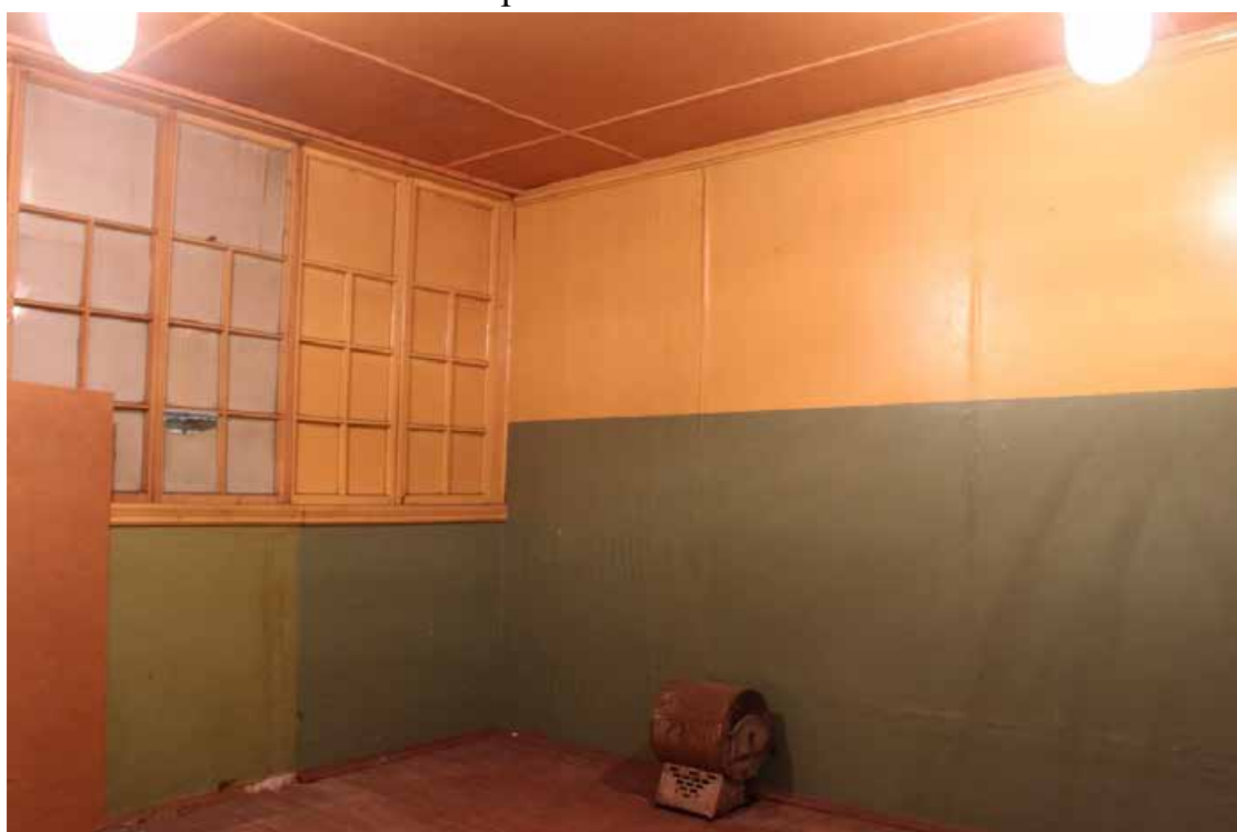
Фото 87. Здание по адресу: Санкт-Петербург, 17-я линия В.О., дом 54, корпус 5, литера Б объекта культурного наследия регионального значения «Блок цехов (с двумя трубами) и котельная с дымовой трубой». Внутренние помещения антресольного этажа.
