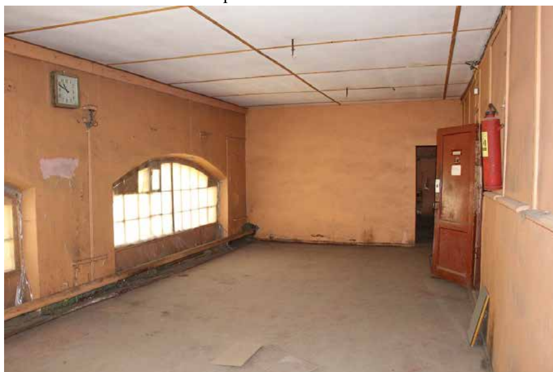
Фото 81. Здание по адресу: Санкт-Петербург, 17-я линия В.О., дом 54, корпус 5, литера Б объекта культурного наследия регионального значения «Блок цехов (с двумя трубами) и котельная с дымовой трубой». Внутренние помещения антресольного этажа.
