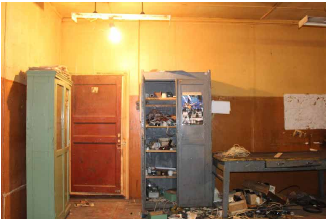
Фото 88. Здание по адресу: Санкт-Петербург, 17-я линия В.О., дом 54, корпус 5, литера Б объекта культурного наследия регионального значения «Блок цехов (с двумя трубами) и котельная с дымовой трубой». Внутренние помещения антресольного этажа.
