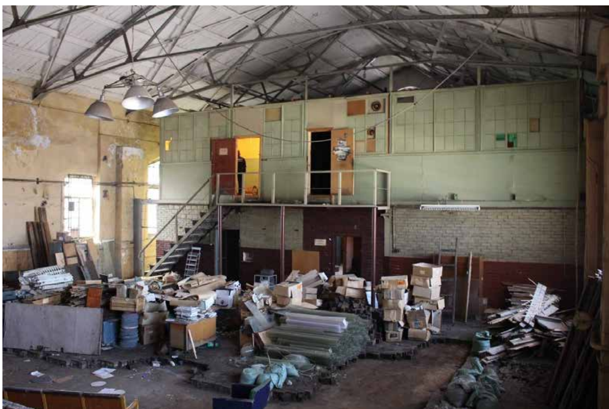
Фото 52. Здание по адресу: Санкт-Петербург, 17-я линия В.О., дом 54, корпус 5, литера Б объекта культурного наследия регионального значения «Блок цехов (с двумя трубами) и котельная с дымовой трубой». Внутренние помещения 2-го этажа.
