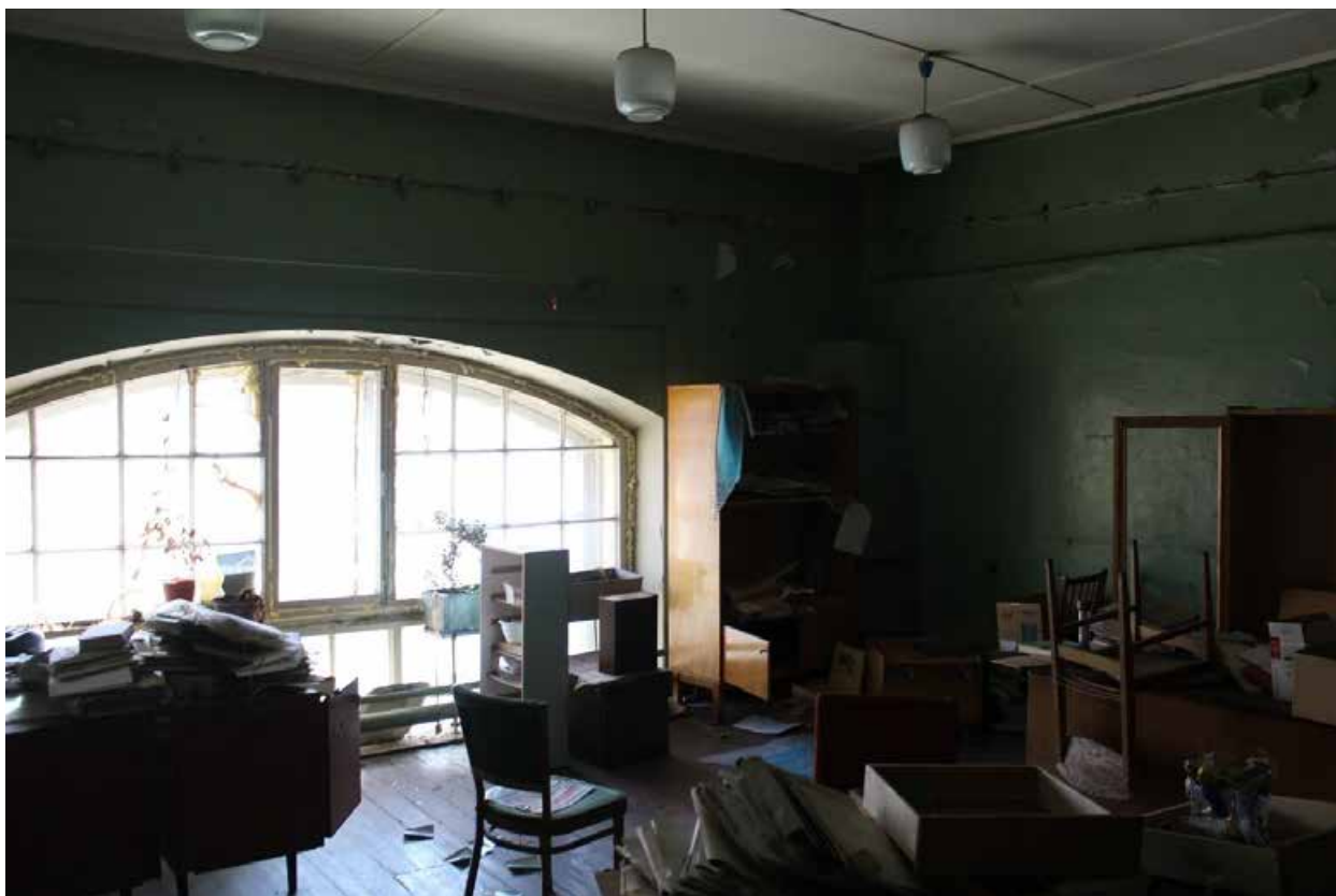
Фото 66. Здание по адресу: Санкт-Петербург, 17-я линия В.О., дом 54, корпус 5, литера Б объекта культурного наследия регионального значения «Блок цехов (с двумя трубами) и котельная с дымовой трубой». Внутренние помещения антресольного этажа.
