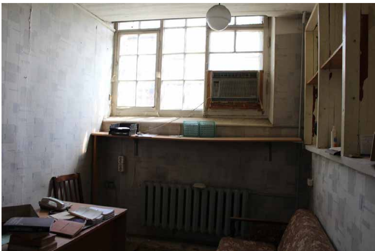
Фото 62. Здание по адресу: Санкт-Петербург, 17-я линия В.О., дом 54, корпус 5, литера Б объекта культурного наследия регионального значения «Блок цехов (с двумя трубами) и котельная с дымовой трубой». Внутренние помещения 2-го этажа.
