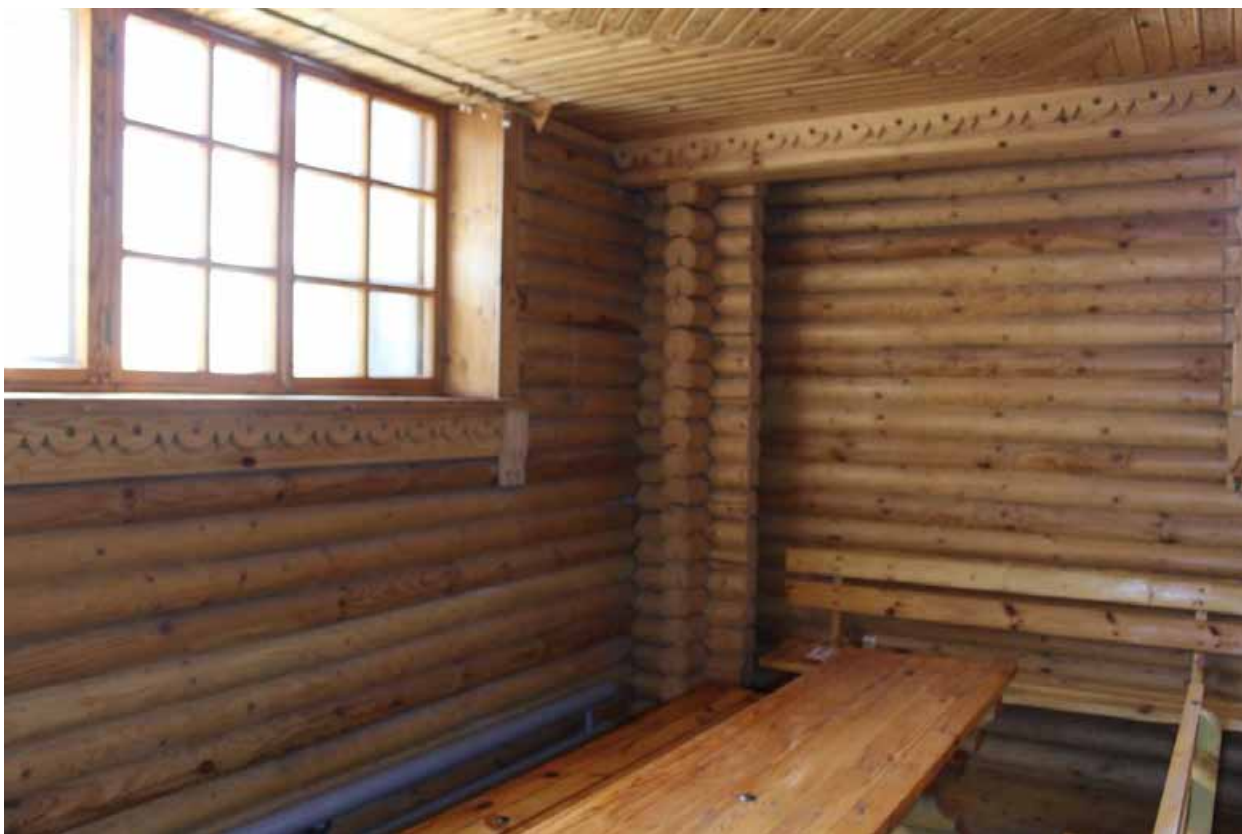
Фото 56. Здание по адресу: Санкт-Петербург, 17-я линия В.О., дом 54, корпус 5, литера Б объекта культурного наследия регионального значения «Блок цехов (с двумя трубами) и котельная с дымовой трубой». Внутренние помещения 2-го этажа.
