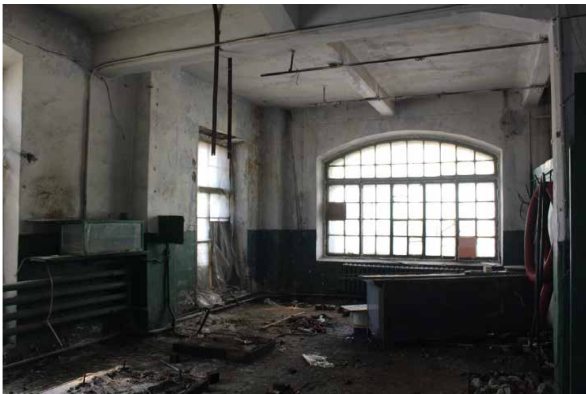
Фото 38. Здание по адресу: Санкт-Петербург, 17-я линия В.О., дом 54, корпус 5, литера Б объекта культурного наследия регионального значения «Блок цехов (с двумя трубами) и котельная с дымовой трубой». Внутренние помещения 1-го этажа.
