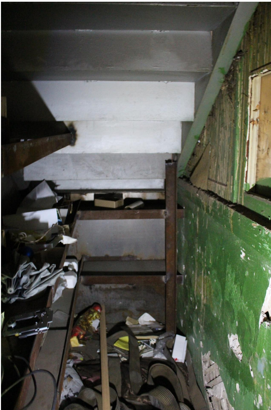
Фото 58. Здание по адресу: Санкт-Петербург, 17-я линия В.О., дом 54, корпус 5, литера Б объекта культурного наследия регионального значения «Блок цехов (с двумя трубами) и котельная с дымовой трубой». Внутренние помещения 2-го этажа.
