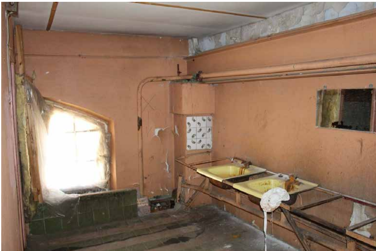
Фото 84. Здание по адресу: Санкт-Петербург, 17-я линия В.О., дом 54, корпус 5, литера Б объекта культурного наследия регионального значения «Блок цехов (с двумя трубами) и котельная с дымовой трубой». Внутренние помещения антресольного этажа.
