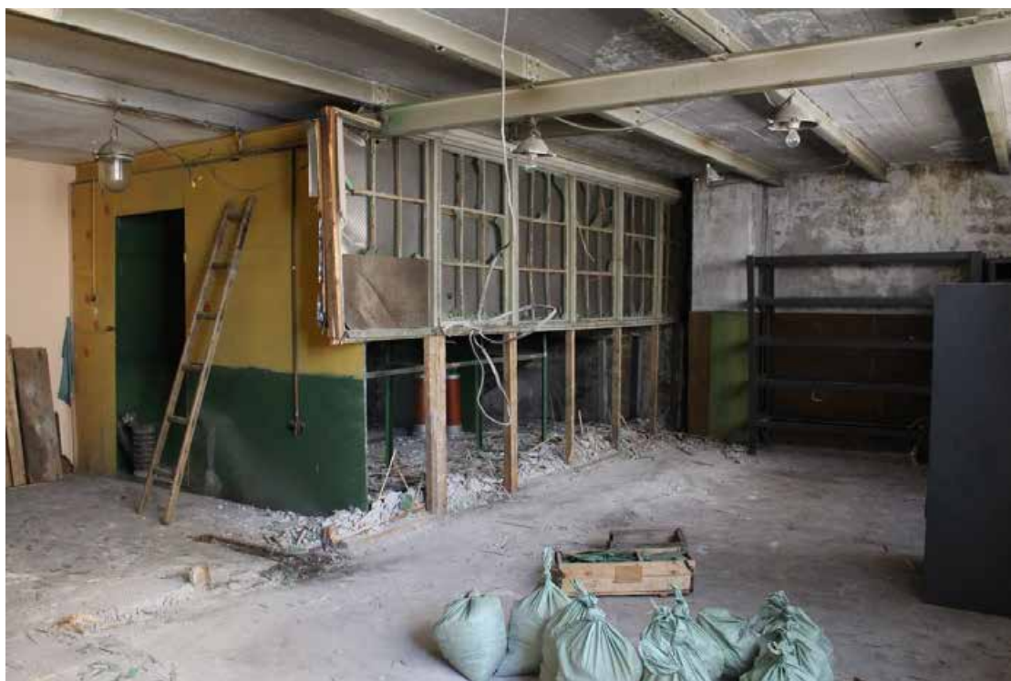
Фото 77. Здание по адресу: Санкт-Петербург, 17-я линия В.О., дом 54, корпус 5, литера Б объекта культурного наследия регионального значения «Блок цехов (с двумя трубами) и котельная с дымовой трубой». Внутренние помещения 2-го этажа.
