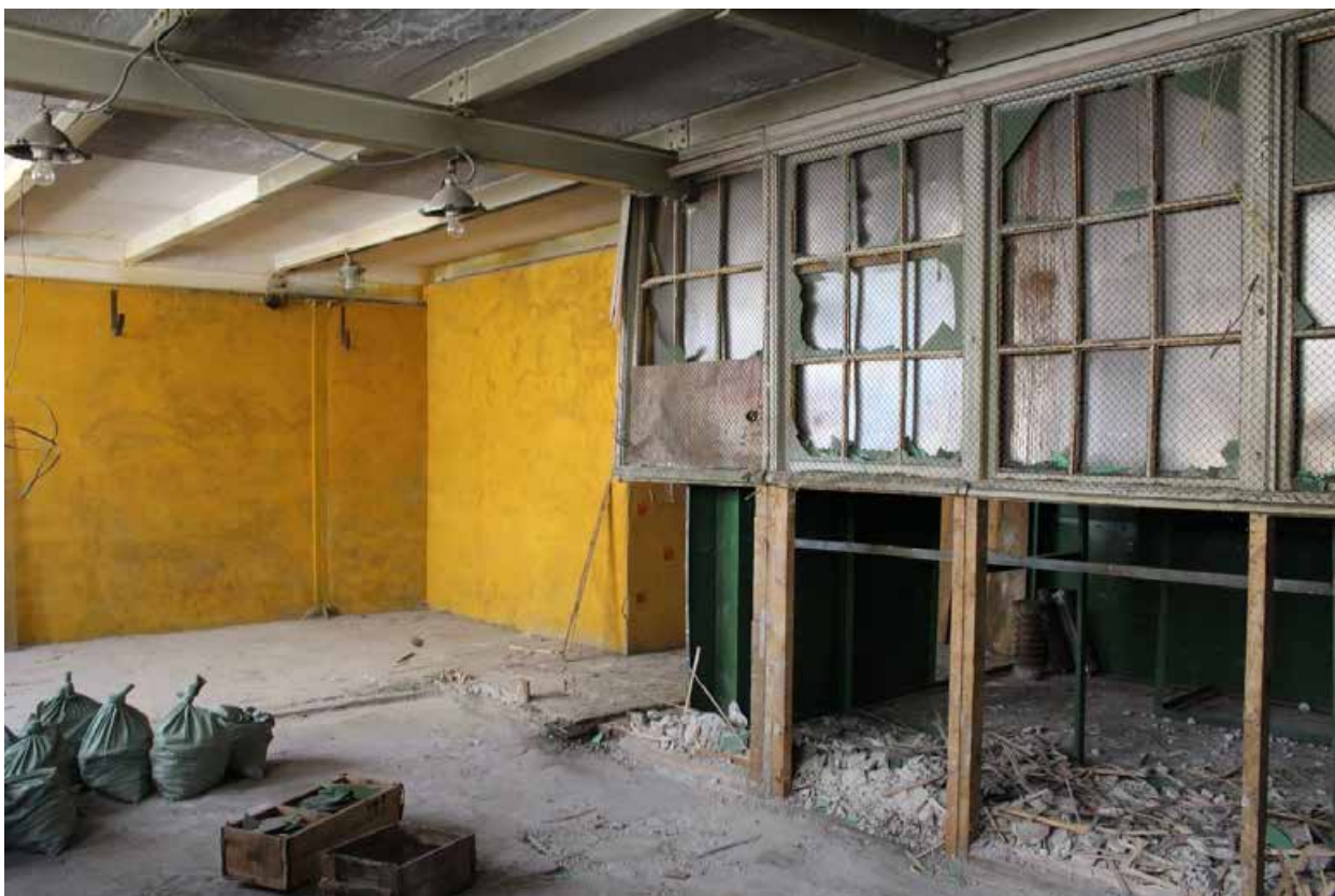
Фото 78. Здание по адресу: Санкт-Петербург, 17-я линия В.О., дом 54, корпус 5, литера Б объекта культурного наследия регионального значения «Блок цехов (с двумя трубами) и котельная с дымовой трубой». Внутренние помещения 2-го этажа.
