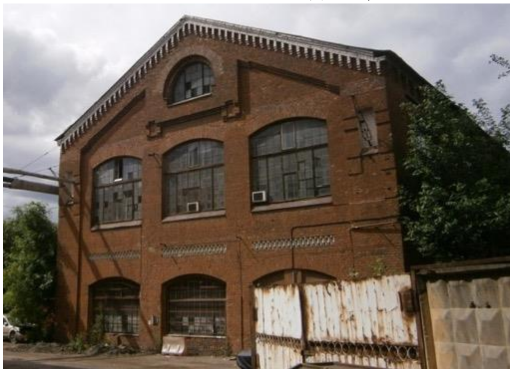
Илл. 176. Военно-подковный завод Посселя . Корпус (двор). 2014 г. (источник: https://www.citywalls.ru/photo196621.html ).
