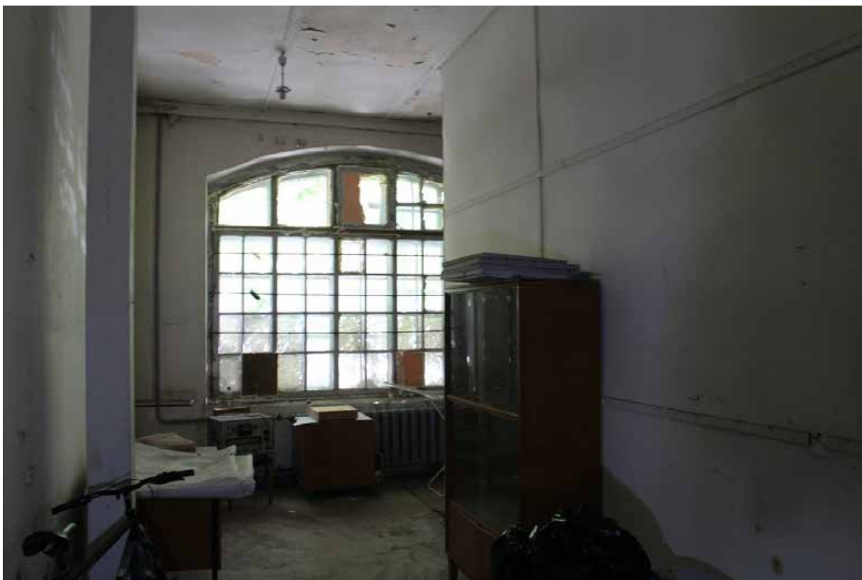
Фото 21. Здание по адресу: Санкт-Петербург, 17-я линия В.О., дом 54, корпус 5, литера Б объекта культурного наследия регионального значения «Блок цехов (с двумя трубами) и котельная с дымовой трубой». Внутренние помещения 1-го этажа.
