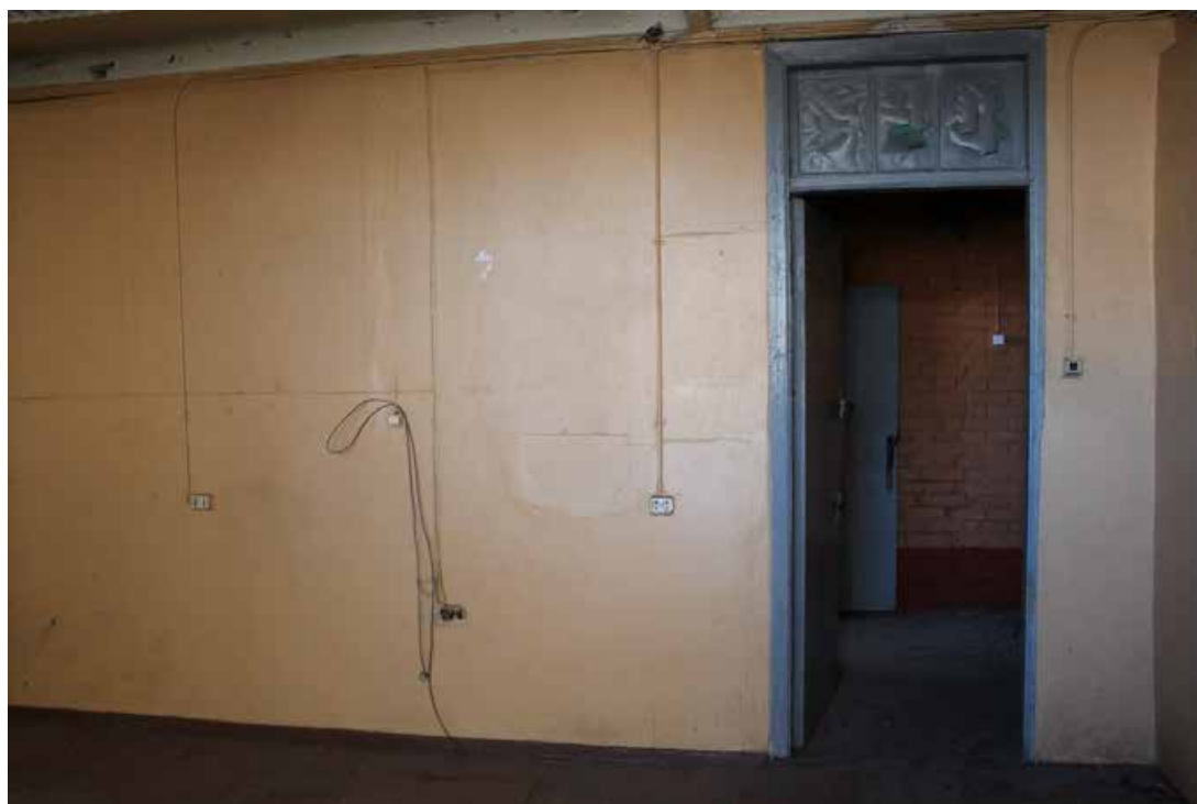
Фото 73. Здание по адресу: Санкт-Петербург, 17-я линия В.О., дом 54, корпус 5, литера Б объекта культурного наследия регионального значения «Блок цехов (с двумя трубами) и котельная с дымовой трубой». Внутренние помещения 2-го этажа.
