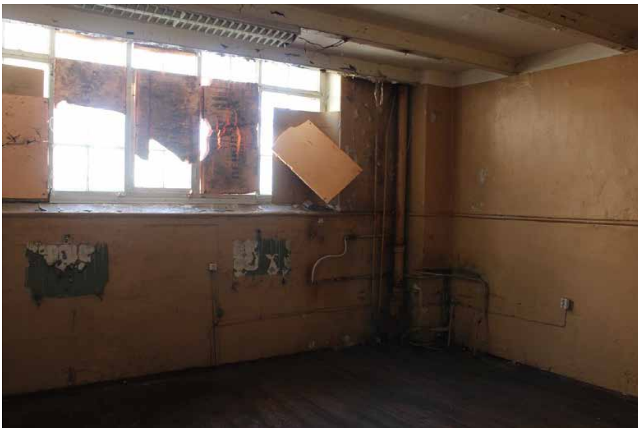
Фото 72. Здание по адресу: Санкт-Петербург, 17-я линия В.О., дом 54, корпус 5, литера Б объекта культурного наследия регионального значения «Блок цехов (с двумя трубами) и котельная с дымовой трубой». Внутренние помещения 2-го этажа.
