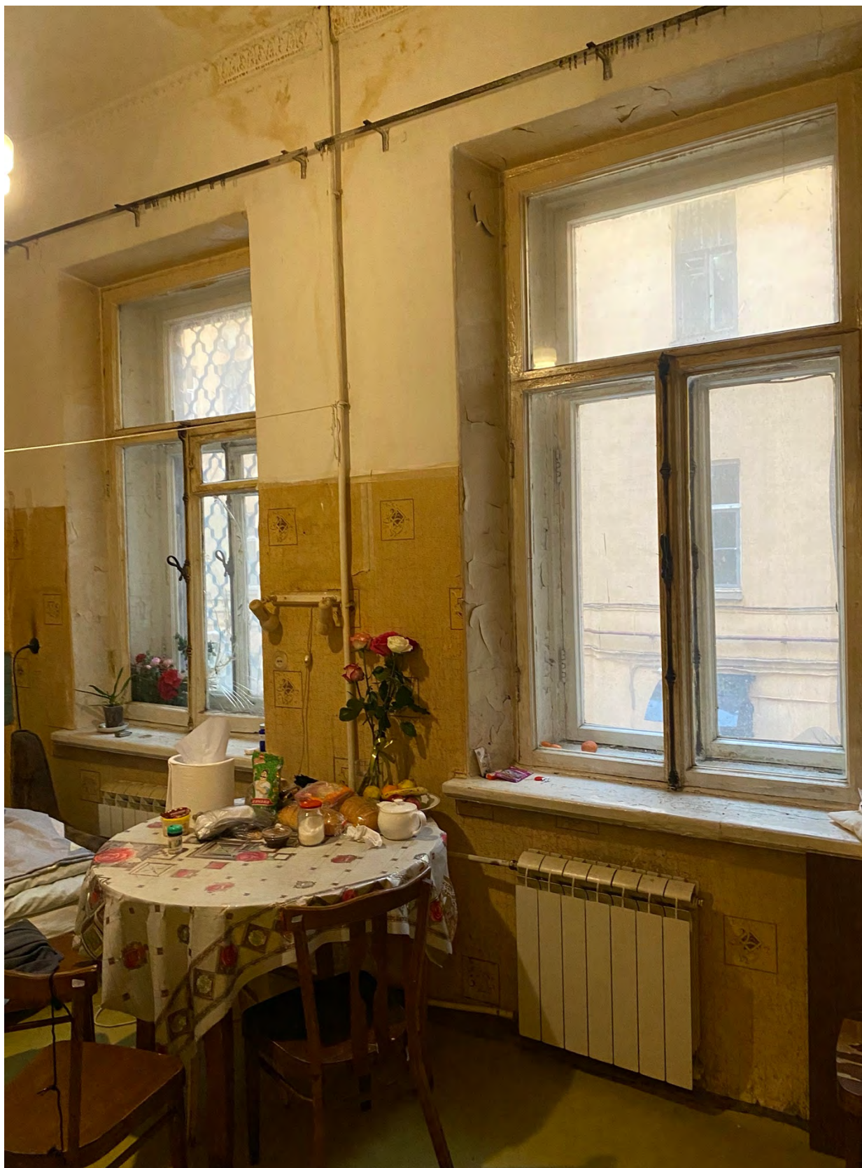
18. Фрагмент интерьера кухни (помещение 4/14.3);
