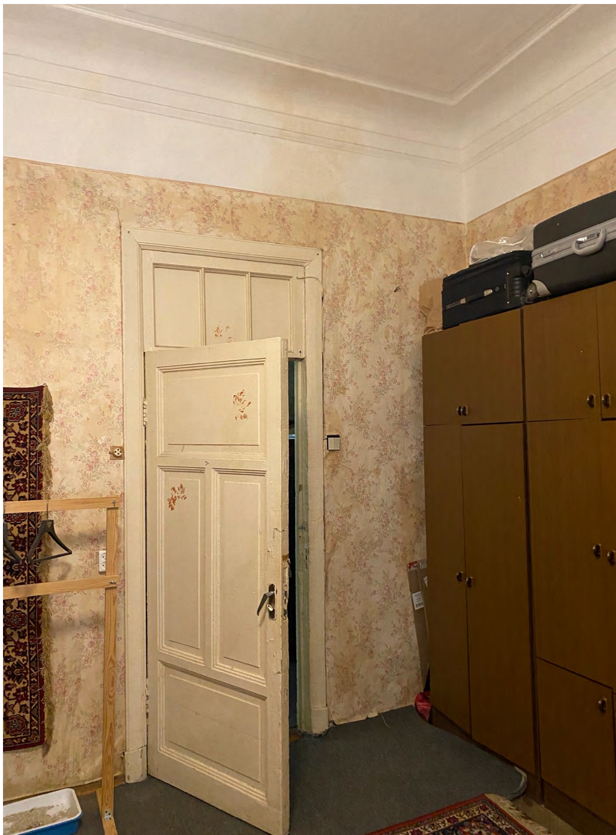
12.Фрагмент интерьера комнаты (помещение 9/23.8);
