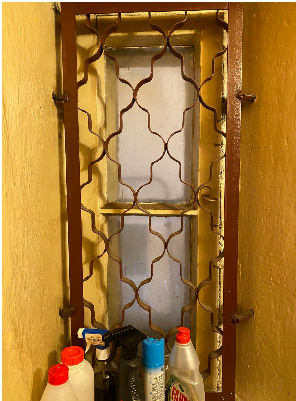
20. Фрагмент оконного заполнения.
