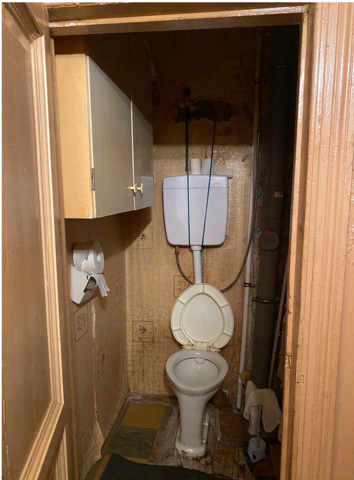
5. Фрагмент интерьера туалета (помещение 2/1.4);
