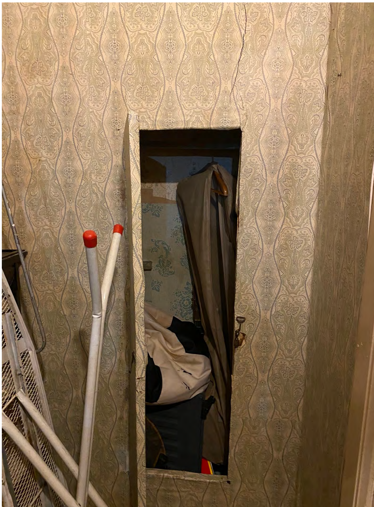
16. Вид на шкаф (помещение 7/0.8);
