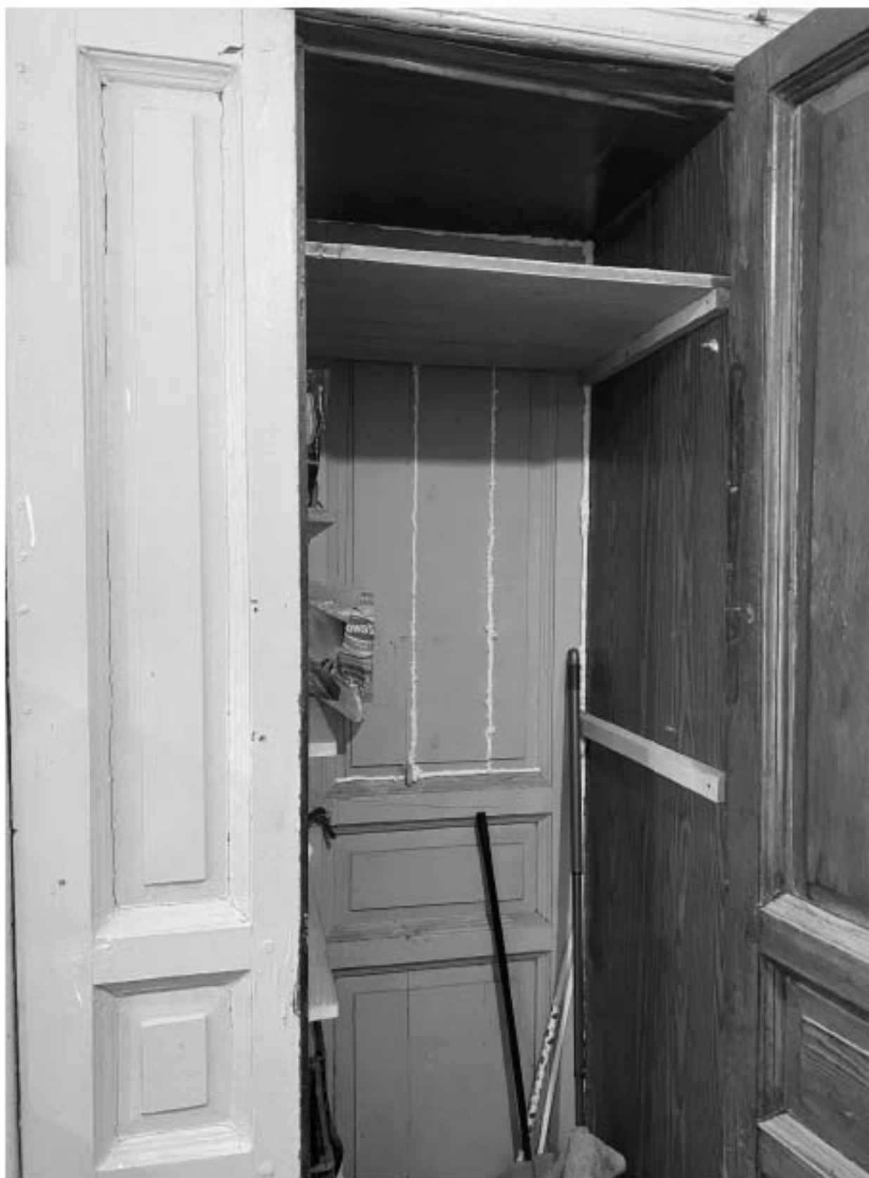
15. Вид на входную дверь в квартиру,
