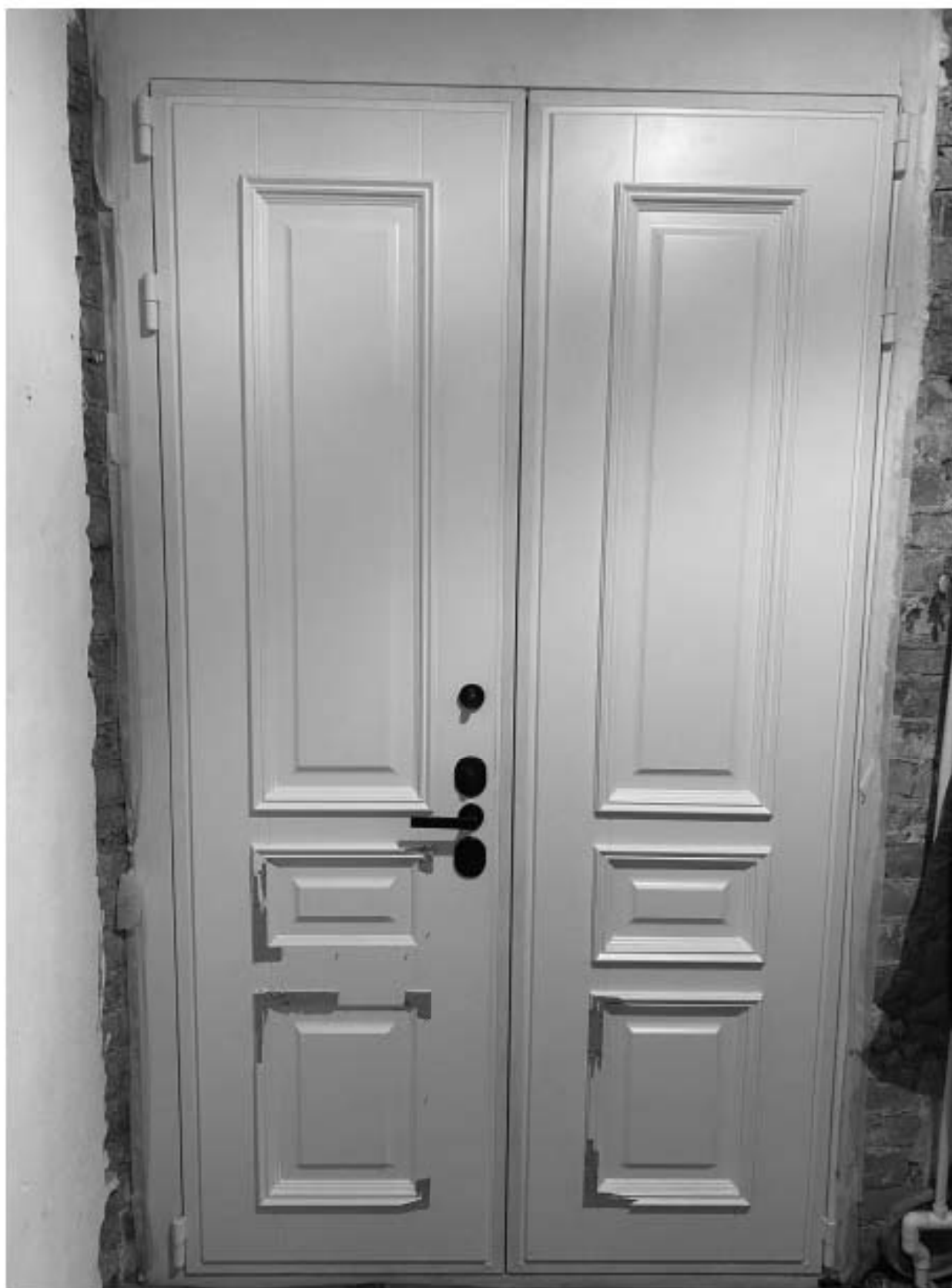
4. Вид на входную дверь в квартире №56;
