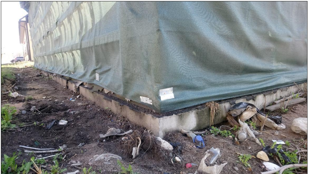
7. Здание по адресу: Малая Митрофаньевская улица, дом 10, корпус 4, литера Л. Фундамент. Вид с северо-западной стороны.
