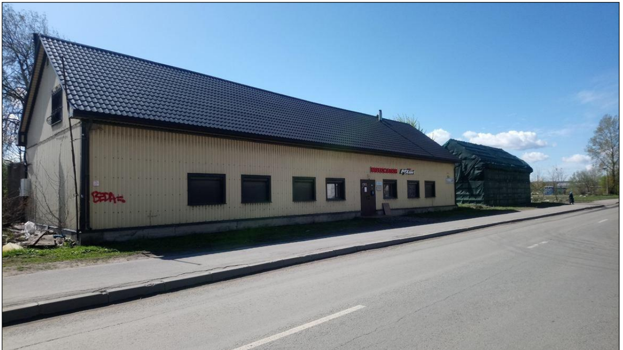
6. Вид с северо-востока на здания по адресу: Малая Митрофаньевская улица, дом 10, корпус 4, литера А (слева) и литера Л (справа).
