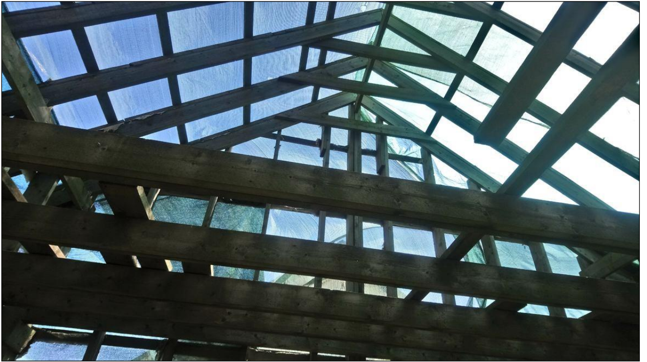
12. Здание по адресу: Малая Митрофаньевская улица, дом 10, корпус 4, литера Л. Вид с западной стороны на перекрытие.
