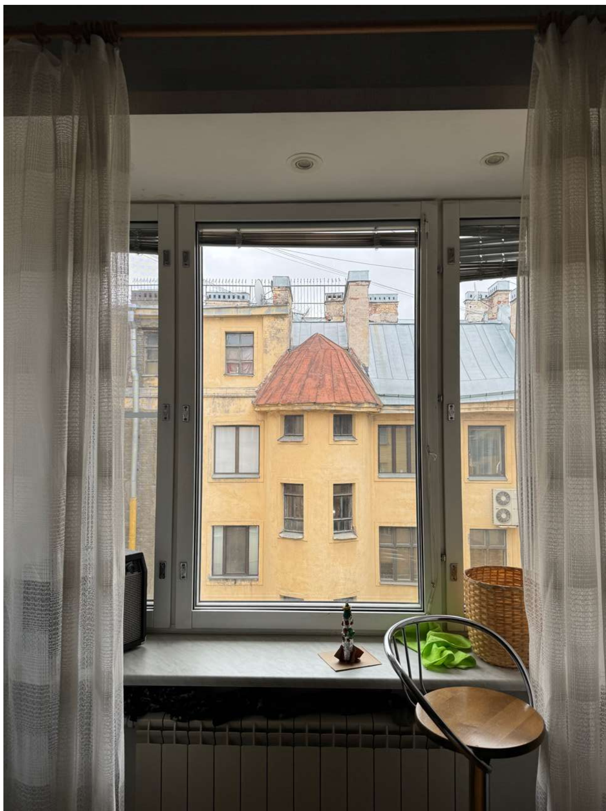
Фото 18. Вид на оконное заполнение квартиры № 50 объекта культурного наследия.
