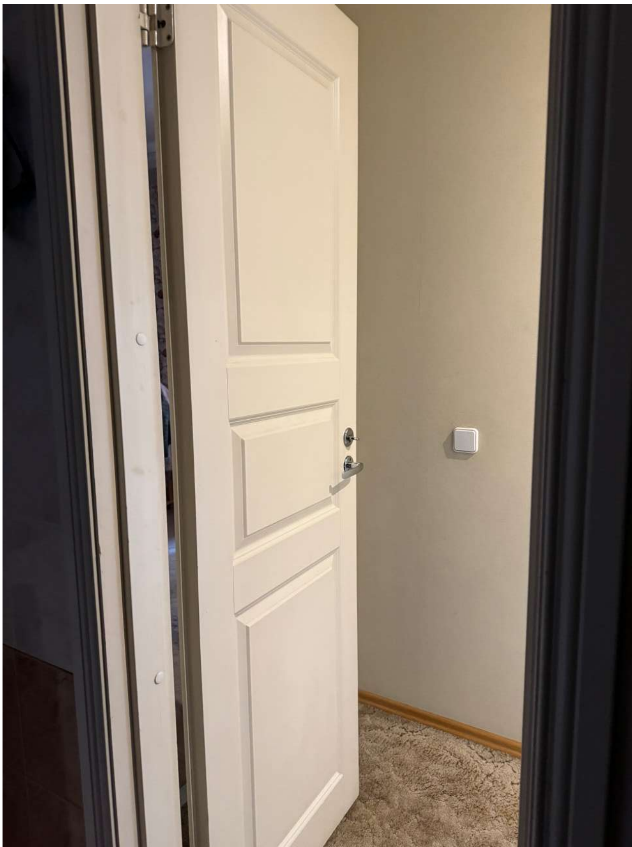
Фото 31. Вид на помещение квартиры № 50 объекта культурного наследия.
