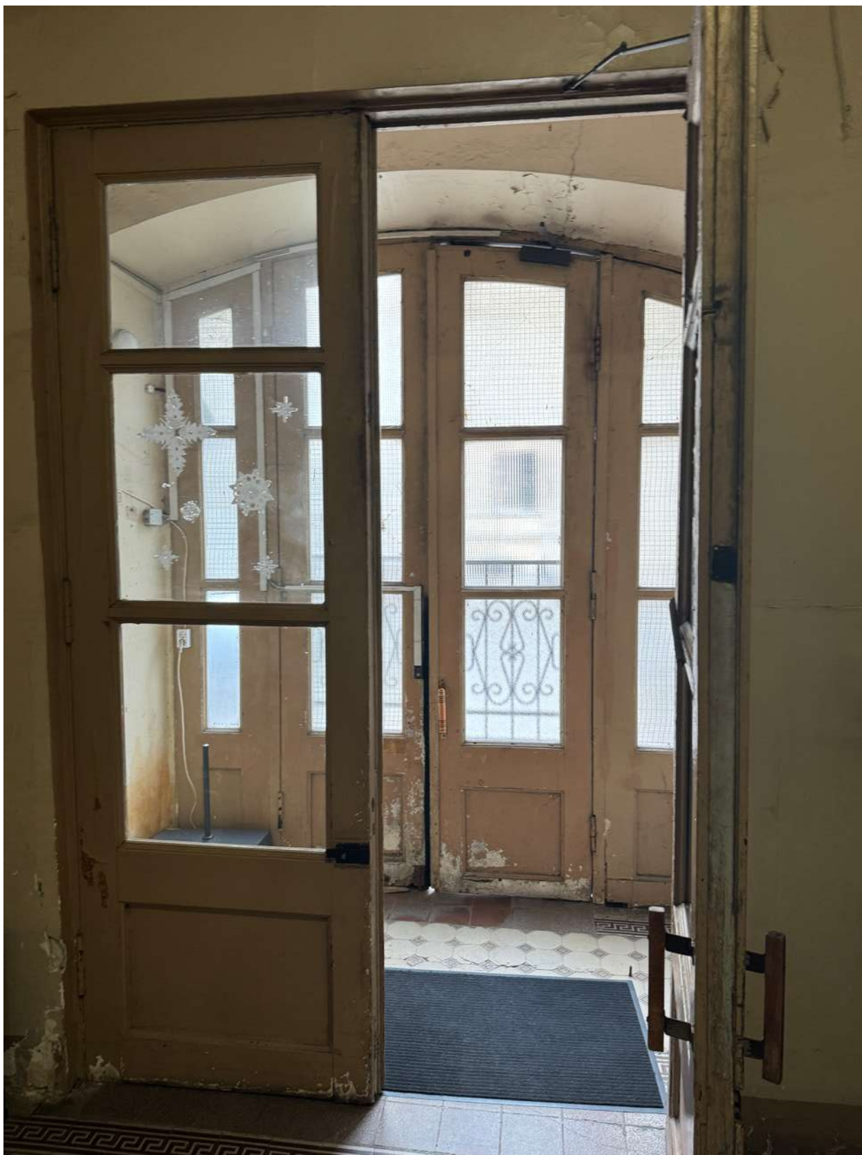
Фото 7. Тамбур парадной, ведущей в квартиру № 50, объекта культурного наследия.
