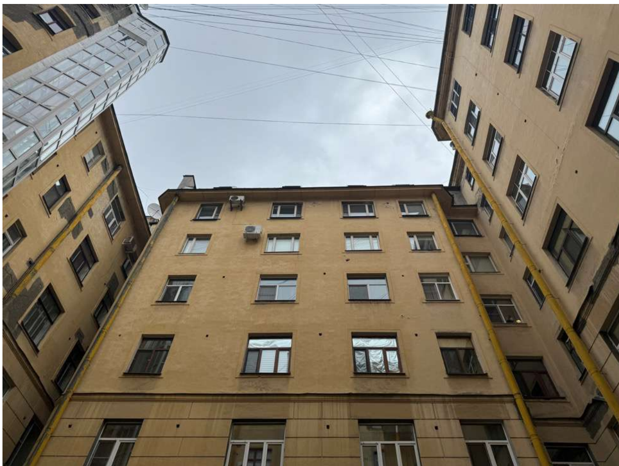
Фото 5. Фрагмент дворового фасада объекта культурного наследия с видом на окна квартиры № 50.
