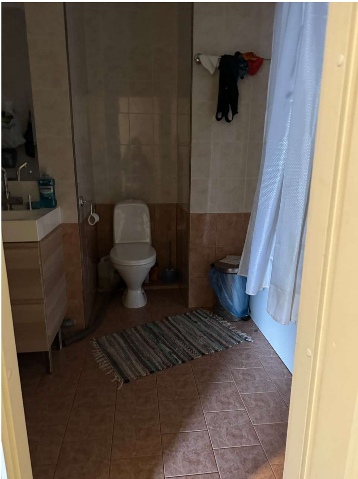
Фото 28. Вид на помещение квартиры № 50 объекта культурного наследия.
