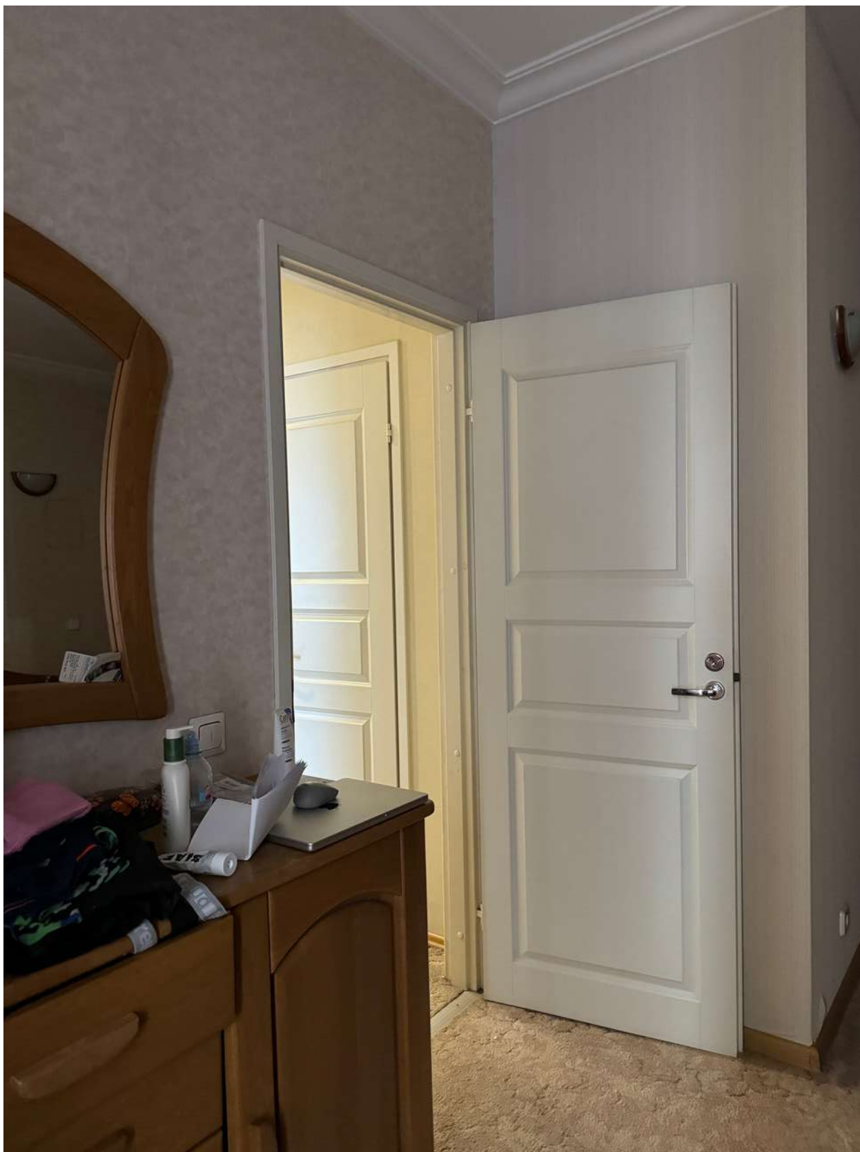
Фото 26. Вид на помещение квартиры № 50 объекта культурного наследия.
