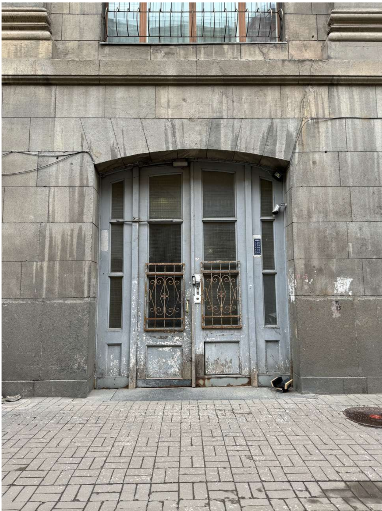
Фото 4. Вход, ведущий в парадную квартиры № 50, объекта культурного наследия по улице Графтио.
