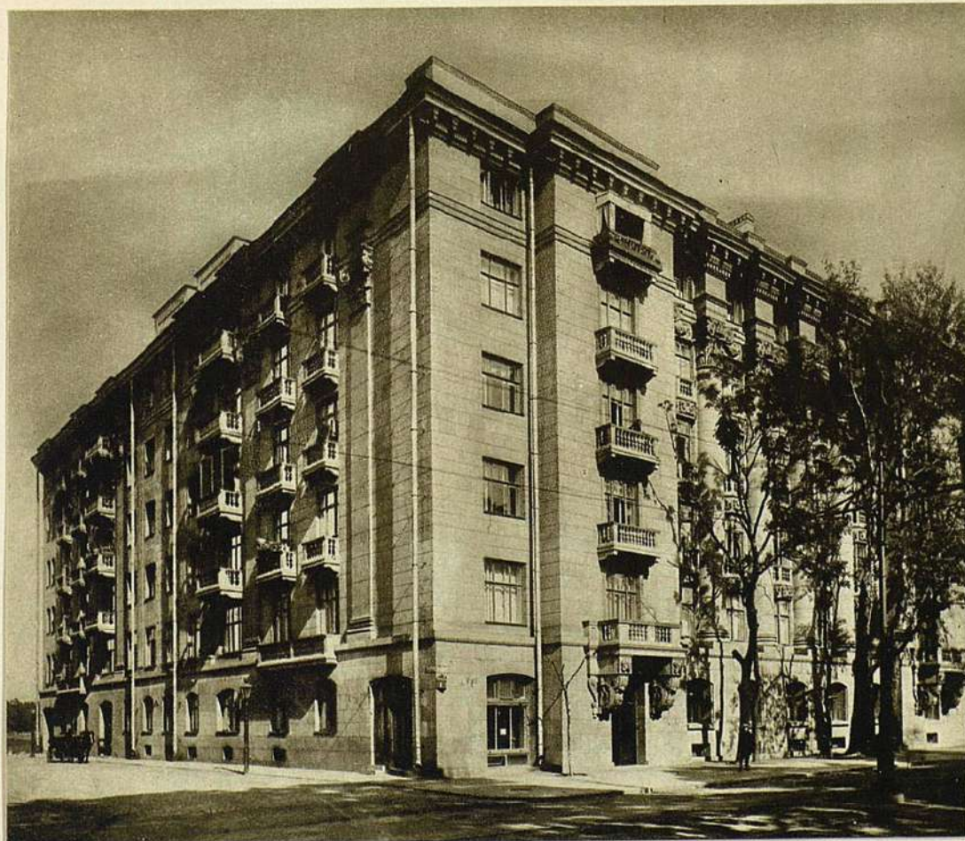
ДОХОДНЫЙ ДОМЪ НА КАМЕННООСТРОВСКОМЪ ПРОСПЕКТЪ. ОБЩІЙ ВИДЪ.
