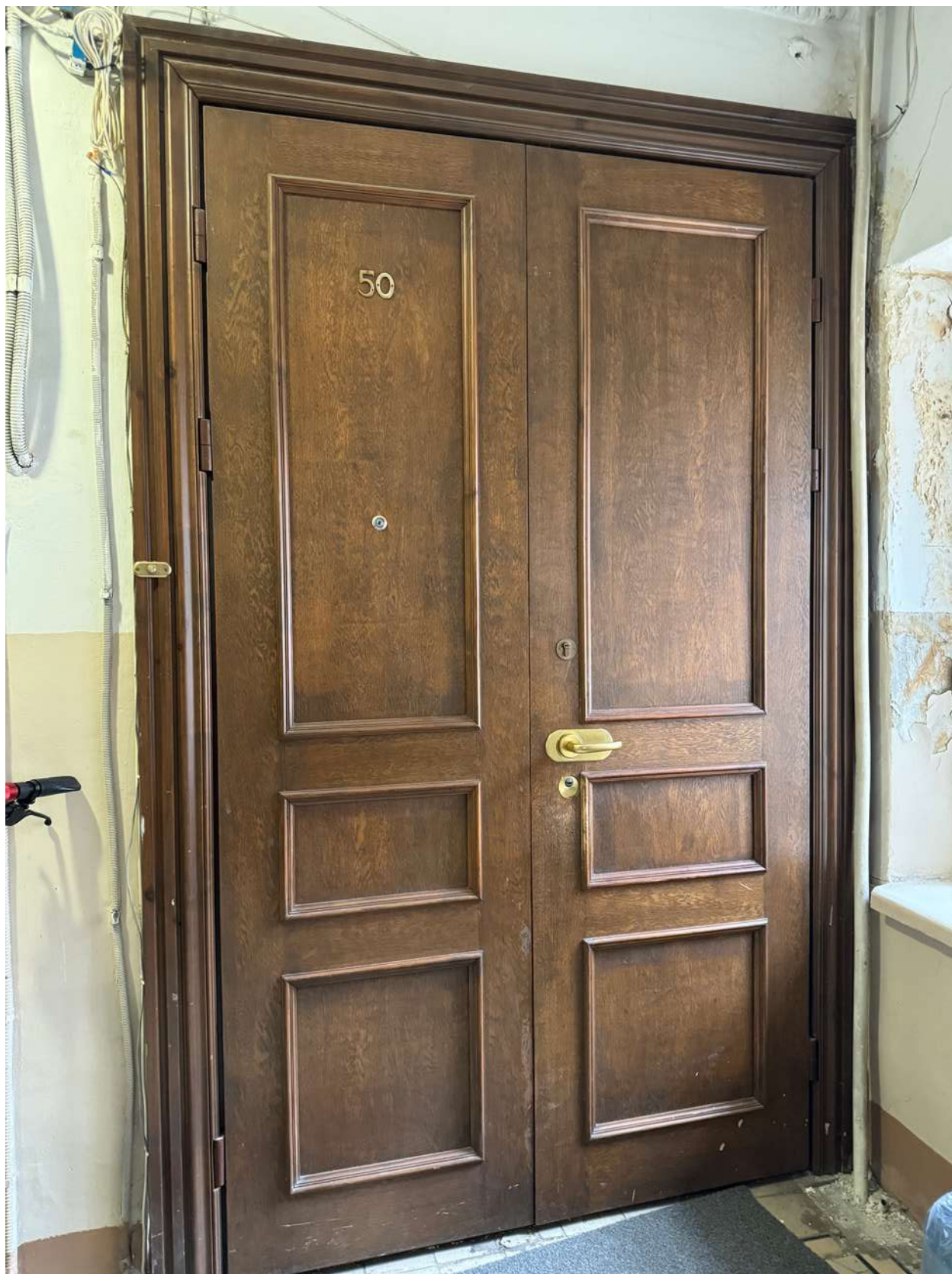
Фото 10. Вид на дверное заполнение, ведущее в квартиру № 50, объекта культурного наследия.
