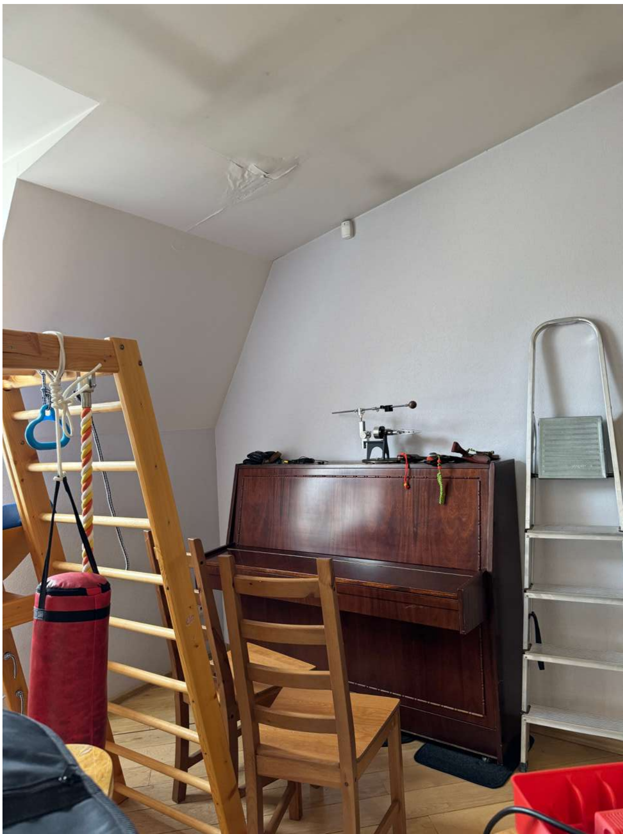
Фото 36. Вид на помещение квартиры № 50 объекта культурного наследия.
