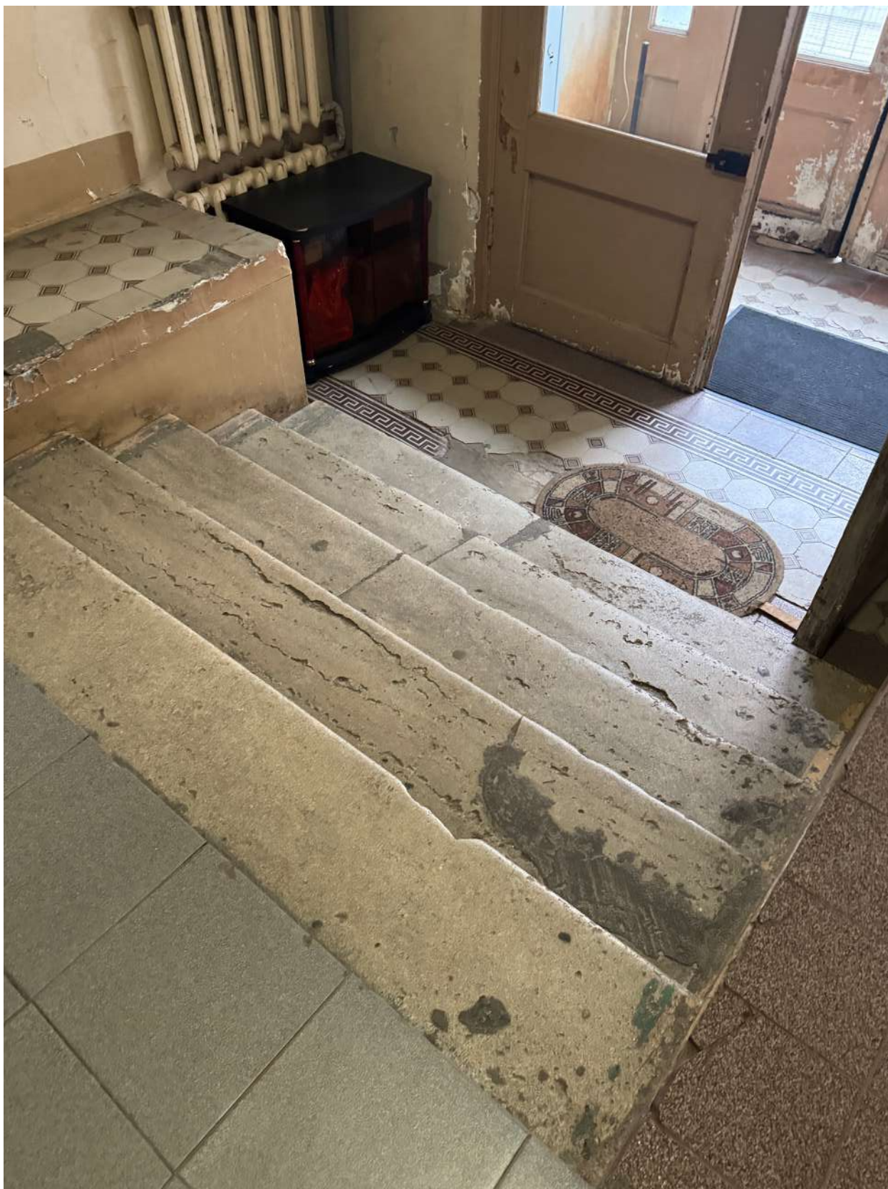
Фото 8. Лестница всхода парадной, ведущей в квартиру № 50, объекта культурного наследия.
