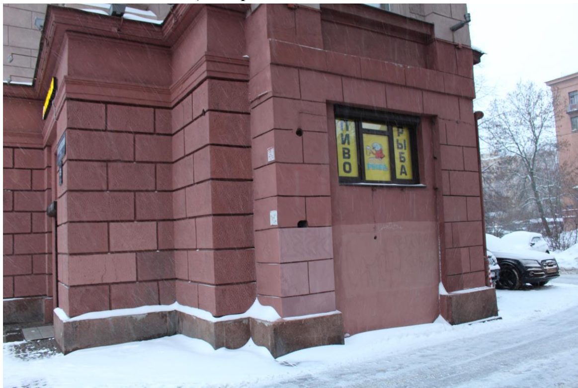
Фото 4. Вид на фрагмент северного фасада выявленного объекта культурного наследия «Здание 2» по адресу: Санкт-Петербург, Московский пр., 159, входящего в состав выявленного объекта культурного наследия «Жилые дома (4 здания)», в границах помещения 10-Н.
