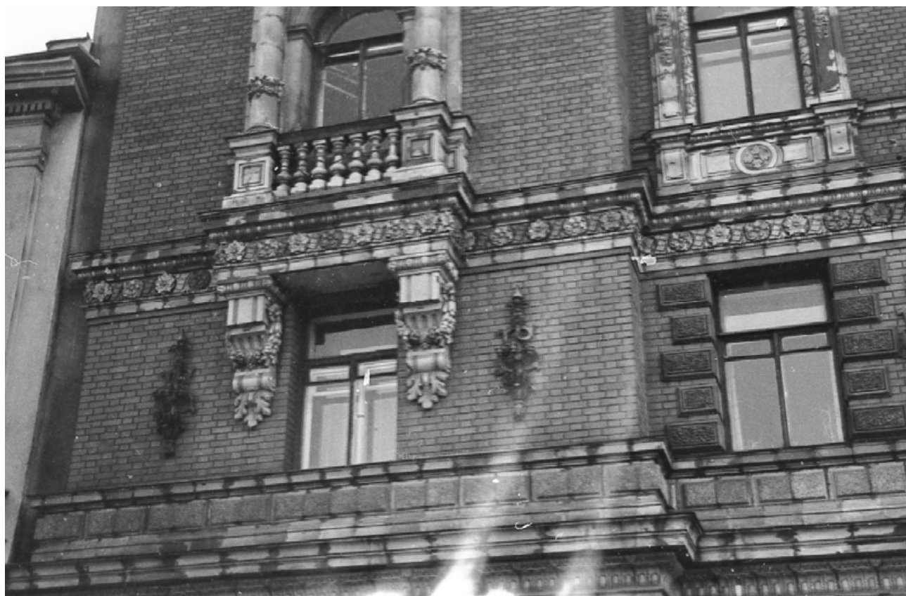
Илл.27. Фрагмент фасада дома по набережной реки Фонтанки, 64. Фотография 1975 г. Источник – сайт pastvu.com.
