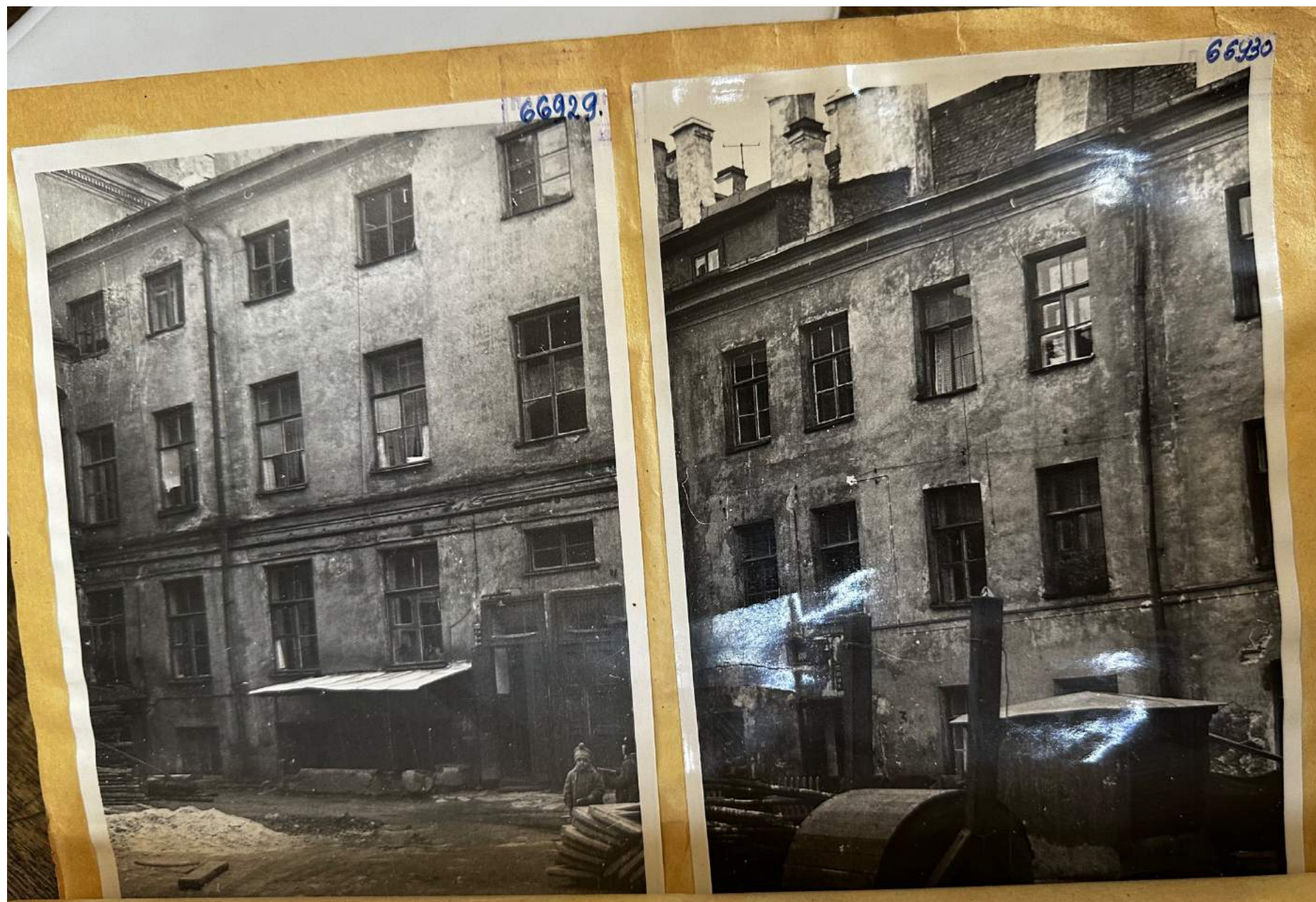
104. Фотографии дворовых фасадов. 1960 г. // Источник: Проект реставрации и реконструкции лицевого корпуса А1 и дворовых фл. А2 и А3 д.2/9 по ул. Союза Связи /б. Дом Мятлевых/ Проектный институт «Ленжилпроект». Архив КГИОП. П62. Пр.-4.
