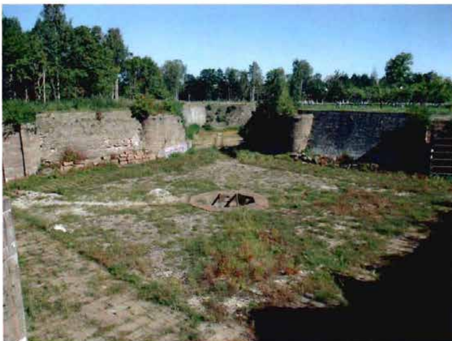
8. Разворотный бассейн. Вид с юга на север
