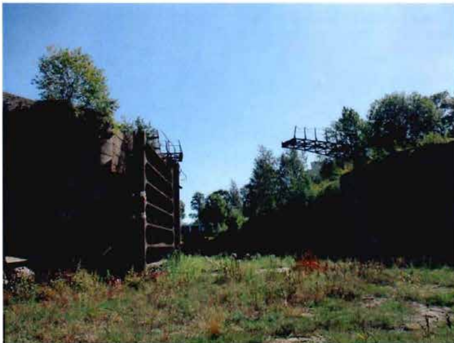
7. Восточный док. Двустворчатые ворота, разводной поворотный мост
