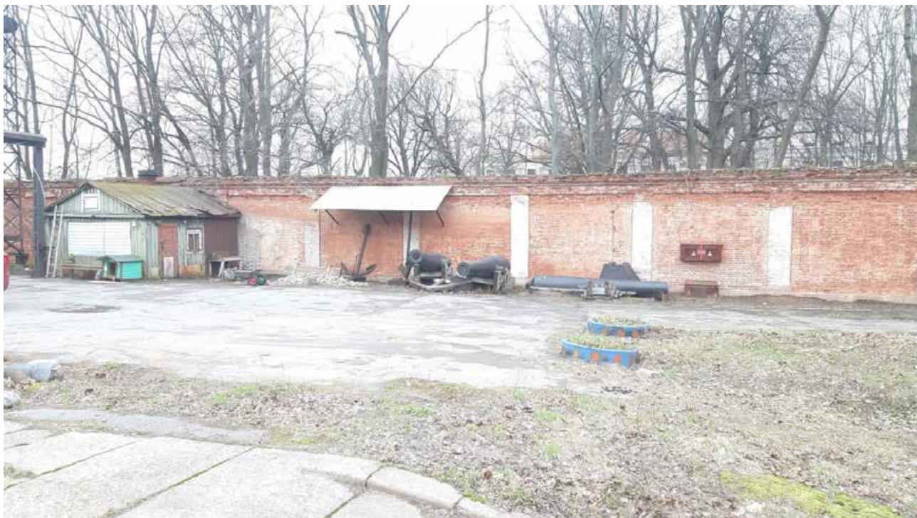
5. Док Петровский (южный). Входная зона со стороны площадки около Южной головы Петровского дока. Давыдова Н.А. 24.04.2024.
