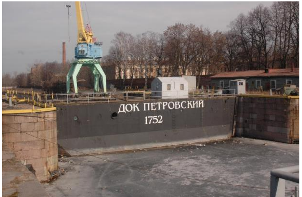
12. Канал им. Петра Великого с гидротехническими сооружениями. Док Петровский (южный). Фото Давыдова Н.А. 11.04.2018 г. (1).
