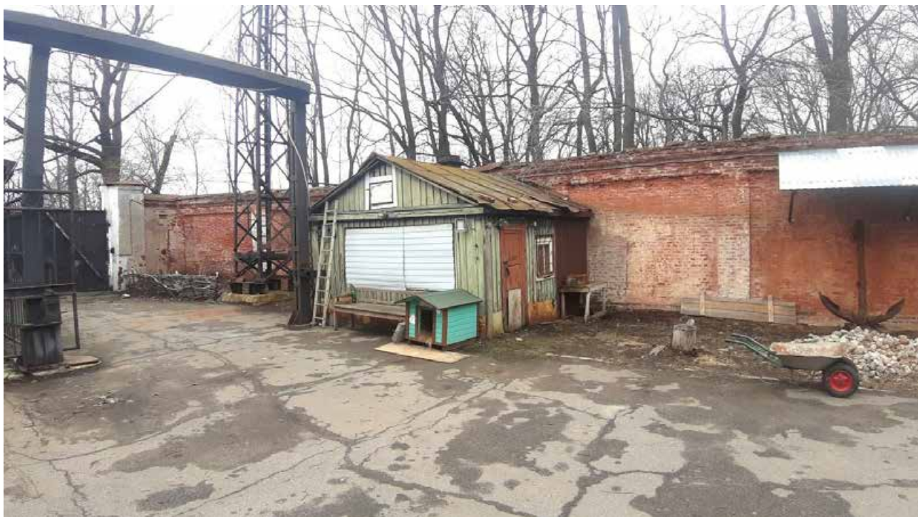
3. Док Петровский (южный). Входная зона. Вид с лицевого фасада. Давыдова Н.А. 24.04.2024.
