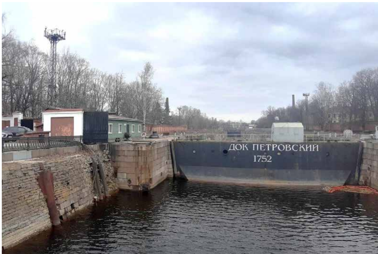
1. Затвор (батопорт) в южной части дока. Вид с южной стороны. Давыдова Н.А. 24.04.2024.
