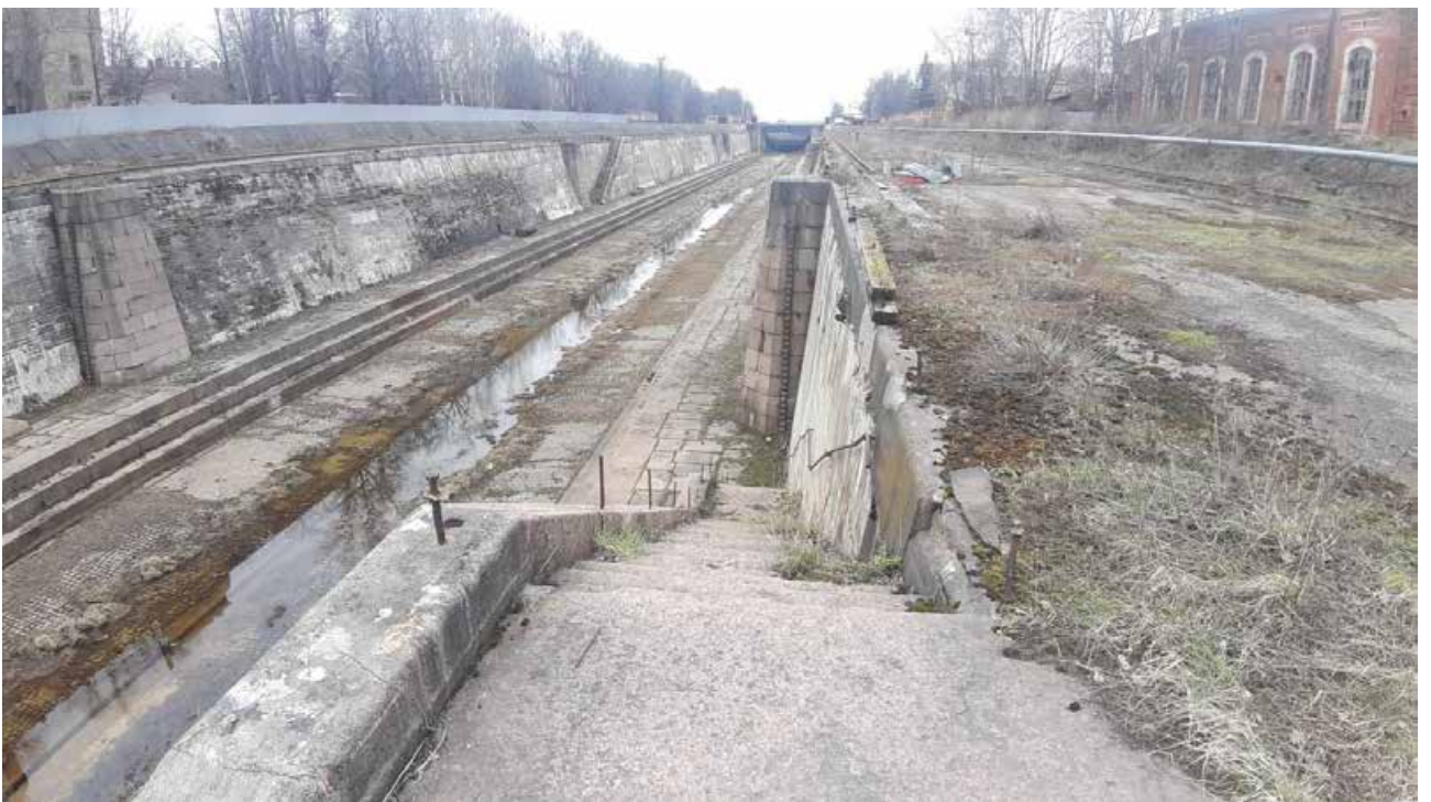
32. Док Петровский (южный). Лестничный спуск на западной стороне Петровского дока. Давыдова Н.А. 24.04.2024.
