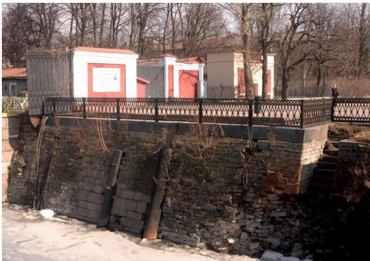
11. Канал им. Петра Великого с гидротехническими сооружениями. Док Петровский (южный). Фото Давыдова Н.А. 11.04.2018 г. (1).
