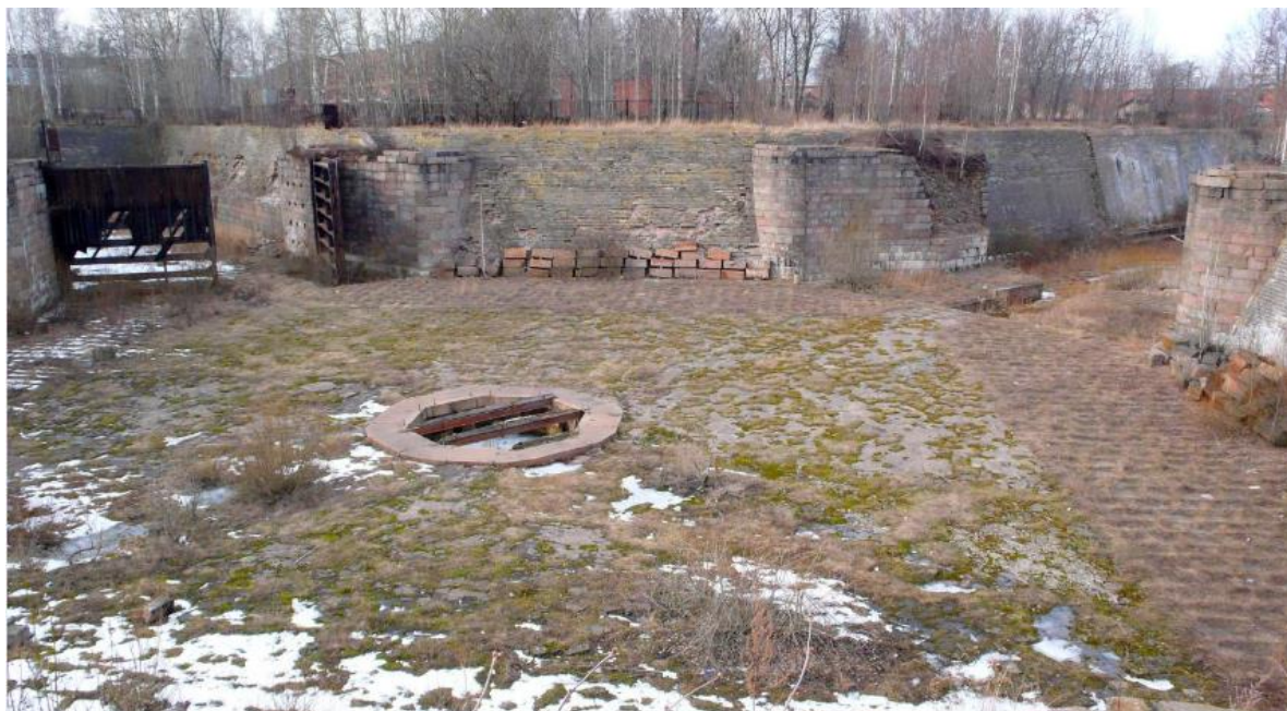
10. Канал им. Петра Великого с гидротехническими сооружениями. Доки в крест-канале. Фото Давыдова Н.А. 11.04.2018 г. Акт по результатам государственной историко-культурной экспертизы проектной документации на проведение работ по сохранению объекта культурного наследия федерального значения «Канал им. Петра Великого с гидротехническими сооружениями», Санкт-Петербург, г. Кронштадт, Адмиралтейство. 2018 г. (Архив КГИОП).
