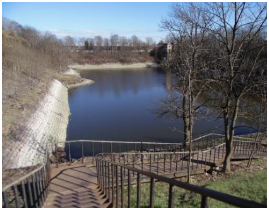
13. Канал им. Петра Великого с гидротехническими сооружениями. Бассейн с насосной станцией и отводным каналом. Фото Давыдова Н.А. 11.04.2018 г. (1).
