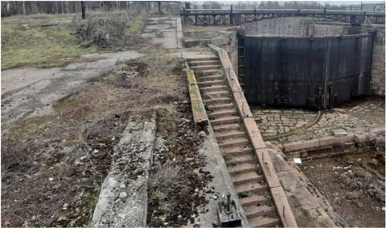
29. Док Петровский (южный). Лестничный спуск на западной стороне Петровского дока. Давыдова Н.А. 24.04.2024.
