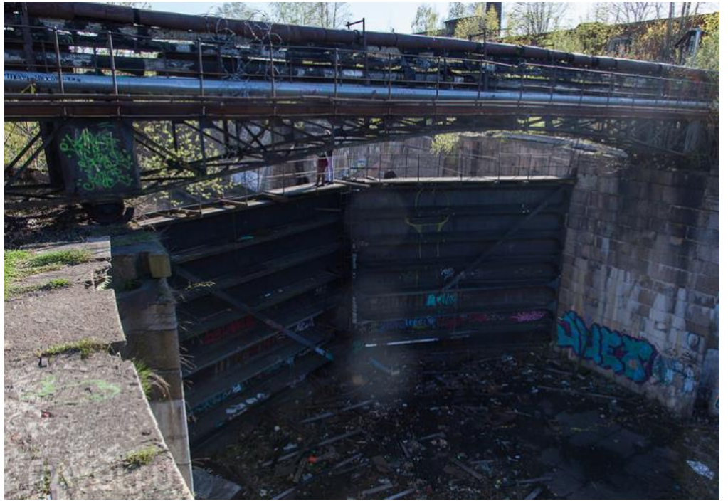
16. Канал им. Петра Великого с гидротехническими сооружениями. Док Петровский (южный). Фото Давыдова Н.А. 11.04.2018 г. (1).
