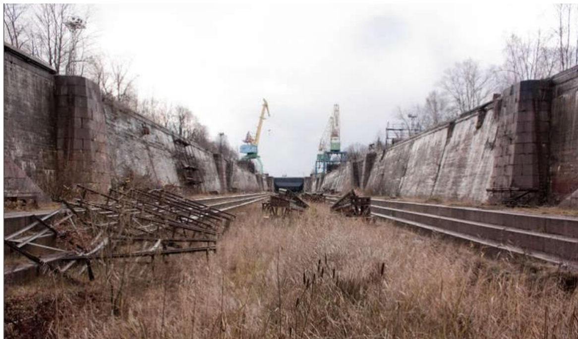
14. Канал им. Петра Великого с гидротехническими сооружениями. Бассейн с насосной станцией и отводным каналом. Док Петровский (южный). Фото Давыдова Н.А. 11.04.2018 г. (1).
