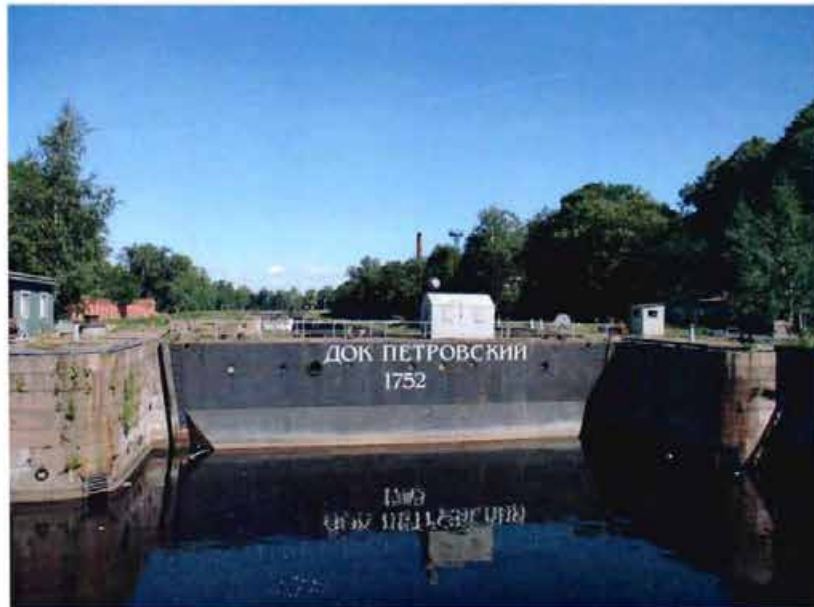
2. Затвор (батопорт) в южной части дока. Вид с южной стороны
