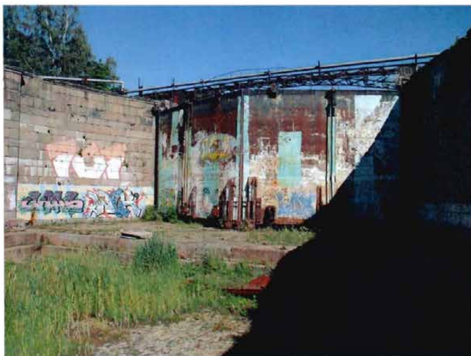
6. Вид на двусторчатые ворота и переходной мост в северной части дока со стороны камеры
