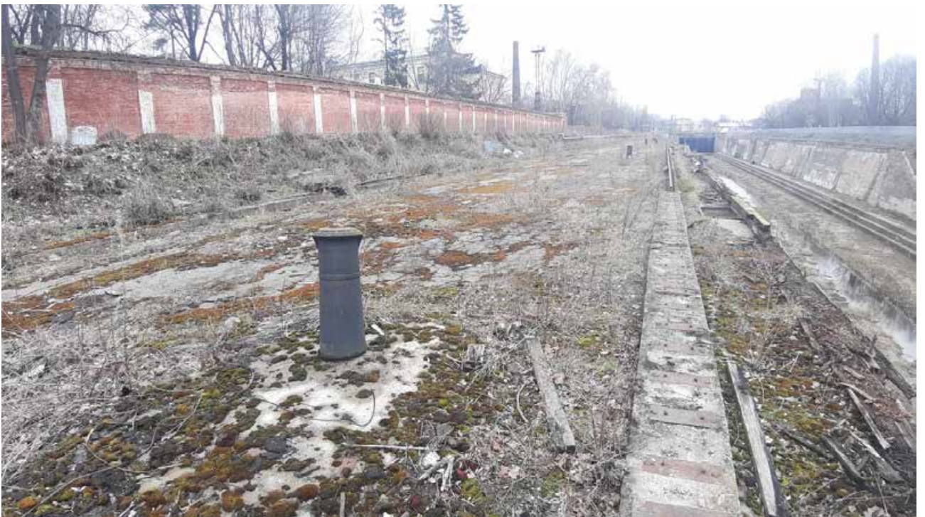
18. Док Петровский (южный). Исторические кнехты на берме вдоль западного края камеры дока из пушечных стволов. Давыдова Н.А. 24.04.2024.
