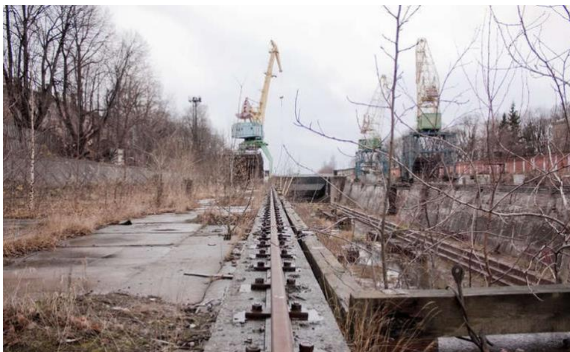
15. Канал им. Петра Великого с гидротехническими сооружениями. Док Петровский (южный). Фото Давыдова Н.А. 11.04.2018 г. (1).
