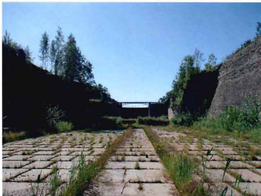
5. Северный док. Вид с севера на юг
