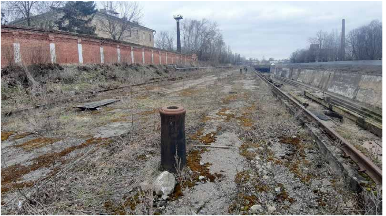
19. Док Петровский (южный). Исторические кнехты на берме вдоль западного края камеры дока из пушечных стволов. Давыдова Н.А. 24.04.2024.
