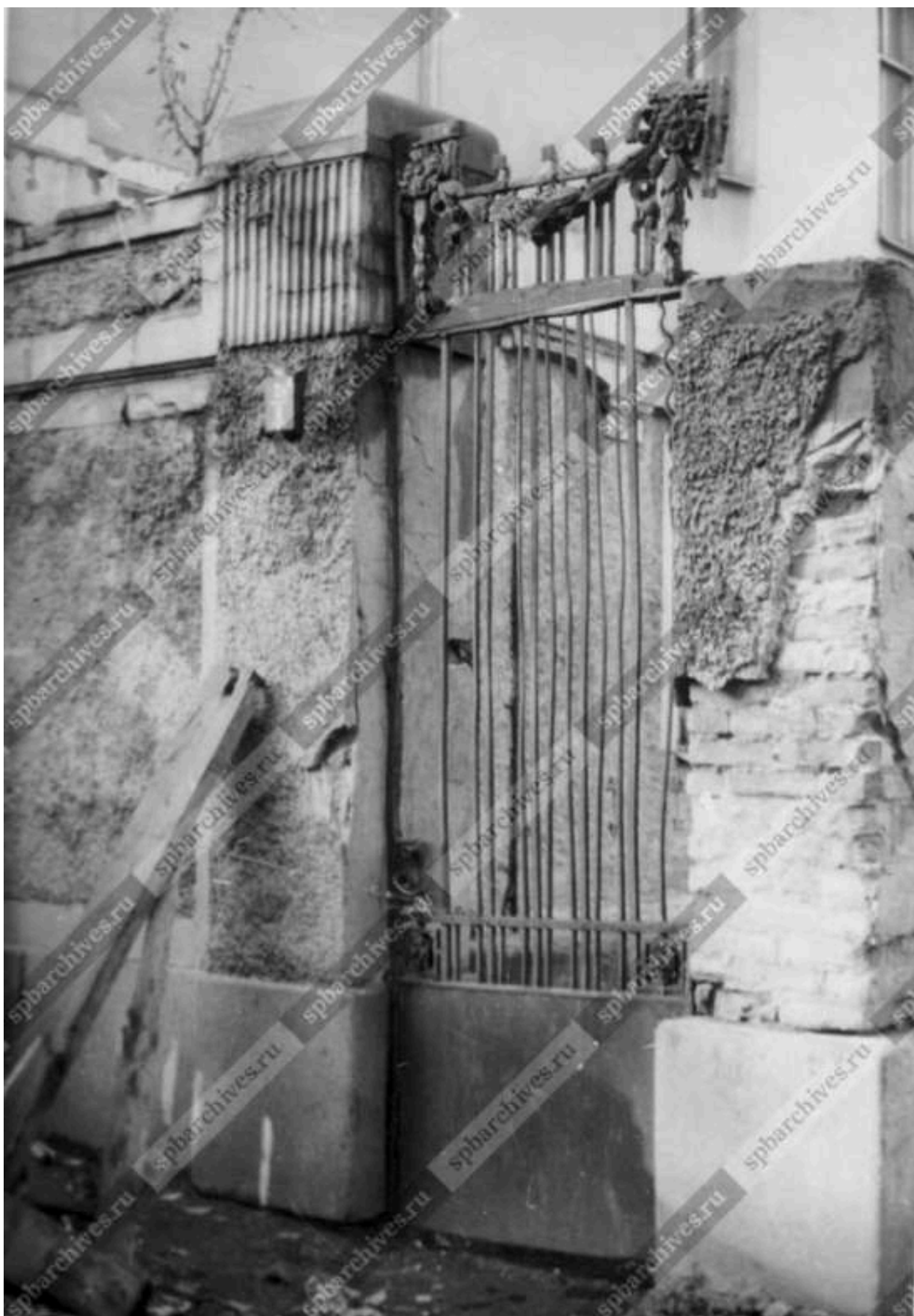
76. Ворота № 4 на Петропавловской улице. Архитектор С.С. Корвин-Круковский, 1910-1911 гг., 1990 г. – ЦГАКФФД СПб – Фотодокумент Ар 211757
