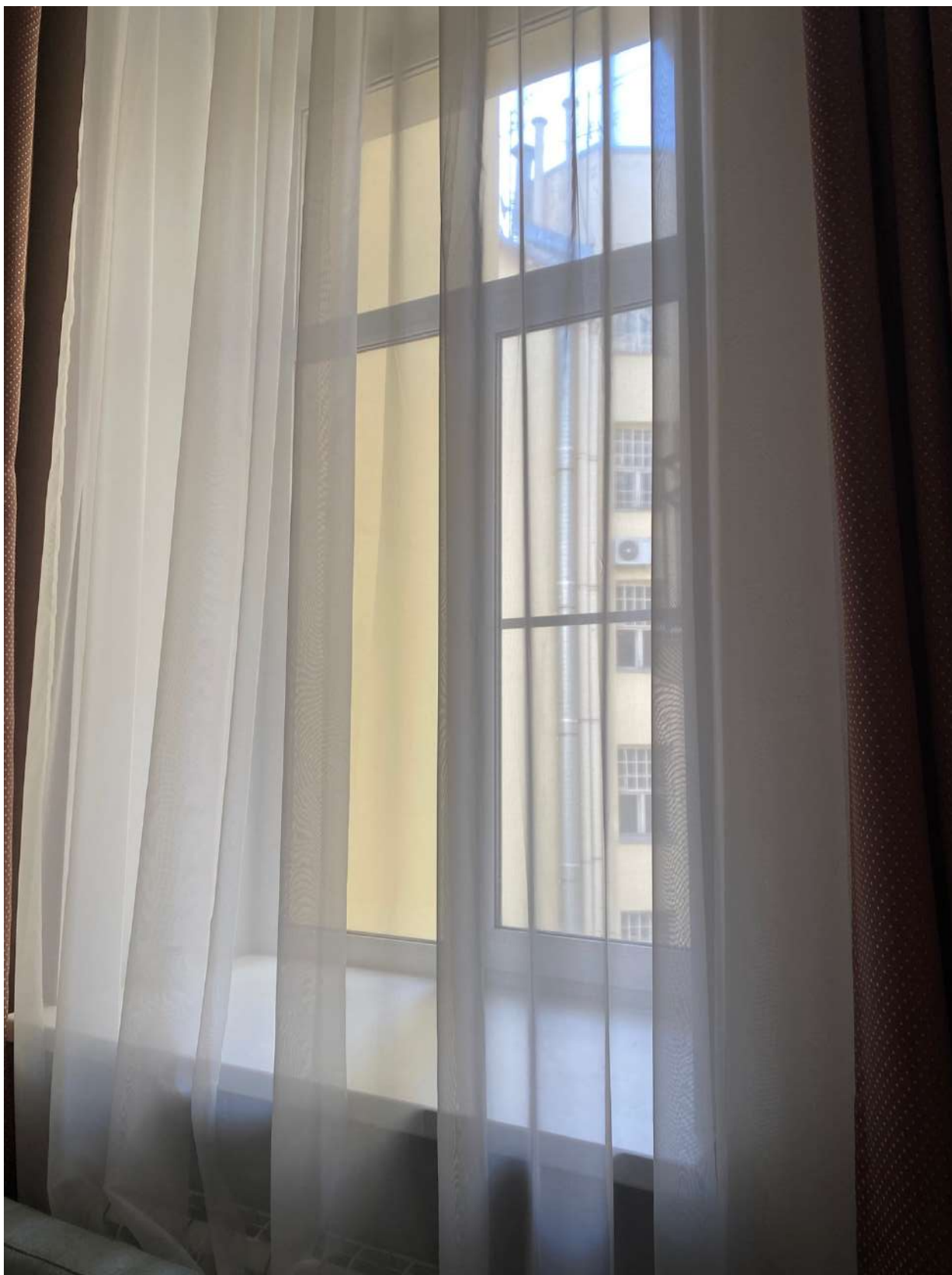
Фото 29. Вид на оконное заполнение квартиры № 49 объекта культурного наследия.
