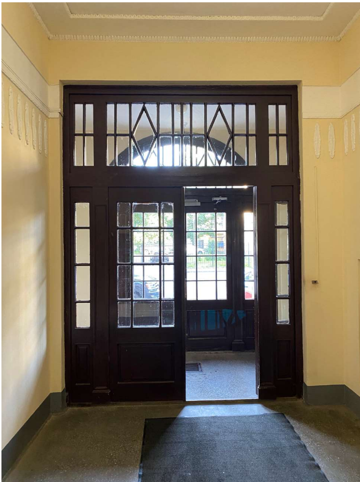
Фото 15. Вид на вестибюль парадной, ведущей в квартиру № 49, объекта культурного наследия.
