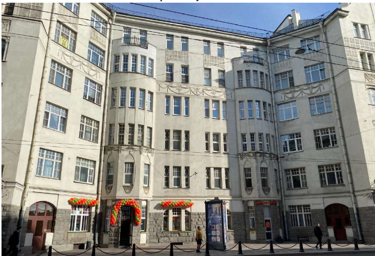
Фото 2. Фрагмент фасада объекта культурного наследия по Большому проспекту П.С.
