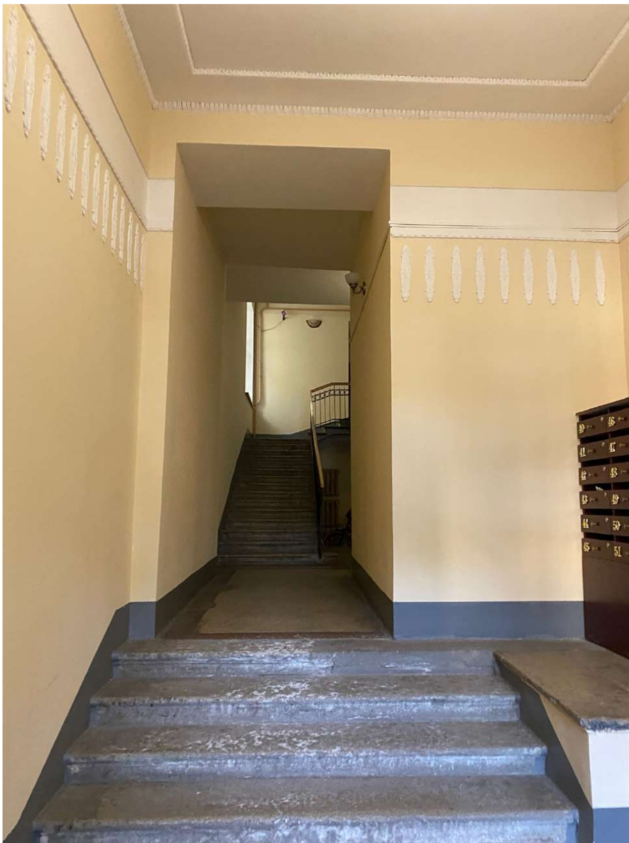
Фото 16. Вид на вестибюль парадной, ведущей в квартиру № 49, объекта культурного наследия.
