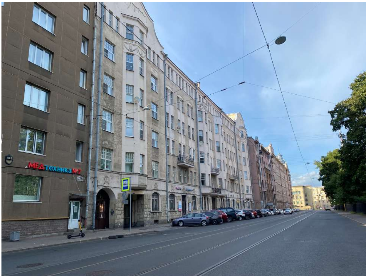
Фото 5. Общий вид фасада объекта культурного наследия по Петропавловской улице.
