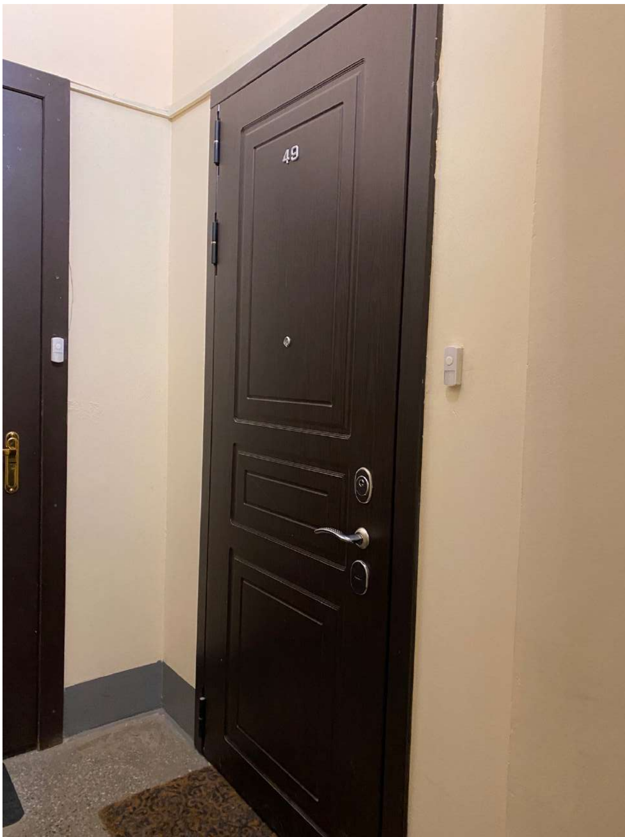
Фото 18. Вид на дверное заполнение квартиры № 49 объекта культурного наследия.
