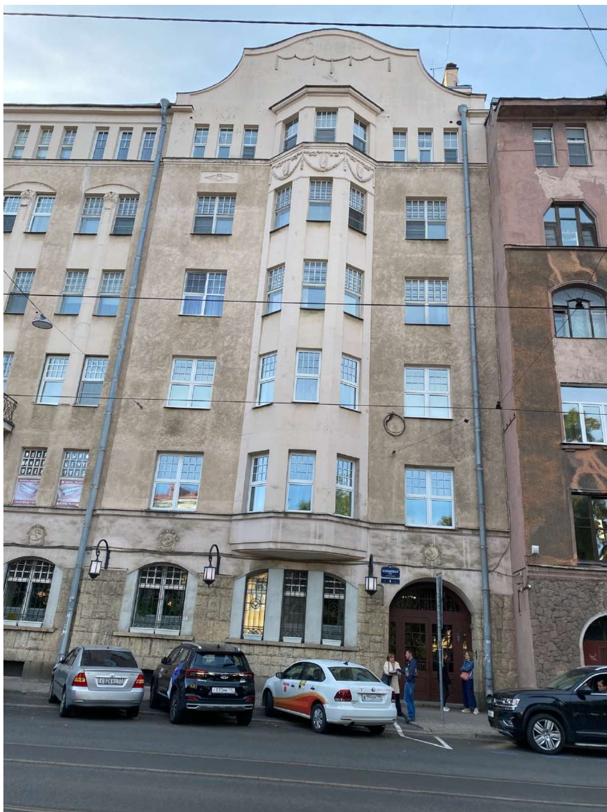
Фото 8. Фрагмент фасада объекта культурного наследия по Петропавловской улице.
