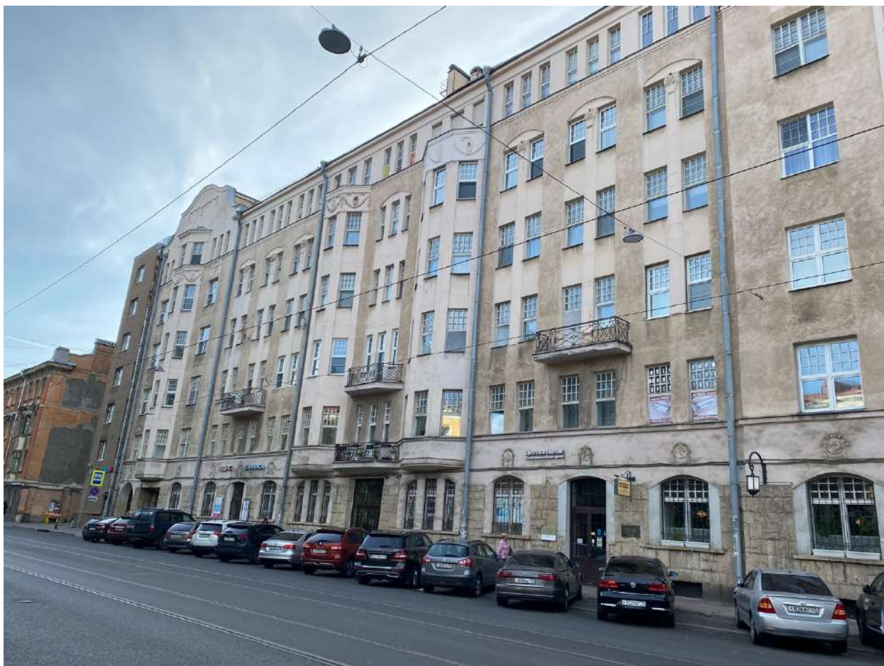
Фото 9. Фрагмент фасада объекта культурного наследия по Петропавловской улице.
