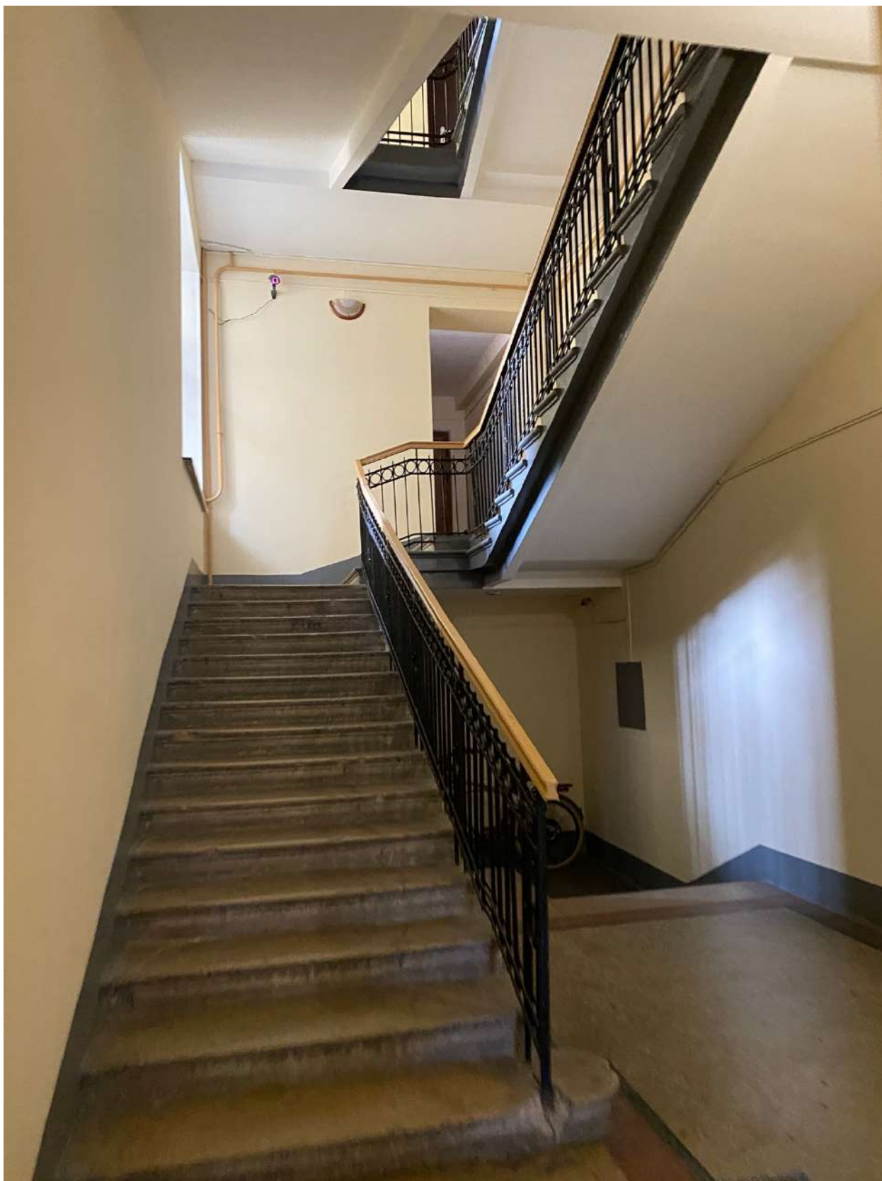
Фото 17. Вид на лестницу, ведущую в квартиру № 49, объекта культурного наследия.
