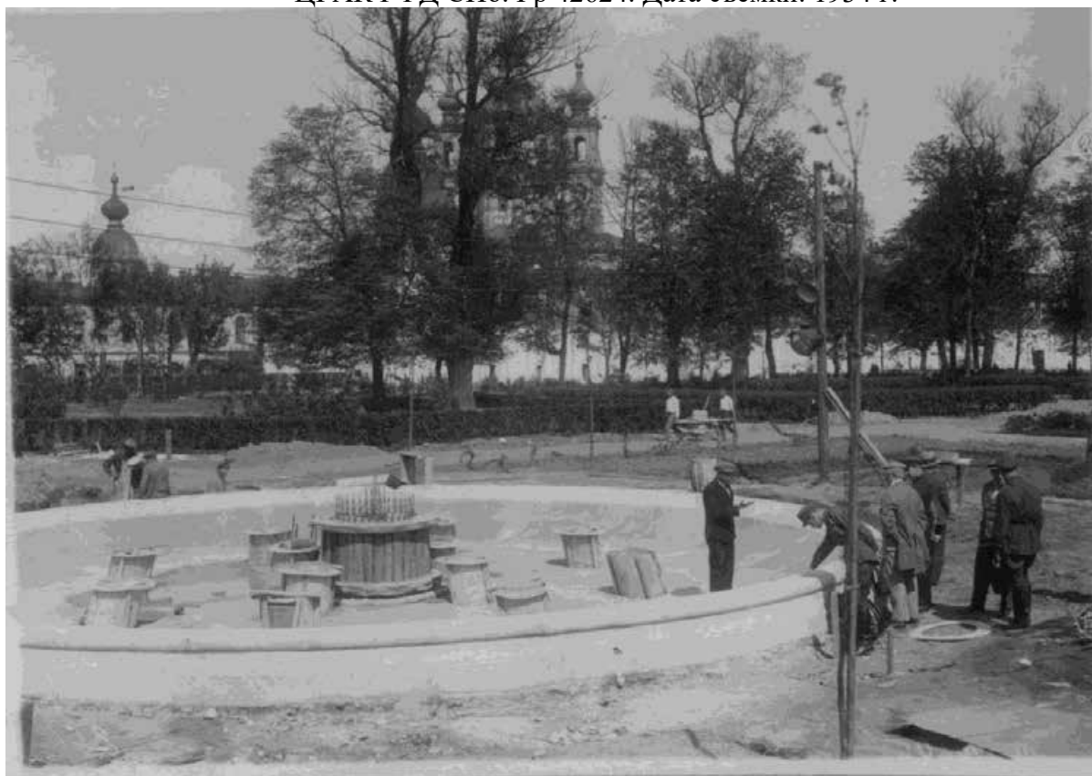
5. Возведение гранитного бассейна для фонтана в сквере у Смольного у площади Диктатуры // ЦГАКФФД СПб. Гр 42625. Дата съёмки: 1934 г.
