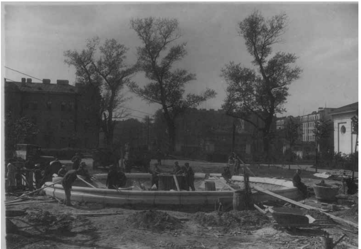
3. Общий вид строительства фонтана у Смольного. ЦГАКФФД СПб. Гр 42734. Дата съёмки: 1934 г.
