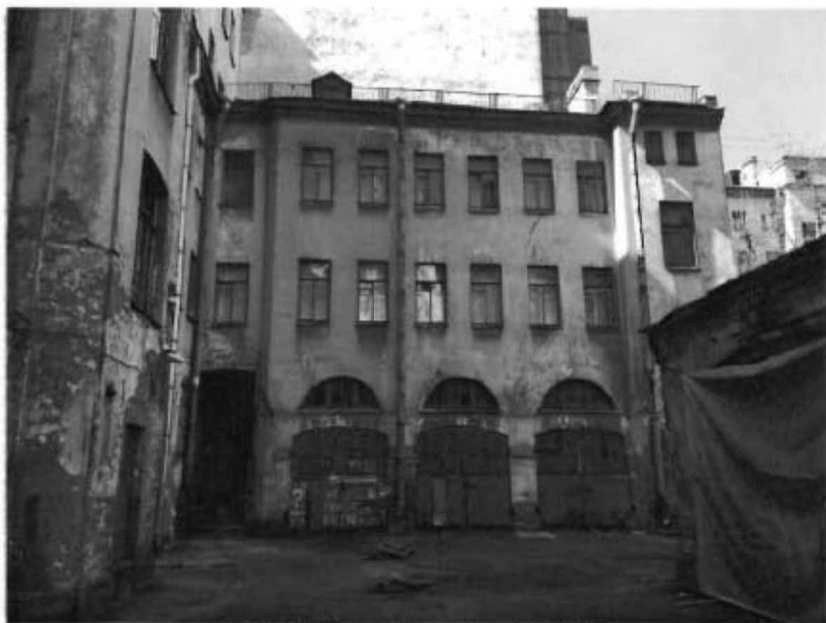
Фото 3. Часть дворового фасада флигеля
