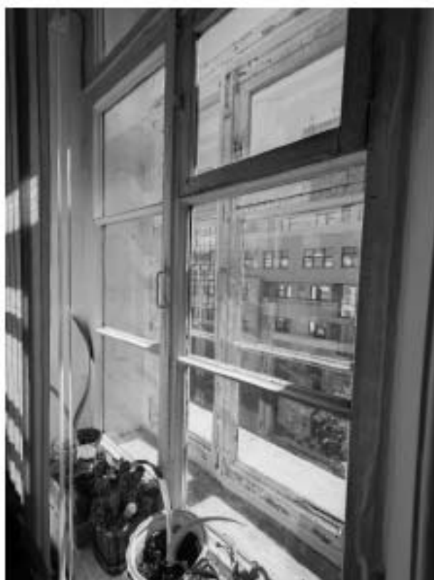
47. «Дом, где жили: в 1912-1936 гг. – путешественник Грум-Гржимайло Г.Е, в 1914-1922 гг. – певец Шалыпин Ф.И.», ул. Графтио, д. 26, лит. А. Четвертый этаж. Помещение №81. Фрагмент. Фото 08.05.2024г.
