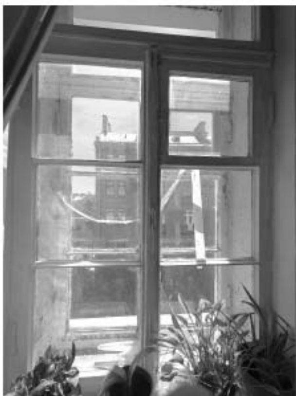
41. «Дом, где жили: в 1912-1936 гг. – путешественник Грум-Гржимайло Г.Е, в 1914-1922 гг. – певец Шалыпин Ф.И.», ул. Графтио, д. 26, лит. А. Четвертый этаж. Помещение №84. Фрагмент. Фото 08.05.2024г.
