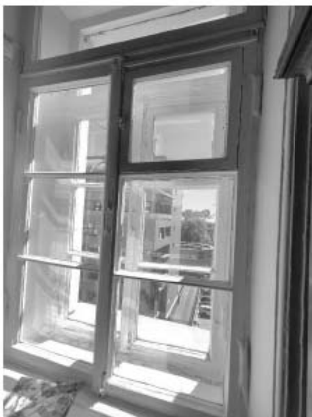
97. «Дом, где жили: в 1912-1936 гг. – путешественник Грум-Гржимайло Г.Е, в 1914-1922 гг. – певец Шаляпин Ф.И.», ул. Графтио, д. 26, лит. А. Пятый этаж. Помещение №106. Фрагмент. Фото 08.05.2024г.
