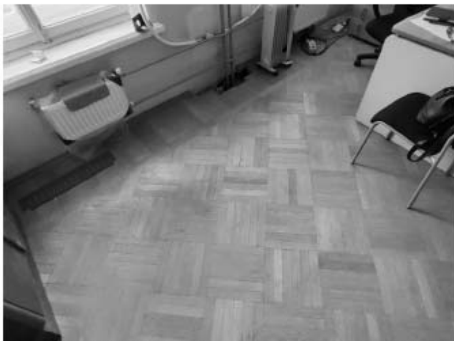
27. «Дом, где жили: в 1912-1936 гг. – путешественник Грум-Гржимайло Г.Е, в 1914-1922 гг. – певец Шаляпин Ф.И.», ул. Графтио, д. 26, лит. А. Третий этаж. Помещение №68. Фрагмент. Фото 08.05.2024г.
