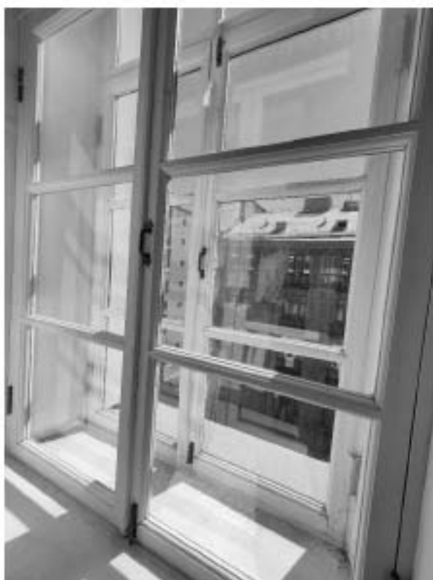
79. «Дом, где жили: в 1912-1936 гг. – путешественник Грум-Гржимайло Г.Е, в 1914-1922 гг. – певец Шаляпин Ф.И.», ул. Графтио, д. 26, лит. А. Пятый этаж. Помещение №109. Фрагмент. Фото 08.05.2024г.
