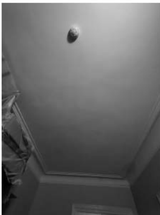
17. «Дом, где жили: в 1912-1936 гг. – путешественник Грум-Гржимайло Г.Е, в 1914-1922 гг. – певец Шаляпин Ф.И.», ул. Графтио, д. 26, лит. А. Третий этаж. Помещение №68. Фрагмент. Фото 08.05.2024г.
