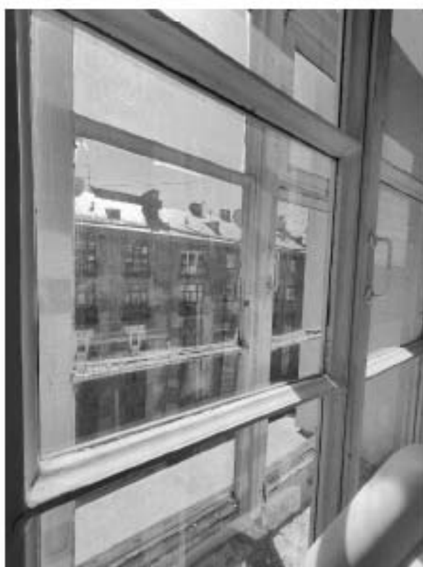
84. «Дом, где жили: в 1912-1936 гг. – путешественник Грум-Гржимайло Г.Е, в 1914-1922 гг. – певец Шаляпин Ф.И.», ул. Графтио, д. 26, лит. А. Пятый этаж. Помещение №108. Фрагмент. Фото 08.05.2024г.
