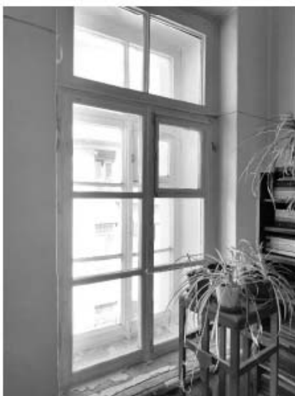
104. «Дом, где жили: в 1912-1936 гг. – путешественник Грум-Гржимайло Г.Е, в 1914-1922 гг. – певец Шаляпин Ф.И.», ул. Графтио, д. 26, лит. А. Пятый этаж. Помещение №100. Фрагмент. Фото 08.05.2024г.
