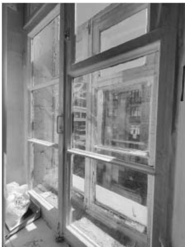
72. «Дом, где жили: в 1912-1936 гг. – путешественник Грум-Гржимайло Г.Е, в 1914-1922 гг. – певец Шаляпин Ф.И.», ул. Графтио, д. 26, лит. А. Четвертый этаж. Помещение №88. Фрагмент. Фото 08.05.2024г.
