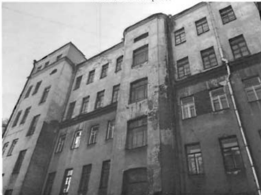
Фото 2. Часть дворового фасада главного корпуса
