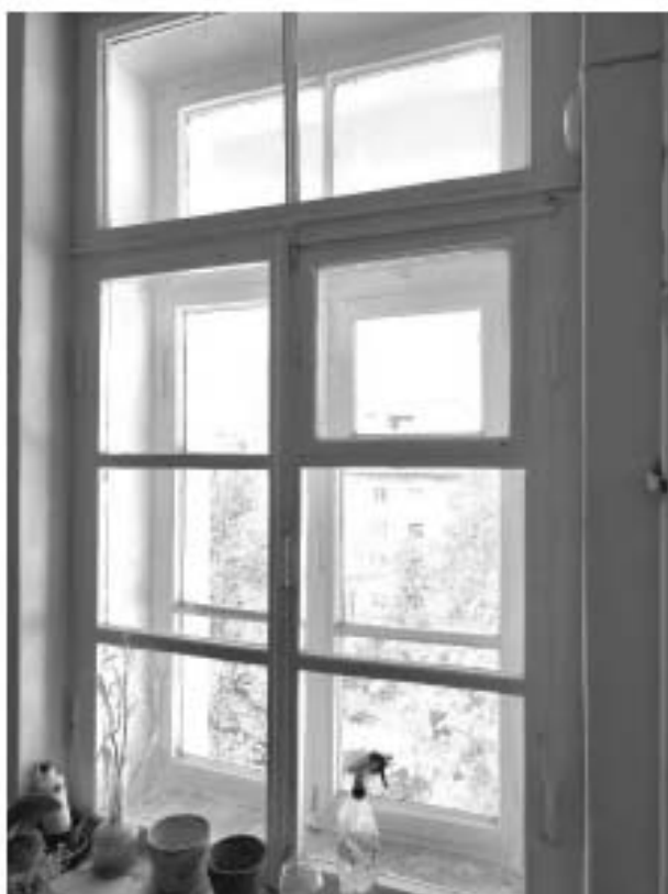
103. «Дом, где жили: в 1912-1936 гг. – путешественник Грум-Гржимайло Г.Е, в 1914-1922 гг. – певец Шаляпин Ф.И.», ул. Графтио, д. 26, лит. А. Пятый этаж. Помещение №100. Фрагмент. Фото 08.05.2024г.
