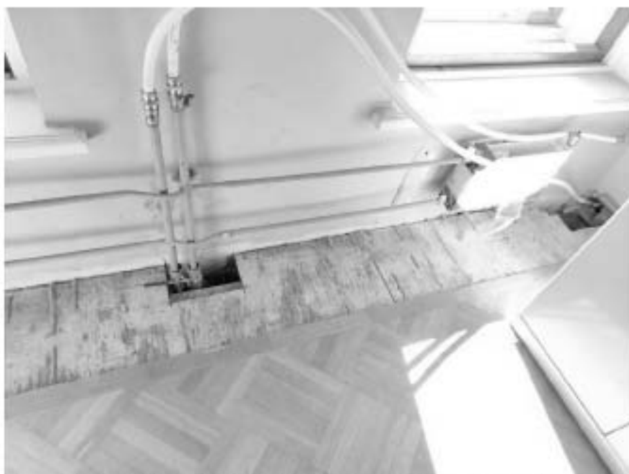
21. «Дом, где жили: в 1912-1936 гг. – путешественник Грум-Гржимайло Г.Е, в 1914-1922 гг. – певец Шаляпин Ф.И.», ул. Графтио, д. 26, лит. А. Третий этаж. Помещение №67. Фрагмент. Фото 08.05.2024г.
