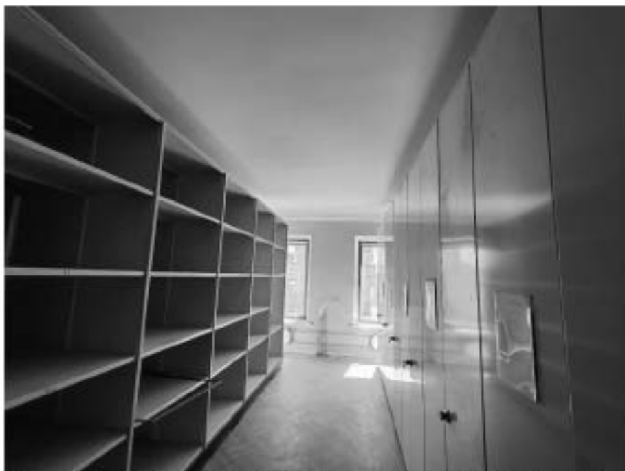
19. «Дом, где жили: в 1912-1936 гг. – путешественник Грум-Гржимайло Г.Е, в 1914-1922 гг. – певец Шаляпин Ф.И.», ул. Графтино, д. 26, лит. А. Третий этаж. Помещение №67. Общий вид. Фото 08.05.2024г.
