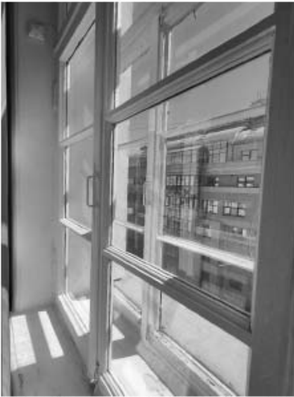
101. «Дом, где жили: в 1912-1936 гг. – путешественник Грум-Гржимайло Г.Е, в 1914-1922 гг. – певец Шаляпин Ф.И.», ул. Графтио, д. 26, лит. А. Пятый этаж. Помещение №105. Фрагмент. Фото 08.05.2024г.
