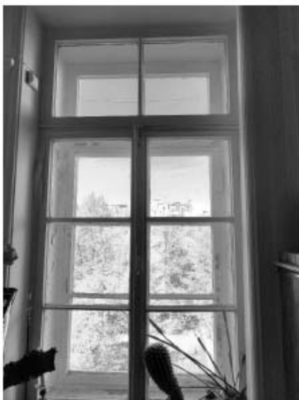
53. «Дом, где жили: в 1912-1936 гг. – путешественник Грум-Гржимайло Г.Е, в 1914-1922 гг. – певец Шалыпин Ф.И.», ул. Графтио, д. 26, лит. А. Четвертый этаж. Помещение №73. Фрагмент. Фото 08.05.2024г.
