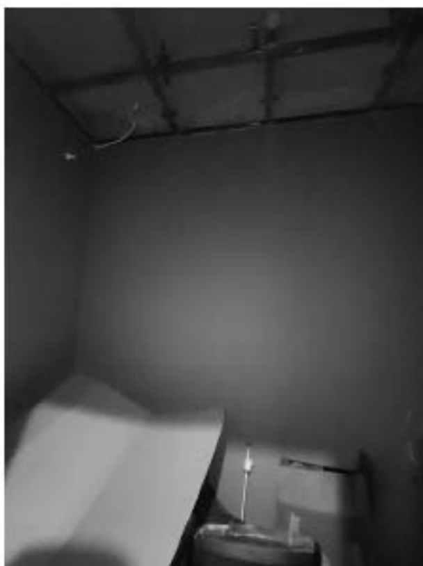
13. «Дом, где жили: в 1912-1936 гг. – путешественник Грум-Гржимайло Г.Е, в 1914-1922 гг. – певец Шаляпин Ф.И.», ул. Графтио, д. 26, лит. А. Третий этаж. Помещение №61. Общий вид. Фото 08.05.2024г.
