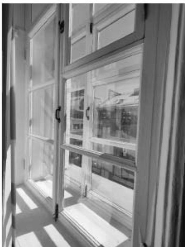
81. «Дом, где жили: в 1912-1936 гг. – путешественник Грум-Гржимайло Г.Е, в 1914-1922 гг. – певец Шаляпин Ф.И.», ул. Графтио, д. 26, лит. А. Пятый этаж. Помещение №109. Фрагмент. Фото 08.05.2024г.
