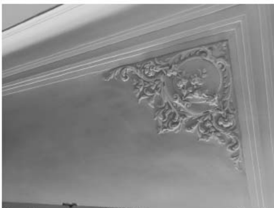
34. «Дом, где жили: в 1912-1936 гг. – путешественник Грум-Гржимайло Г.Е, в 1914-1922 гг. – певец Шаляпин Ф.И.», ул. Графтио, д. 26, лит. А. Третий этаж. Помещение №67. Фрагмент. Фото 08.05.2024г.
