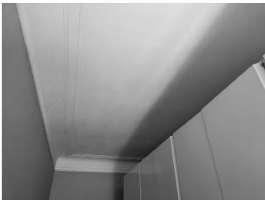
36. «Дом, где жили: в 1912-1936 гг. – путешественник Грум-Гржимайло Г.Е, в 1914-1922 гг. – певец Шаляпин Ф.И.», ул. Графтио, д. 26, лит. А. Третий этаж. Помещение №67. Фрагмент. Фото 08.05.2024г.
