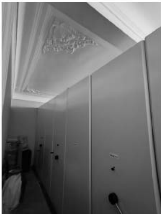
31. «Дом, где жили: в 1912-1936 гг. – путешественник Грум-Гржимайло Г.Е., в 1914-1922 гг. – певец Шаляпин Ф.И.», ул. Графтино, д. 26, лит. А. Третий этаж. Помещение №67. Общий вид. Фото 08.05.2024г.
