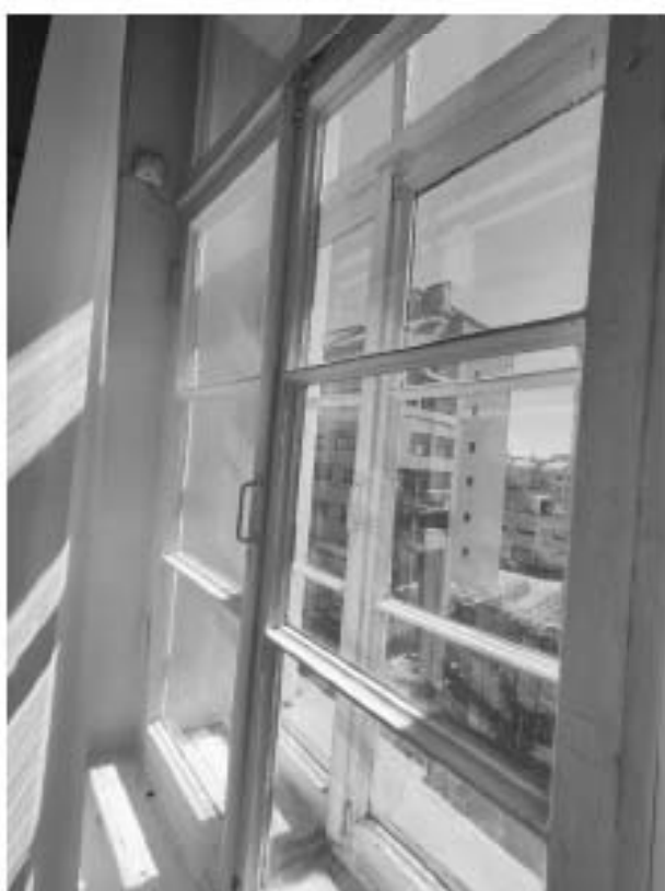
60. «Дом, где жили: в 1912-1936 гг. – путешественник Грум-Гржимайло Г.Е, в 1914-1922 гг. – певец Шалыпин Ф.И.», ул. Графтио, д. 26, лит. А. Четвертый этаж. Помещение №85. Фрагмент. Фото 08.05.2024г.
