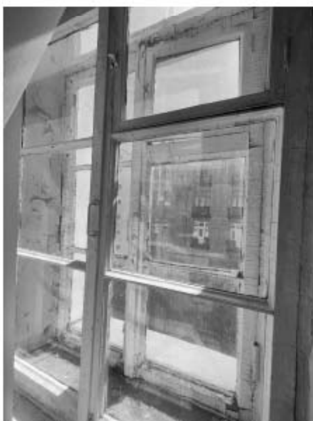
62. «Дом, где жили: в 1912-1936 гг. – путешественник Грум-Гржимайло Г.Е, в 1914-1922 гг. – певец Шалыпин Ф.И.», ул. Графтио, д. 26, лит. А. Четвертый этаж. Помещение №86. Фрагмент. Фото 08.05.2024г.
