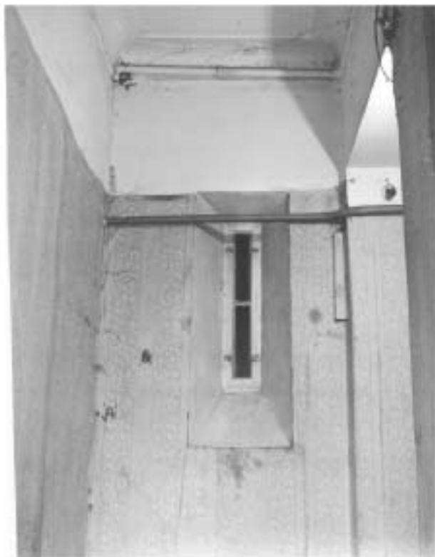
11. Пермская ул., 26, 3-й этаж. Щелевидное окно, в юго-западной стене помещения 68В ныне заложено. Справа проход в помещение №69. Слева разобранный к настоящему времени северо-западная стена ванны. Фотофиксация. 1987 г. / ЛФ Гипротест. Материал предоставлен заказчиком.
