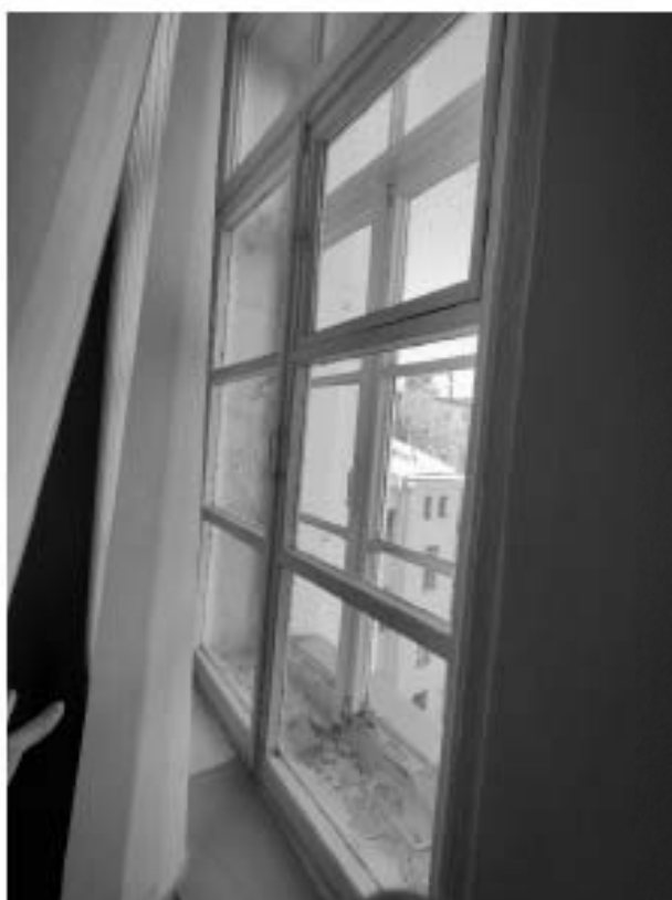
57. «Дом, где жили: в 1912-1936 гг. – путешественник Грум-Гржимайло Г.Е, в 1914-1922 гг. – певец Шалыпин Ф.И.», ул. Графтио, д. 26, лит. А. Четвертый этаж. Помещение №72. Фрагмент. Фото 08.05.2024г.
