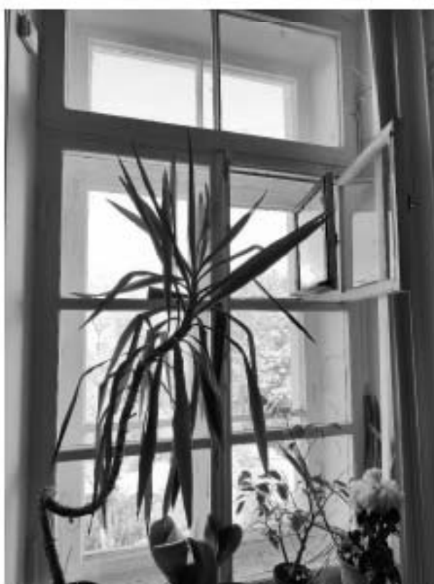
56. «Дом, где жили: в 1912-1936 гг. – путешественник Грум-Гржимайло Г.Е, в 1914-1922 гг. – певец Шалыпин Ф.И.», ул. Графтио, д. 26, лит. А. Четвертый этаж. Помещение №72. Фрагмент. Фото 08.05.2024г.
