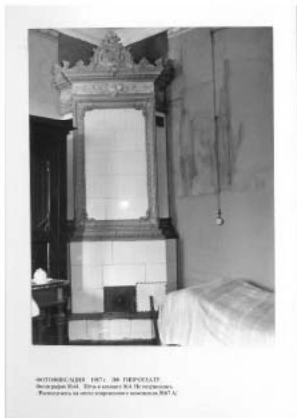
22. Фотофиксация печи 3 этажа в помещении 1-Н (67). ЛФ ГИПРОТЕАТР 1987 г.
