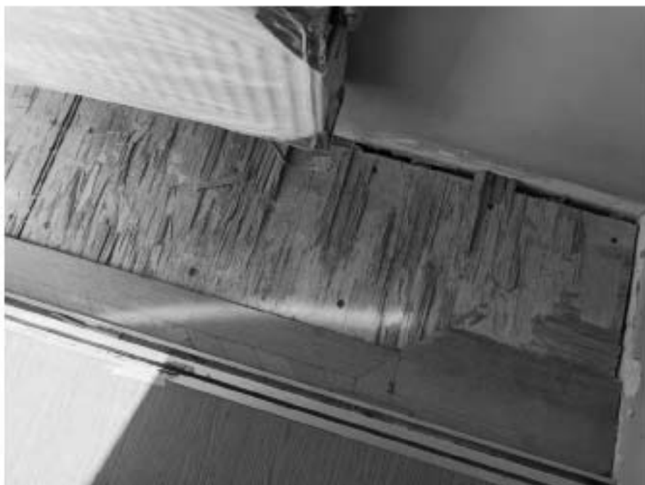
35. «Дом, где жили: в 1912-1936 гг. – путешественник Грум-Гржимайло Г.Е, в 1914-1922 гг. – певец Шаляпин Ф.И.», ул. Графтио, д. 26, лит. А. Третий этаж. Помещение №67. Фрагмент. Фото 08.05.2024г.
