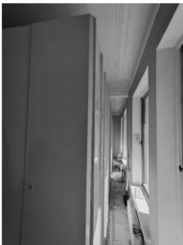
33. «Дом, где жили: в 1912-1936 гг. – путешественник Грум-Гржимайло Г.Е, в 1914-1922 гг. – певец Шаляпин Ф.И.», ул. Графтио, д. 26, лит. А. Третий этаж. Помещение №67. Общий вид. Фото 08.05.2024г.
