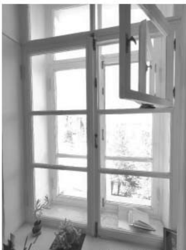
76. «Дом, где жили: в 1912-1936 гг. – путешественник Грум-Гржимайло Г.Е, в 1914-1922 гг. – певец Шаляпин Ф.И.», ул. Графтио, д. 26, лит. А. Пятый этаж. Помещение №110. Фрагмент. Фото 08.05.2024г.
