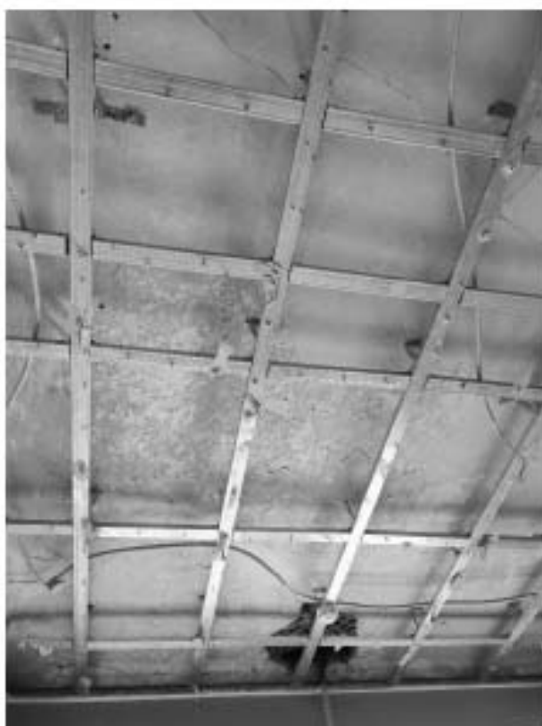
11. «Дом, где жили: в 1912-1936 гг. – путешественник Грум-Гржимайло Г.Е, в 1914-1922 гг. – певец Шаляпин Ф.И.», ул. Графтио, д. 26, лит. А. Третий этаж. Помещение №59. Фрагмент. Фото 08.05.2024г.
