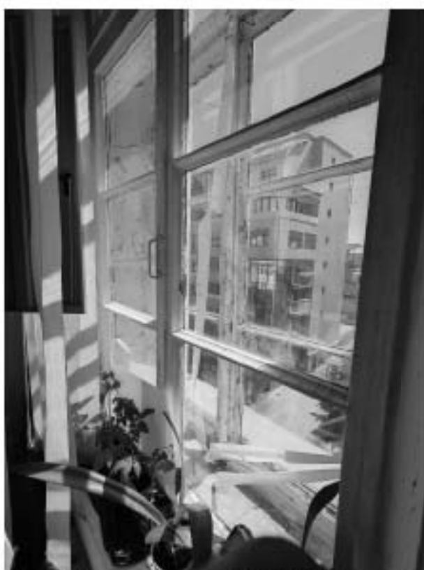
42. «Дом, где жили: в 1912-1936 гг. – путешественник Грум-Гржимайло Г.Е, в 1914-1922 гг. – певец Шалыпин Ф.И.», ул. Графтио, д. 26, лит. А. Четвертый этаж. Помещение №84. Фрагмент. Фото 08.05.2024г.
