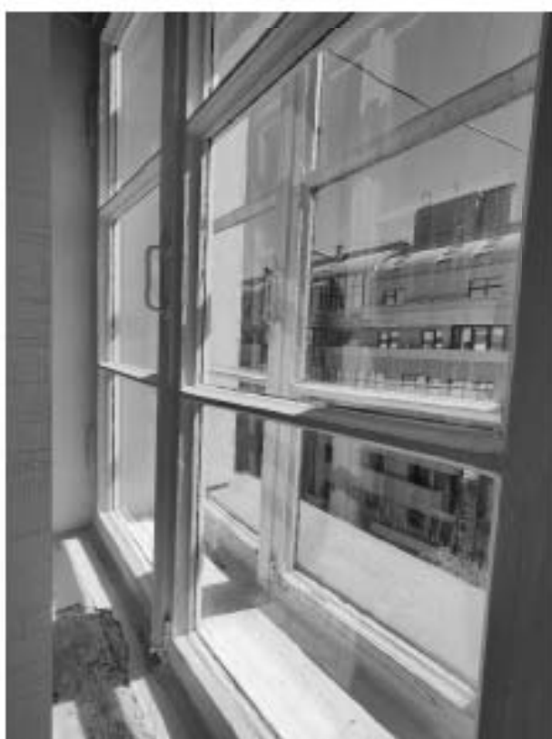
98. «Дом, где жили: в 1912-1936 гг. – путешественник Грум-Гржимайло Г.Е, в 1914-1922 гг. – певец Шаляпин Ф.И.», ул. Графтио, д. 26, лит. А. Пятый этаж. Помещение №106. Фрагмент. Фото 08.05.2024г.
