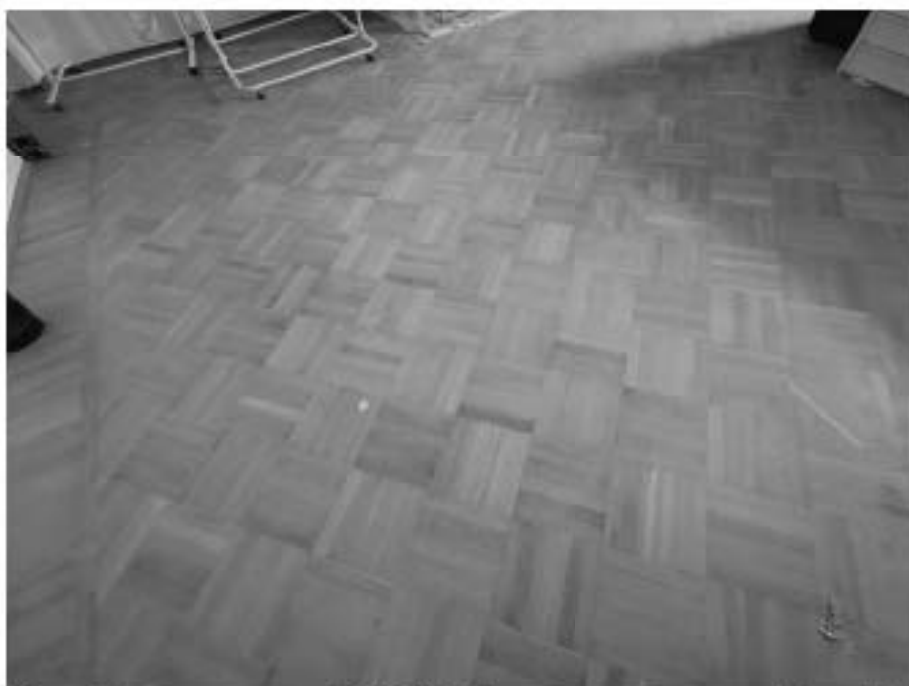
30. «Дом, где жили: в 1912-1936 гг. – путешественник Грум-Гржимайло Г.Е, в 1914-1922 гг. – певец Шаляпин Ф.И.», ул. Графтио, д. 26, лит. А. Третий этаж. Помещение №68. Фрагмент. Фото 08.05.2024г.
