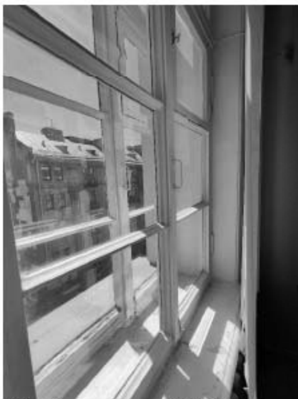
100. «Дом, где жили: в 1912-1936 гг. – путешественник Грум-Гржимайло Г.Е, в 1914-1922 гг. – певец Шаляпин Ф.И.», ул. Графтио, д. 26, лит. А. Пятый этаж. Помещение №105. Фрагмент. Фото 08.05.2024г.
