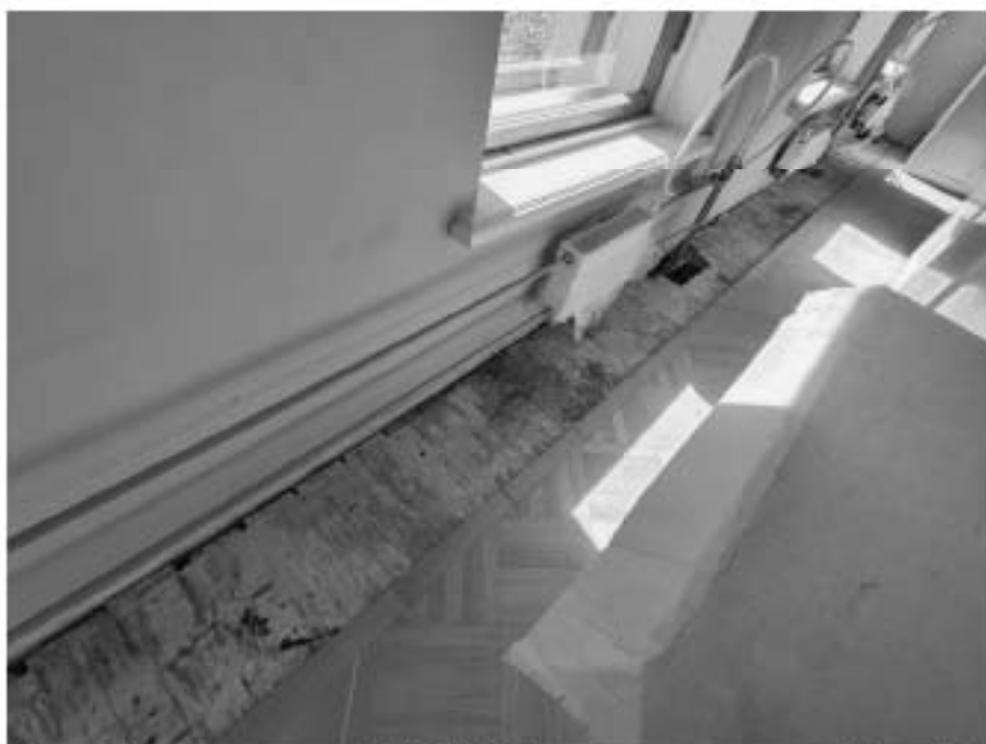
24. «Дом, где жили: в 1912-1936 гг. – путешественник Грум-Гржимайло Г.Е, в 1914-1922 гг. – певец Шаляпин Ф.И.», ул. Графтио, д. 26, лит. А. Третий этаж. Помещение №67. Фрагмент. Фото 08.05.2024г.
