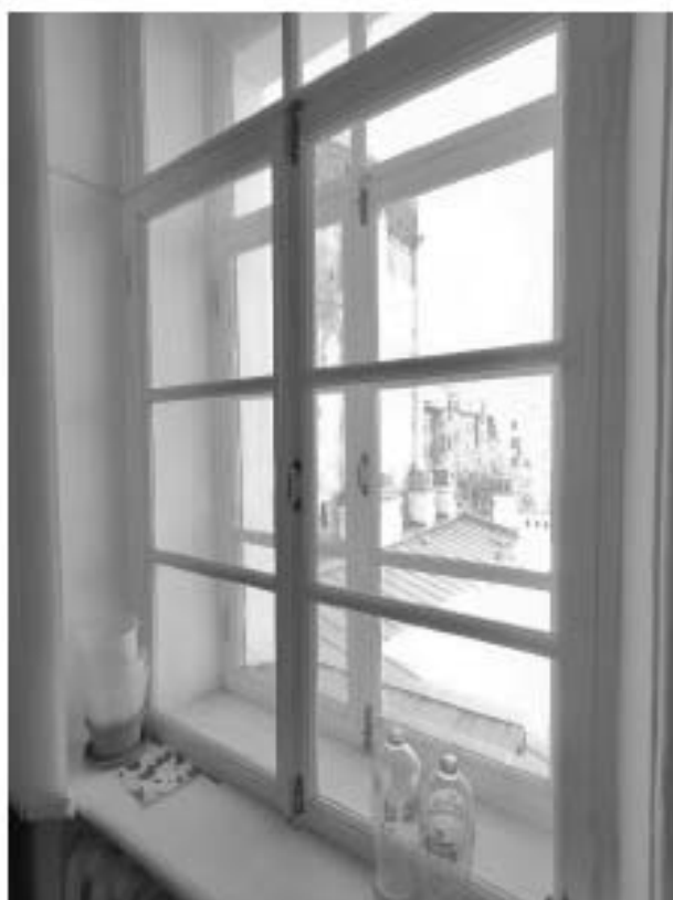
77. «Дом, где жили: в 1912-1936 гг. – путешественник Грум-Гржимайло Г.Е, в 1914-1922 гг. – певец Шаляпин Ф.И.», ул. Графтио, д. 26, лит. А. Пятый этаж. Помещение №110. Фрагмент. Фото 08.05.2024г.
