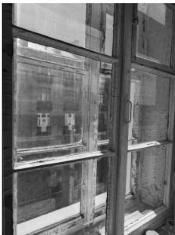
39. «Дом, где жили: в 1912-1936 гг. – путешественник Грум-Гржимайло Г.Е, в 1914-1922 гг. – певец Шалыпин Ф.И.», ул. Графтио, д. 26, лит. А. Четвертый этаж. Помещение №83. Фрагмент. Фото 08.05.2024г.
