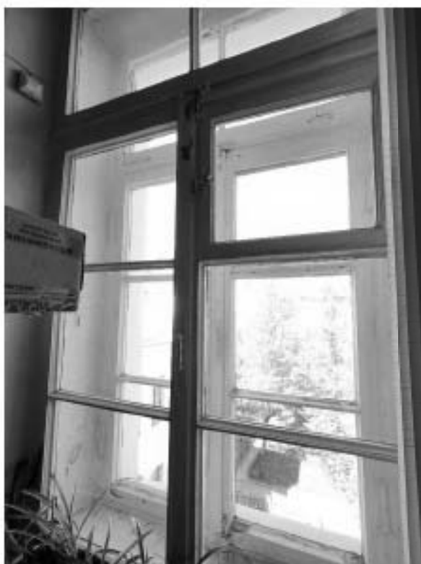
65. «Дом, где жили: в 1912-1936 гг. – путешественник Грум-Гржимайло Г.Е, в 1914-1922 гг. – певец Шалыпин Ф.И.», ул. Графтио, д. 26, лит. А. Четвертый этаж. Помещение №90. Фрагмент. Фото 08.05.2024г.
