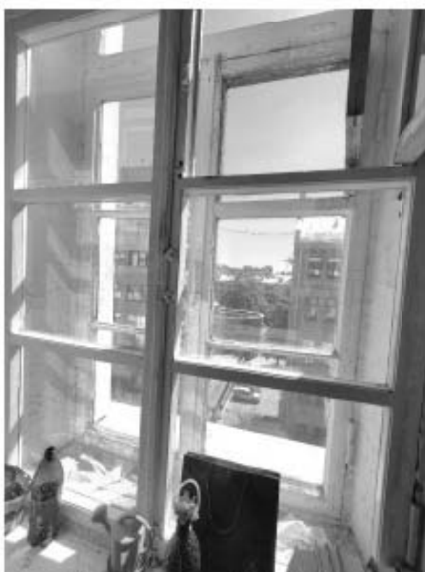
88. «Дом, где жили: в 1912-1936 гг. – путешественник Грум-Гржимайло Г.Е, в 1914-1922 гг. – певец Шаляпин Ф.И.», ул. Графтио, д. 26, лит. А. Пятый этаж. Помещение №107. Фрагмент. Фото 08.05.2024г.
