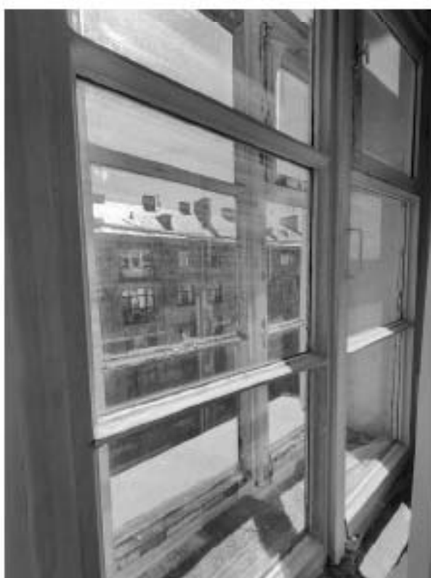
86. «Дом, где жили: в 1912-1936 гг. – путешественник Грум-Гржимайло Г.Е, в 1914-1922 гг. – певец Шаляпин Ф.И.», ул. Графтио, д. 26, лит. А. Пятый этаж. Помещение №108. Фрагмент. Фото 08.05.2024г.
