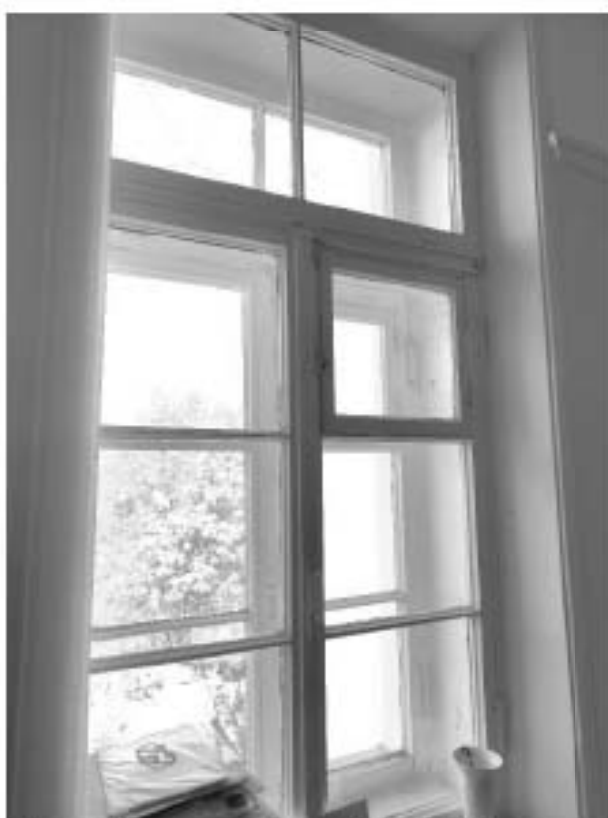
54. «Дом, где жили: в 1912-1936 гг. – путешественник Грум-Гржимайло Г.Е, в 1914-1922 гг. – певец Шалыпин Ф.И.», ул. Графтио, д. 26, лит. А. Четвертый этаж. Помещение №73. Фрагмент. Фото 08.05.2024г.
