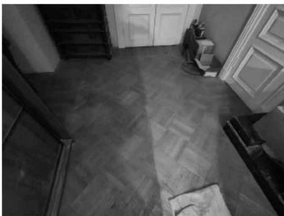
18. «Дом, где жили: в 1912-1936 гг. – путешественник Грум-Гржимайло Г.Е, в 1914-1922 гг. – певец Шаляпин Ф.И.», ул. Графтио, д. 26, лит. А. Третий этаж. Помещение №68. Фрагмент. Фото 08.05.2024г.
