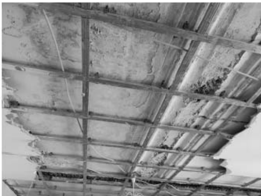
29. «Дом, где жили: в 1912-1936 гг. – путешественник Грум-Гржимайло Г.Е, в 1914-1922 гг. – певец Шаляпин Ф.И.», ул. Графтио, д. 26, лит. А. Третий этаж. Помещение №68. Фрагмент. Фото 08.05.2024г.
