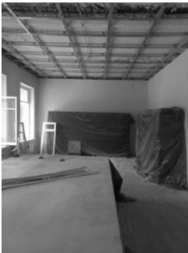
5. «Дом, где жили: в 1912-1936 гг. – путешественник Грум-Гржимайло Г.Е, в 1914-1922 гг. – певец Шаляпин Ф.И.», ул. Графтио, д. 26, лит. А. Третий этаж. Помещение №57. Общий вид. Фото 08.05.2024г.
