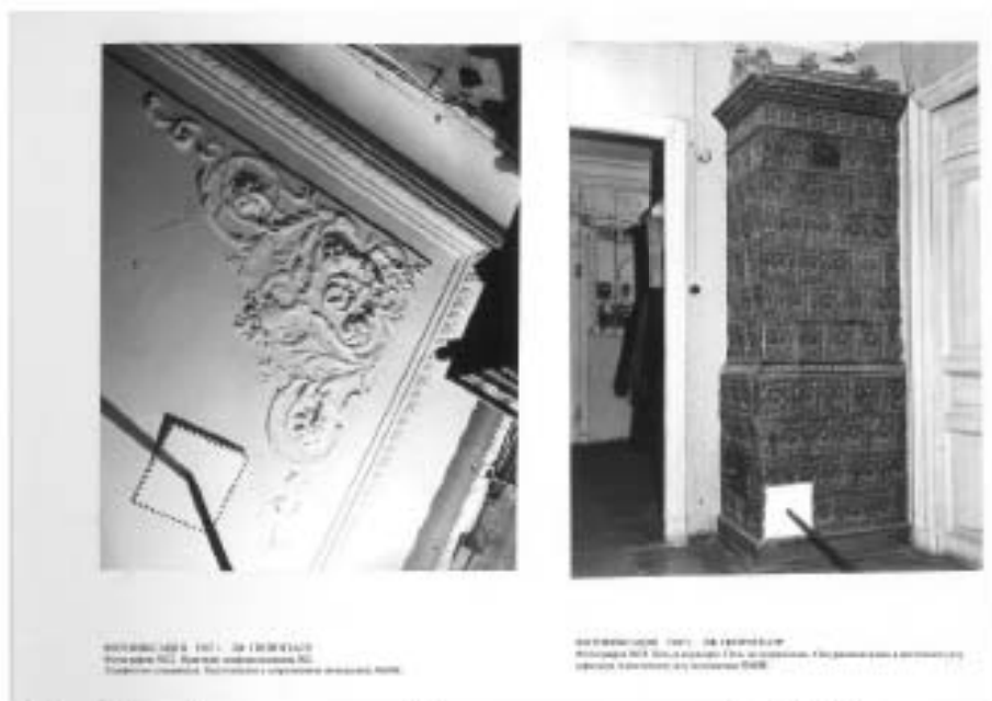
18. Фотофиксация печи 3 этажа в помещении 1-Н (68) коридор. ЛФ ГИПРОТЕАТР 1987 г.
