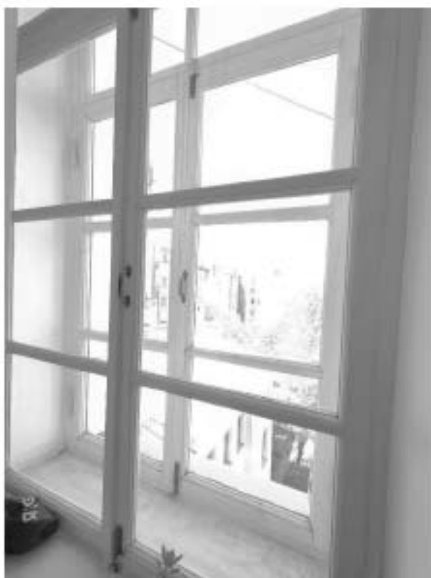
75. «Дом, где жили: в 1912-1936 гг. – путешественник Грум-Гржимайло Г.Е, в 1914-1922 гг. – певец Шаляпин Ф.И.», ул. Графтио, д. 26, лит. А. Пятый этаж. Помещение №110. Фрагмент. Фото 08.05.2024г.
