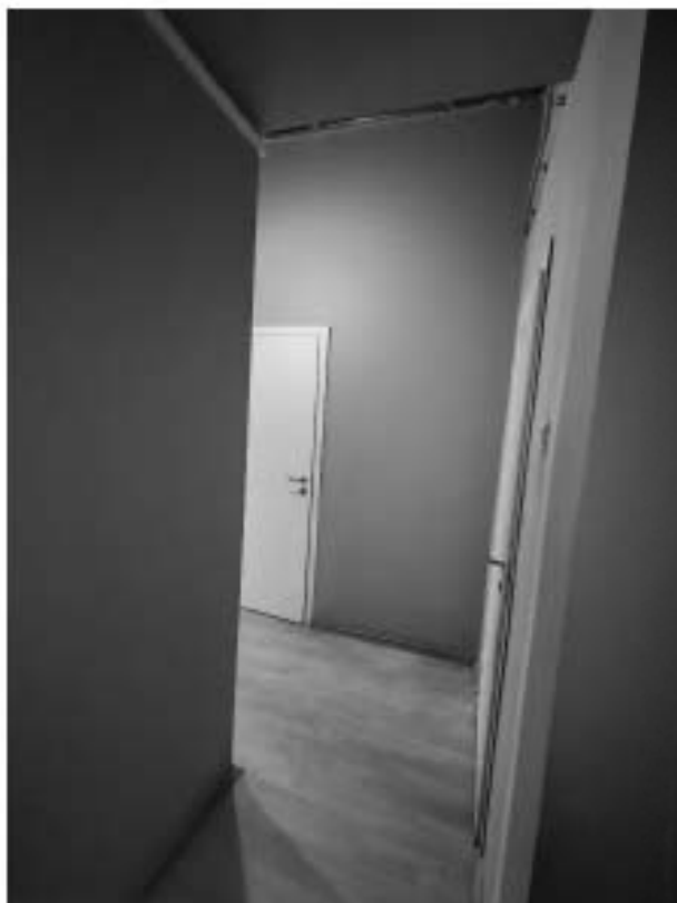
15. «Дом, где жили: в 1912-1936 гг. – путешественник Грум-Гржимайло Г.Е., в 1914-1922 гг. – певец Шаляпин Ф.И.», ул. Графтино, д. 26, лит. А. Третий этаж. Помещение №60. Общий вид. Фото 08.05.2024г.
