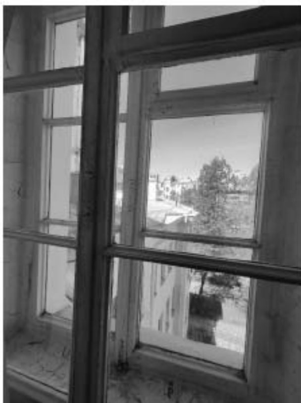
67. «Дом, где жили: в 1912-1936 гг. – путешественник Грум-Гржимайло Г.Е, в 1914-1922 гг. – певец Шалыпин Ф.И.», ул. Графтио, д. 26, лит. А. Четвертый этаж. Помещение №91. Фрагмент. Фото 08.05.2024г.
