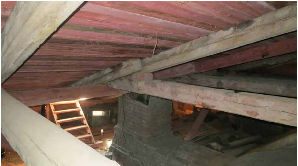
Фото 36. Подкровельное пространство. Фрагмент стропильной системы
