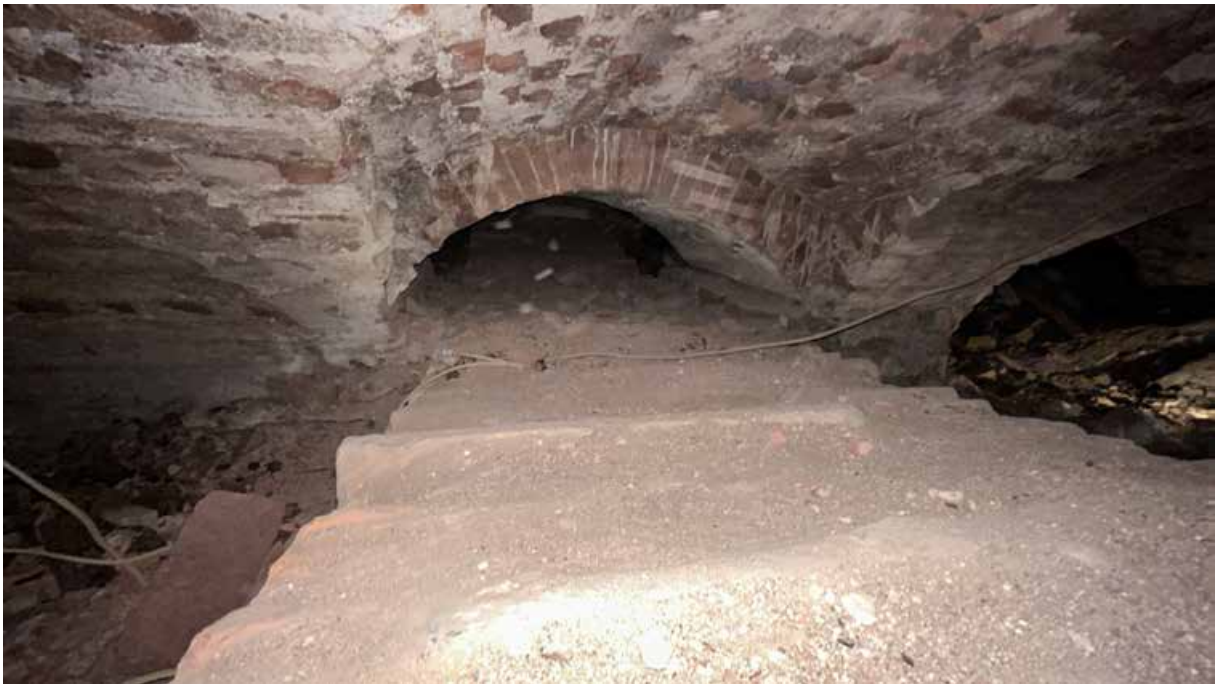
Фото 14. Подвал. Вид на разгрузочную арку в центральной части собора.
