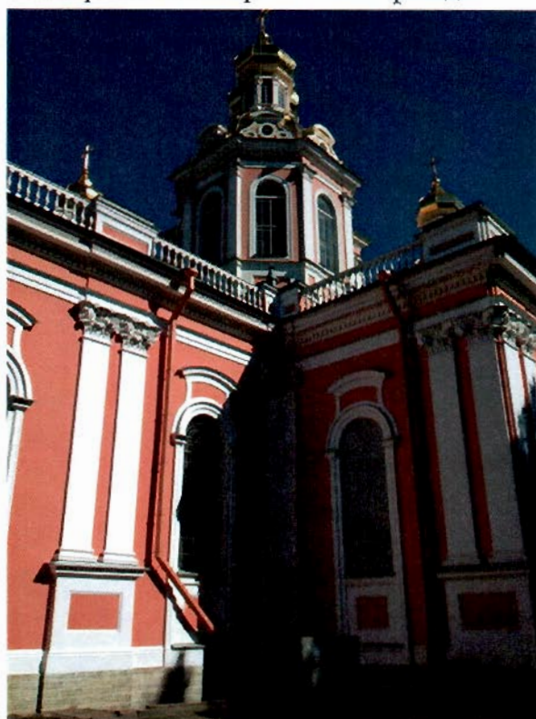
2. Фрагмент северной части фасада
