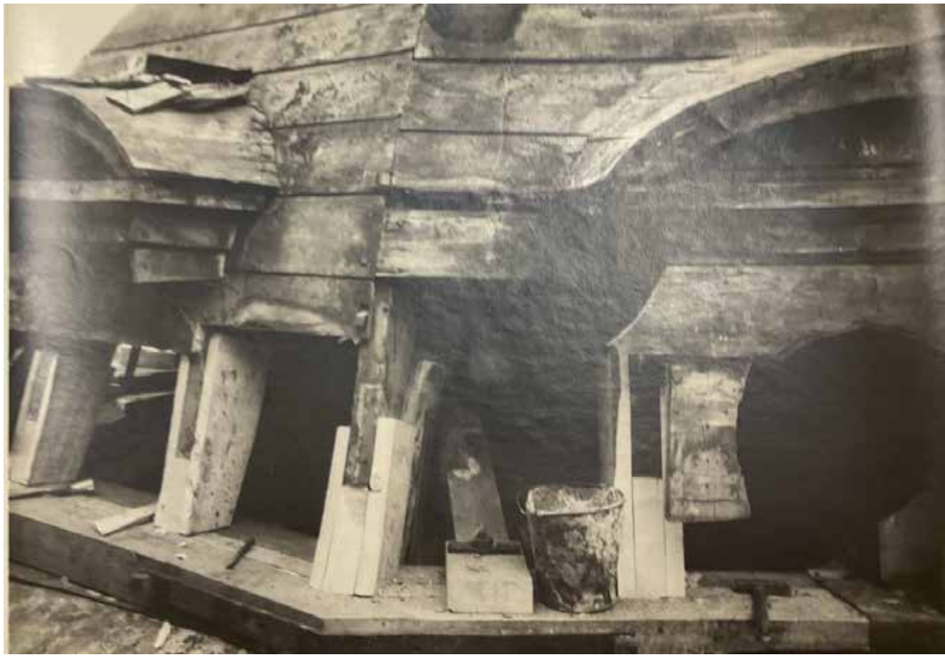
91. Предтеченская церковь. Северо-восточная малая глава, реставрация купола Юго- западная часть. (ЦГАНДТ Р-488, Оп. 324, Д. 213, Л. 8. 1952-1967 г.)
