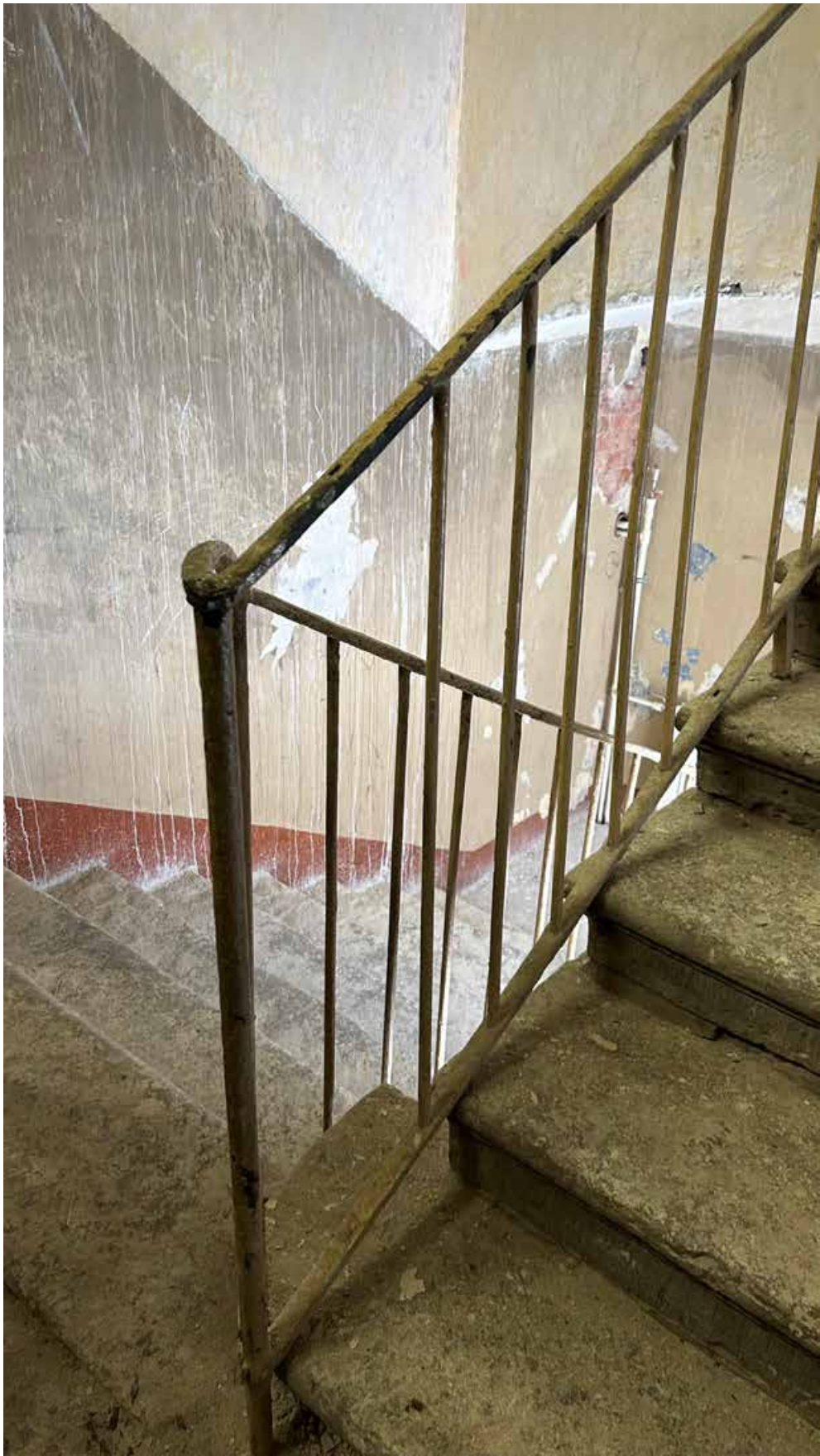
Фото 28. Лестница в западной части собора.
