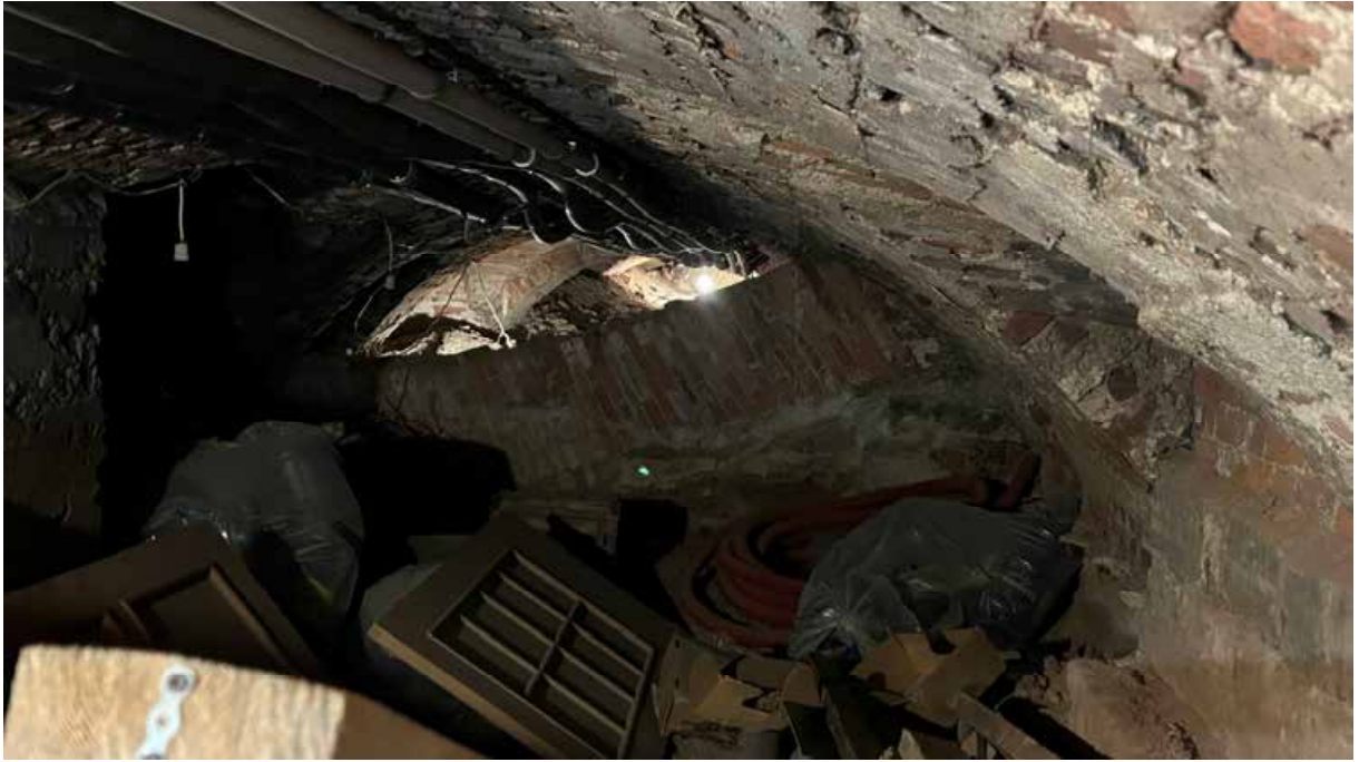
Фото11. Подвал. Вид на разгрузочную арку в центральной части собора.
