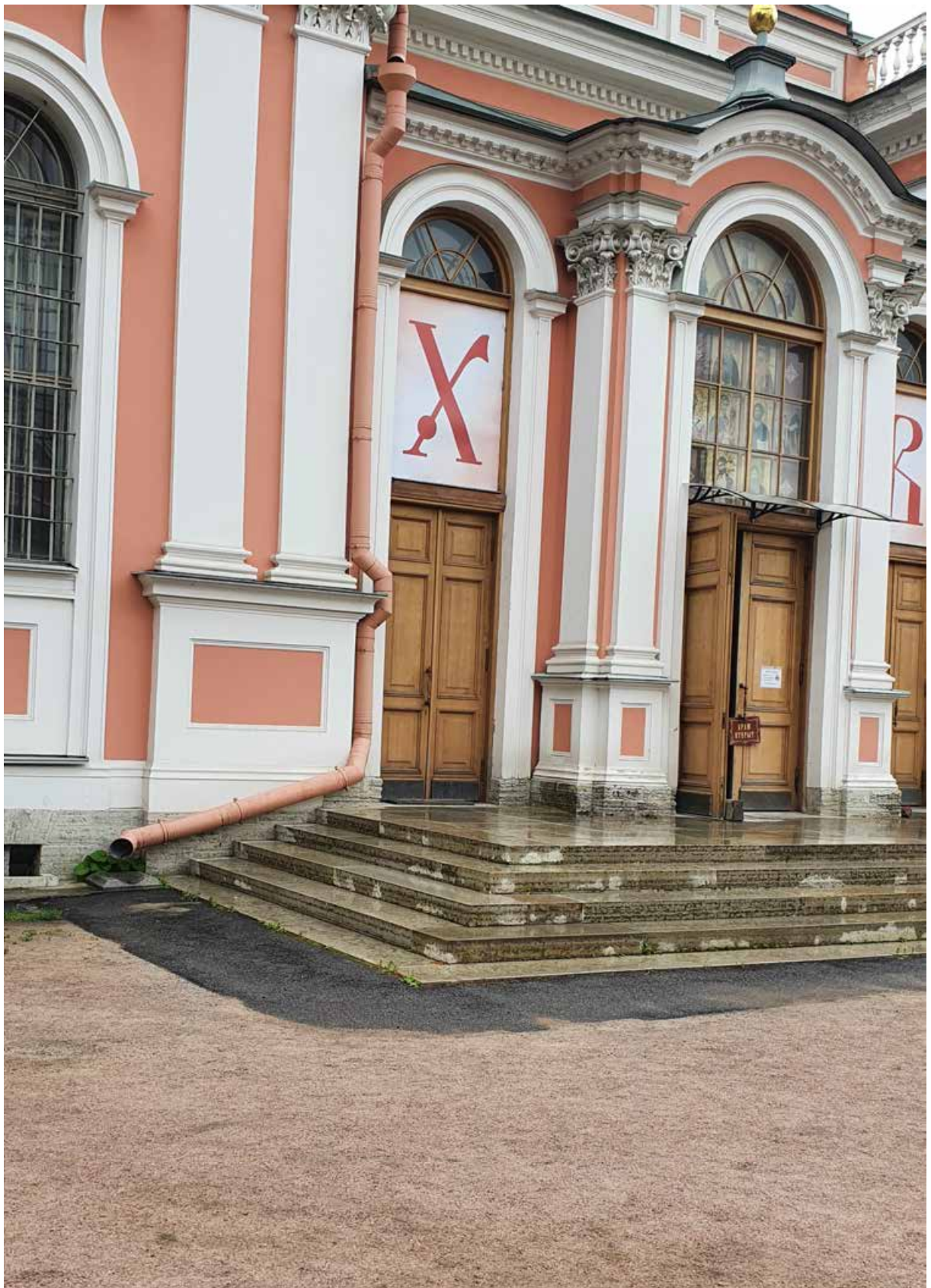
Фото 6. Фрагмент западного фасада.
