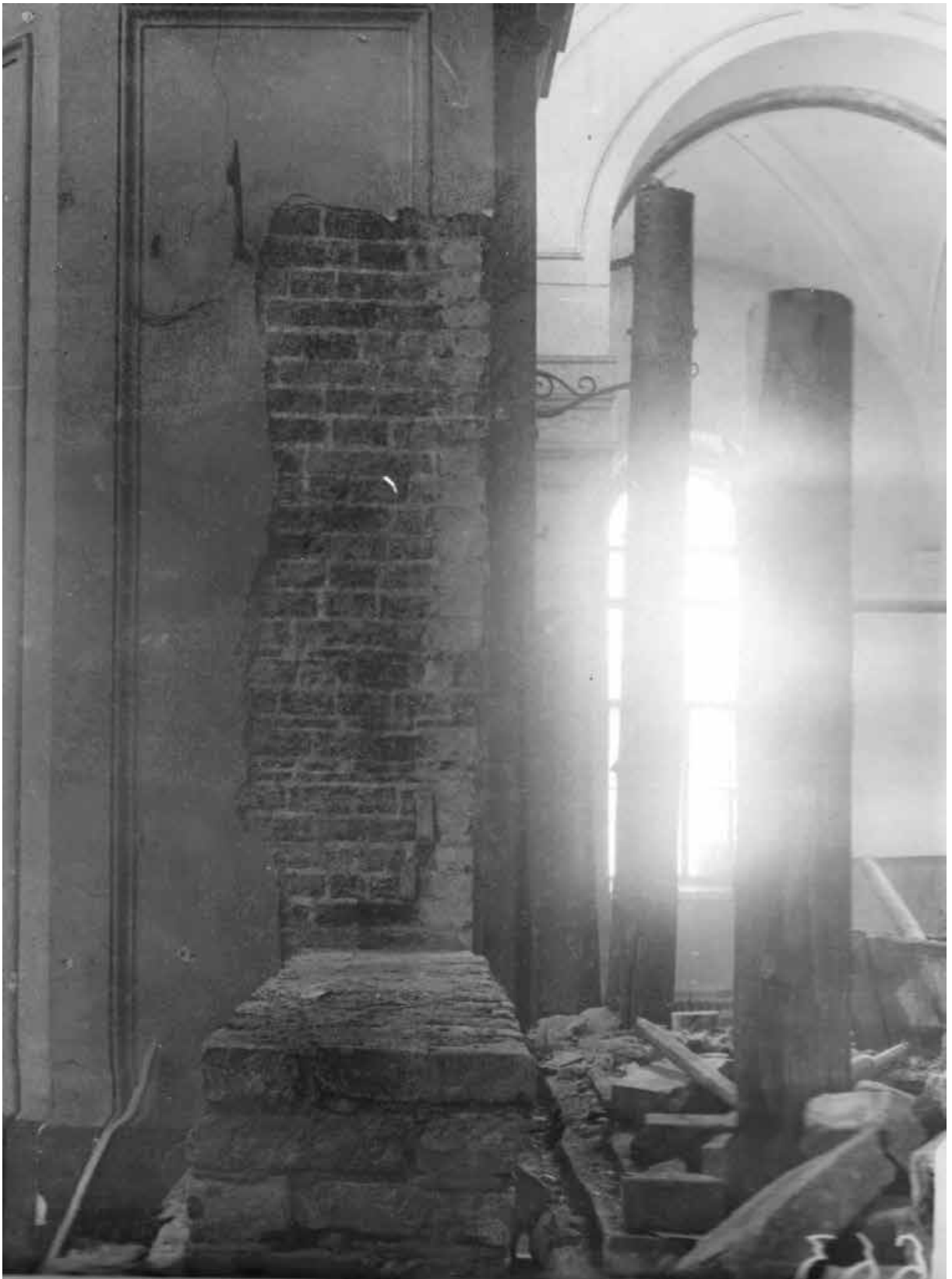
74. Крестовоздвиженская церковь. Фрагмент интерьера. 1940-е гг. (Материалы исторической справки, «Ленпроектреставрация», 1990 г.)
