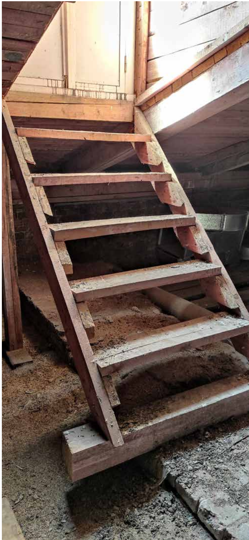
Фото 37. Выход на крышу.
