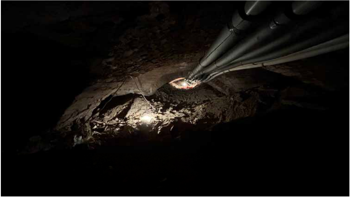
Фото13. Подвал. Вид на разгрузочную арку в центральной части собора.
