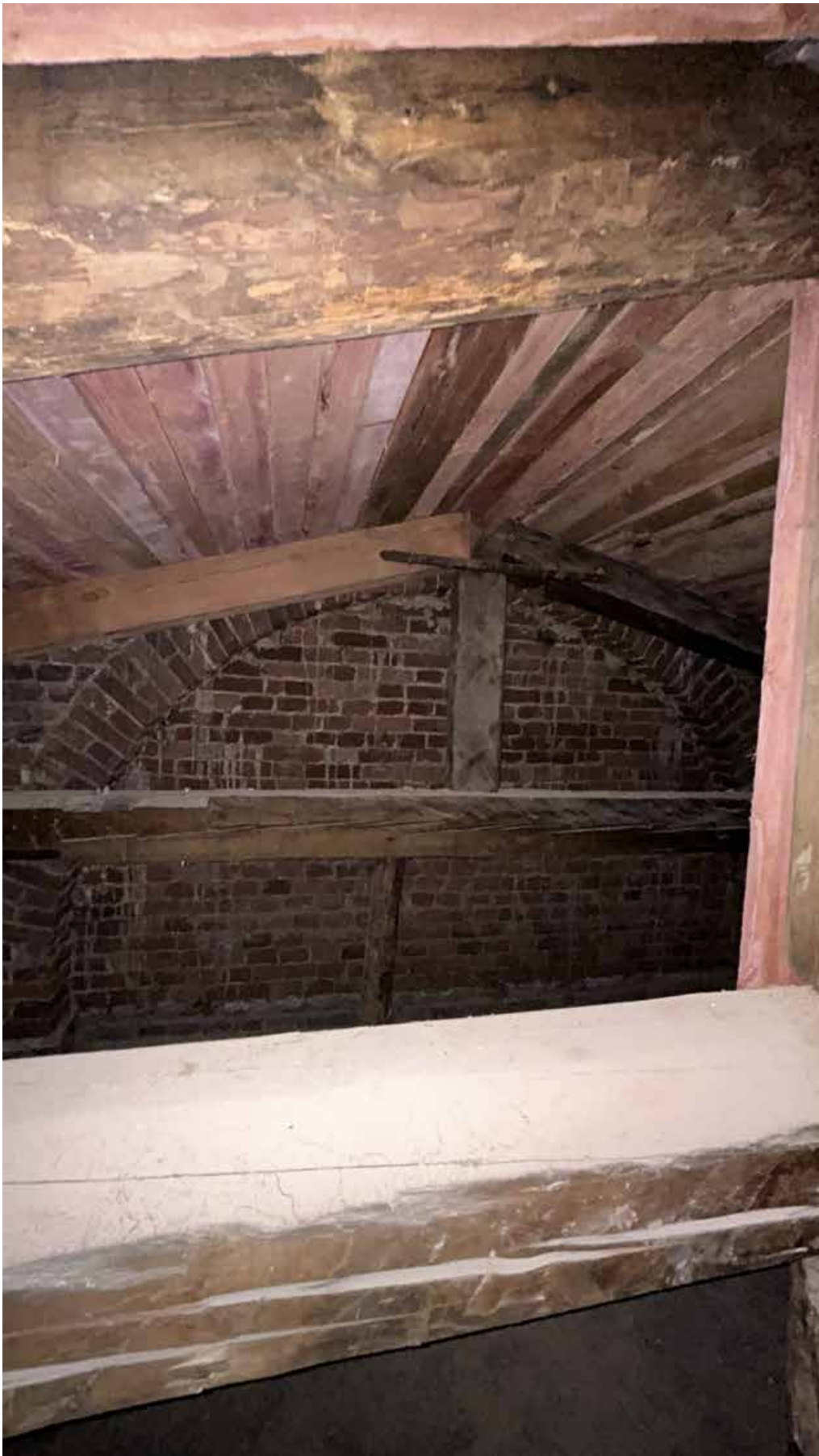
Фото 34. Подкровельное пространство. Фрагмент стропильной системы.
