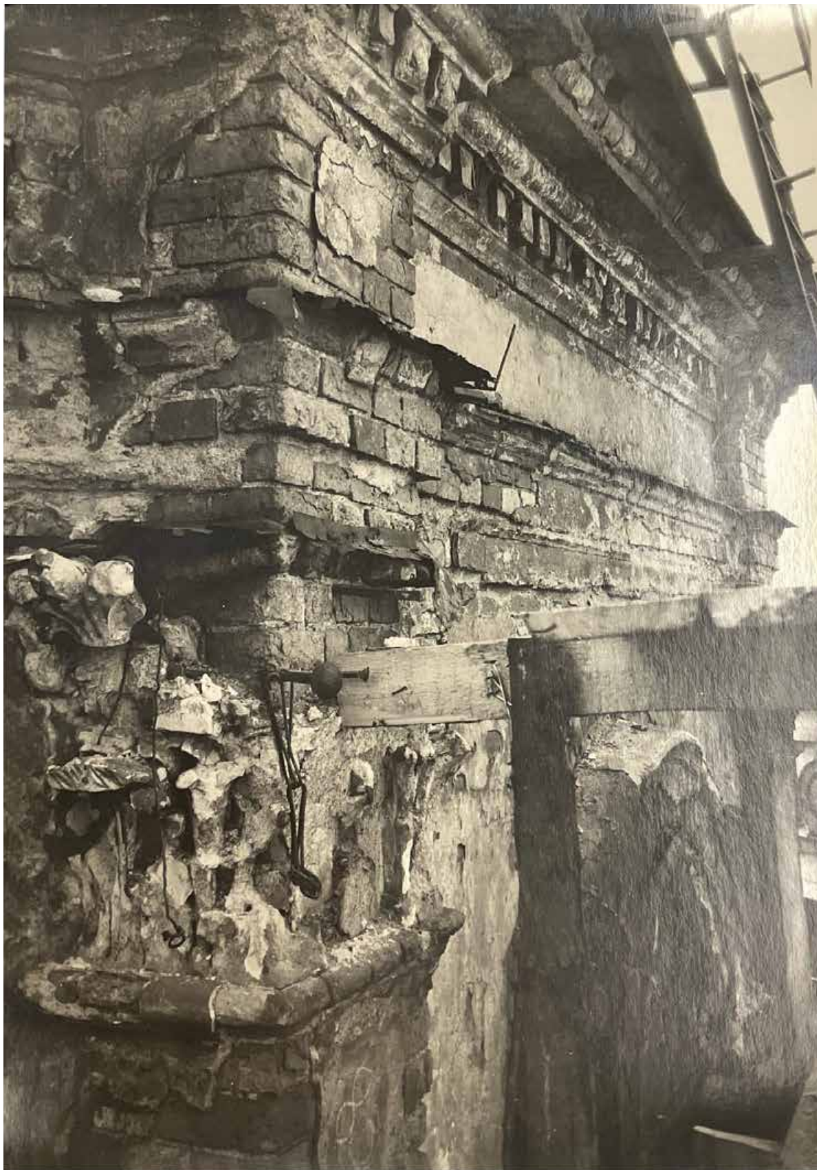
90. Предтеченская церковь. Деталь восьмигранник центральной главы Западная часть, до реставрации 1954 г. (ЦГАНДТ Р-488, Оп. 324, Д. 213, Л. 7. 1952-1967 г.)
