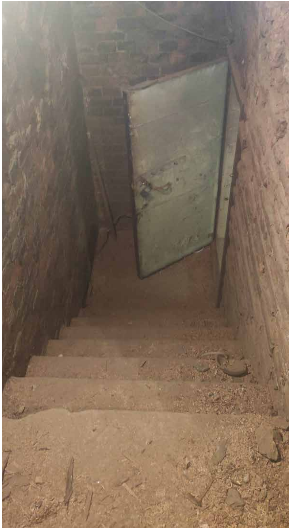
Фото 32. Лестница на чердак.
