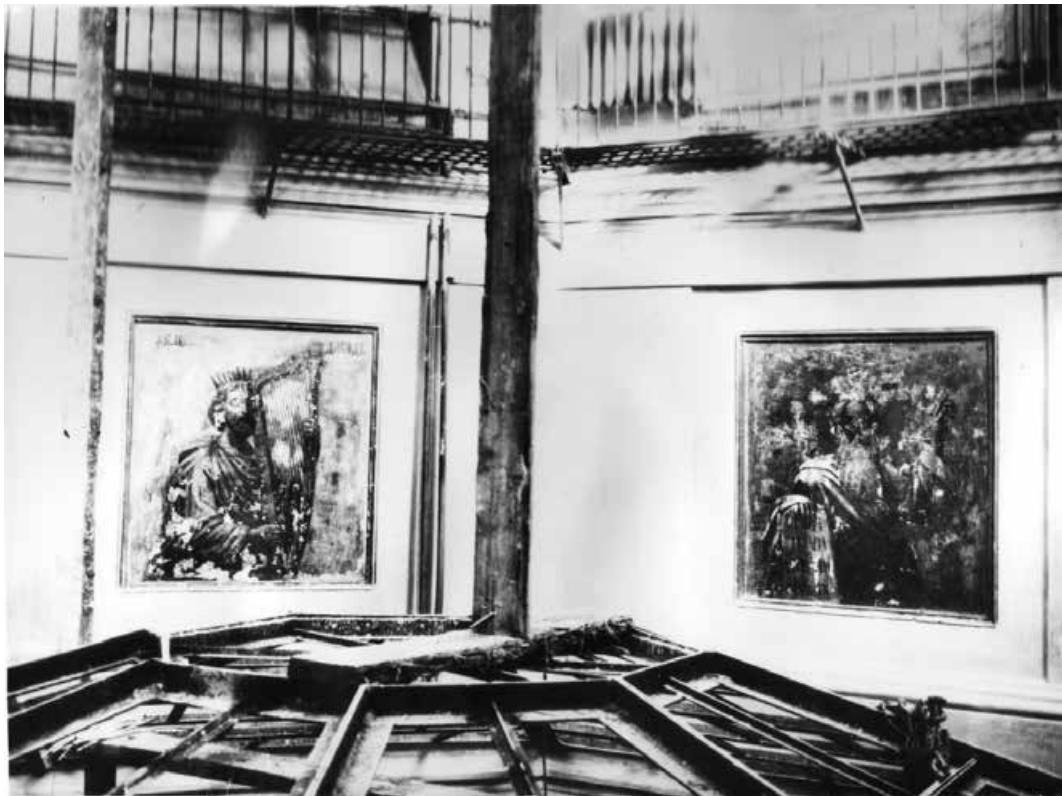
81. Пророки Давид и Моисей. Роспись в барабане центрального купола, обнаруженная под набелом во время ремонта. 1950 г. (Материалы исторической справки, «Ленпроектреставрация», 1990 г.)
