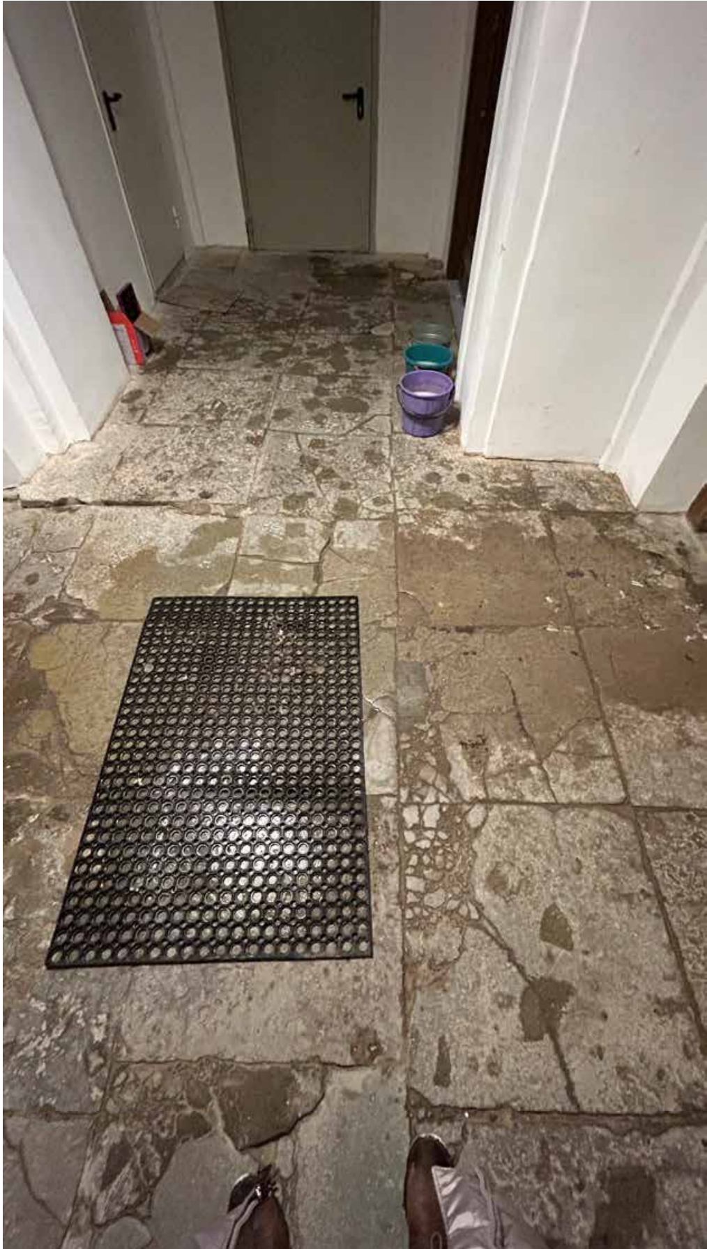
Фото 27. Напольное покрытие притвора собора.
