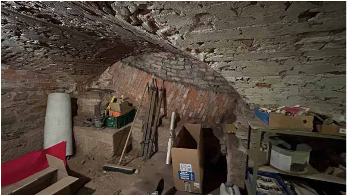
Фото 18. Подвал. Вид на разгрузочную арку в помещении мастерских.
