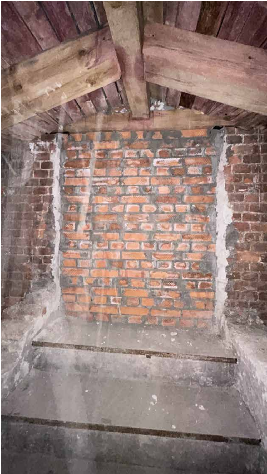
Фото 33. Подкровельное пространство. Фрагмент стропильной системы.
