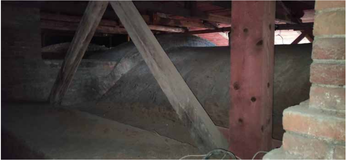
Фото 35. Подкровельное пространство. Вид на цилиндрический свод собора.
