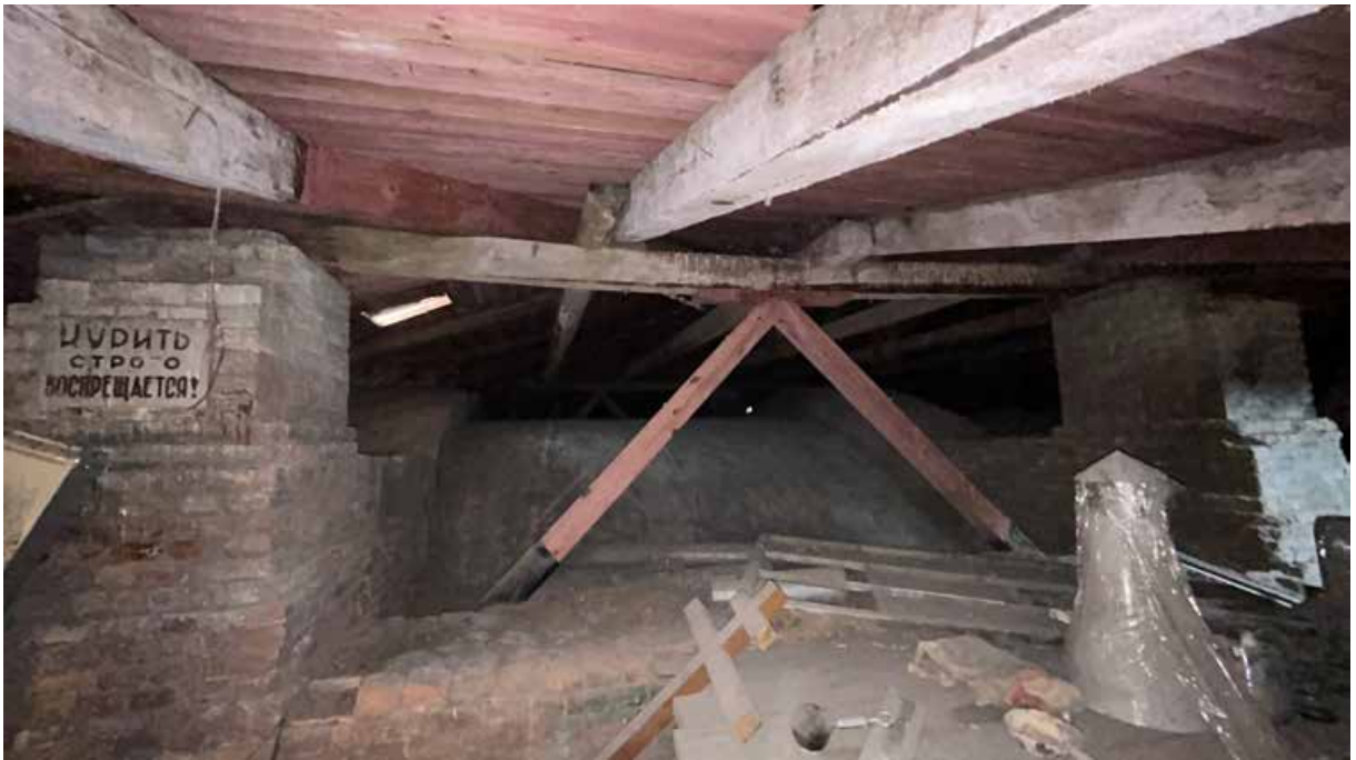
Фото 31. Подкровельное пространство. Фрагмент стропильной системы.
