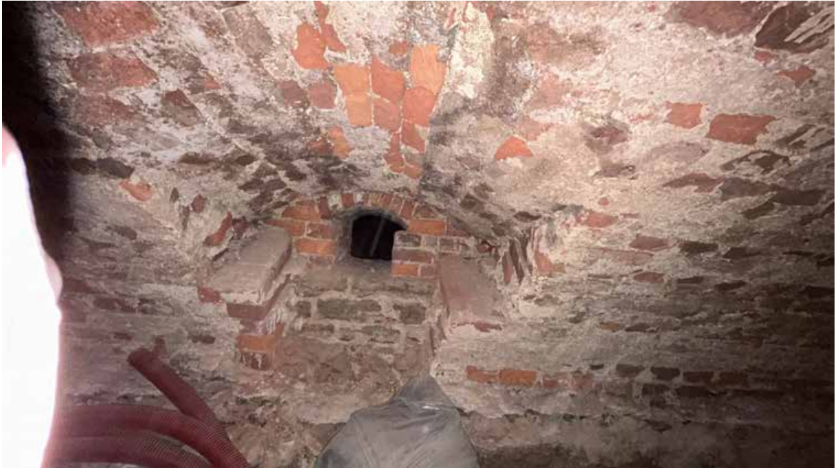
Фото15. Подвал. Вид на исторический оконный проем. Фрагмент северо-восточного фасада. Вход в подвал.
