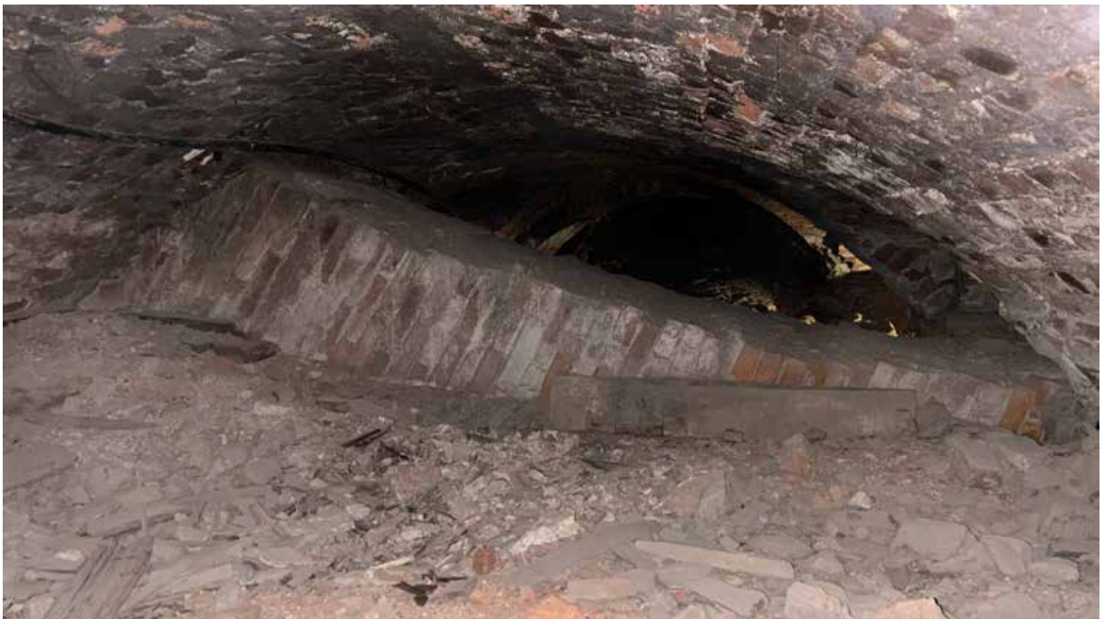
Фото 16. Подвал. Вид на разгрузочную арку в центральной части собора.
