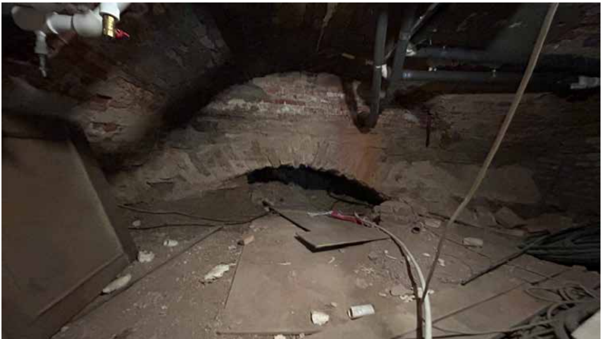
Фото 12. Подвал. Вид на цилиндрический свод центральной части собора.
