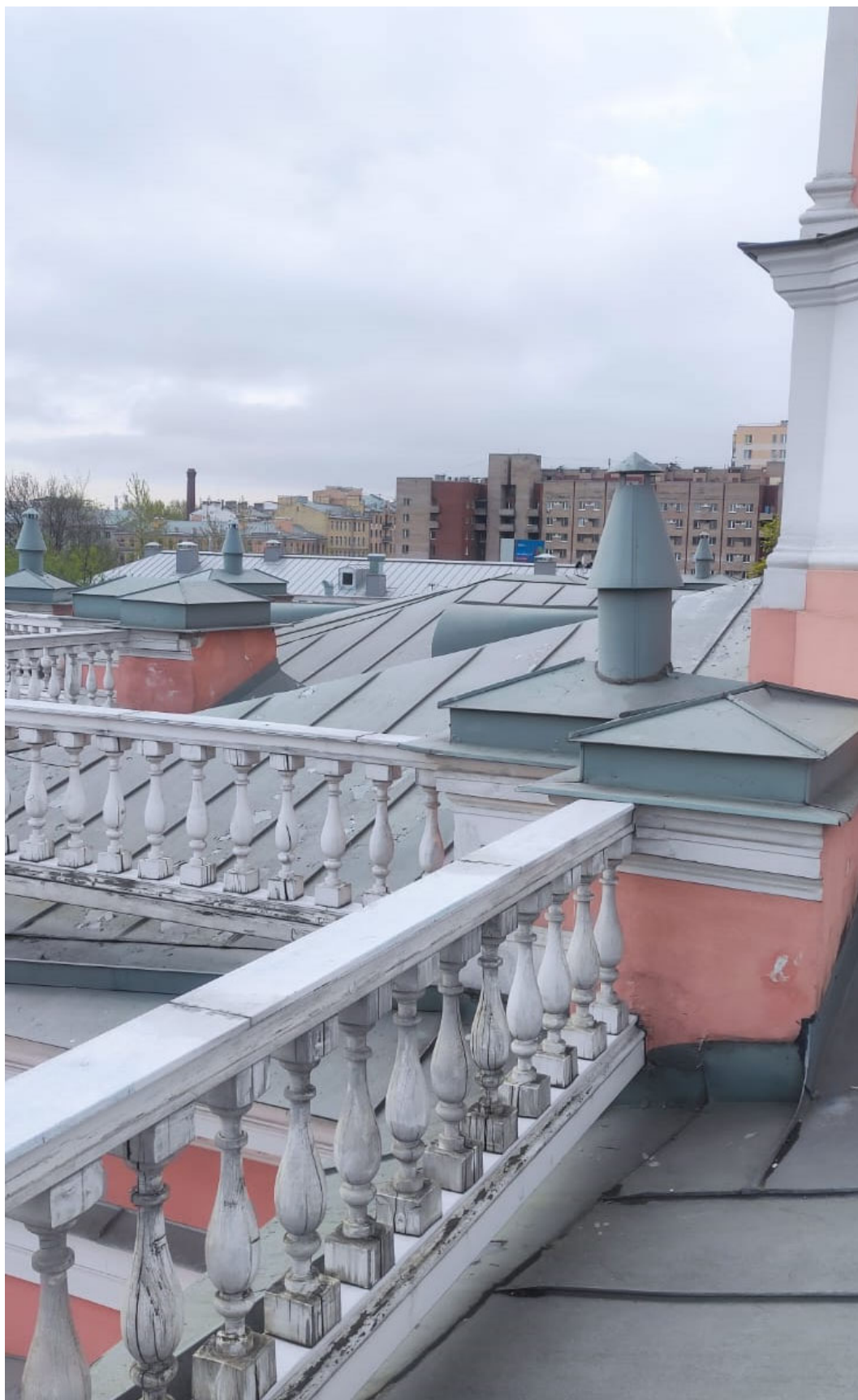
Фото 5. Вид с крыши собора.
