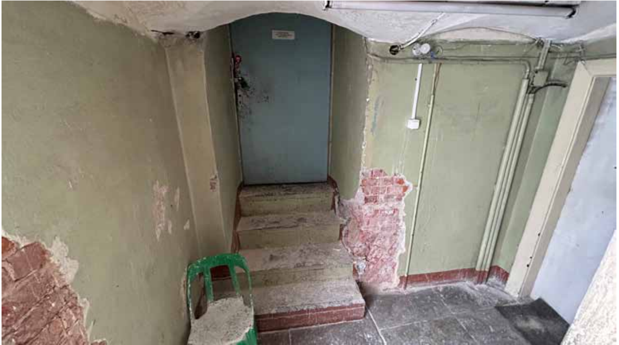
Фото 30. Вид на лестничную площадку.
