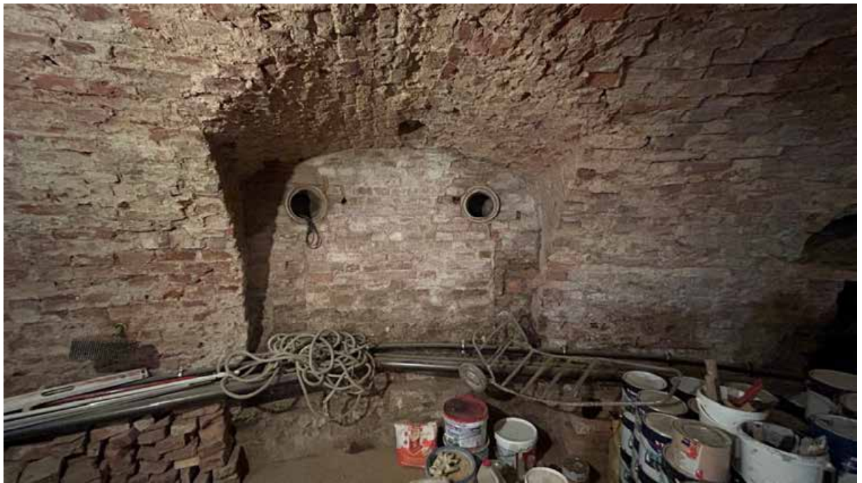
Фото 21. Подвал. Помещение под алтарной частью. Вид на керамические воздушные каналы.
