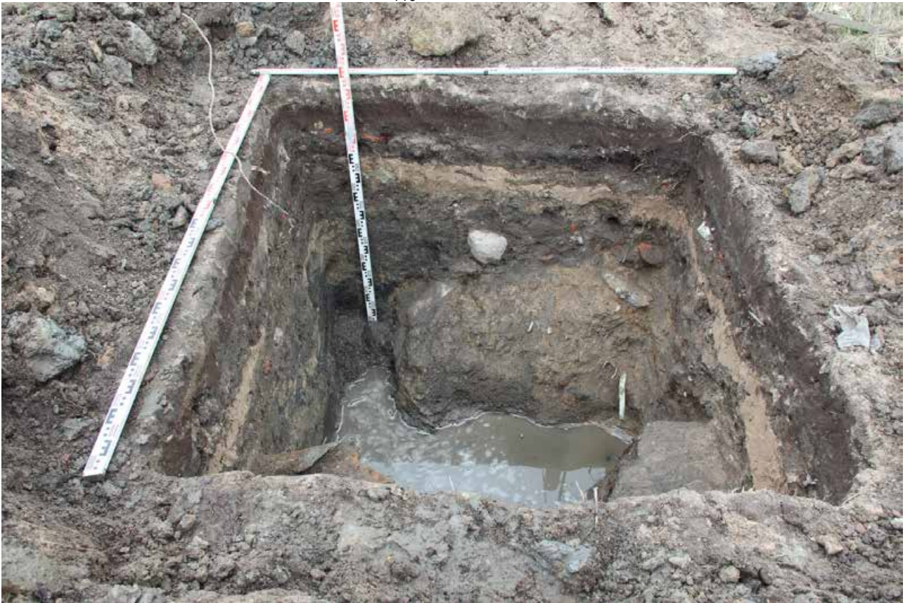
Рис. 52. Санкт-Петербург, Красносельский, Кировский районы. Маршала Казакова. Общий вид Шурфа 2. Вид на В.
