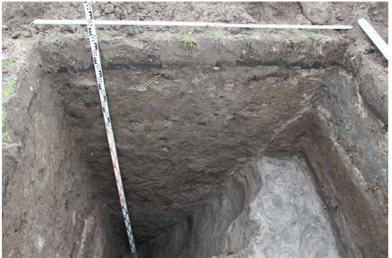
Рис. 35. Санкт-Петербург, Красносельский, Кировский районы. Маршала Казакова. Фиксация выбранной траншеи.
