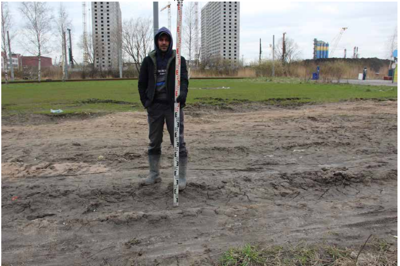
Рис. 48. Санкт-Петербург, Красносельский, Кировский районы. Маршала Казакова. Месторасположение Шурфа 2. До начала работ. Вид на С.
