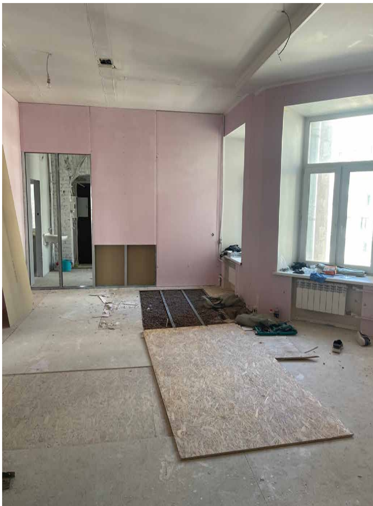
7. Фрагмент интерьера комнаты (помещение 7/22);
