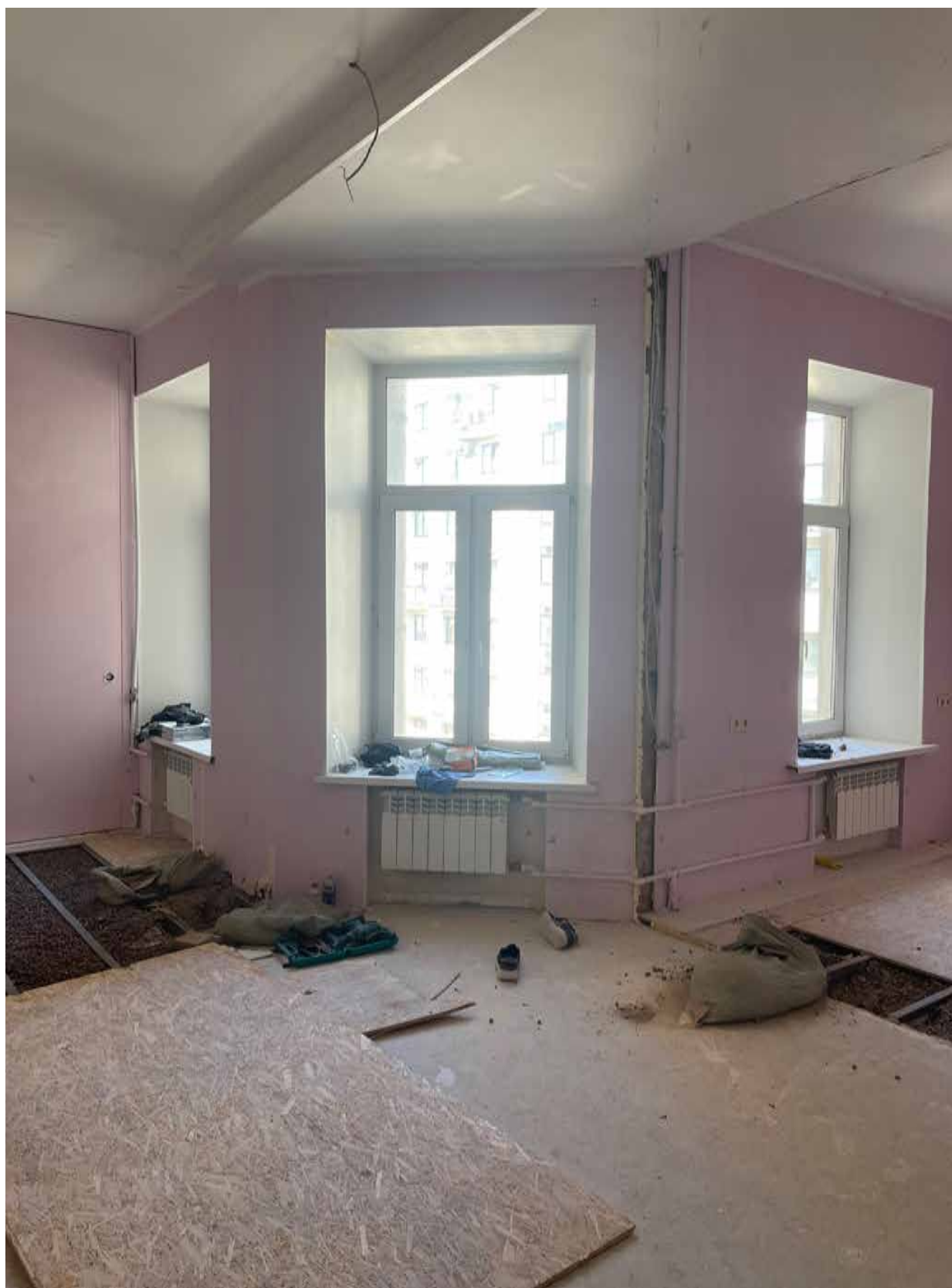
8. Фрагмент интерьера комнаты (помещение 7/22);
