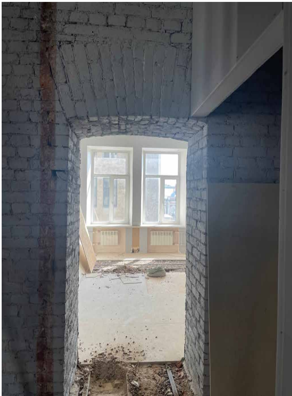
9. Фрагмент интерьера комнаты (помещение 8/19.6);
