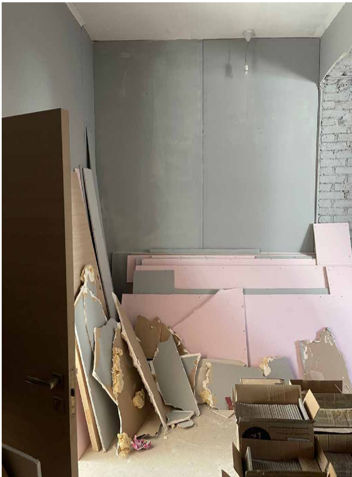
3. Фрагмент интеръера коридора (помещение 9/7.7);
