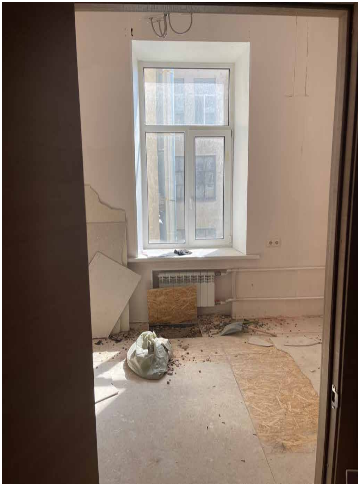
4. Фрагмент интерьера комнаты (помещение 10/11.9);
