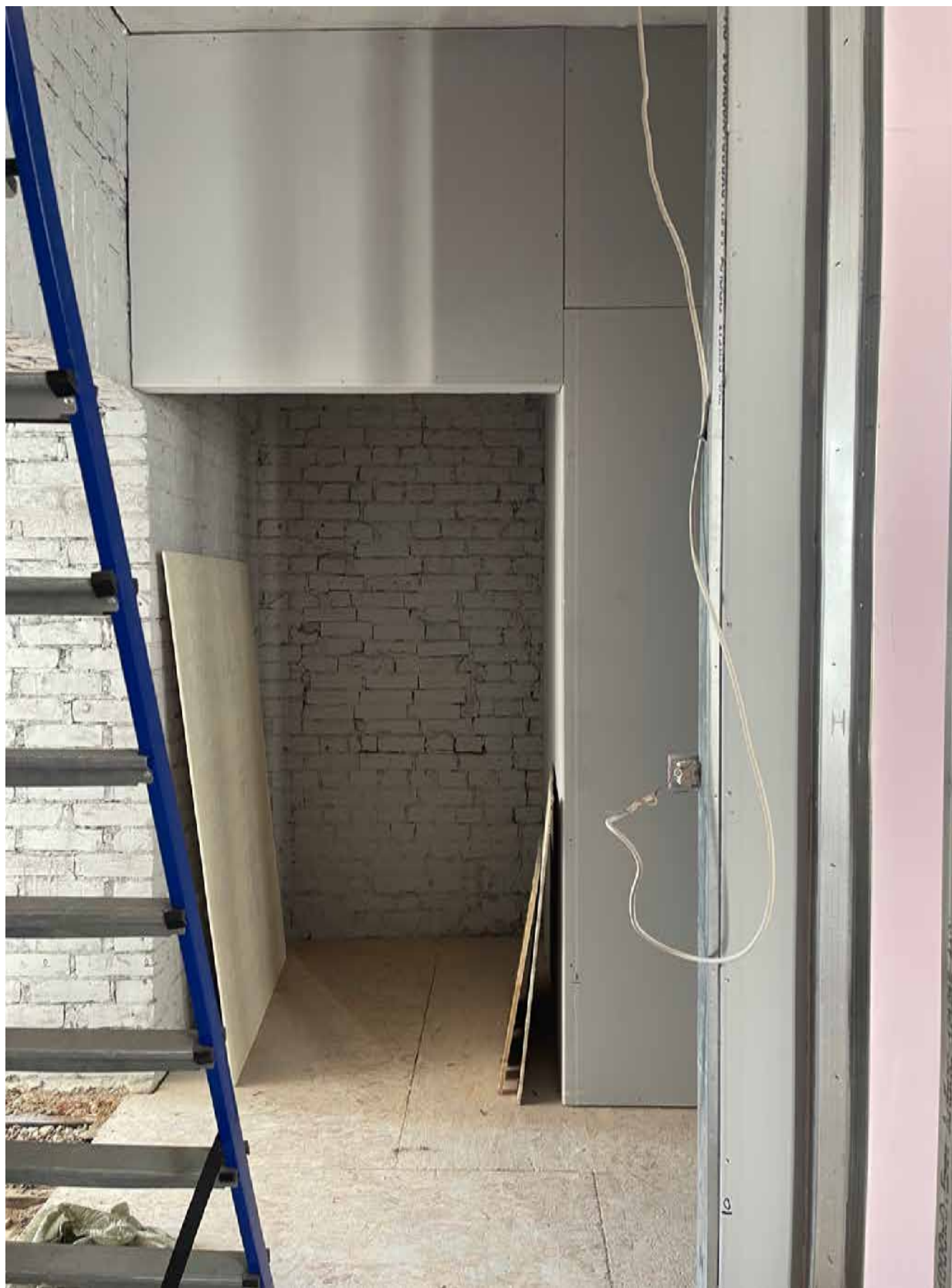
6. Фрагмент интерьера комнаты (помещение 11/14.7);
