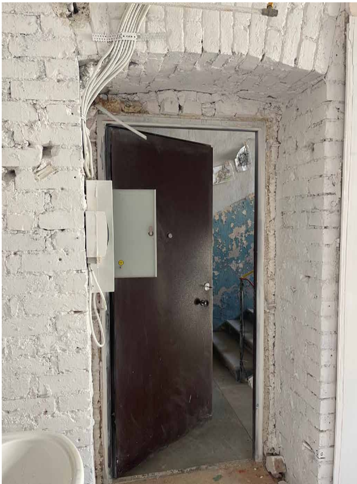
17. Вид на входную дверь в квартире;
