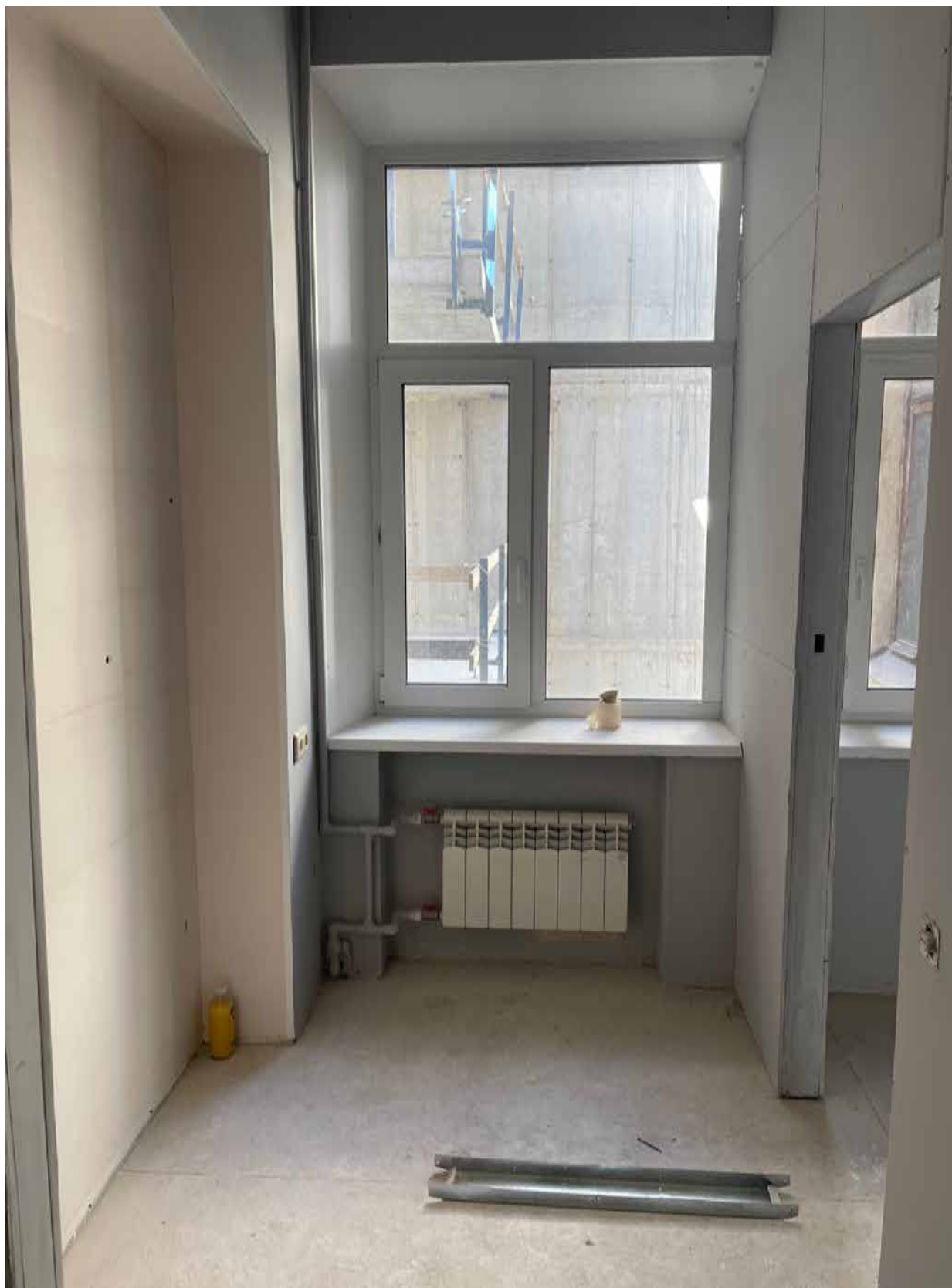
14.Фрагмент интерьера кладовой (помещение 3/5);
