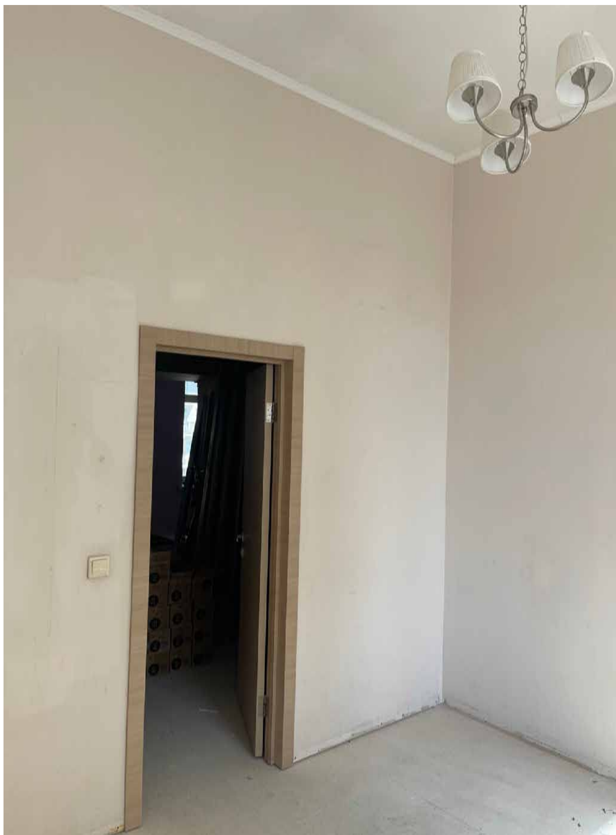
5. Фрагмент интерьера комнаты (помещение 10/11.9);
