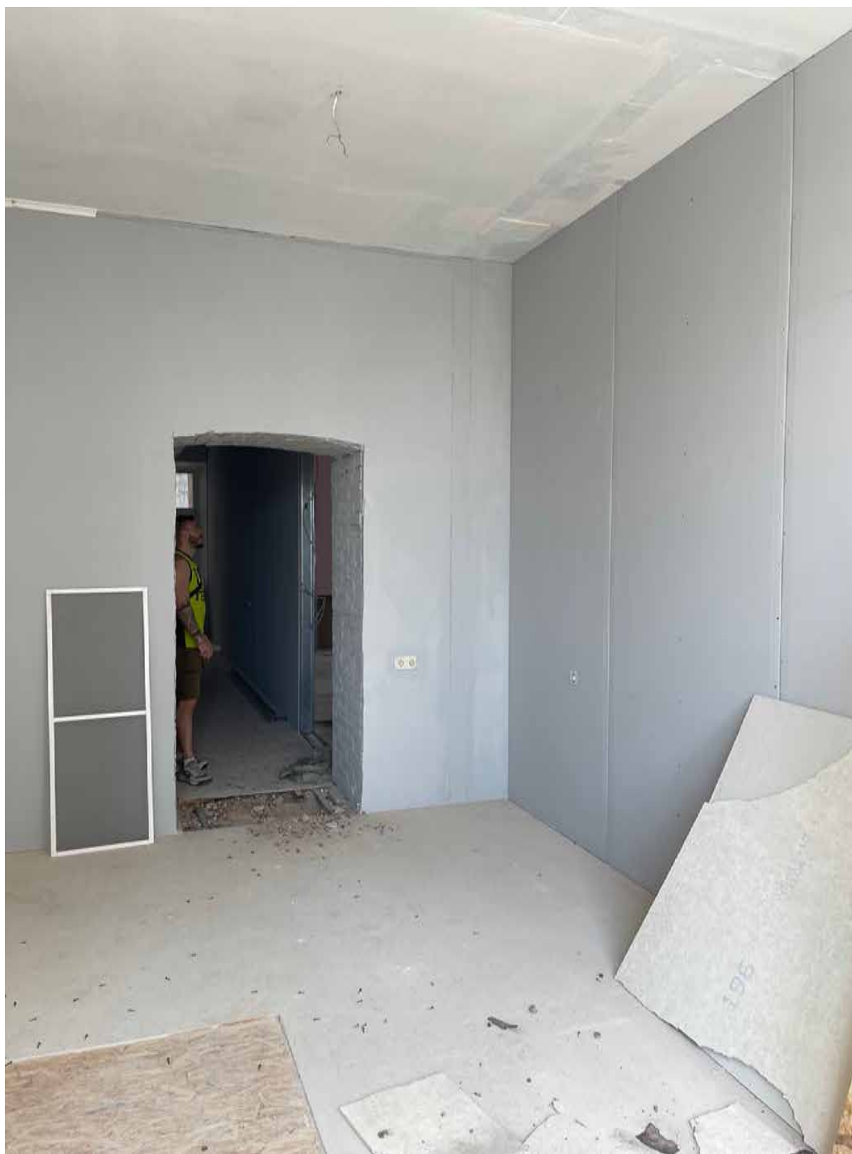
10.Фрагмент интерьера комнаты (помещение 8/19.6);
