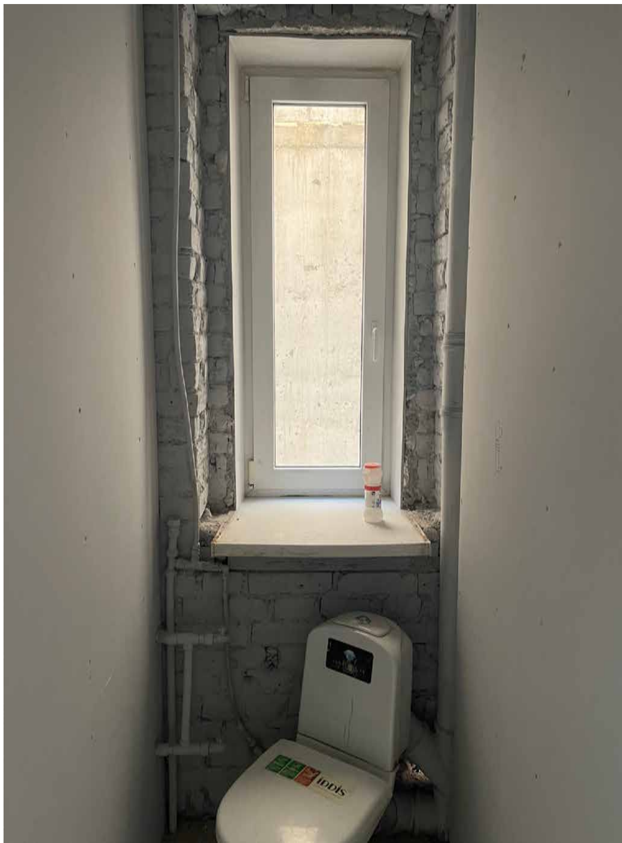
13.Фрагмент интеръера туалета (помещение 4/1.4);
