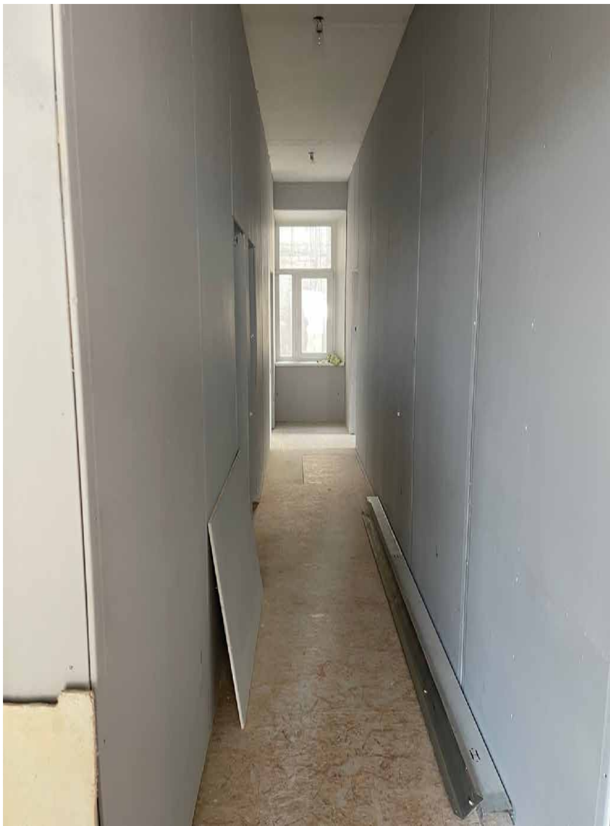
11.Фрагмент интеръера коридора (помещение 2/9.5);
