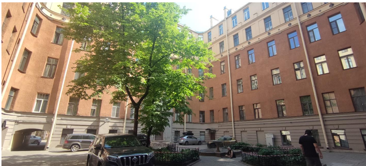
Фото 7. Дворовый фасад, фрагмент.
