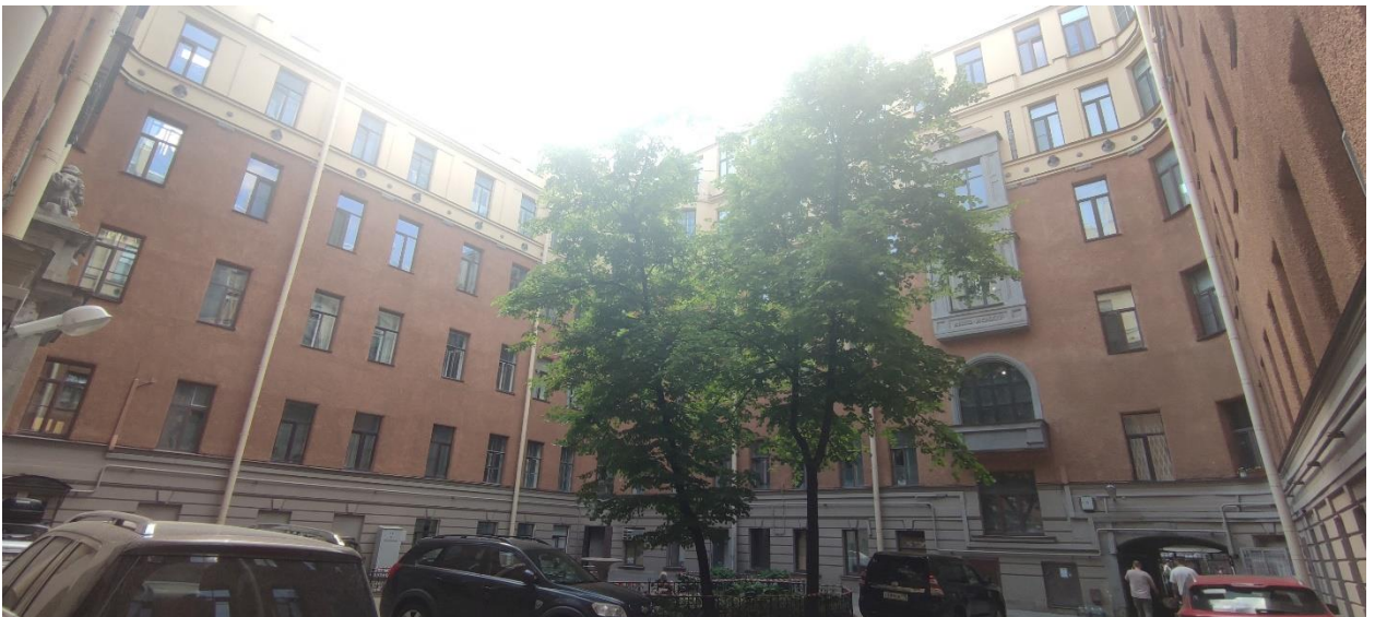
Фото 2. Дворовый фасад, фрагмент.
