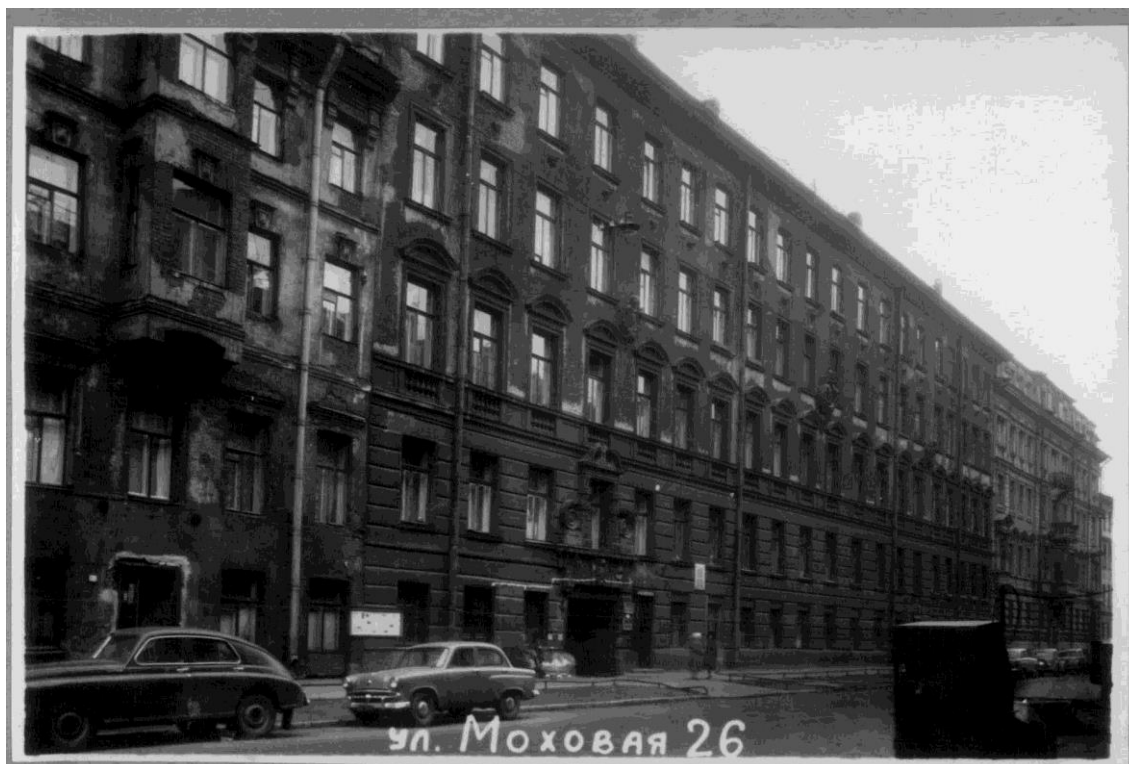
Илл. 15. Вид фасада дома №26 на Моховой улице. Дата съёмки 1960 г. Автор съёмки неизвестен. // ЦГАКФФД СПб. Фотодокумент Гр 75416.
