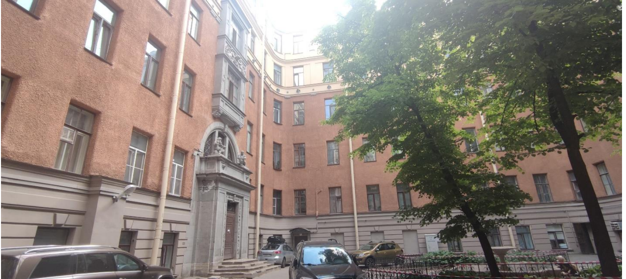
Фото 1. Дворовый фасад, фрагмент.
