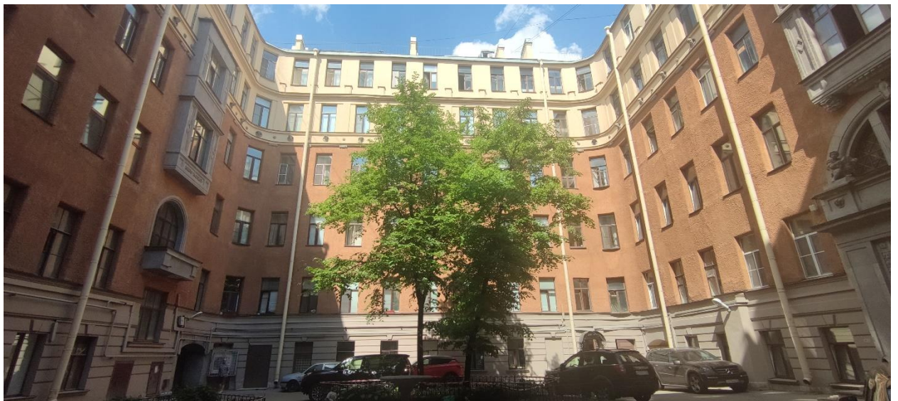
Фото 4. Дворовый фасад, фрагмент.
