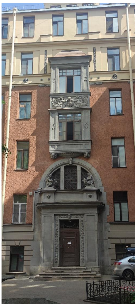
Фото 6. Дворовый фасад, фрагмент.
