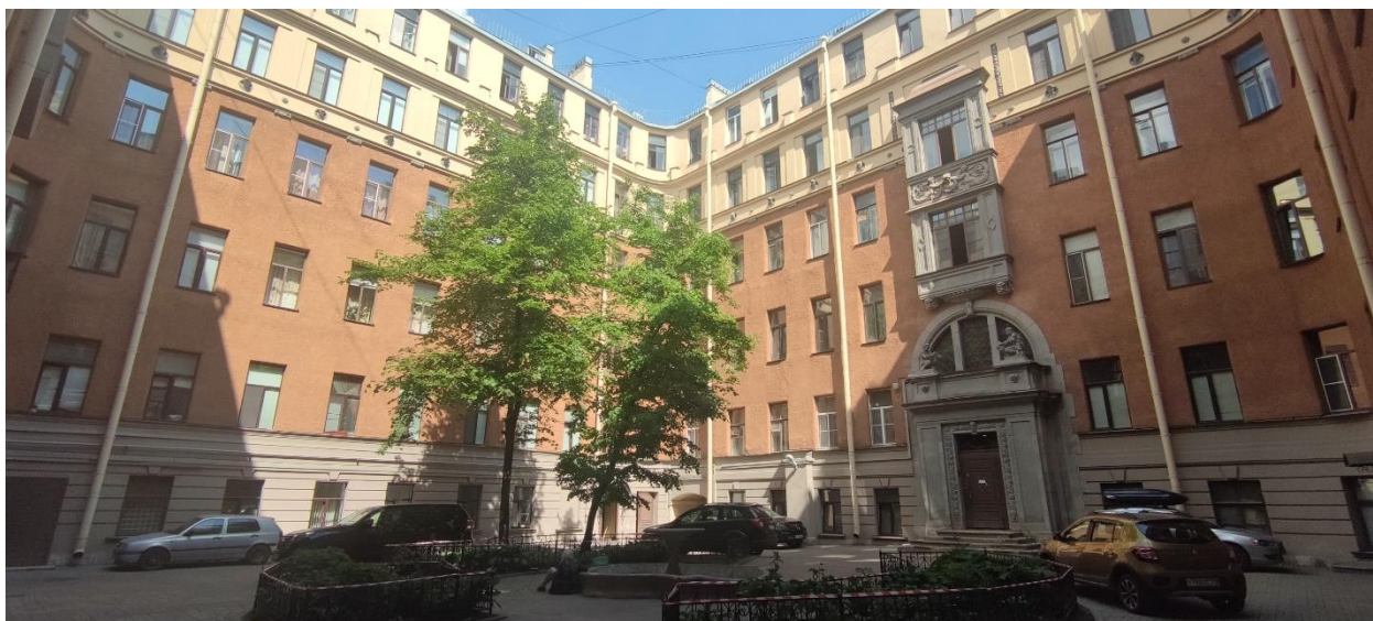
Фото 5. Дворовый фасад, фрагмент.
