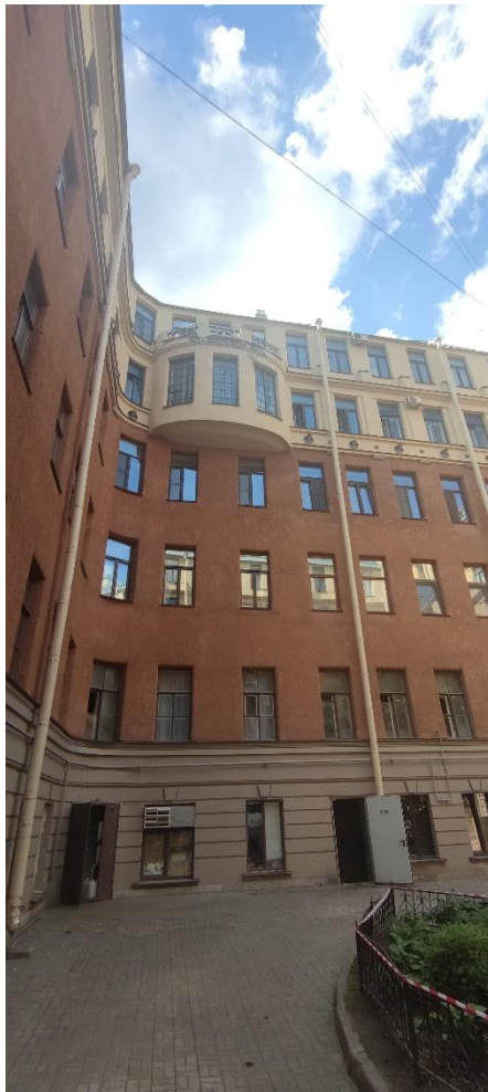
Фото 3. Дворовый фасад, фрагмент.
