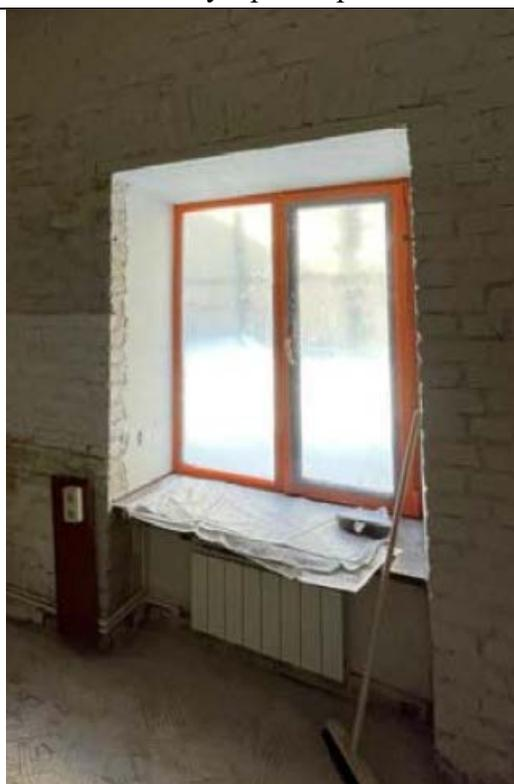
Подтверждение того, что оконный проем был устроен ранее в пом. 6 – наличие перемычки
