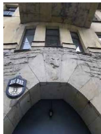
оконные проемы боковых ризалитов на уровне 1-го этажа, с трапециевидным завершением, исторической расстекловкой, в гладких обрамлениях известняковых плит, с архивольтом, декорированным рельефным каменным изображением совы;
