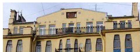
карниз с покрытием в на уровне оконных проемов 2-го этажа (прерываемый оконными проемами);
