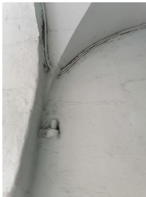
Фото 25. Фрагмент петли воротного проезда со стороны двора. «Дом А.Р. Гешвенда» по адресу: г. Санкт-Петербург, 9-я линия В.О., д.32, лит. А. 07.05.2024г.
