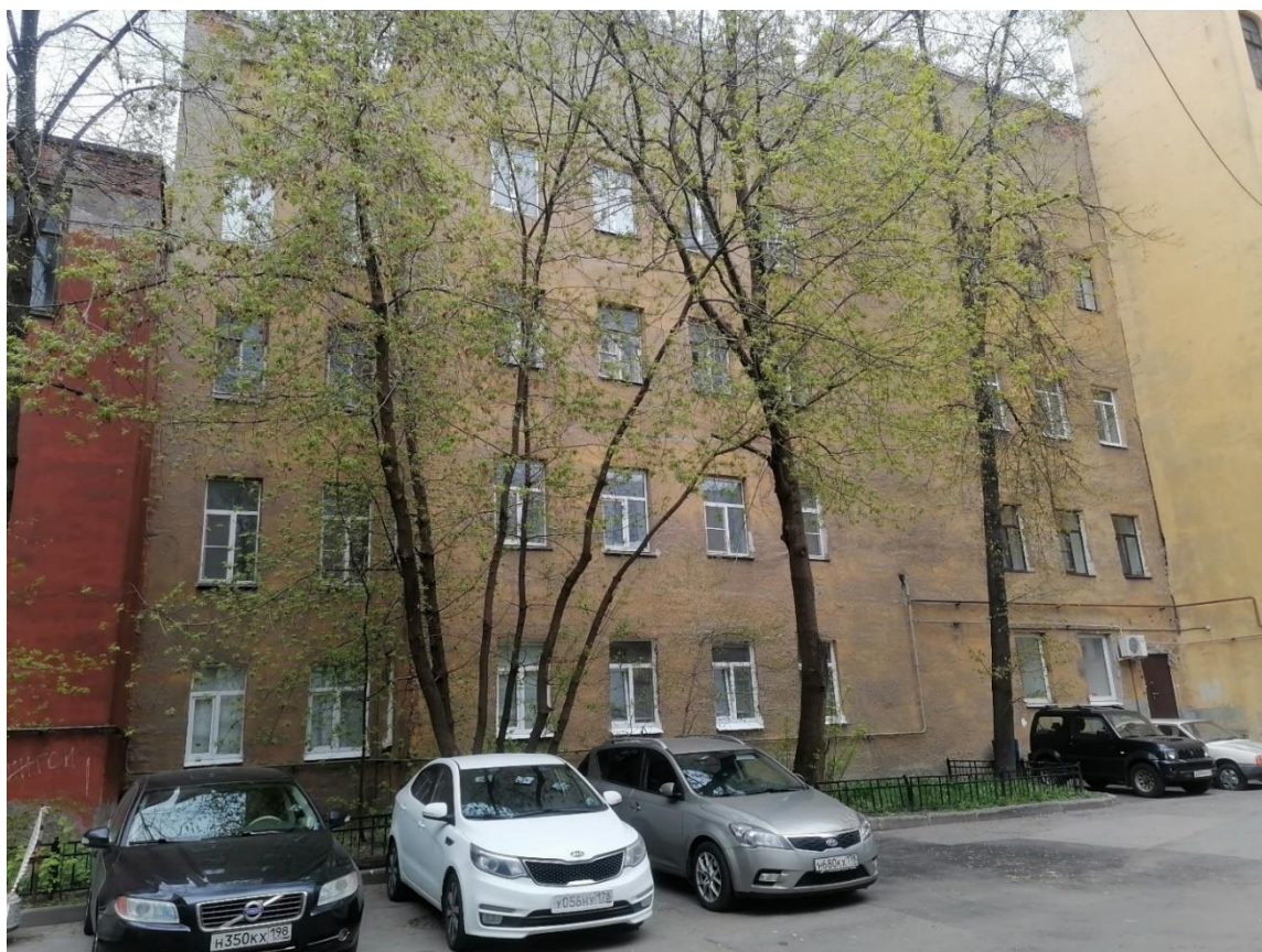
Фото 35. Общий вид дворового фасада южного флигеля со стороны дворовой территории дома №30 по 9-ой линии В.О. «Дом А.Р. Гешвенда» по адресу: г. Санкт-Петербург, 9-я линия В.О., д.32, лит. А. 07.05.2024г.
