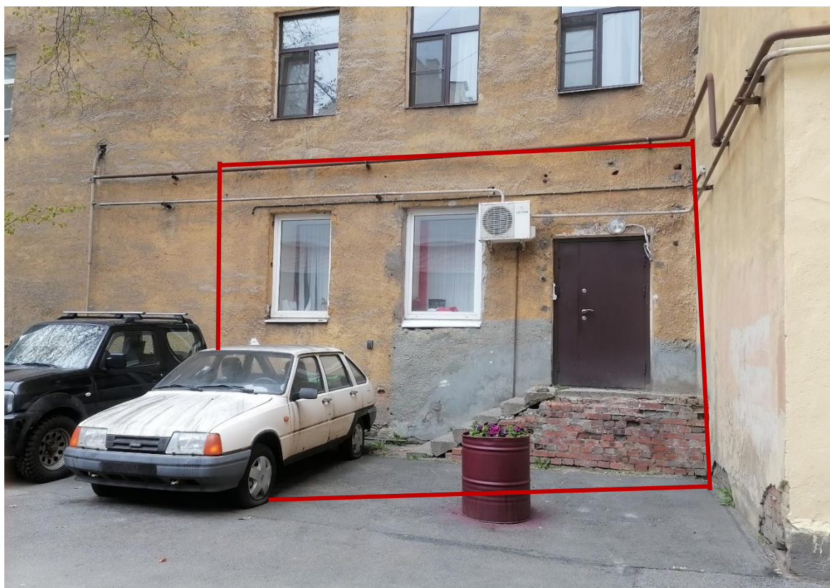
Фото 36. Вид 1-го этажа дворового фасада южного флигеля со стороны дворовой территории дома №30 по 9-ой линии В.О в границах помещения 1-Н. «Дом А.Р. Гешвенда» по адресу: г. Санкт-Петербург, 9-я линия В.О., д.32, лит. А. 07.05.2024г.
