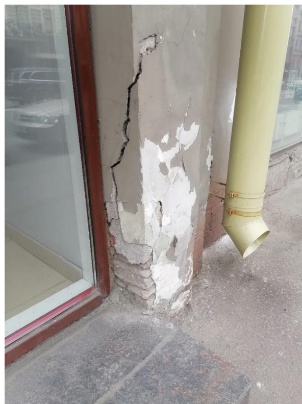
Фото 9,10. Состояние штукатурной отделки у входа со стороны лицевого фасада в помещении 1-Н. «Дом А.Р. Гешвенда» по адресу: г. Санкт-Петербург, 9-я линия В.О., д.32, лит. А. 07.05.2024г.
