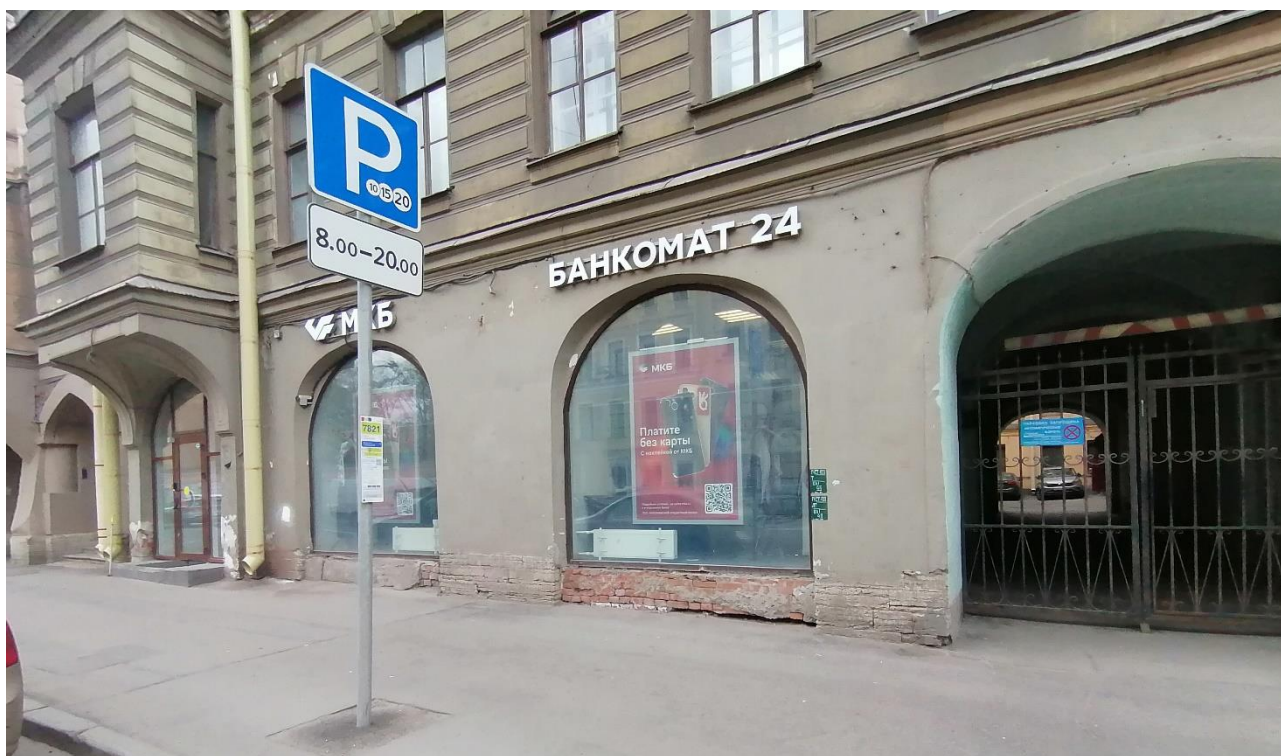
Фото 4. Вид 1-го этажа лицевого фасада со стороны воротного проезда в границах помещения 1-Н. «Дом А.Р. Гешвенда» по адресу: г. Санкт-Петербург, 9-я линия В.О., д.32, лит. А. 07.05.2024г.
