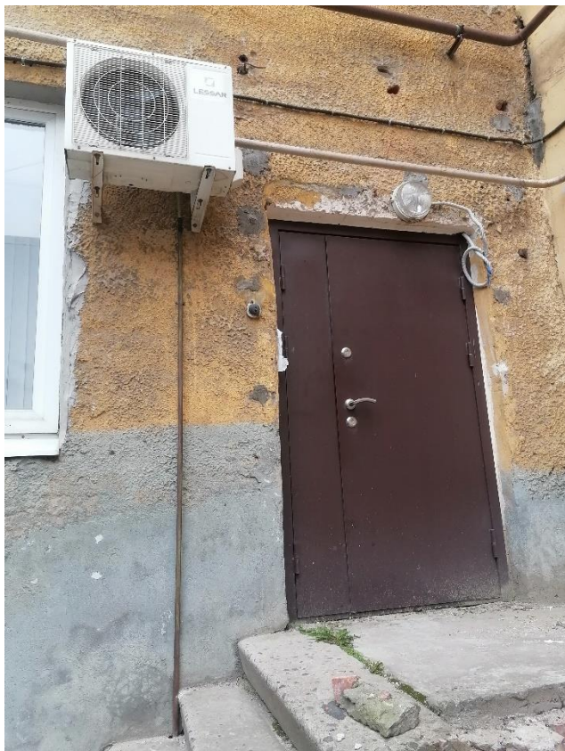
Фото 37. Служебный вход в помещение 1-Н со стороны дворовой территории дома №30 по 9-ой линии В.О. «Дом А.Р. Гешвенда» по адресу: г. Санкт-Петербург, 9-я линия В.О., д.32, лит. А. 07.05.2024г.
