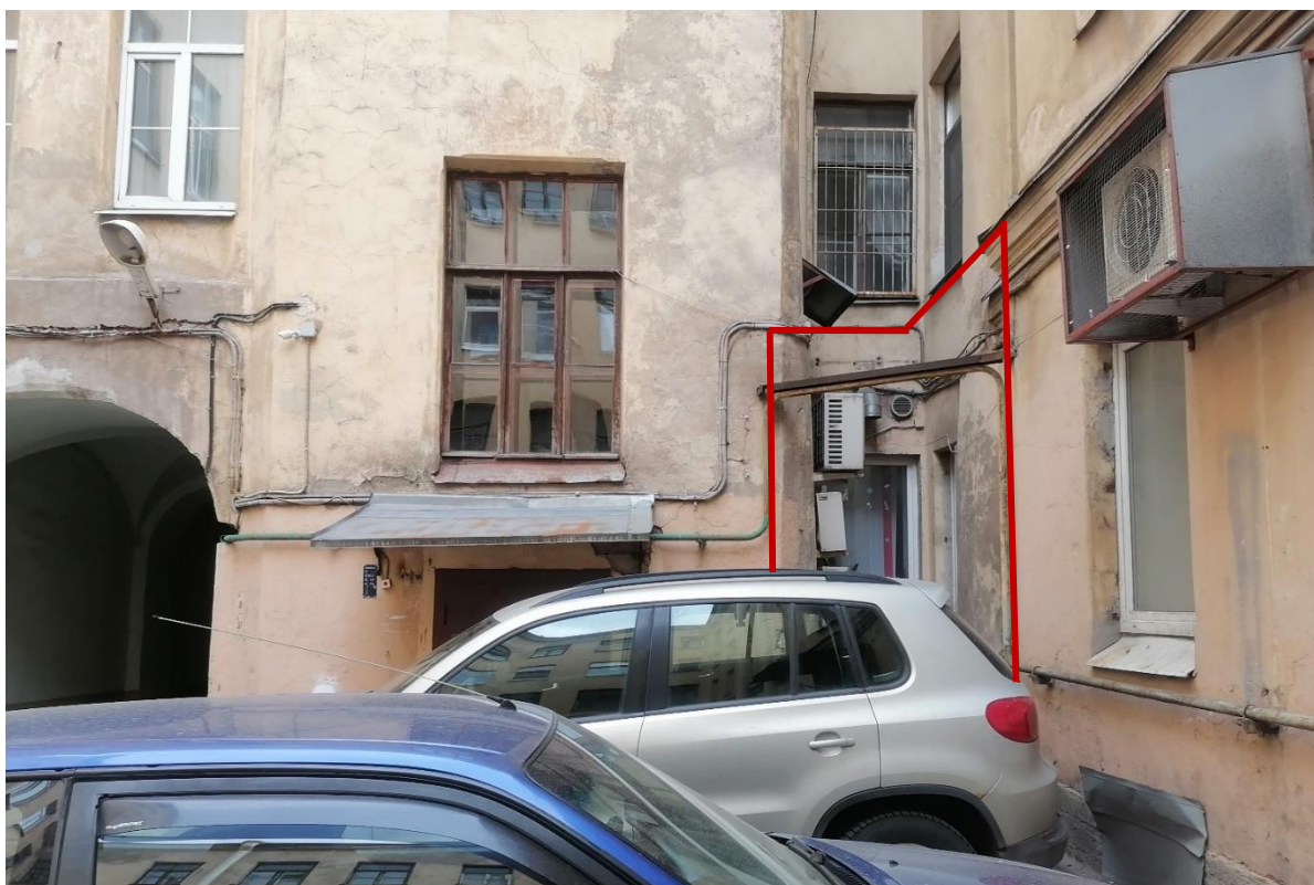
Фото 30. Вид дворового фасада главного корпуса в границах помещения 1-Н. «Дом А.Р. Гешвенда» по адресу: г. Санкт-Петербург, 9-я линия В.О., д.32, лит. А. 07.05.2024г.
