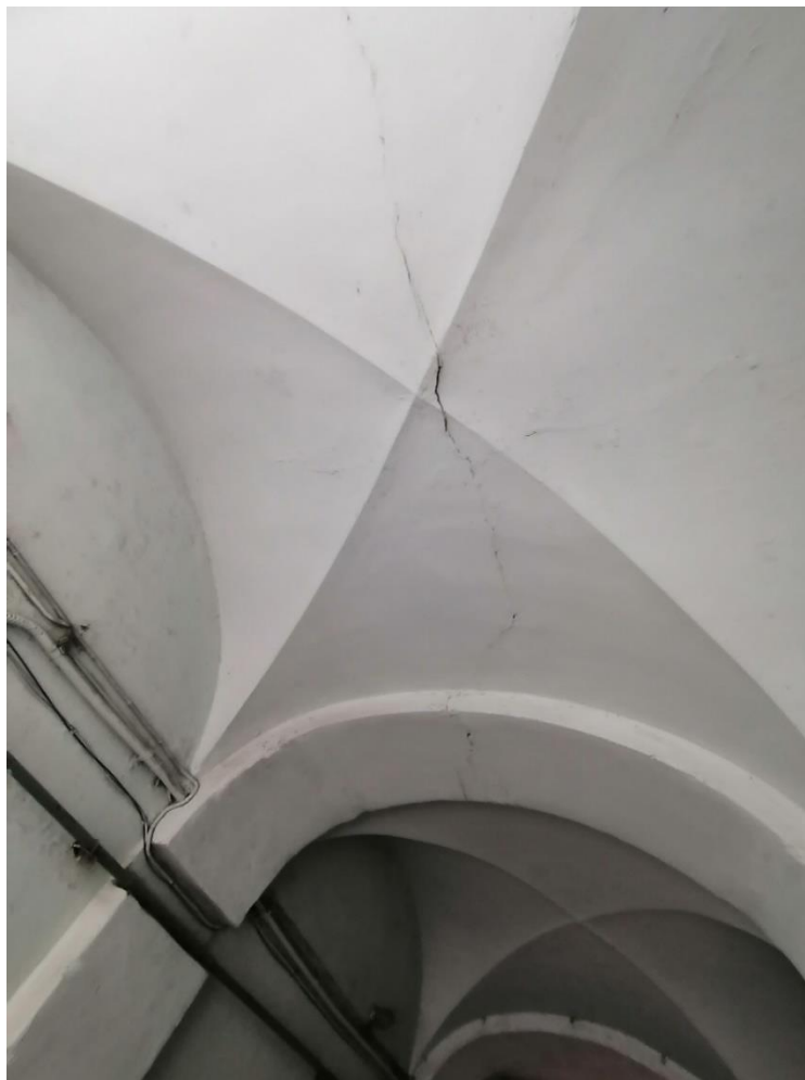
Фото 23. Трещины в сводах воротного проезда. «Дом А.Р. Гешвенда» по адресу: г. Санкт-Петербург, 9-я линия В.О., д.32, лит. А. 07.05.2024г.
