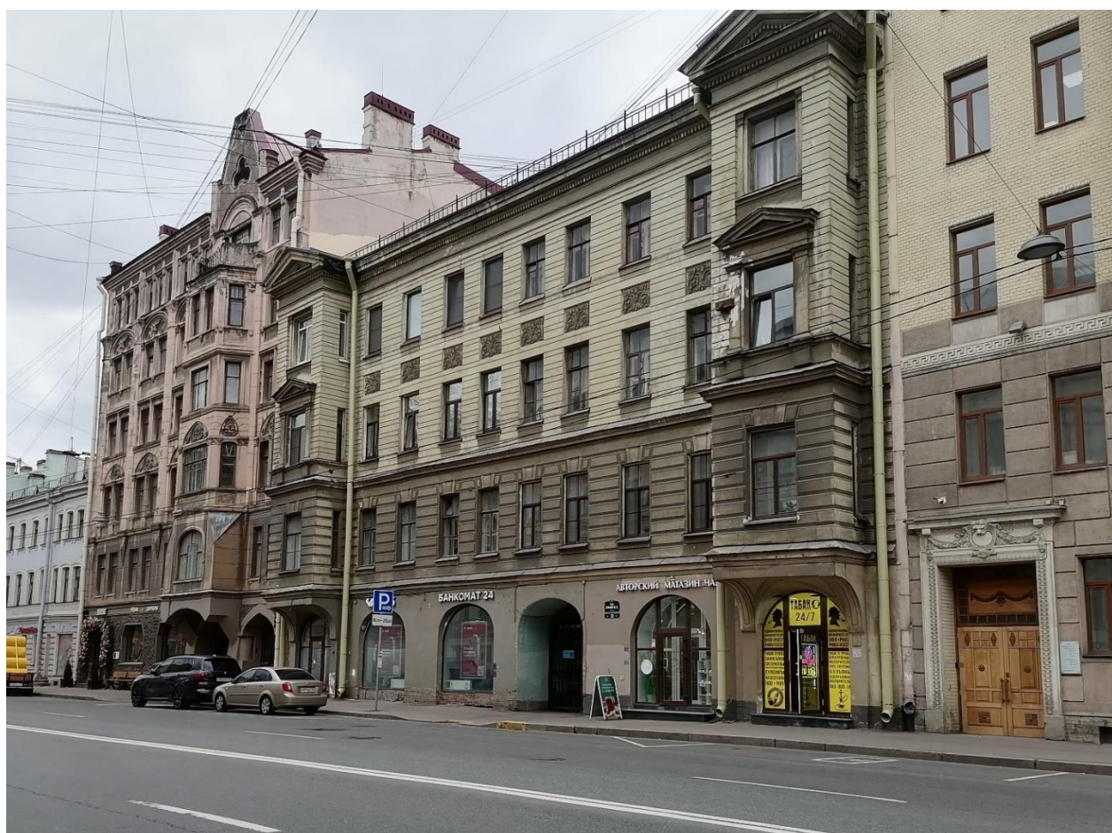
Фото 2. Общий вид лицевого фасада. «Дом А.Р. Гешвенда» по адресу: г. Санкт-Петербург, 9-я линия В.О., д.32, лит. А. 07.05.2024г.
