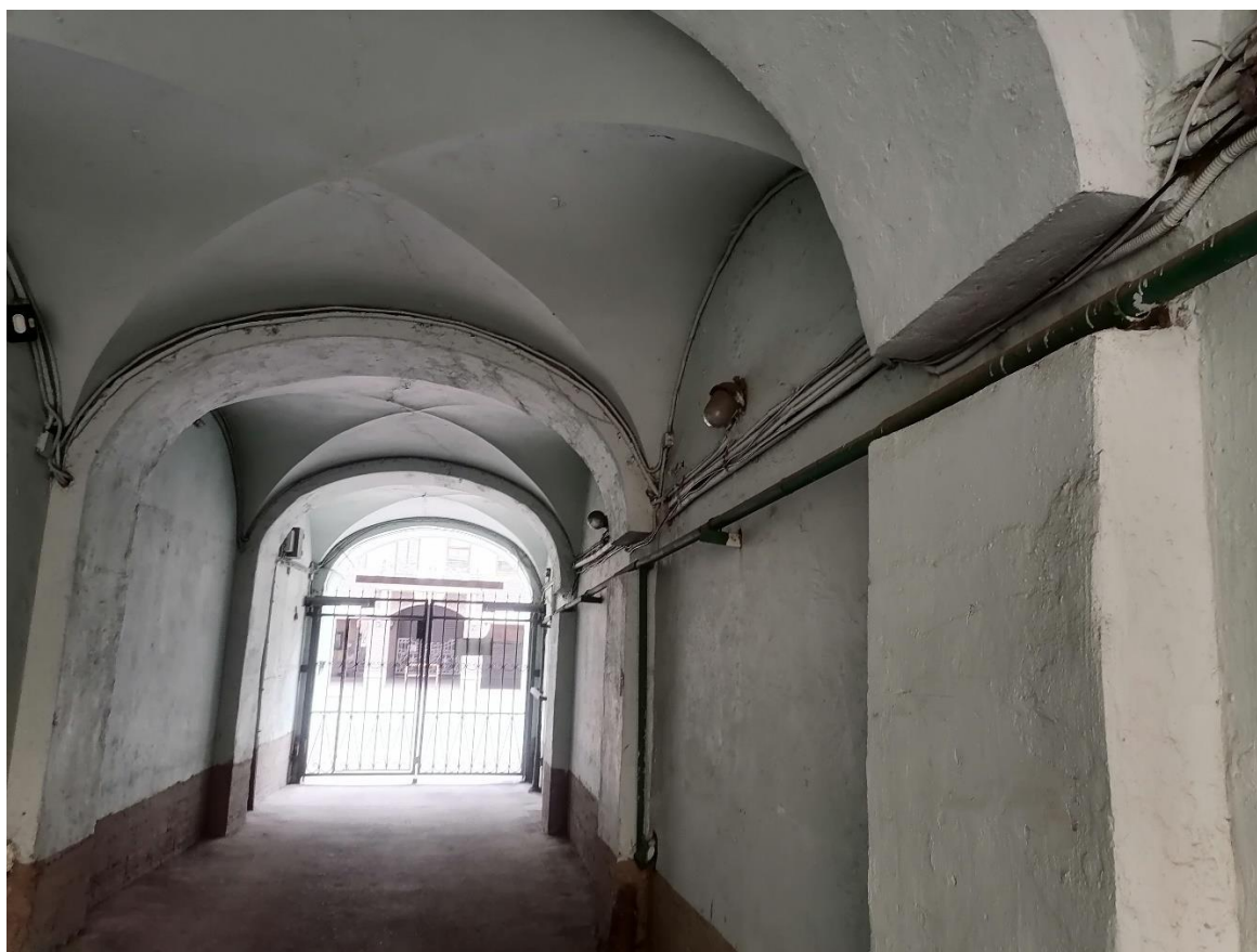
Фото 20. Вид на наружную стену помещения ЛК-1 и 1-Н со стороны воротного проезда. Имеются выемки в пятах свода для прокладки коммуникаций. «Дом А.Р. Гешвенда» по адресу: г. Санкт-Петербург, 9-я линия В.О., д.32, лит. А. 07.05.2024г.
