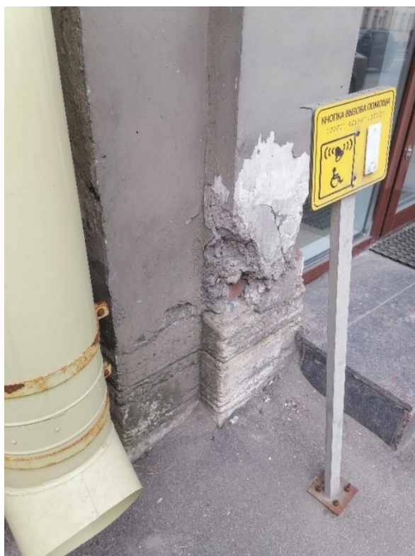
Фото 9,10. Состояние штукатурной отделки у входа со стороны лицевого фасада в помещении 1-Н. «Дом А.Р. Гешвенда» по адресу: г. Санкт-Петербург, 9-я линия В.О., д.32, лит. А. 07.05.2024г.
