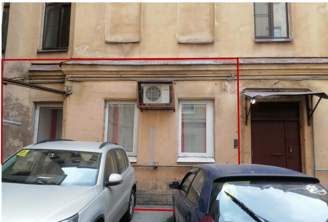
Фото 28. Вид дворового фасада южного флигеля в границах помещения 1-Н. «Дом А.Р. Гешвенда» по адресу: г. Санкт-Петербург, 9-я линия В.О., д.32, лит. А. 07.05.2024г.
