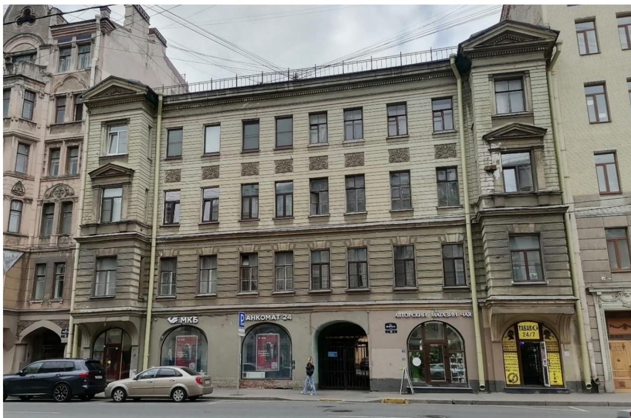
Фото 1. Общий вид лицевого фасада. «Дом А.Р. Гешвенда» по адресу: г. Санкт-Петербург, 9-я линия В.О., д.32, лит. А. 07.05.2024г.
