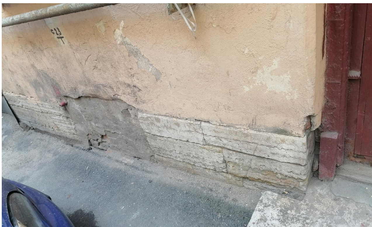
Фото 29. Вид цоколя 1-го этажа дворового фасада южного флигеля в границах помещения 1-Н. «Дом А.Р. Гешвенда» по адресу: г. Санкт-Петербург, 9-я линия В.О., д.32, лит. А. 07.05.2024г.
