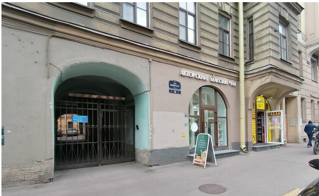
Фото 5. Вид 1-го этажа лицевого фасада северной части от воротного проезда. «Дом А.Р. Гешвенда» по адресу: г. Санкт-Петербург, 9-я линия В.О., д.32, лит. А. 07.05.2024г.
