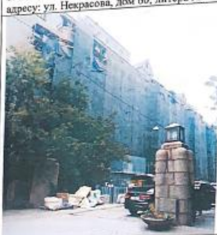
3. Общий вид. Северный фасад здания по адресу: ул. Некрасова, дом 60, литера А.
