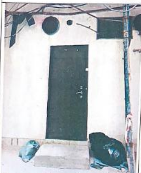
11. Фрагмент. Восточный дворовой фасад здания по адресу: ул. Некрасова, дом 60, литера А. Дверь в Помещение.
