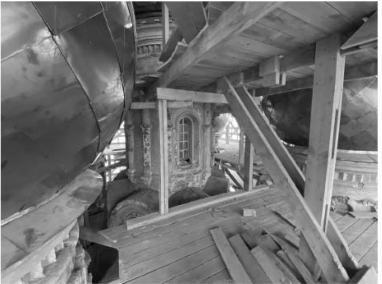
Фото 71. Фрагмент фасада барабана. Заполнение оконного проема.
