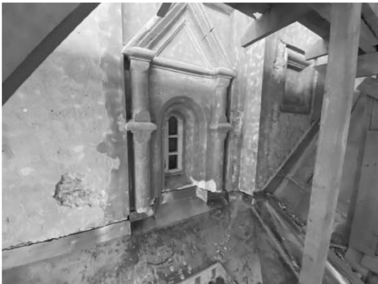
Фото 61. Фрагмент западного фасада колокольни. Заполнение оконного проема.
