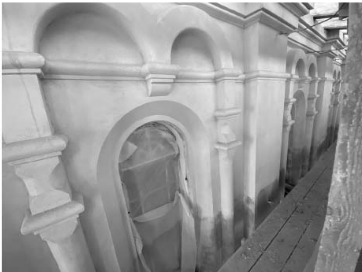
Фото 64. Фрагмент южного фасада основного объема здания. Заполнение оконного проема.
