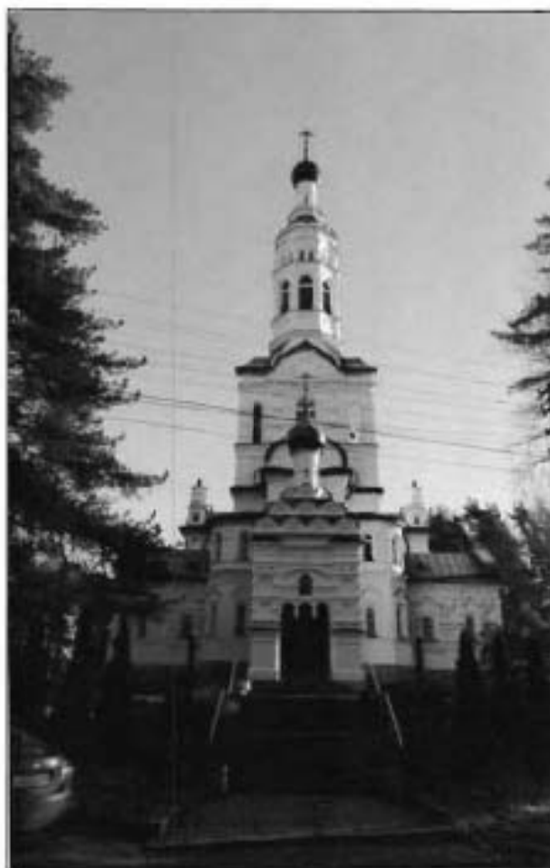
2. Западный фасад. Общий вид.
