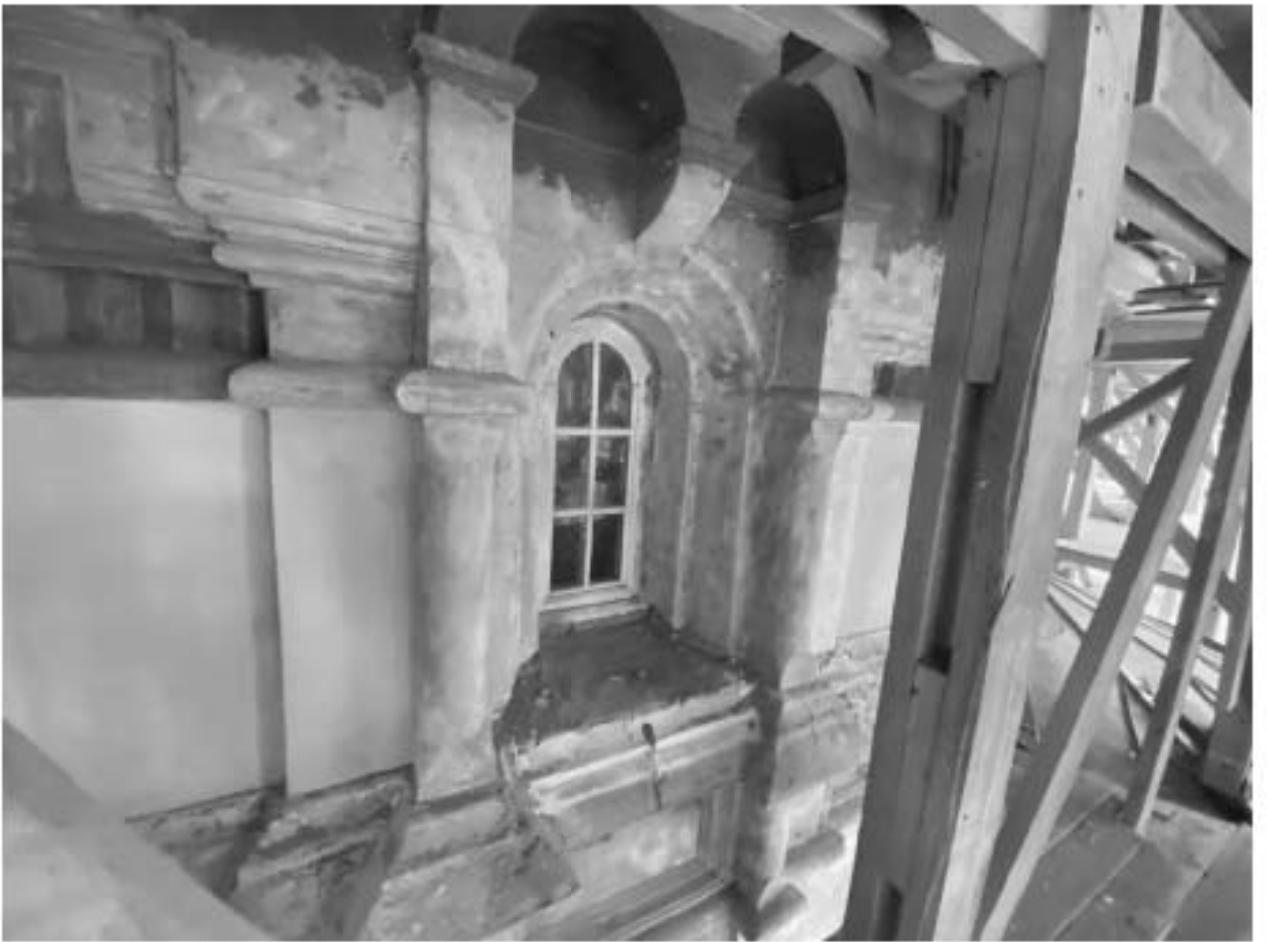
Фото 57. Фрагмент южного фасада основного объема здания. Заполнение оконного проема.
