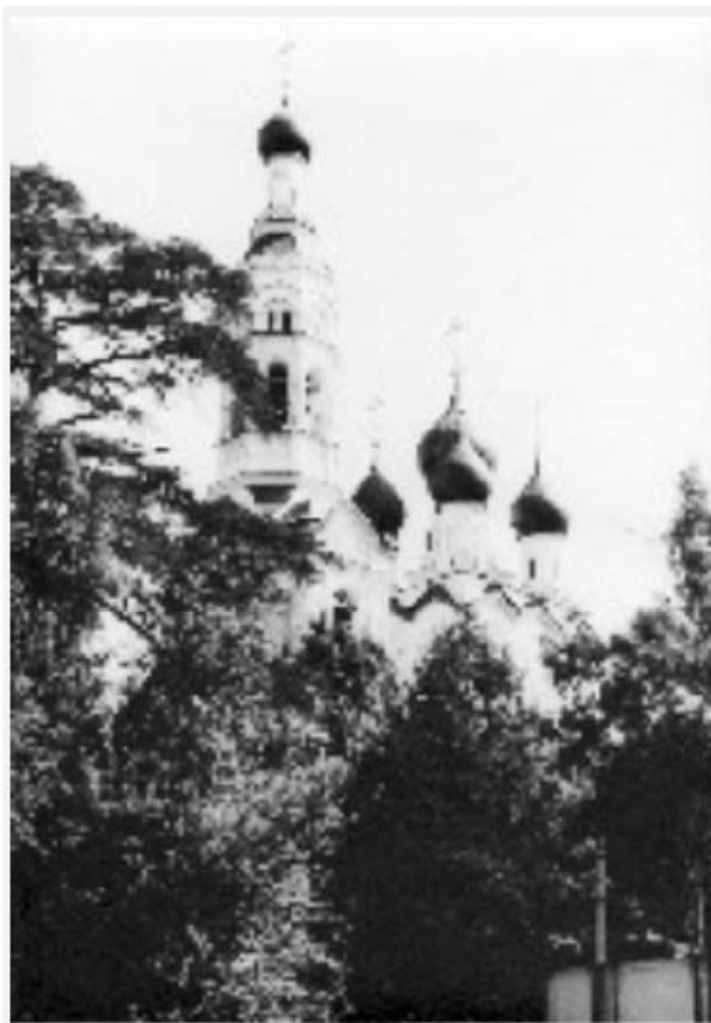
Илл. 34. Вид на колокольню и купола церкви Казанской иконы Божией Матери на Приморском шоссе, 547 в городе Зеленогорске (архитектор Н.Н. Никонов, 1910- 1915 гг.). Автор съёмки: Овчинников Кирилл Владимирович. Дата съёмки: 09 июня 1984 г. // ЦГАКФФД СПб. Шифр: Ар 227463.
