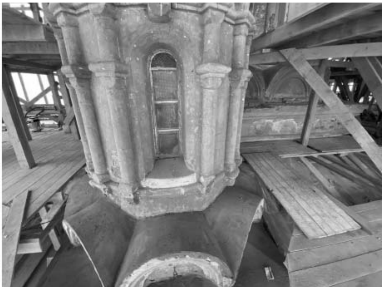
Фото 70. Фрагмент фасада барабана малой главы. Заполнение оконного проема.
