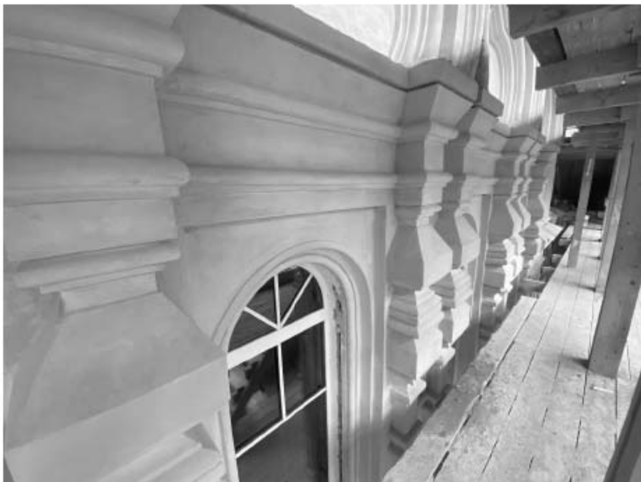
Фото 37. Фрагмент северного фасада основного объема здания. Заполнение оконного проема.
