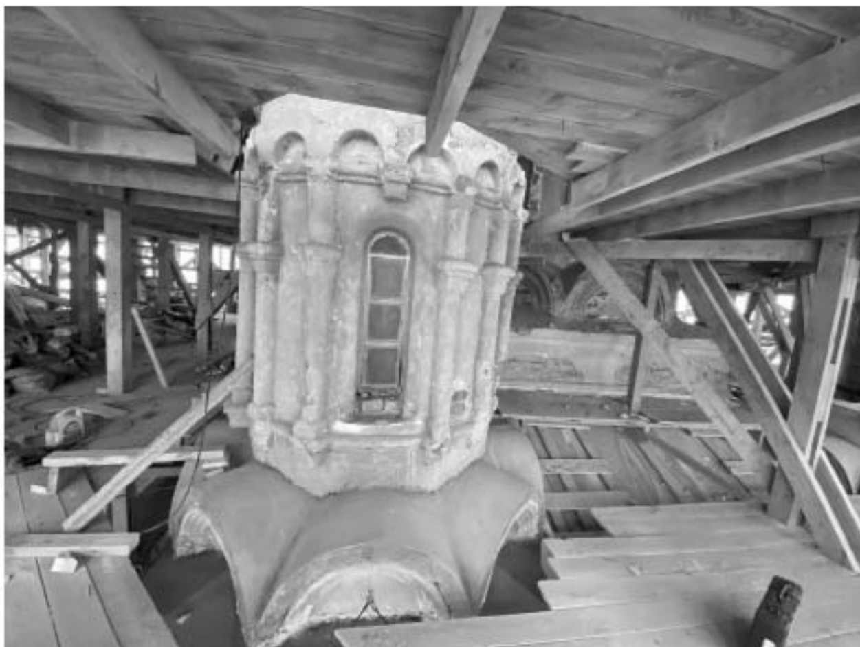
Фото 68. Фрагмент фасада барабана малой главы. Заполнение оконного проема.
