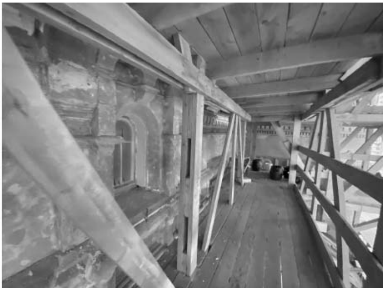
Фото 60. Фрагмент южного фасада основного объема здания. Заполнение оконного проема.
