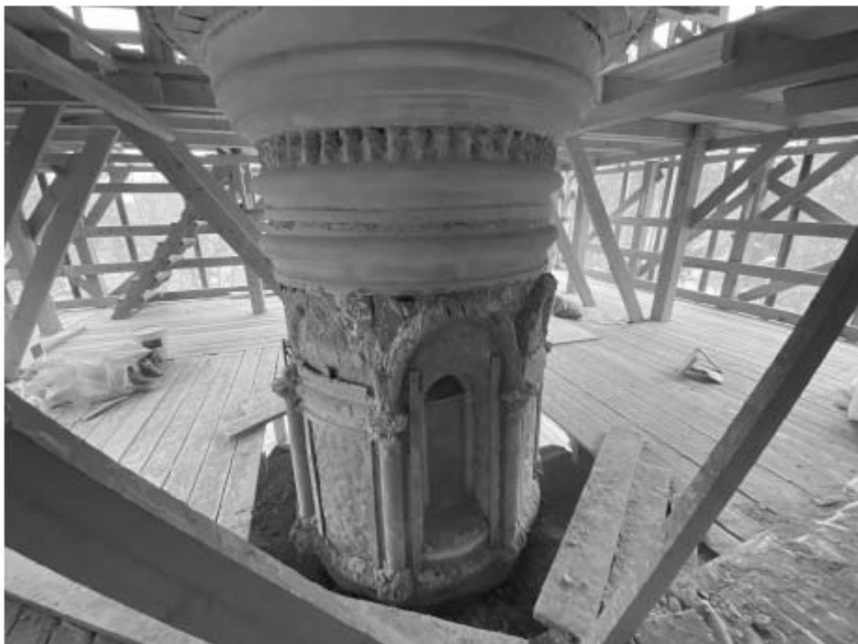
Фото 59. Барабан малой главки, расположенной над западным крыльцом. Заполнение оконного проема.
