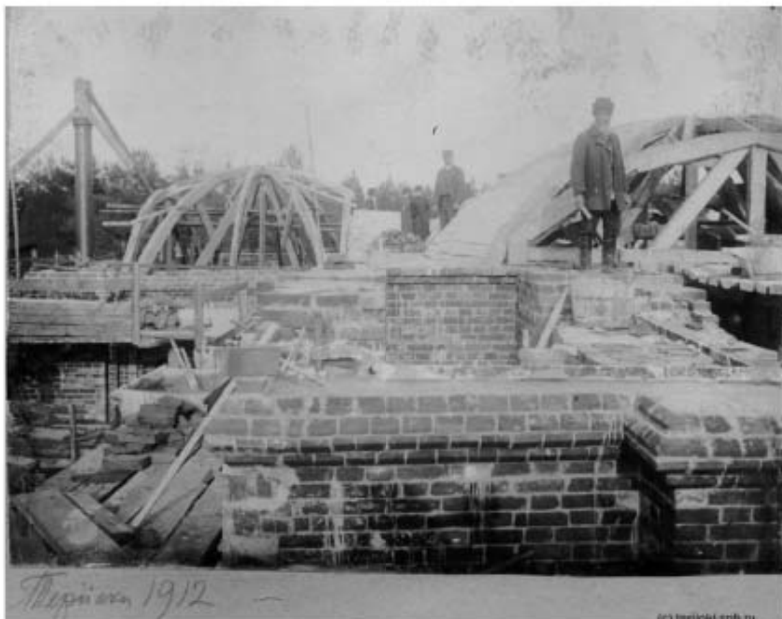
Илл. 17. Терюки. Строительство Казанской церкви. 1912 г. (из архива Е. Ромащенко)/ https://terijoki.spb.ru/history/templ.php?page=hram&lang=ru
