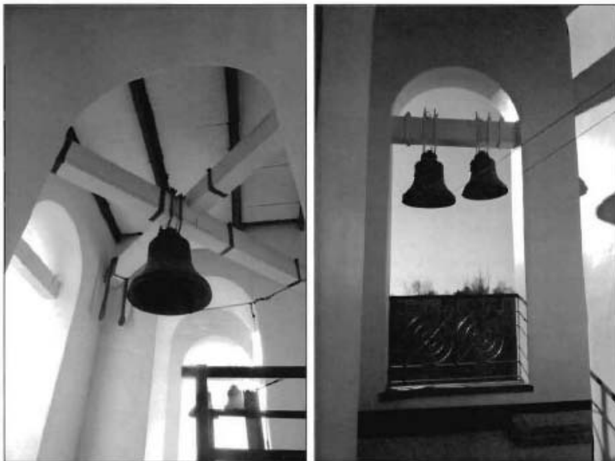
8 - 9. Внутреннее пространство колокольни. Фрагмент.
