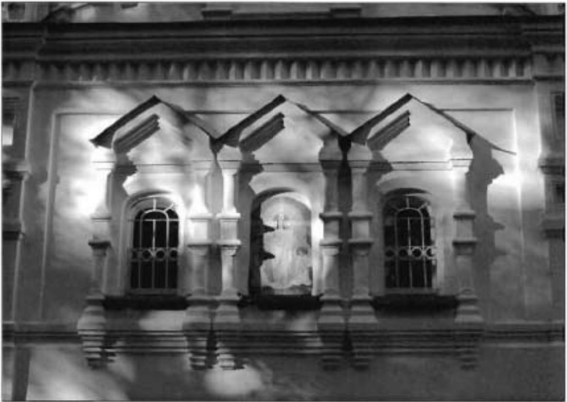
4. Восточный фасад. Фрагмент.
