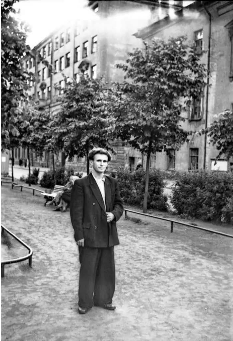
15. 1950-1955 гг. Фасад дома №14, литера В на улица Каляева (Захарьевская). https://pastvu.com/p/1092512
