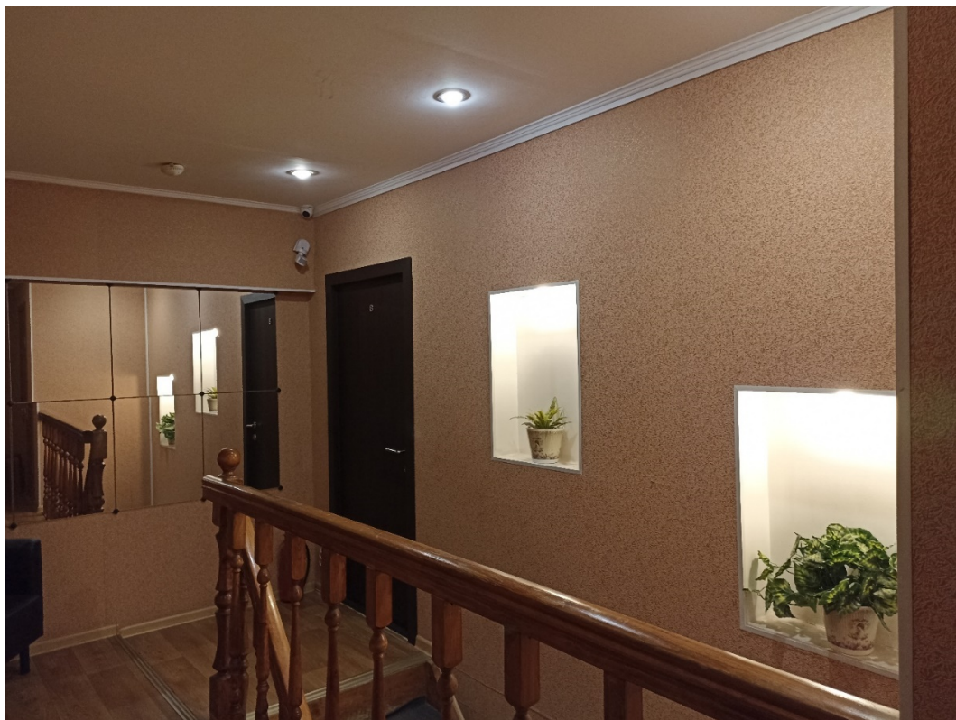
25. Выявленный объект культурного наследия «Три жилых корпуса» (в составе «Комплекс зданий Конторского двора Гоф-интендантской конторы»), расположенный по адресу: г. Санкт-Петербург, ул. Захарьевская, д. 14, литер. В. Антресоль. Дата съемки: 04.03.24г.
