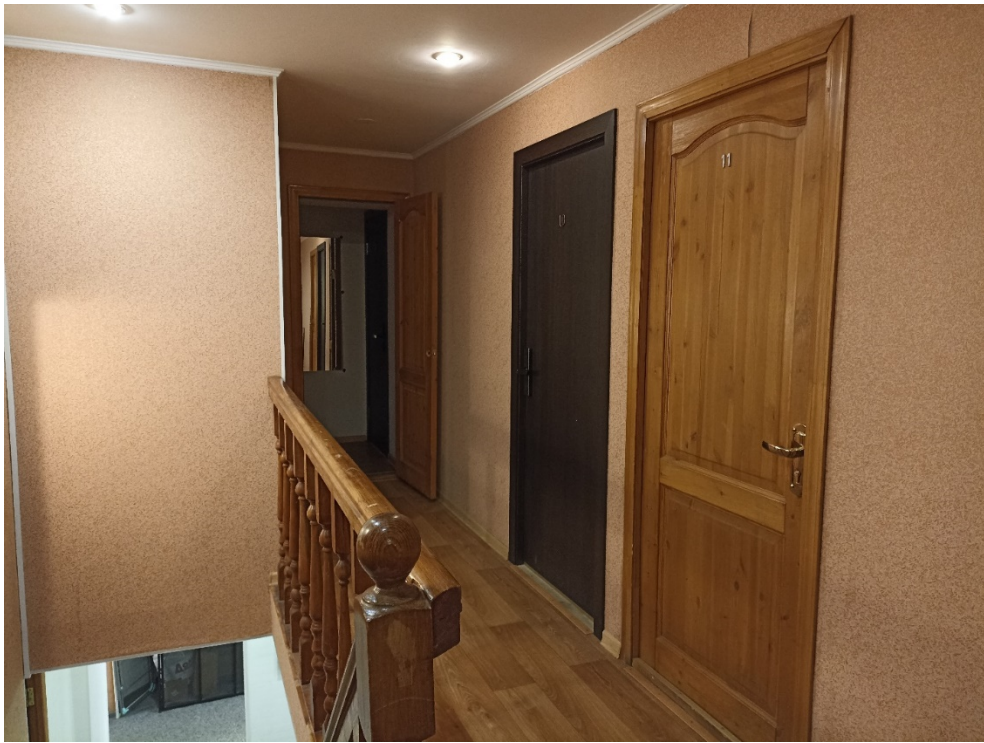
24. Выявленный объект культурного наследия «Три жилых корпуса» (в составе «Комплекс зданий Конторского двора Гоф-интендантской конторы»), расположенный по адресу: г. Санкт-Петербург, ул. Захарьевская, д. 14, литер. В. Помещения, антресоль. Дата съемки: 04.03.24г.
