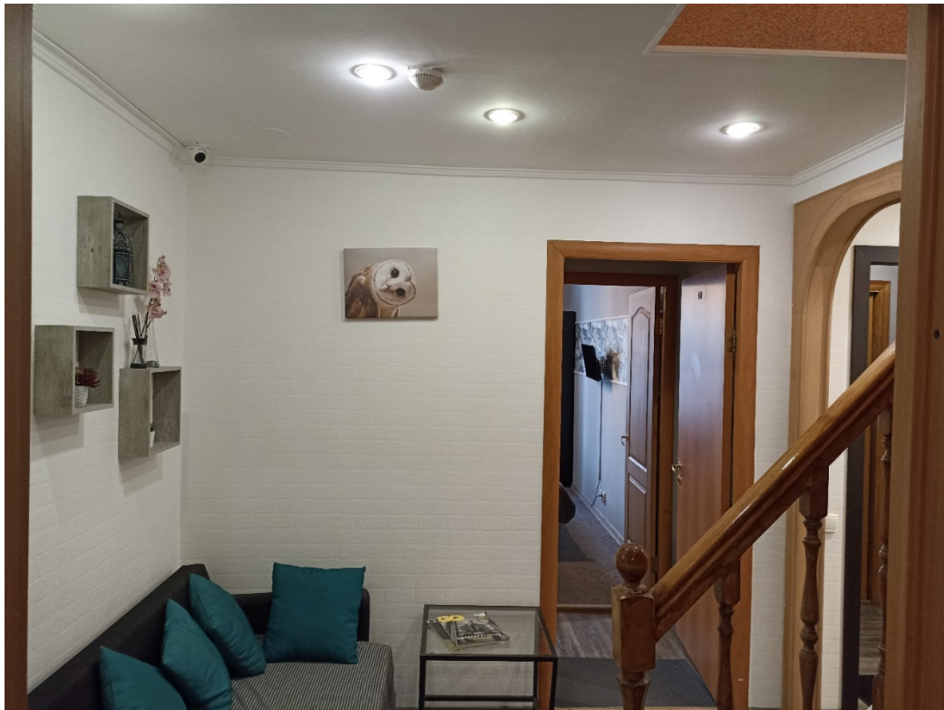
12. Выявленный объект культурного наследия «Три жилых корпуса» (в составе «Комплекс зданий Конторского двора Гоф-интендантской конторы»), расположенный по адресу: г. Санкт-Петербург, ул. Захарьевская, д. 14, литер. В. Коридор, первый этаж. Дата съемки: 04.03.24г.
