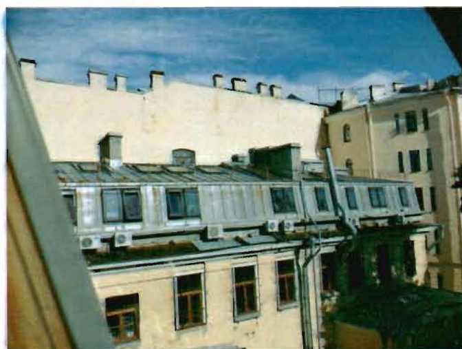
15. Мансардная надстройка над 3-им этажом
