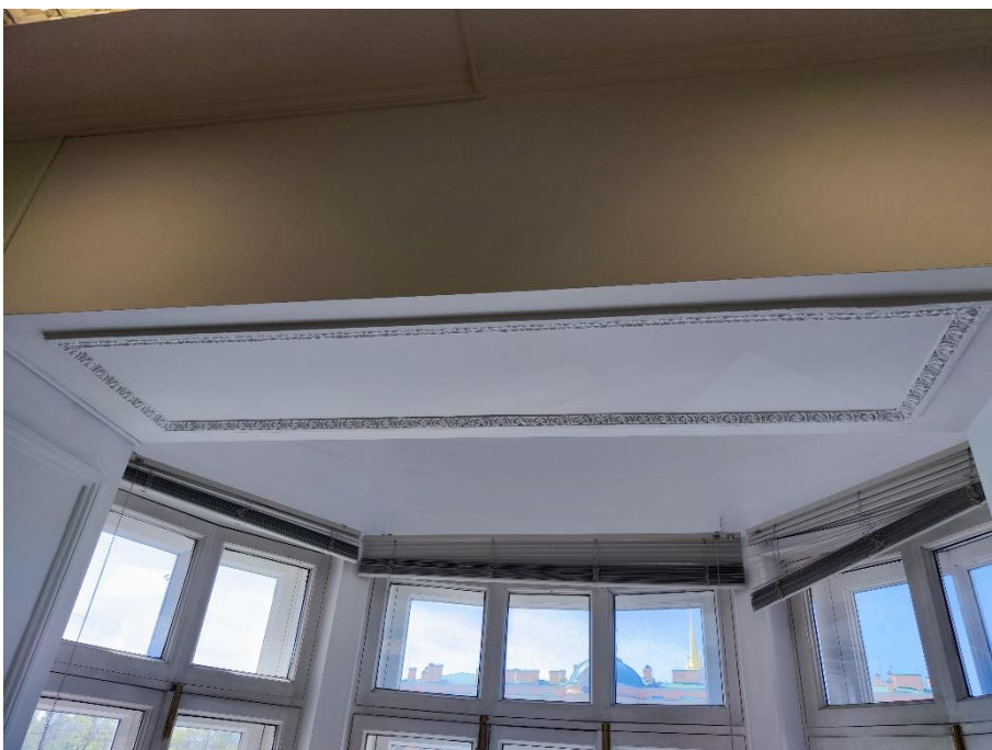
17. «Дом Пашковых», наб. реки Фонтанки, д.18, лит. А. Помещение 5-Н (14). Фрагмент. Фото 08.05.2024г.
