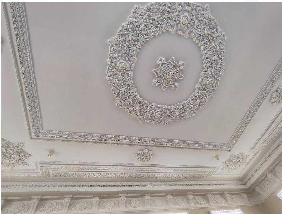
28. «Дом Пашковых», наб. реки Фонтанки, д.18, лит. А. Помещение 5-Н (11). Фрагмент. Фото 08.05.2024г.
