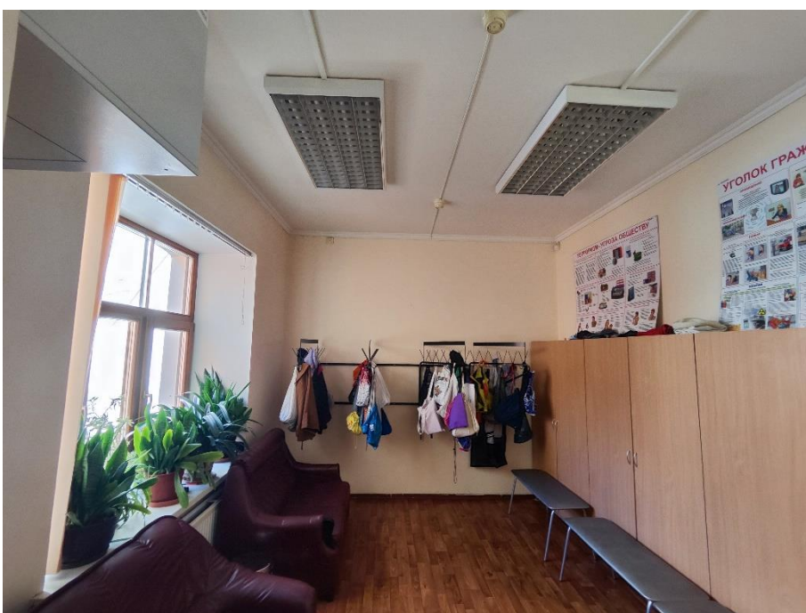
30. «Дом Пашковых», наб. реки Фонтанки, д.18, лит. А. Помещение 5-Н (17). Общий вид. Фото 08.05.2024г.
