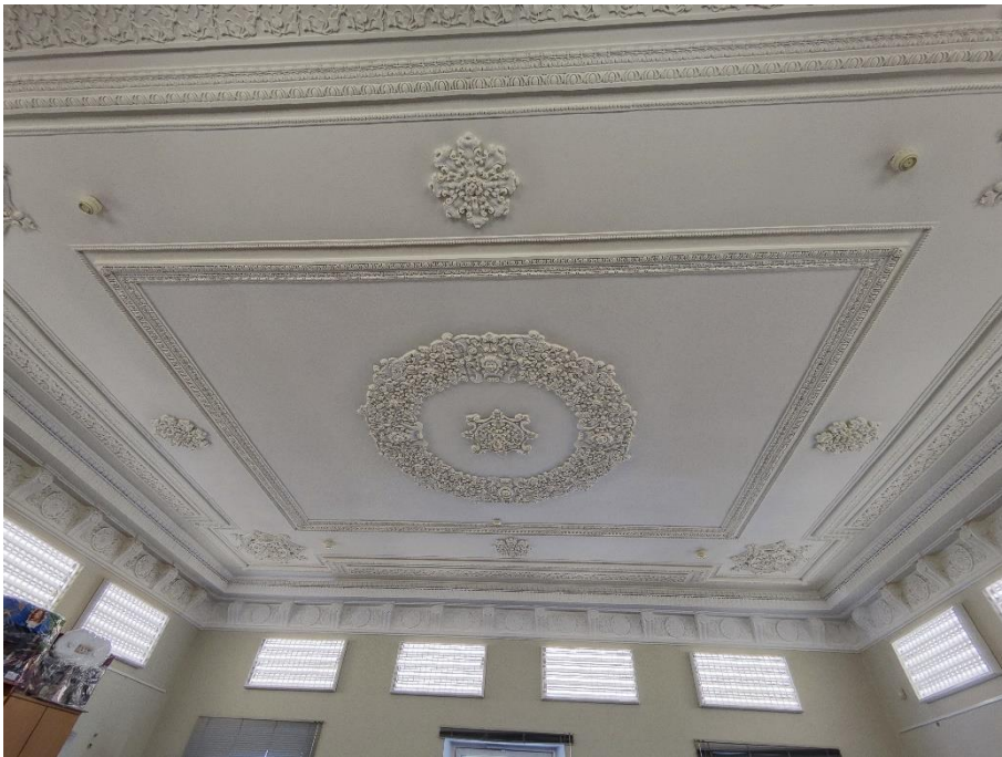
27. «Дом Пашковых», наб. реки Фонтанки, д.18, лит. А. Помещение 5-Н (11). Фрагмент. Фото 08.05.2024г.
