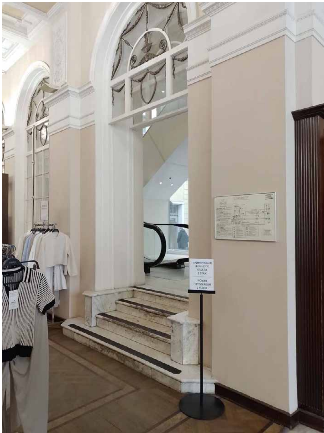
Фото 2. Объект культурного наследия регионального значения «Бывший дом Мертенса (фасады)». 1-й этаж. Лестница пом. 9-Н(6). Съемка 24.04.2024 г. Трушковский В.Э.
