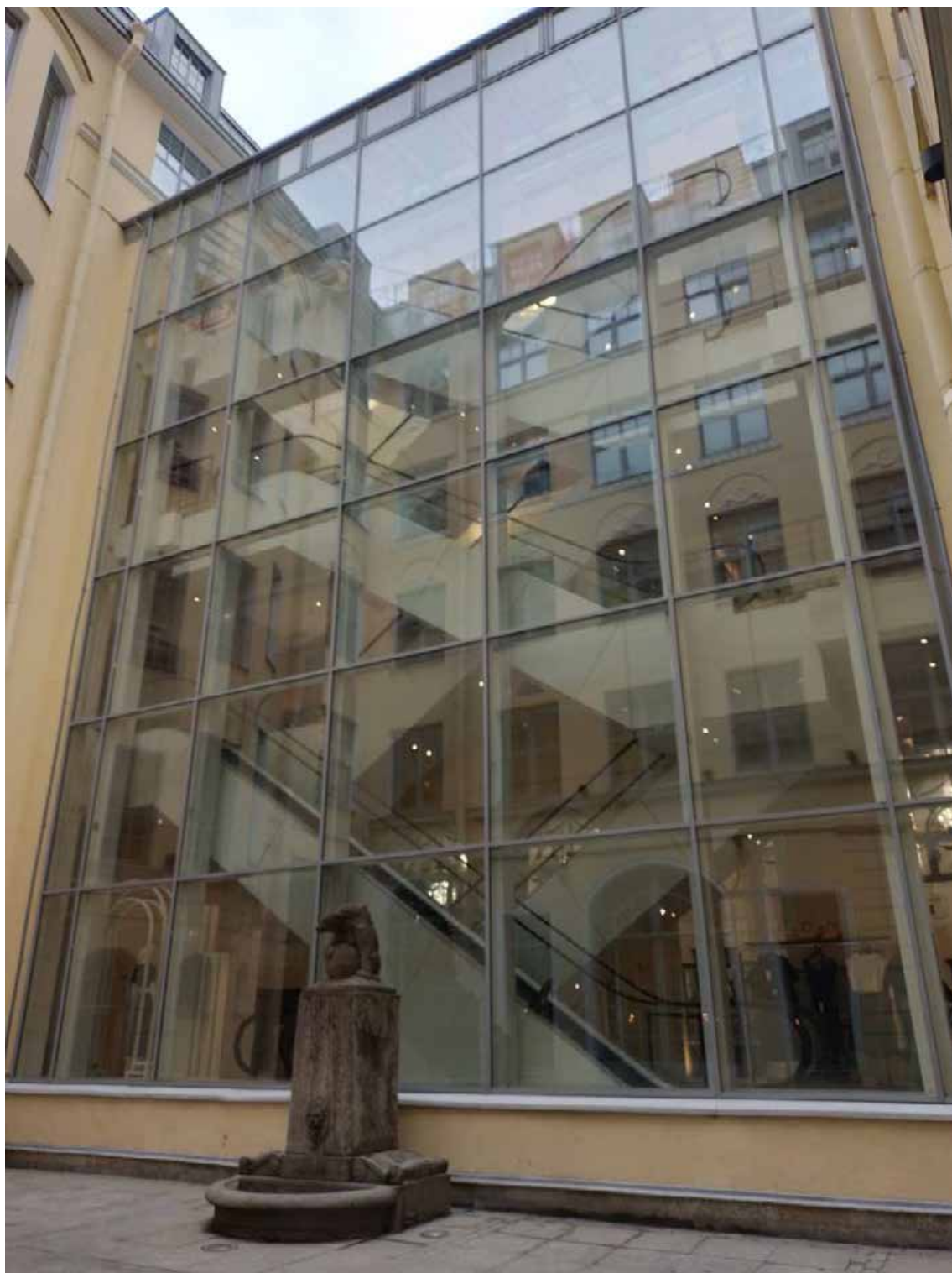
Фото 6. Объект культурного наследия регионального значения «Бывший дом Мертенса (фасады)». Внутренний двор. Пристройка. Съемка 24.04.2024 г. Трушковский В.Э.
