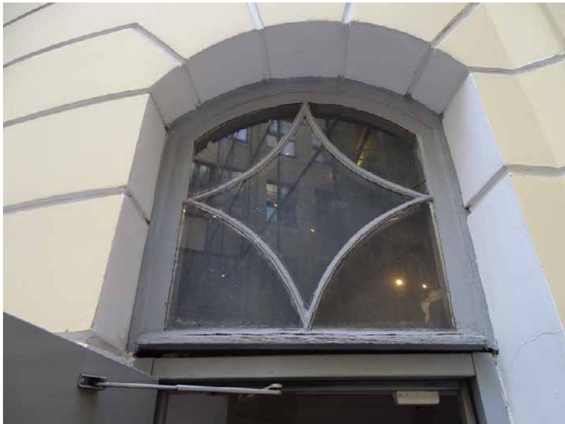
Фото 4. Объект культурного наследия регионального значения «Бывший дом Мертенса (фасады)». Дворовой фасад лицевого корпуса. Фрагмент. Съемка 24.04.2024 г. Трушковский В. Э.
