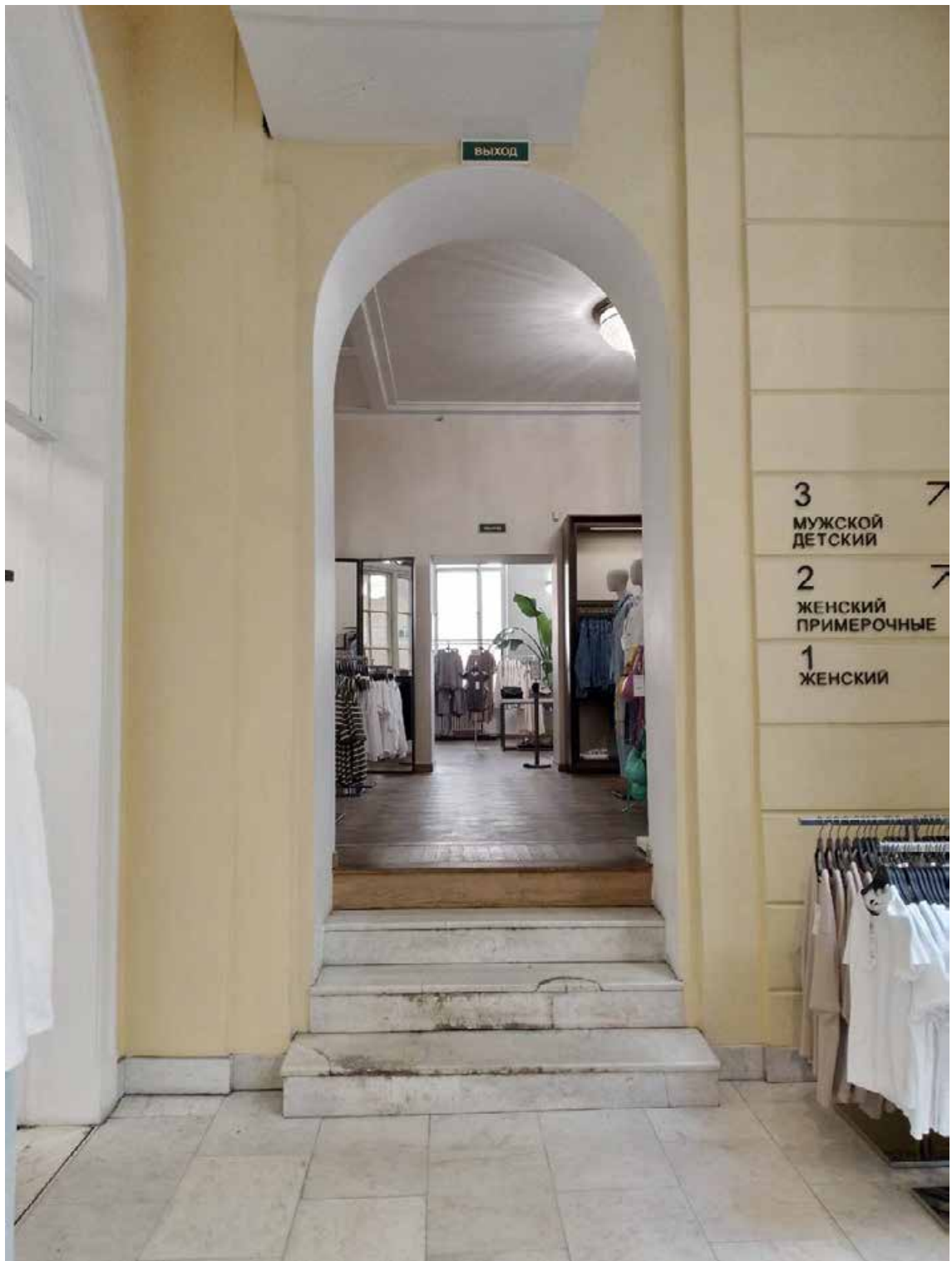
Фото 4. Объект культурного наследия регионального значения «Бывший дом Мертенса (фасады)». 1-й этаж. Лестница пом. 9-Н(15). Съемка 24.04.2024 г. Трушковский В. Э.
