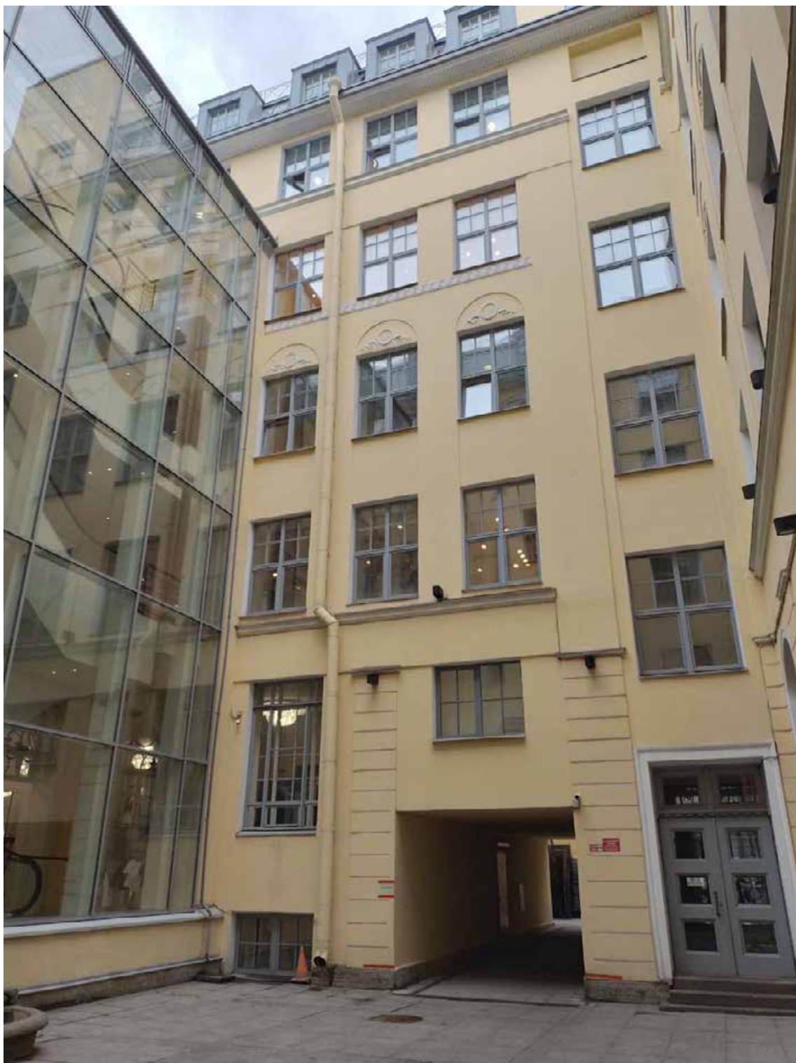
Фото 5. Объект культурного наследия регионального значения «Бывший дом Мертенса (фасады)». Внутренний двор. Съемка 24.04.2024 г. Трушковский В.Э.
