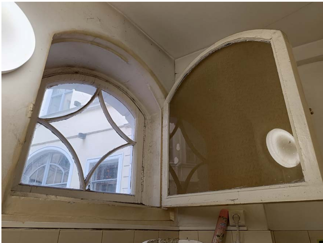
Фото 16. Объект культурного наследия регионального значения «Бывший дом Мертенса (фасады)». Парадная лестница Л-1. 1-й этаж. Оконное заполнение пом. 1-Н (18). Съемка 24.04.2024 г. Трушковский В. Э.
