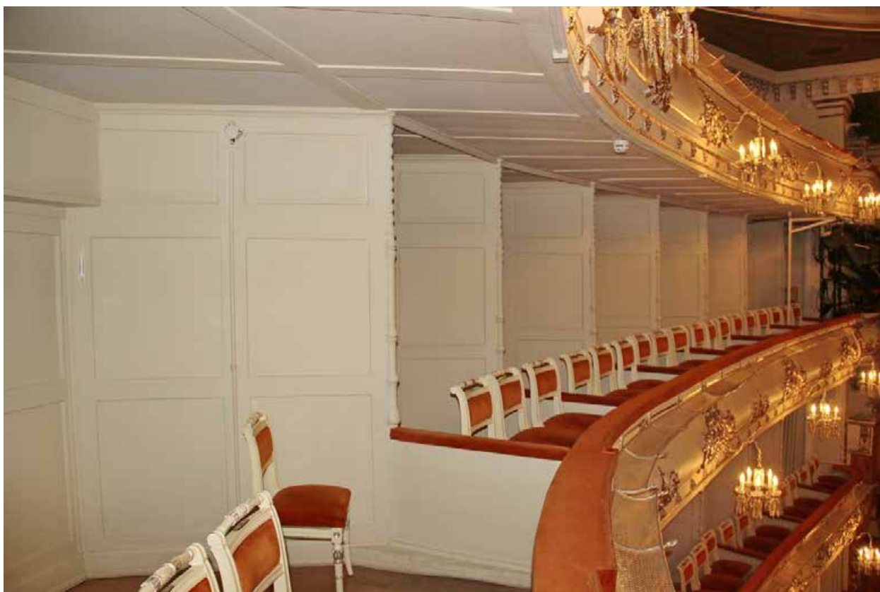
26 Помещение № 2 2 ярус Дата съемки: 01.04.2024
