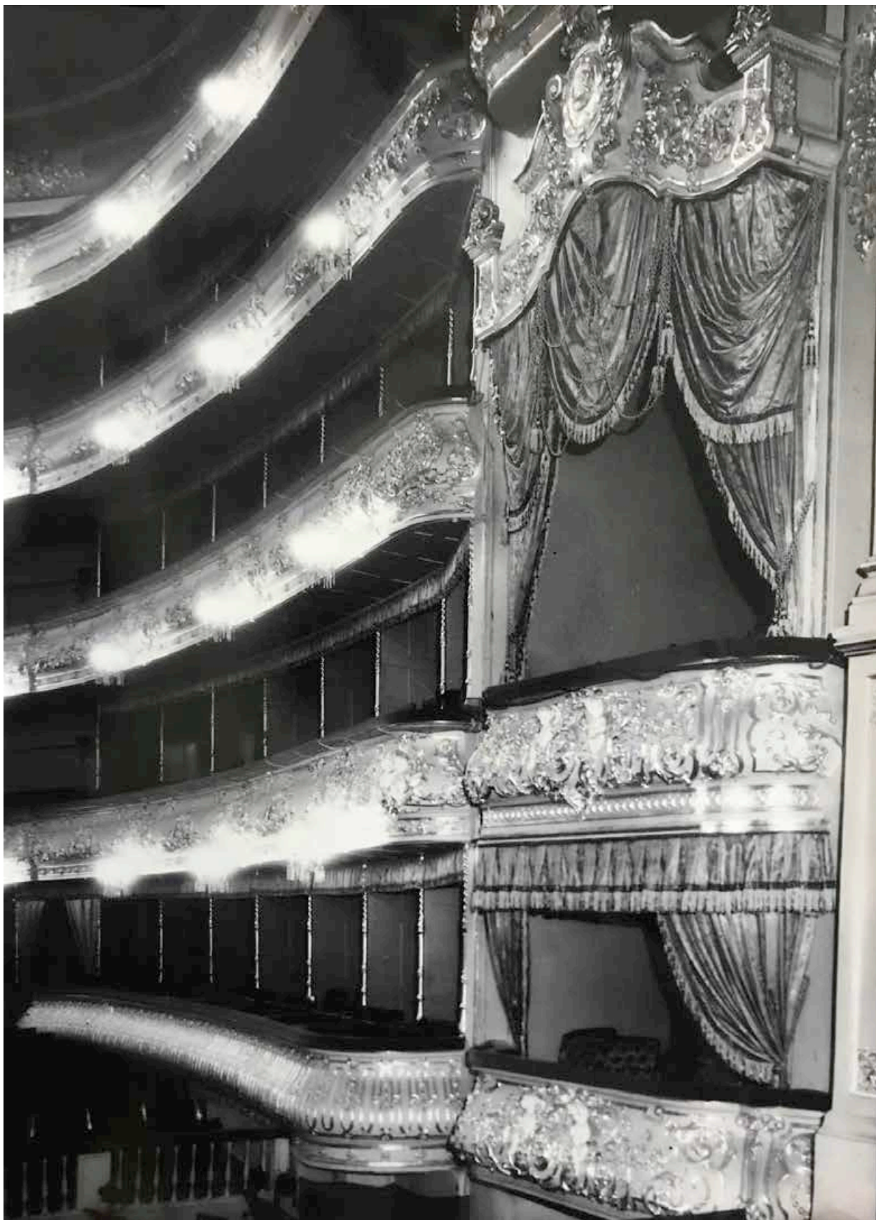
63. Малый оперный театр (бывший Михайловский театр). Часть общего вида Зрительного зала после реставрации. 06.08.1957 г.//КГИОП.
