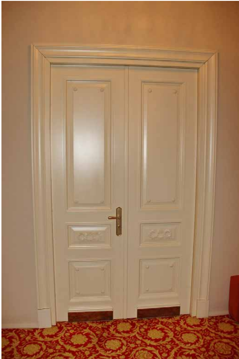
47 Помещение № 24 Ложа «Д». Двери в помещение № 23 Дата съемки: 01.04.2024
