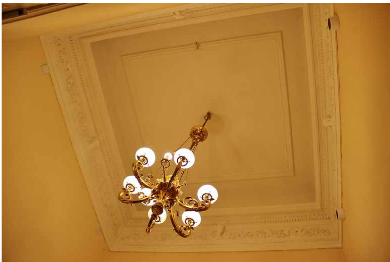
46 Помещение № 23 Аванложа. Потолок Дата съемки: 01.04.2024
