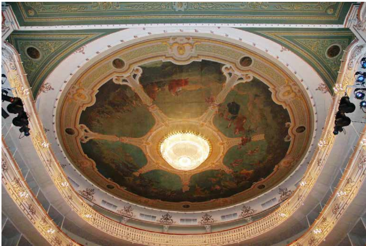
11 Помещение № 2 Живописный плафон над зрительным залом Дата съемки: 01.04.2024
