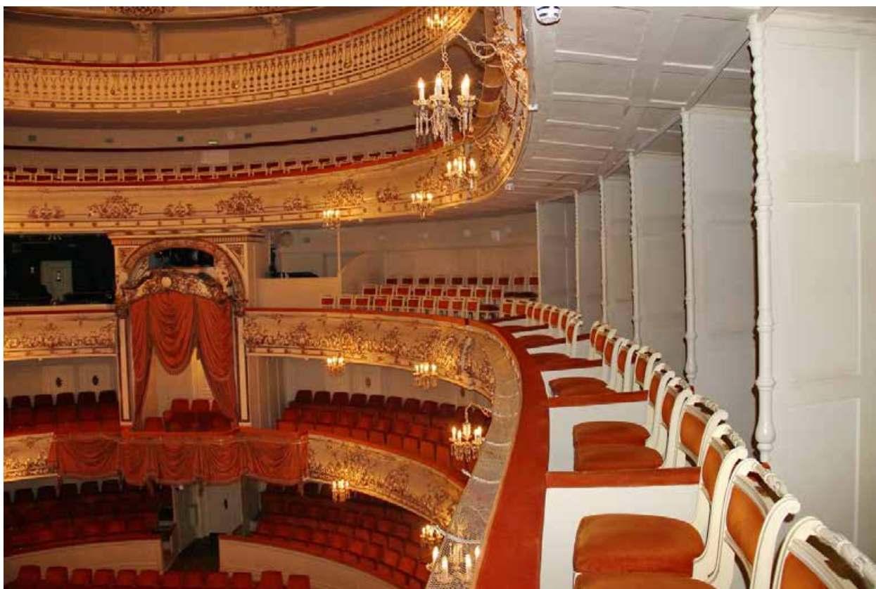
22 Помещение № 9 Зрительный зал. 1 ярус. Дата съемки: 01.04.2024
