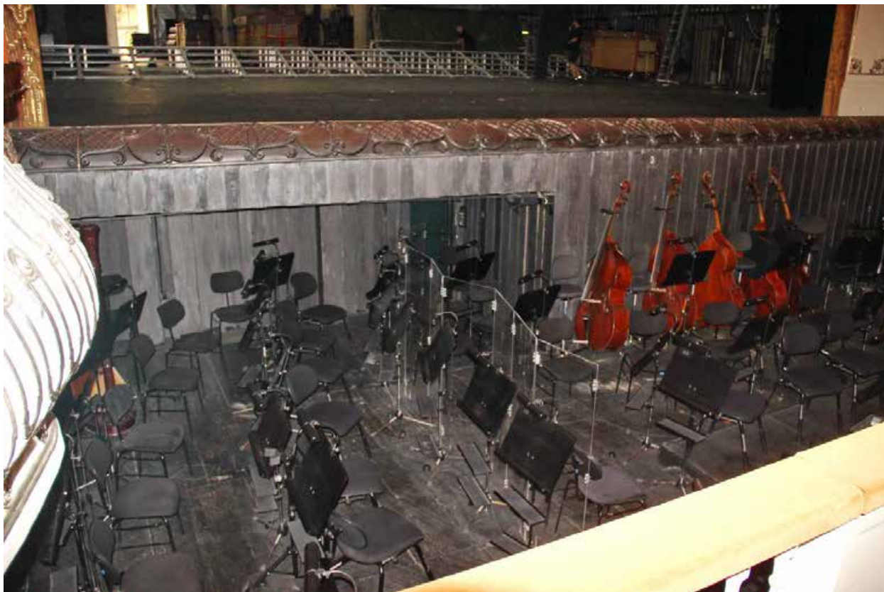
3 Помещение № 2 Партер зрительного зала. Оркестровая яма Дата съемки: 01.04.2024
