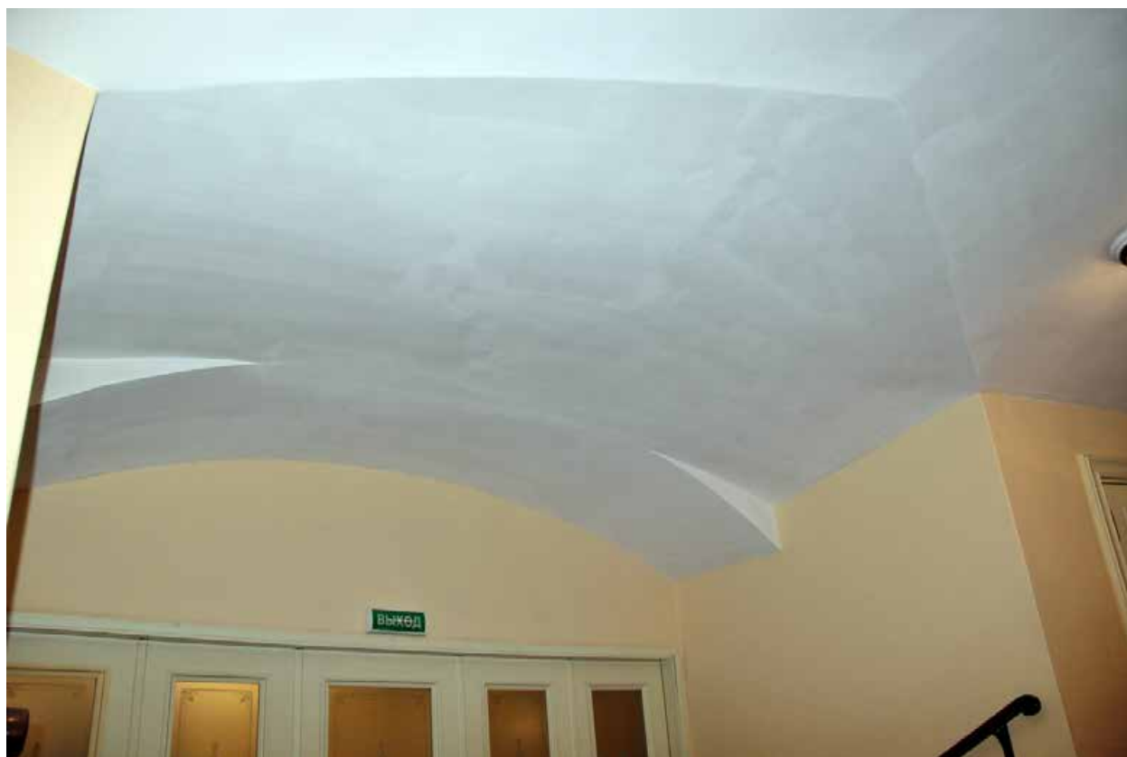
32 Помещение № 3 Променуар бенуара Дата съемки: 01.04.2024
