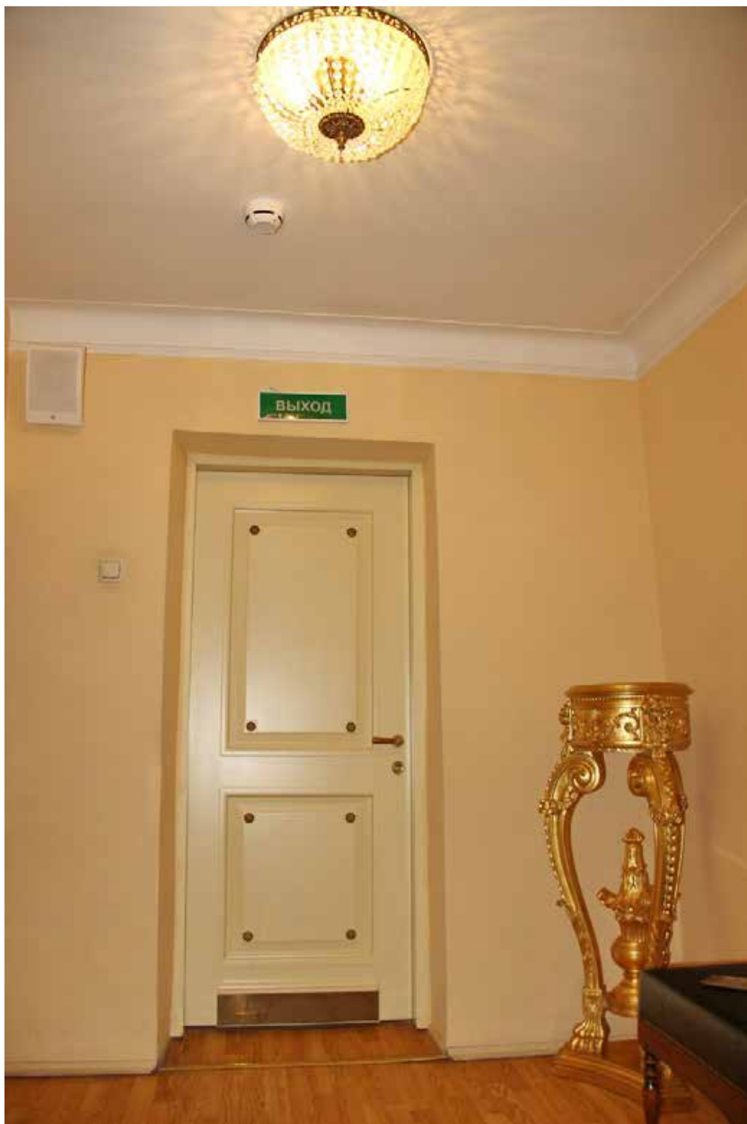
41 Помещение № 14 Дверь в коридор Дата съемки: 01.04.2024
