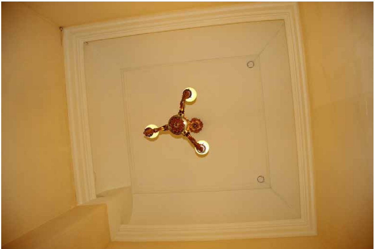
58 Помещение № 12 Аванложа. Потолок Дата съемки: 01.04.2024
