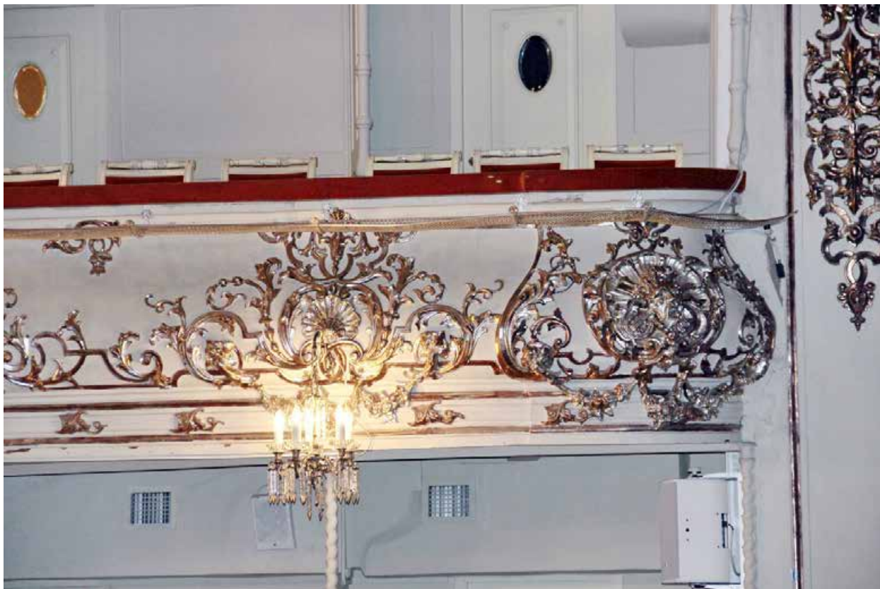
23 Помещение № 2 Зрительный зал. Фрагмент ограждения 1 яруса Дата съемки: 01.04.2024
