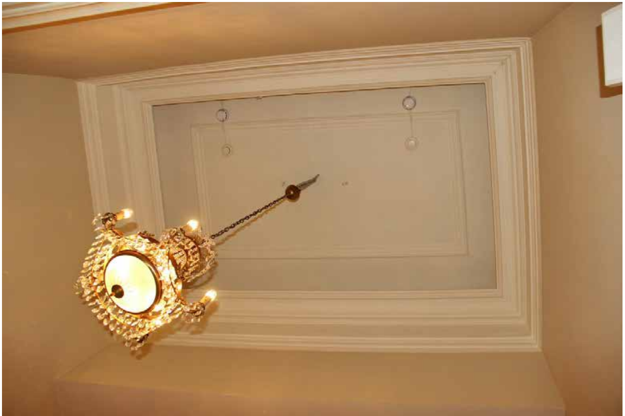
59 Помещение № 11 Ложа «В». Потолок Дата съемки: 01.04.2024
