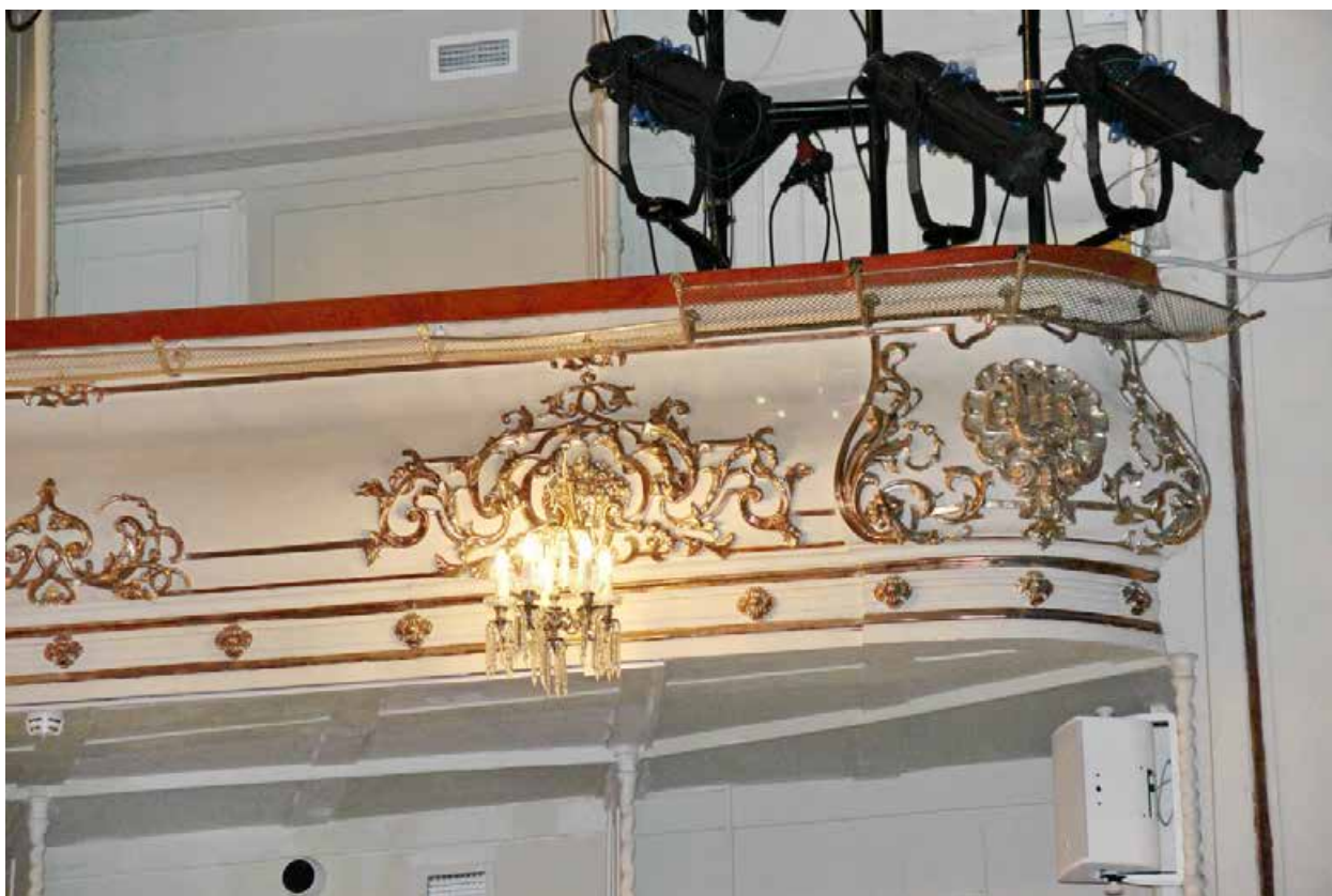
24 Помещение № 2 Зрительный зал. Фрагмент ограждения 2 яруса Дата съемки: 01.04.2024
