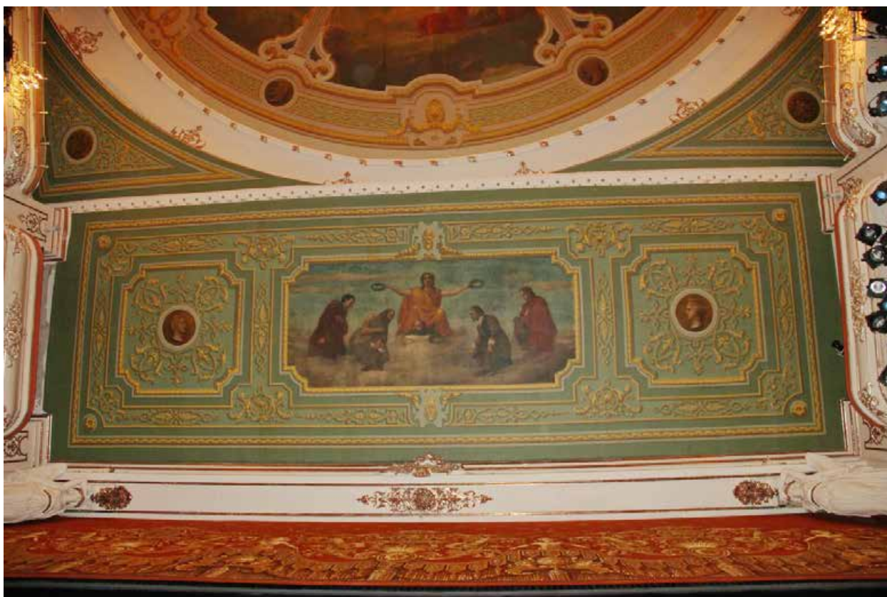
12 Помещение № 2 Живописный плафон над «оркестровой ямой» Дата съемки: 01.04.2024
