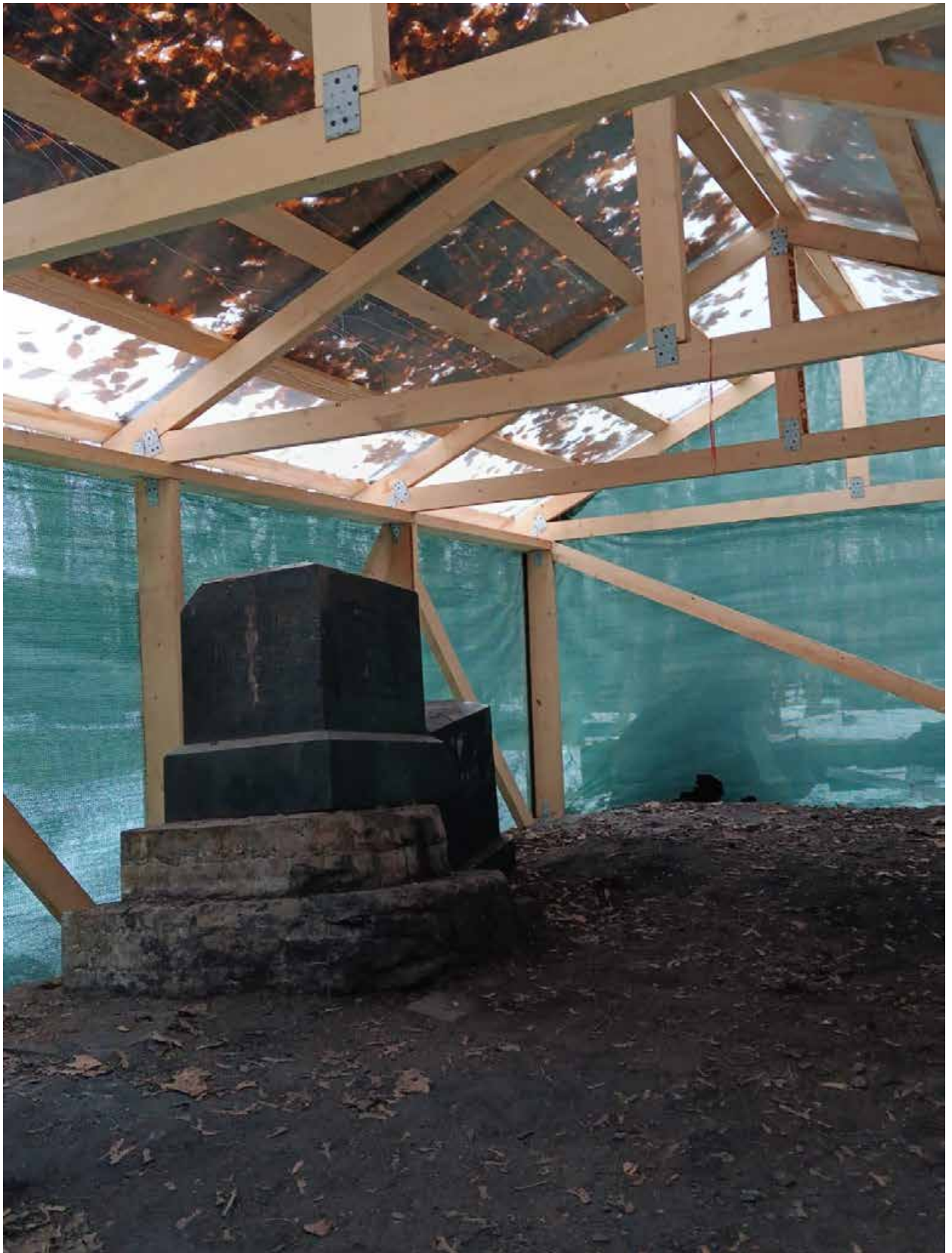
Фото 7. Объект культурного наследия регионального значения «Смоленское лютеранское кладбище». Могила генерал-майора А. фон Бекмана (1807-1833), предмет охраны объекта культурного наследия. Фрагмент временного защитного ограждения в виде деревянного каркаса, обшитого защитными материалами. Общий вид надгробных памятников.
