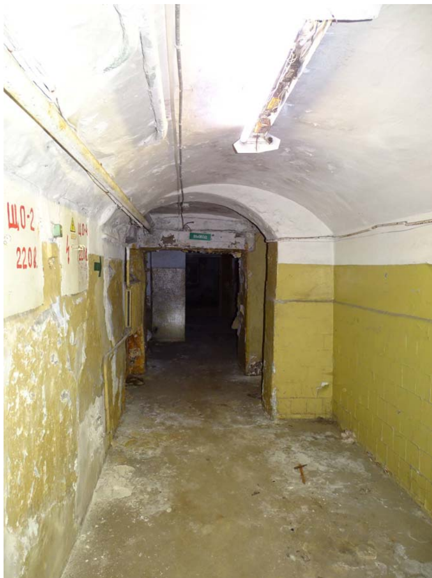
Илл. 13. Цокольный и 1-й этаж. Пом. 6/14,6. Съемка 08.02.2024 г. Трушковский В.Э.
