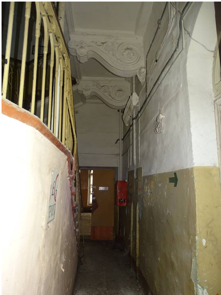
Илл. 11. 1-й этаж. Центральная лестница. Съемка 08.02.2024 г. Трушковский В.Э.
