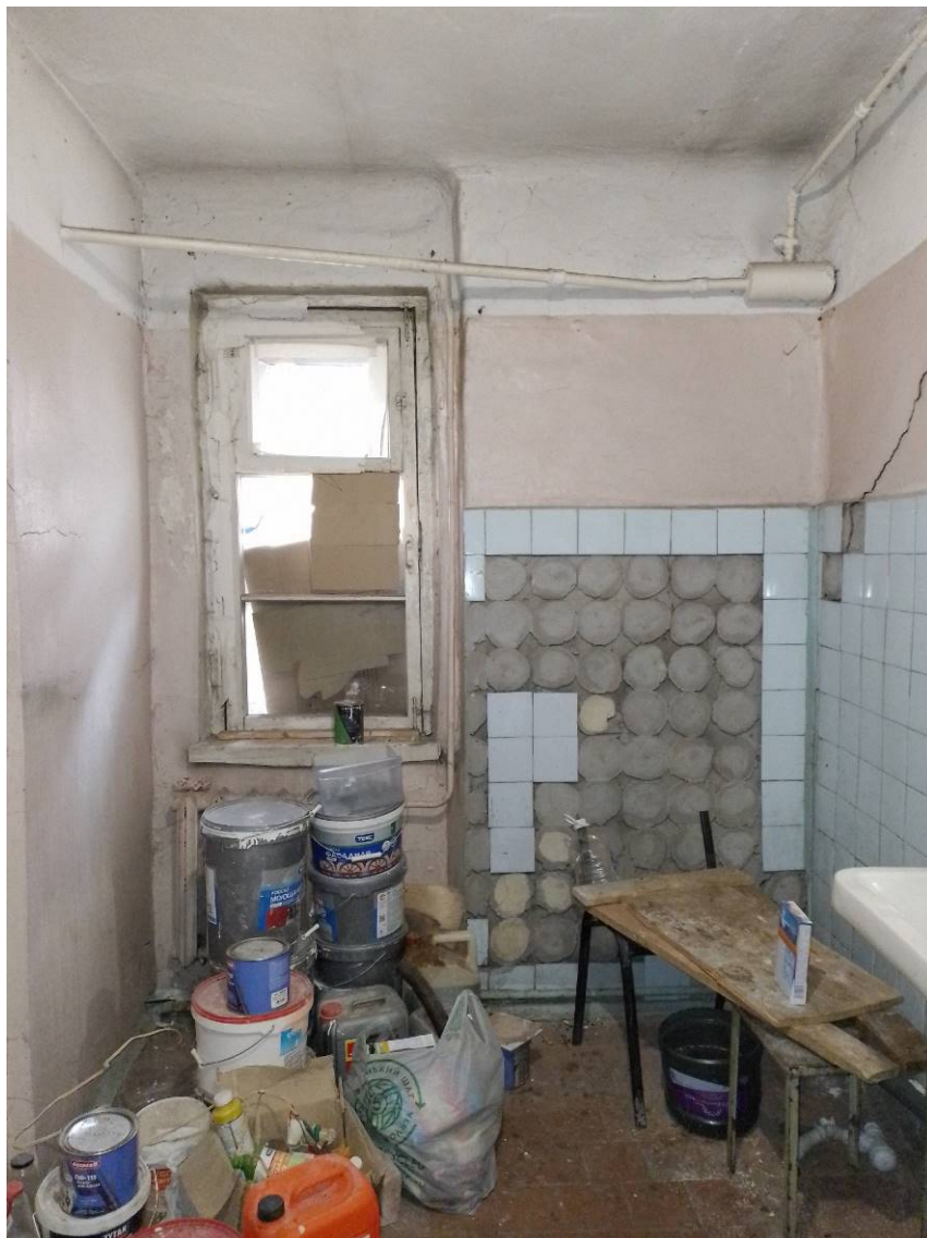
Илл. 15. 1-й этаж. Пом. 4/5,0. Съёмка 08.02.2024 г. Трушковский В.Э.
