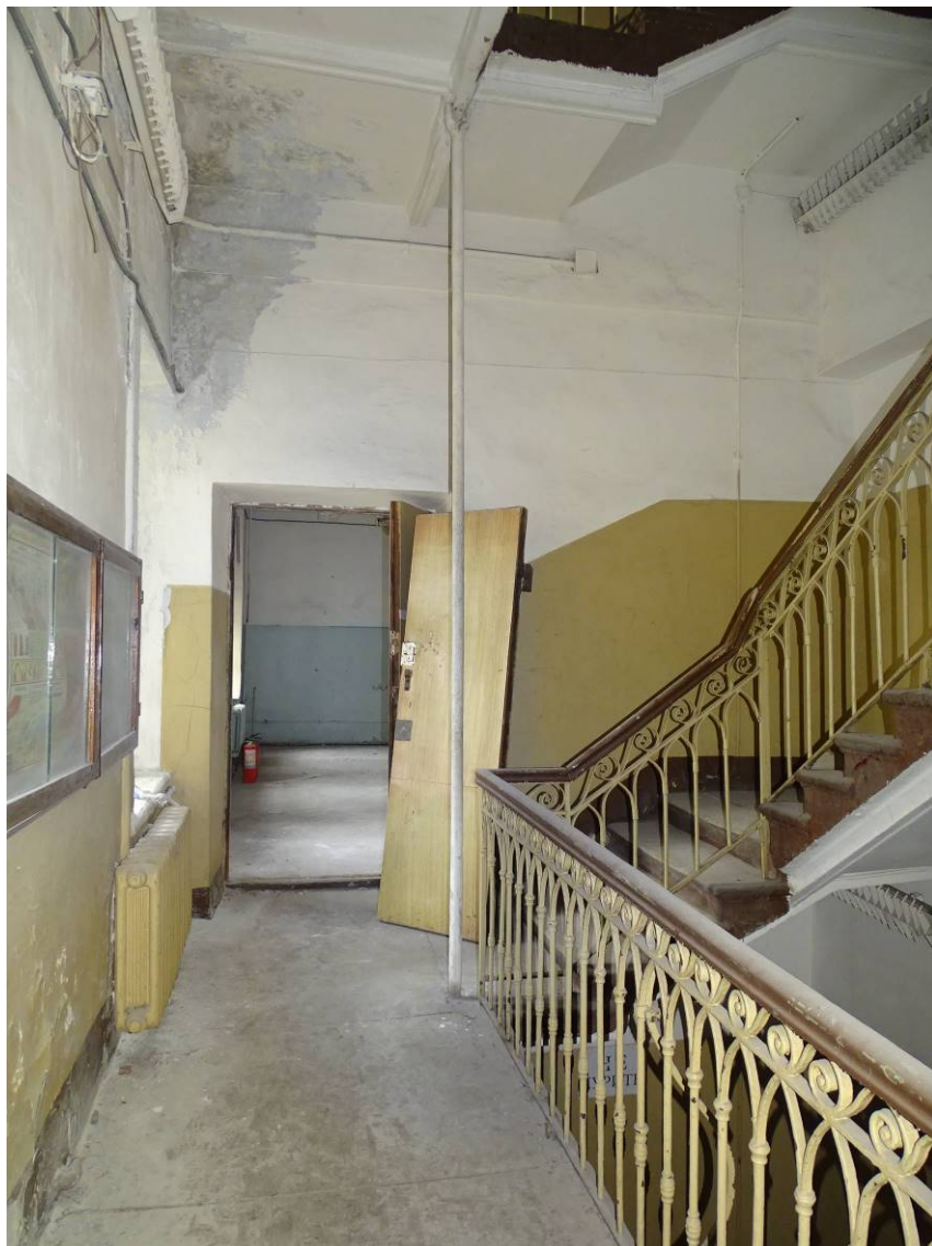
Илл. 1. 2-й этаж. Центральная лестница. Съемка 08.02.2024 г. Трушковский В.Э.
