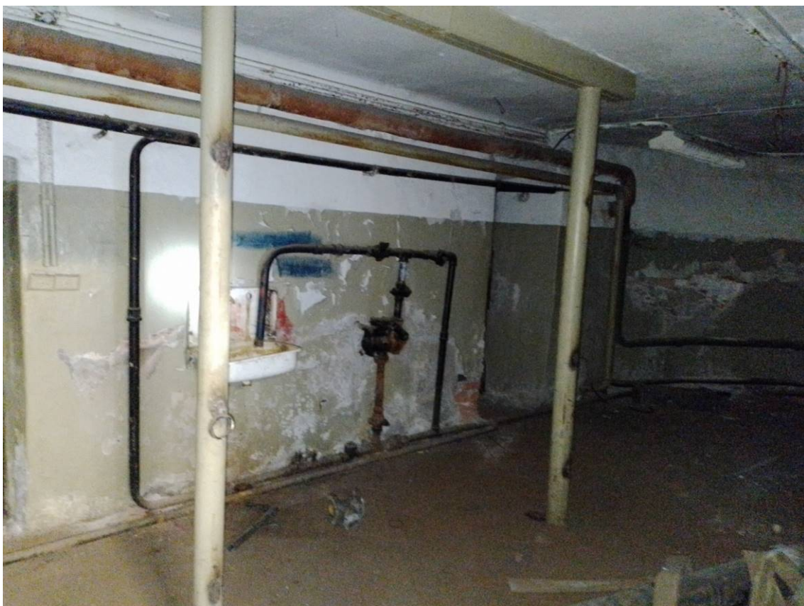
Илл. 19. Цокольный и 1-й этаж. Пом. 15/23,6. Съемка 08.02.2024 г. Трушковский В.Э.
