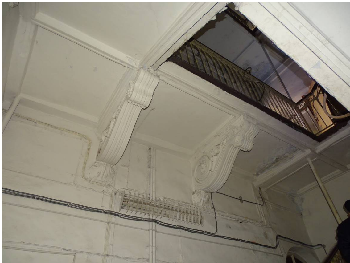
Илл. 12. 1-й этаж. Центральная лестница. Фрагмент. Съемка 08.02.2024 г. Трушковский В.Э.
