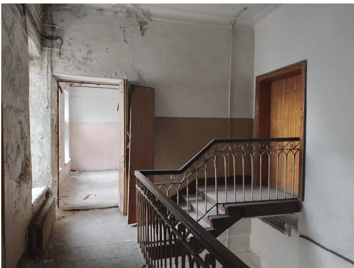
Илл. 2. 3-й этаж. Центральная лестница. Съемка 08.02.2024 г. Трушковский В.Э.
