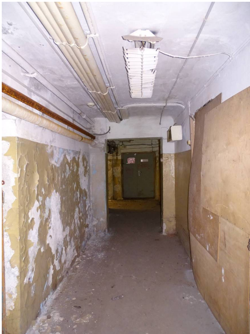
Илл. 9. Цокольный и 1-й этаж. Пом. 7/28,5. Съемка 08.02.2024 г. Трушковский В.Э.
