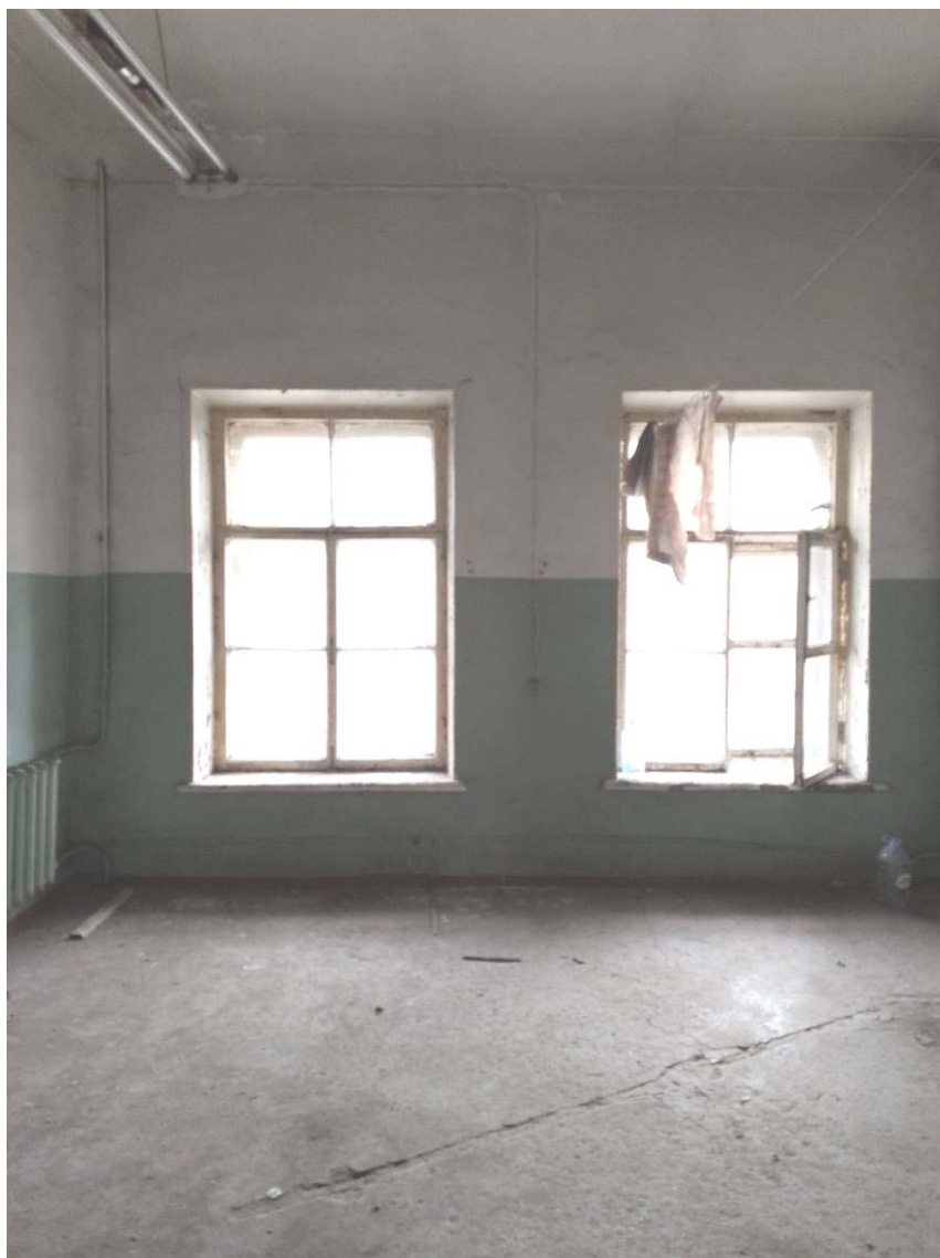
Илл. 11. 3-й этаж. Пом. 83/17,6. Съёмка 08.02.2024 г. Трушковский В.Э.
