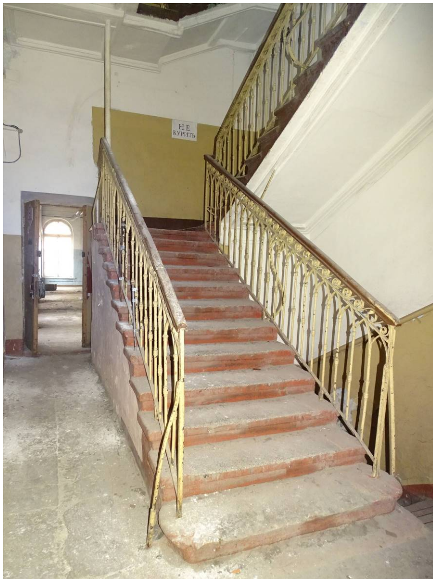
Илл. 10. 1-й этаж. Центральная лестница. Съемка 08.02.2024 г. Трушковский В.Э.
