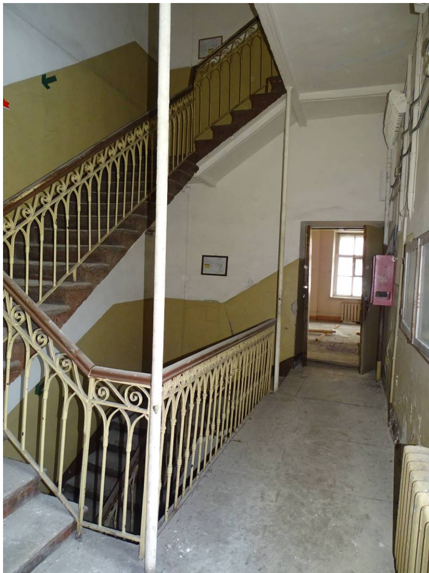
Илл. 12. 2-й этаж. Центральная лестница. Съемка 08.02.2024 г. Трушковский В.Э.
