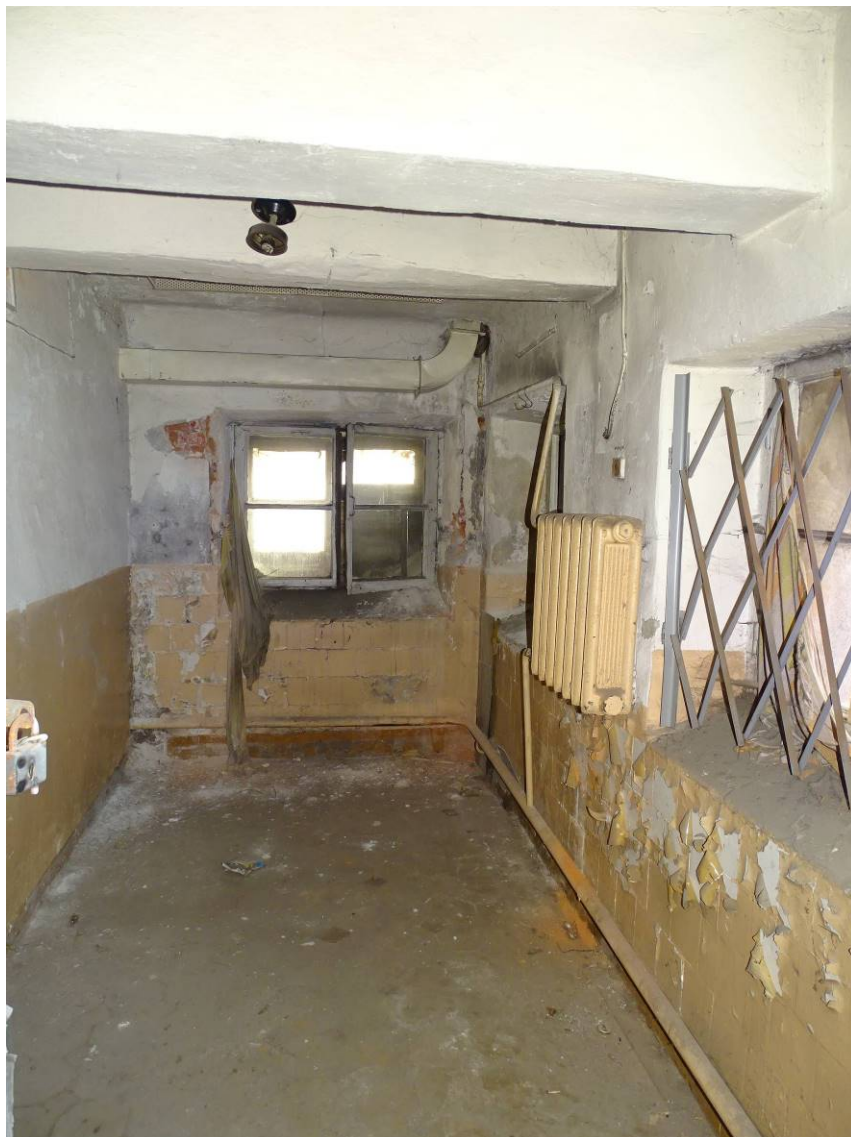
Илл. 7. Цокольный и 1-й этаж. Пом. 21/8,4. Съемка 08.02.2024 г. Трушковский В.Э.
