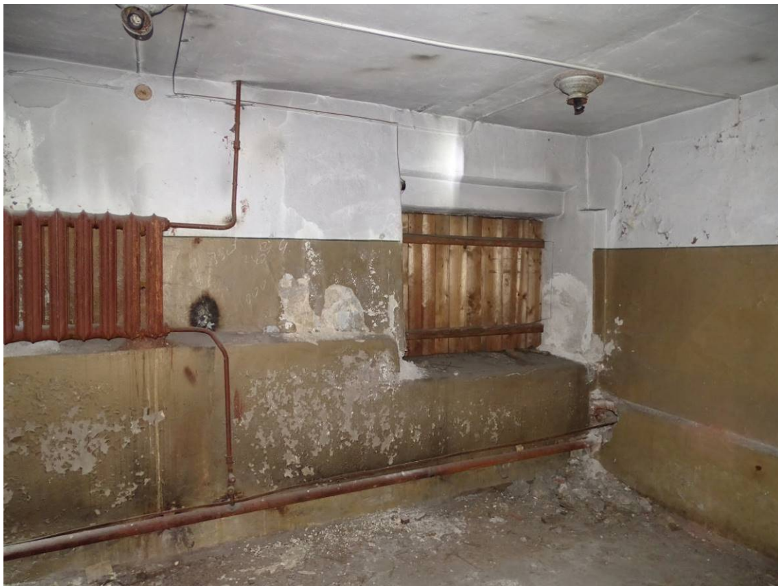
Илл. 11. Цокольный и 1-й этаж. Пом. 18/15,5. Съемка 08.02.2024 г. Трушковский В.Э.
