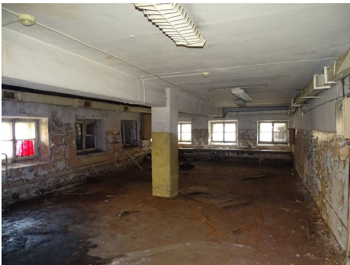
Илл. 16. Цокольный и 1-й этаж. Пом. 3/76,6. Съемка 08.02.2024 г. Трушковский В.Э.
