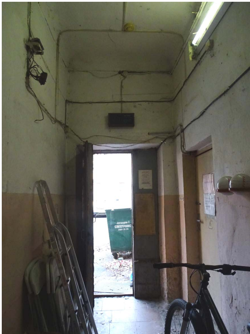
Илл. 1. Цокольный и 1-й этаж. Пом. 38/7,3. Съемка 08.02.2024 г. Трушковский В.Э.
