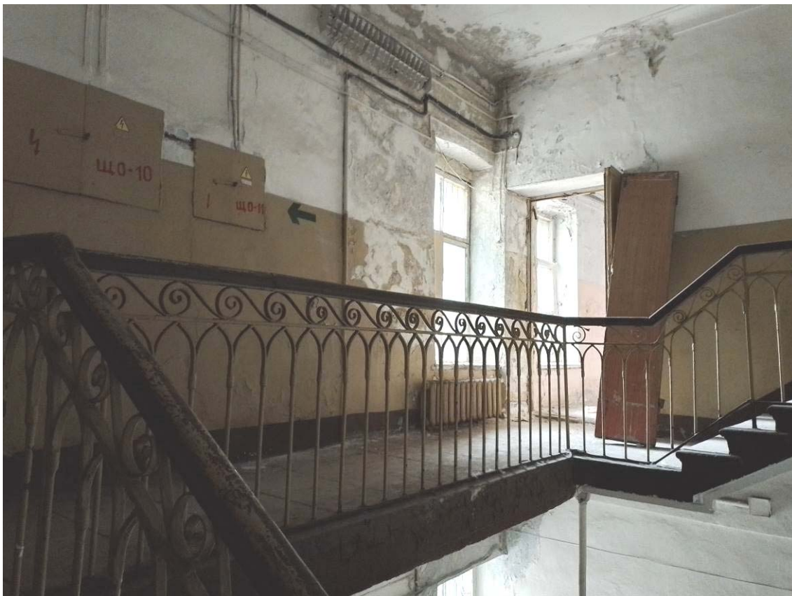
Илл. 1. 3-й этаж. Центральная лестница. Съемка 08.02.2024 г. Трушковский В.Э.
