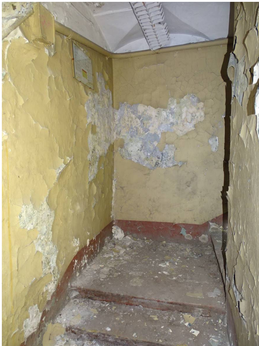
Илл. 14. Цокольный и 1-й этаж. Центральная лестница. Съемка 08.02.2024 г. Трушковский В.Э.
