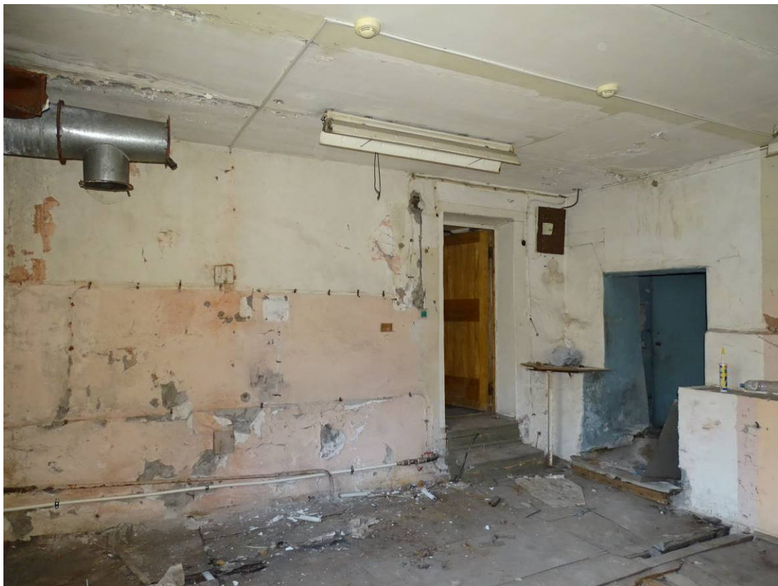
Илл. 3. Цокольный и 1-й этаж. Пом. 36/31,0. Съемка 08.02.2024 г. Трушковский В.Э.
