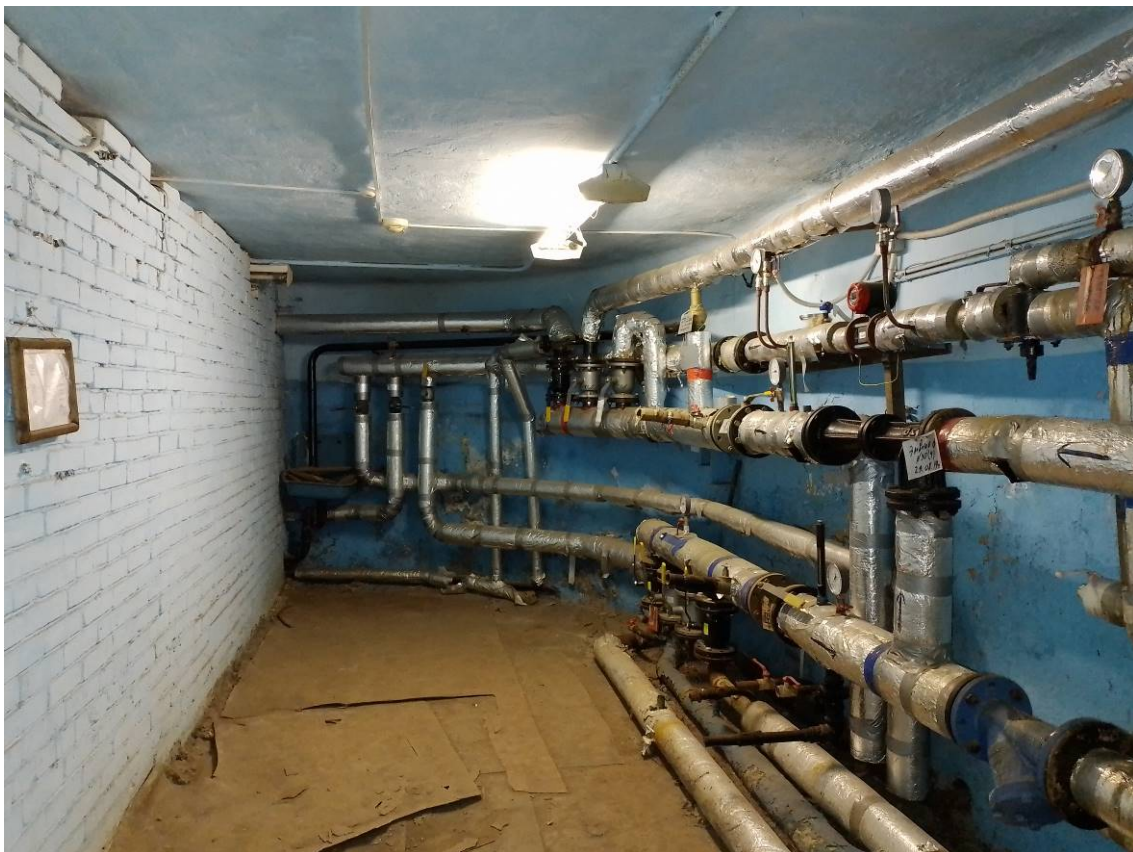
Илл. 18. Цокольный и 1-й этаж. Пом. 17/38,0. Съемка 08.02.2024 г. Трушковский В.Э.
