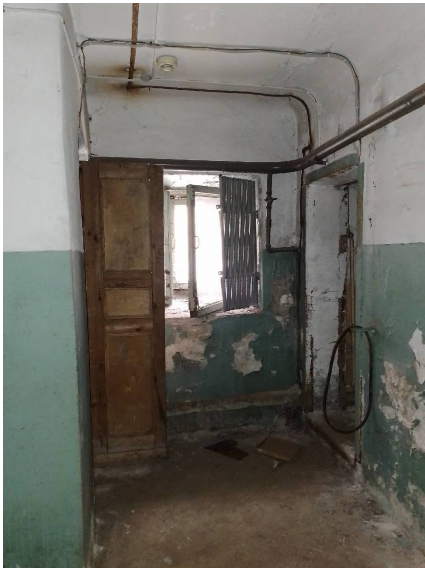
Илл. 20. Цокольный и 1-й этаж. Пом. 10/6,7. Съемка 08.02.2024 г. Трушковский В.Э.
