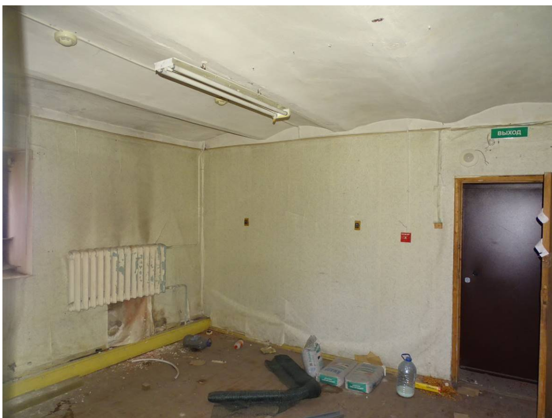
Илл. 4. Цокольный и 1-й этаж. Пом. 37/23,8. Съемка 08.02.2024 г. Трушковский В.Э.
