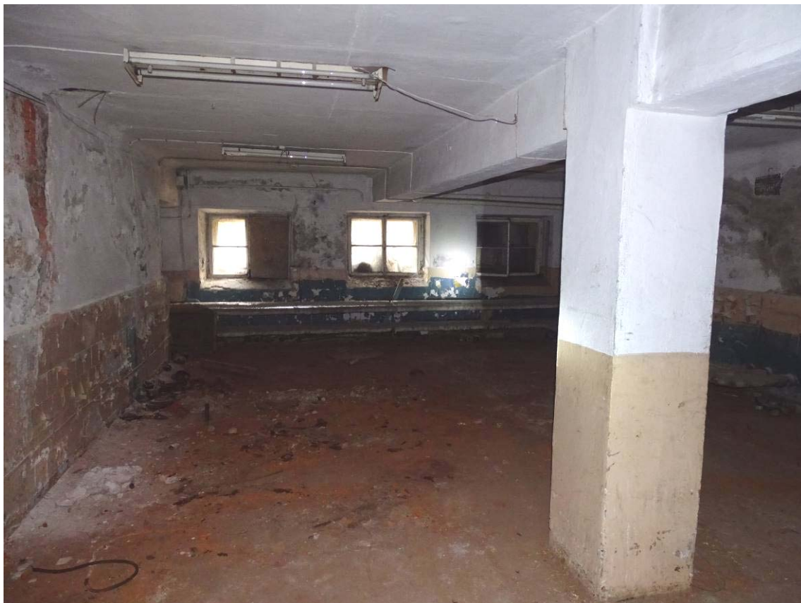
Илл. 15. Цокольный и 1-й этаж. Пом. 4/49,8. Съемка 08.02.2024 г. Трушковский В.Э.
