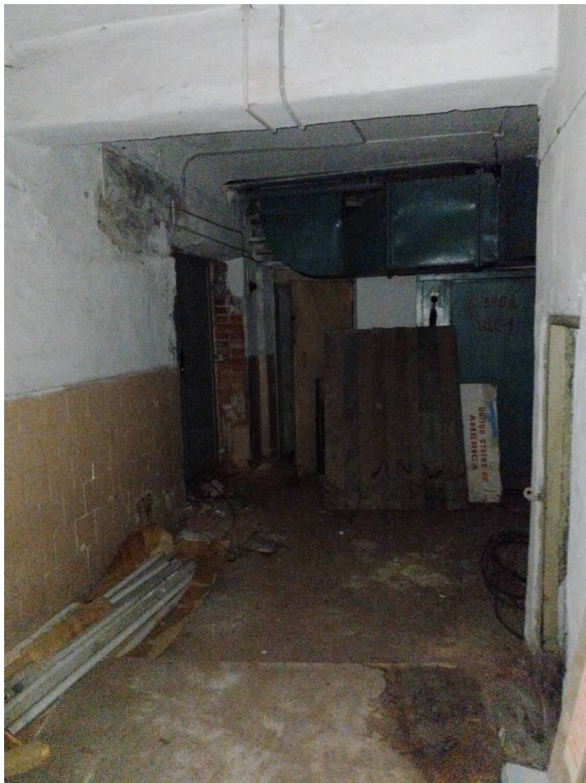
Илл. 21. Цокольный и 1-й этаж. Пом. 8/24,5. Съемка 08.02.2024 г. Трушковский В.Э.
