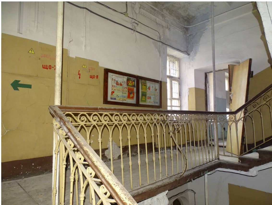
Илл. 2. 2-й этаж. Центральная лестница. Съемка 08.02.2024 г. Трушковский В.Э.
