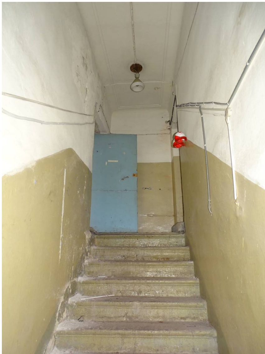
Илл. 2. Цокольный и 1-й этаж. Лестница. Съемка 08.02.2024 г. Трушковский В.Э.
