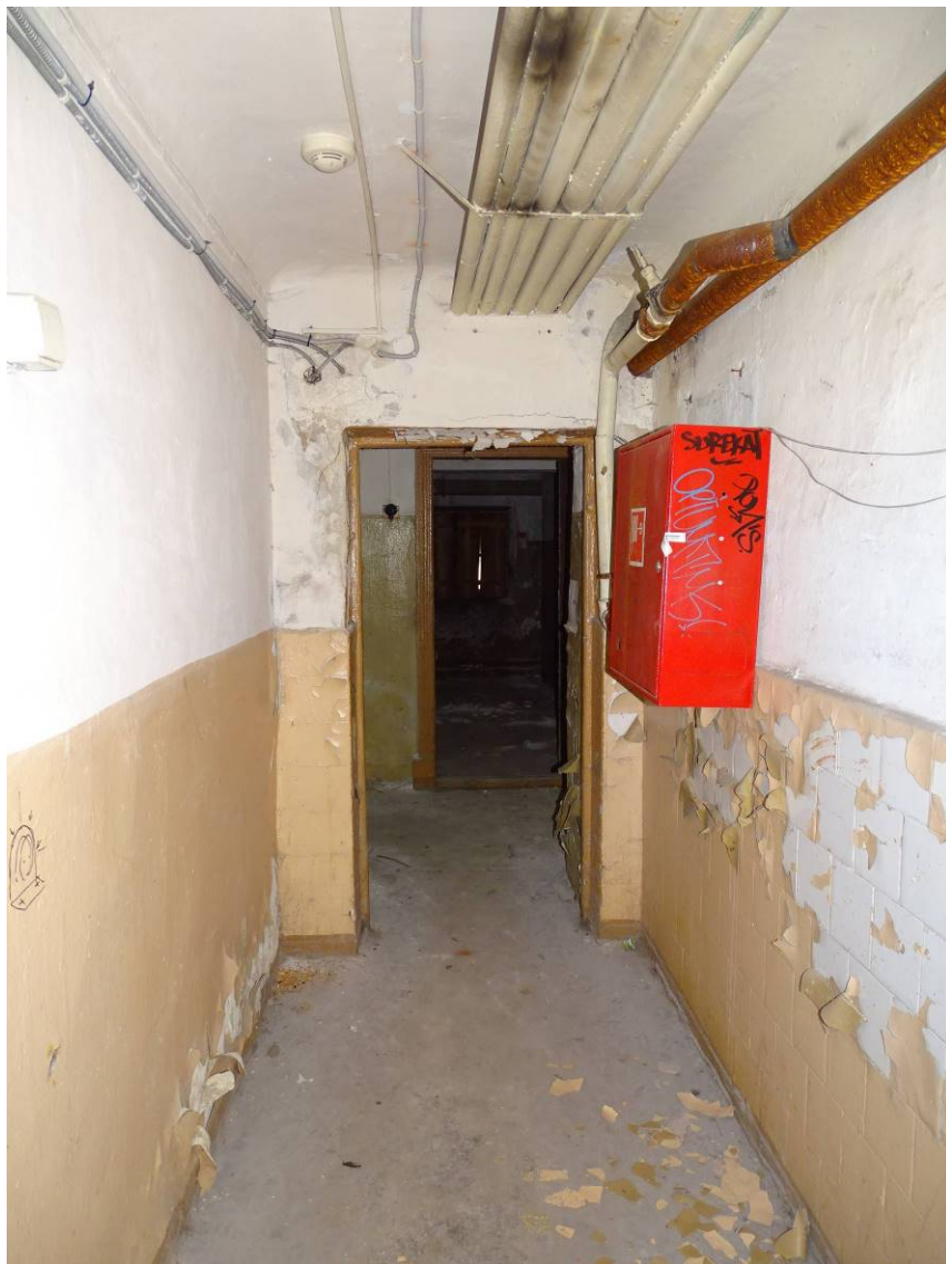
Илл. 6. Цокольный и 1-й этаж. Пом. 28/4,9. Съемка 08.02.2024 г. Трушковский В.Э.
