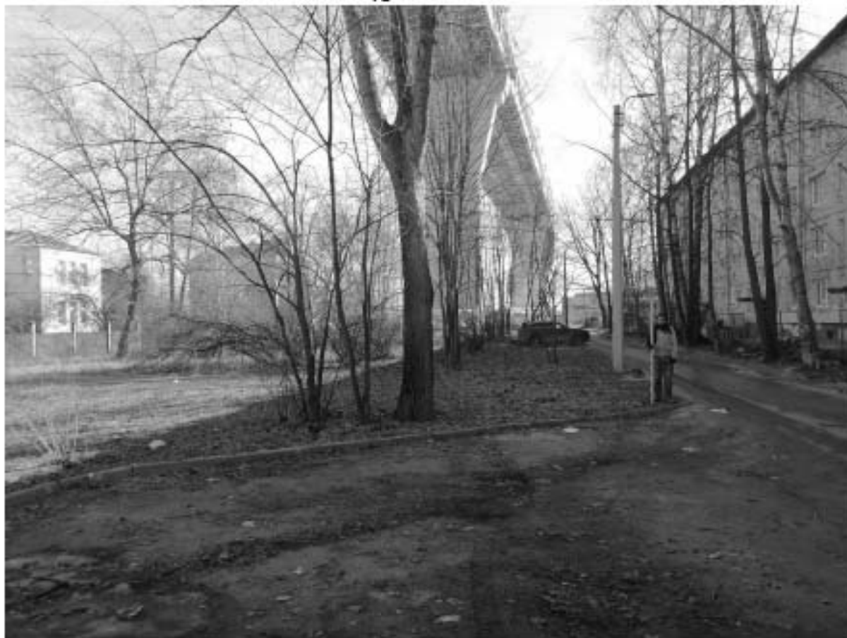
Рис. 11. Санкт-Петербург, Кировский район, Канонерский остров, дом 33, литер А. Точка фотофиксации №3, вид на восток.
