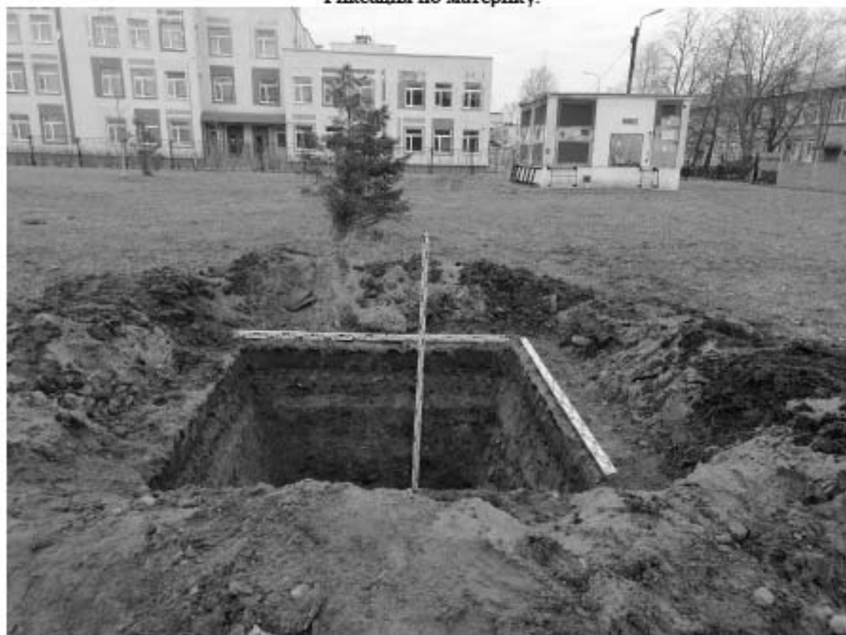
Рис. 20. Санкт-Петербург, Кировский район, Канонерский остров, дом 33, литер А. Шурф 1. Фиксация по матерiku. Вид на север.
