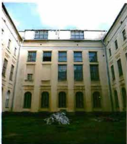
9. Фасады юго-западного двора
