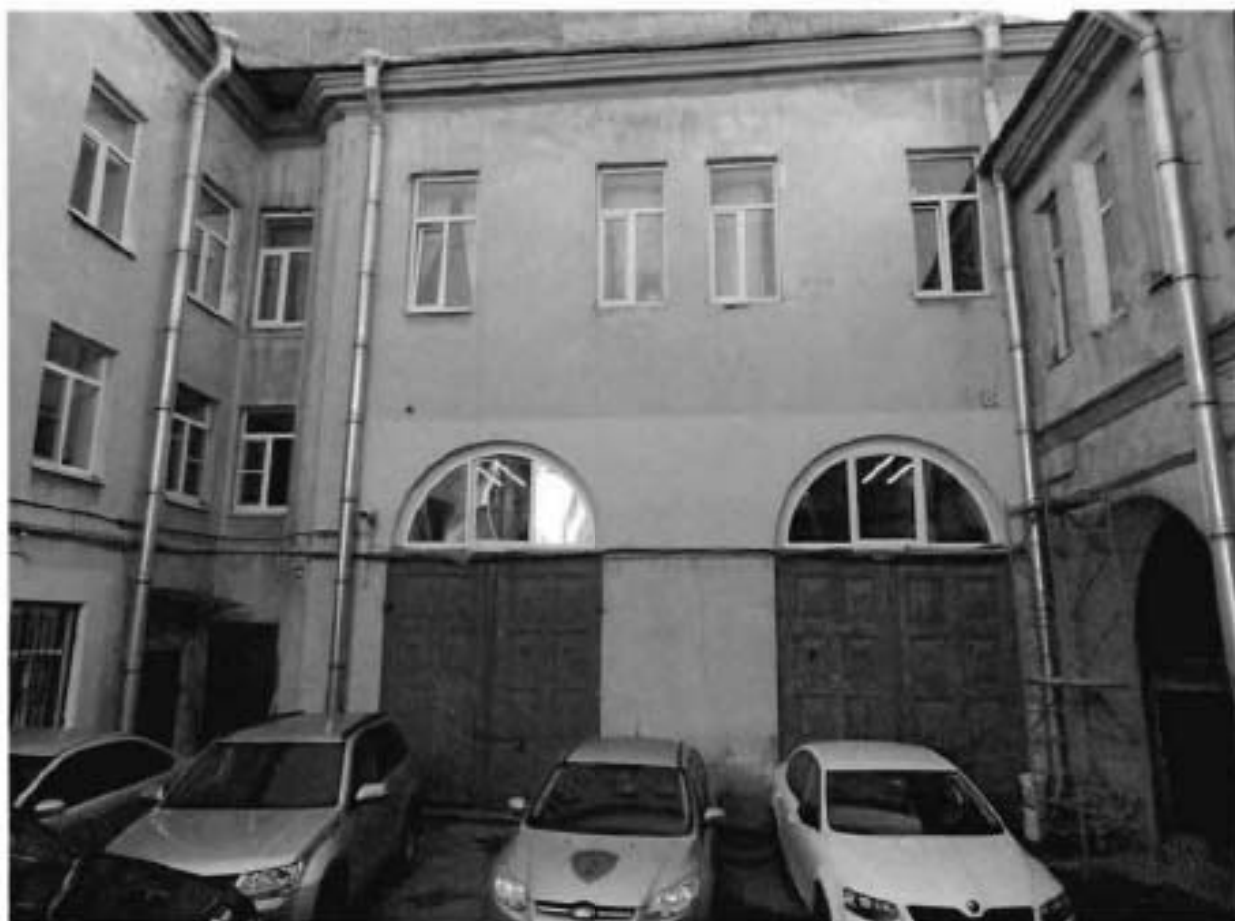
5. Южный дворовый фасад
