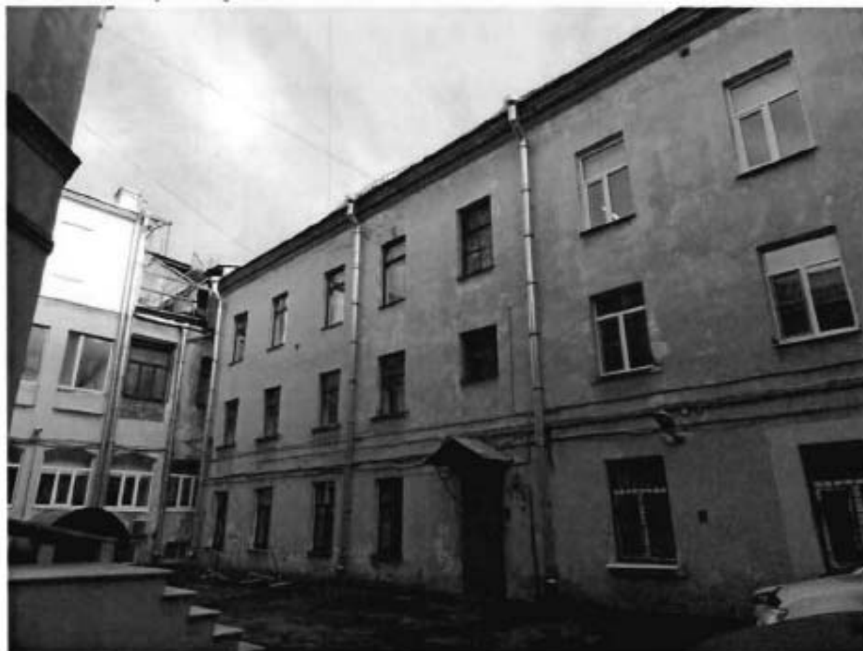
6. Восточный дворовый фасад
