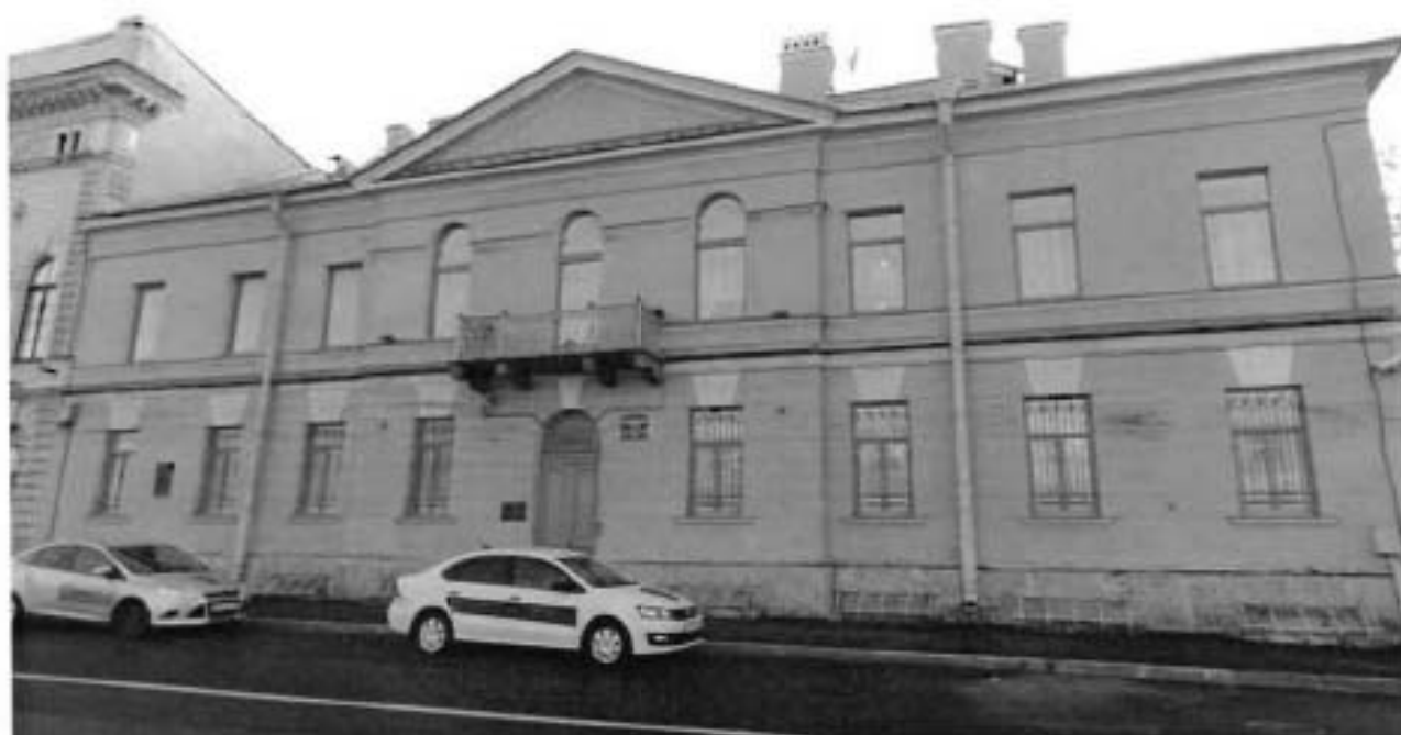
2. Фасад по Английской набережной
