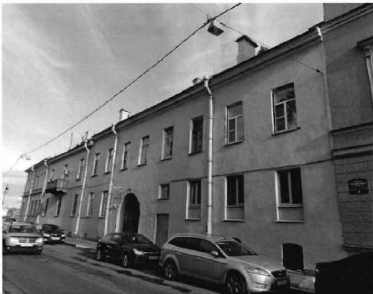
3. Фасад по набережной Ново-Адмиралтейского канала
