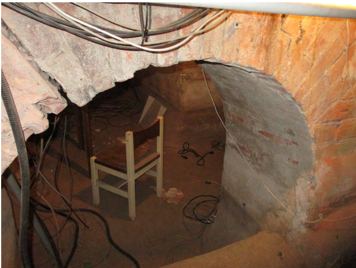
21. Объект культурного наследия регионального значения «Дом В.П. Осетрова» по адресу: г. Санкт-Петербург, ул. Вакуленчука, дом 4, литера А. Клинчатая арка в подвале.
