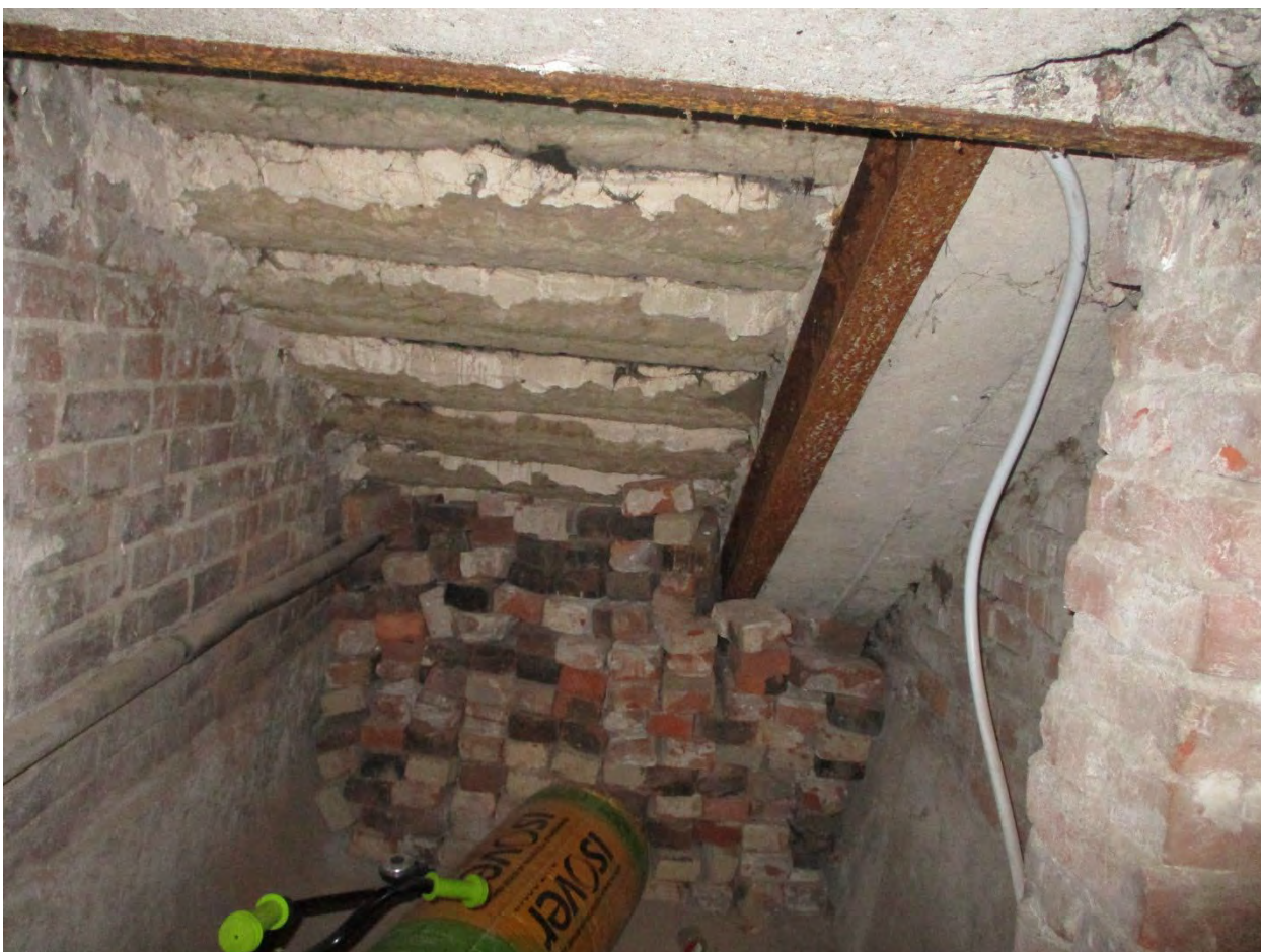
15. Объект культурного наследия регионального значения «Дом В.П. Осетрова» по адресу: г. Санкт-Петербург, ул. Вакуленчука, дом 4, литера А. Подлестничное пространство в подвале.
