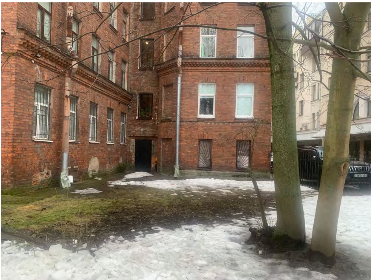
5. Объект культурного наследия регионального значения «Дом В.П. Осетрова» по адресу: г. Санкт-Петербург, ул. Вакулчука, дом 4, литера А. Фрагмент фасада. Вид с востока.
