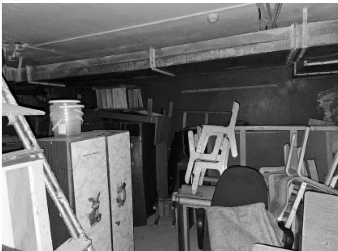
23. Выявленный объект культурного наследия «Особняк Е.А. Брюн», по адресу: г. Санкт-Петербург, Почтамтская ул., д. 19-21, лит. А. Фрагмент пом. 1-Н (1) в уровне цокольного этажа.
