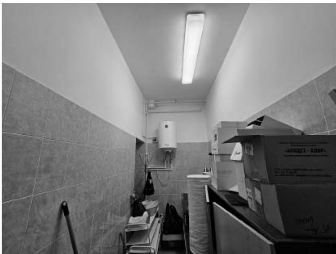
51. Выявленный объект культурного наследия «Особняк Корсаковой», по адресу: г. Санкт-Петербург, Почтамтская ул., д. 19-21, лит. А. Общий вид пом. 4-Н (4) в уровне 1-го этажа.
