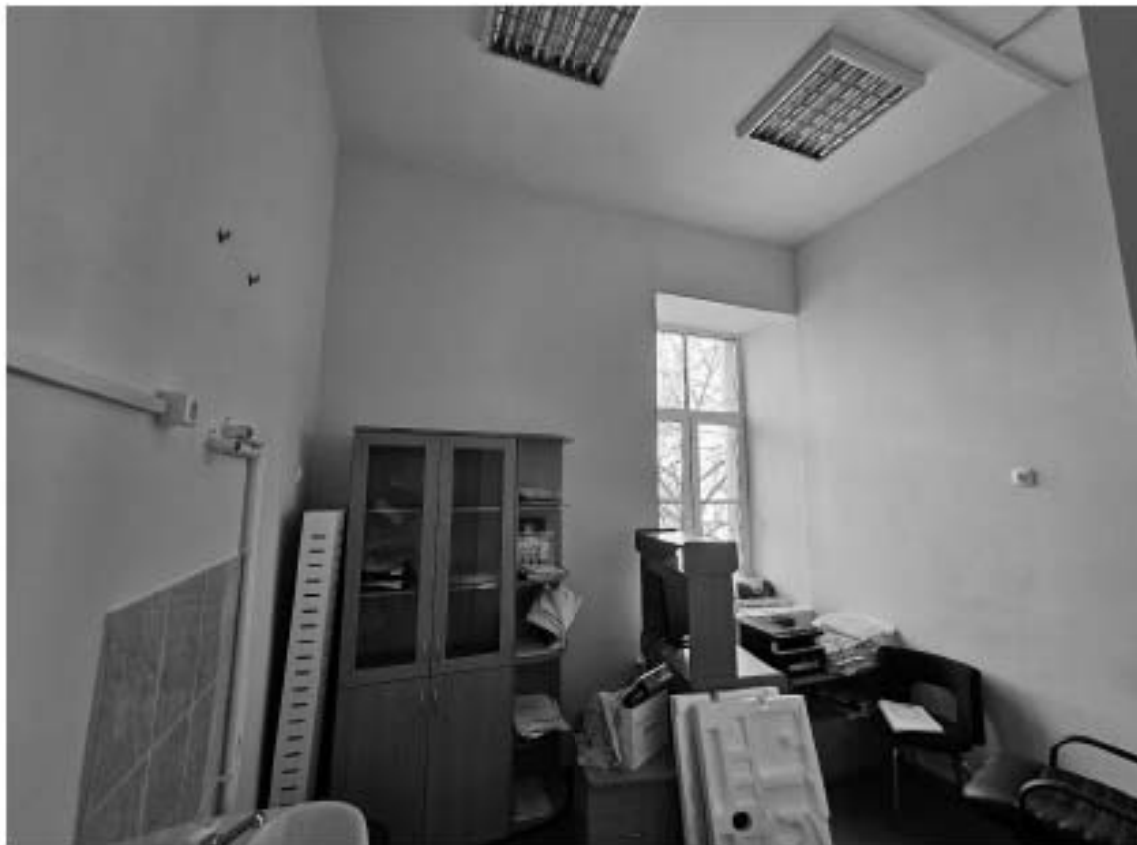
104. Выявленный объект культурного наследия «Особняк Корсаковой», по адресу: г. Санкт-Петербург, Почтамтская ул., д. 19-21, лит. А. Общий вид пом. 10-Н (10) в уровне 2-го этажа.
