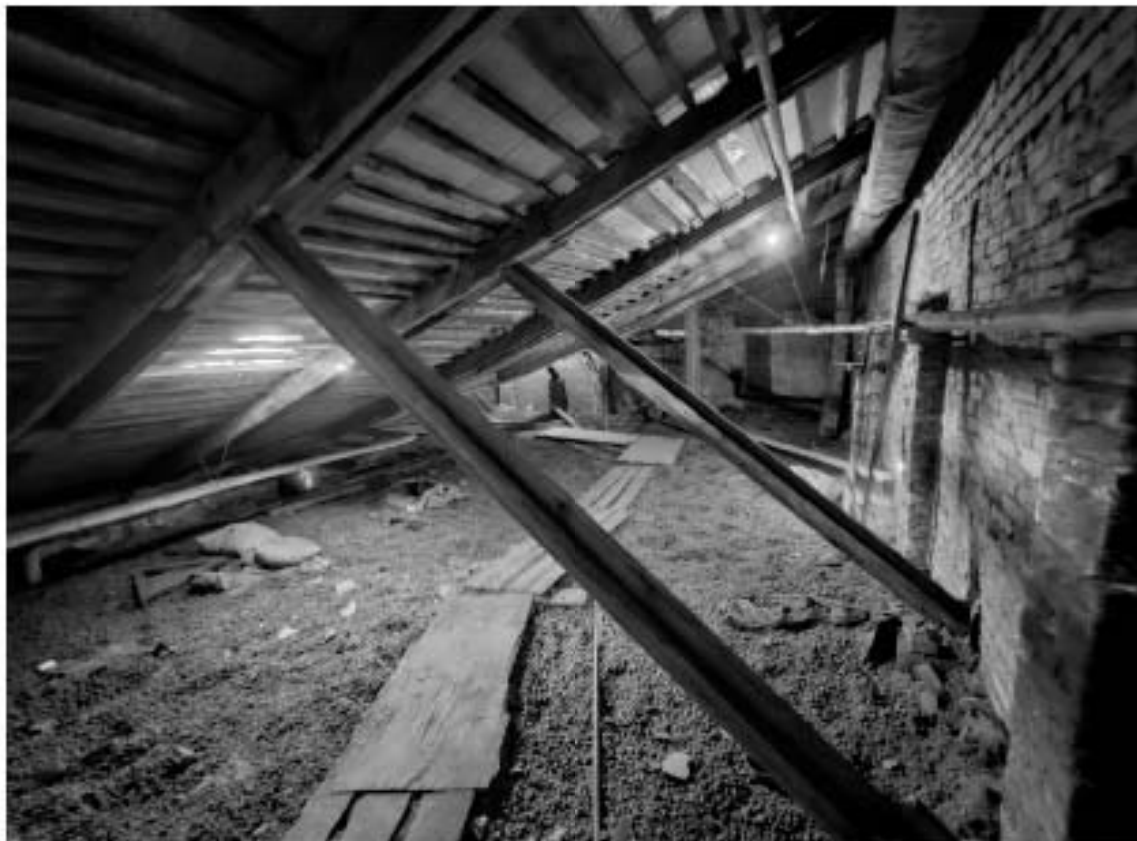
117. Выявленный объект культурного наследия «Особняк Е.А. Брюн», по адресу: г. Санкт-Петербург, Почтамтская ул., д. 19-21, лит. А. Фрагмент стропильной системы односкатной крыши северо-восточного дворового корпуса.
