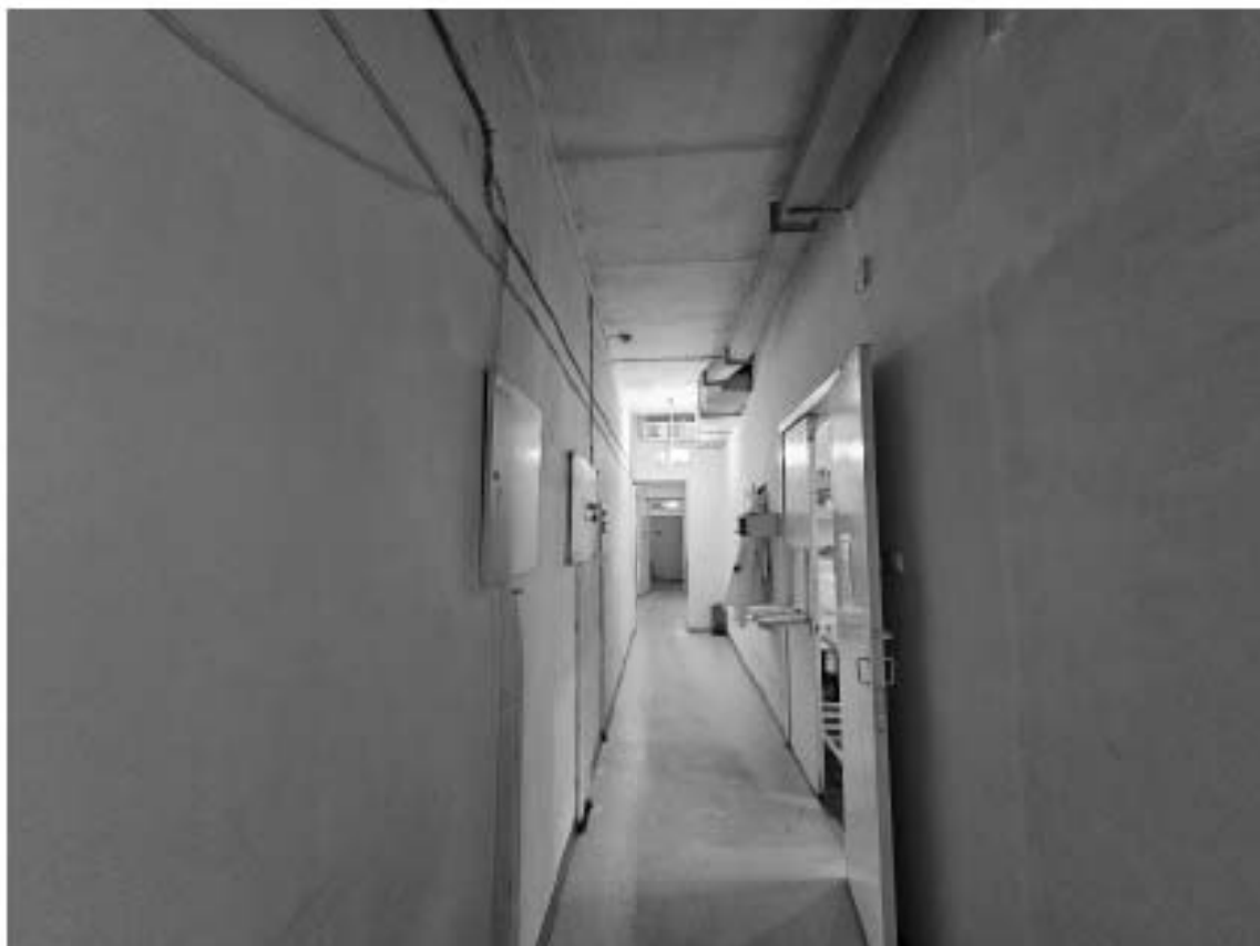
72. Выявленный объект культурного наследия «Особняк Е.А. Брюн», по адресу: г. Санкт-Петербург, Почтамтская ул., д. 19-21, лит. А. Общий вид пом. 8-Н (1) в уровне 1-го этажа.
