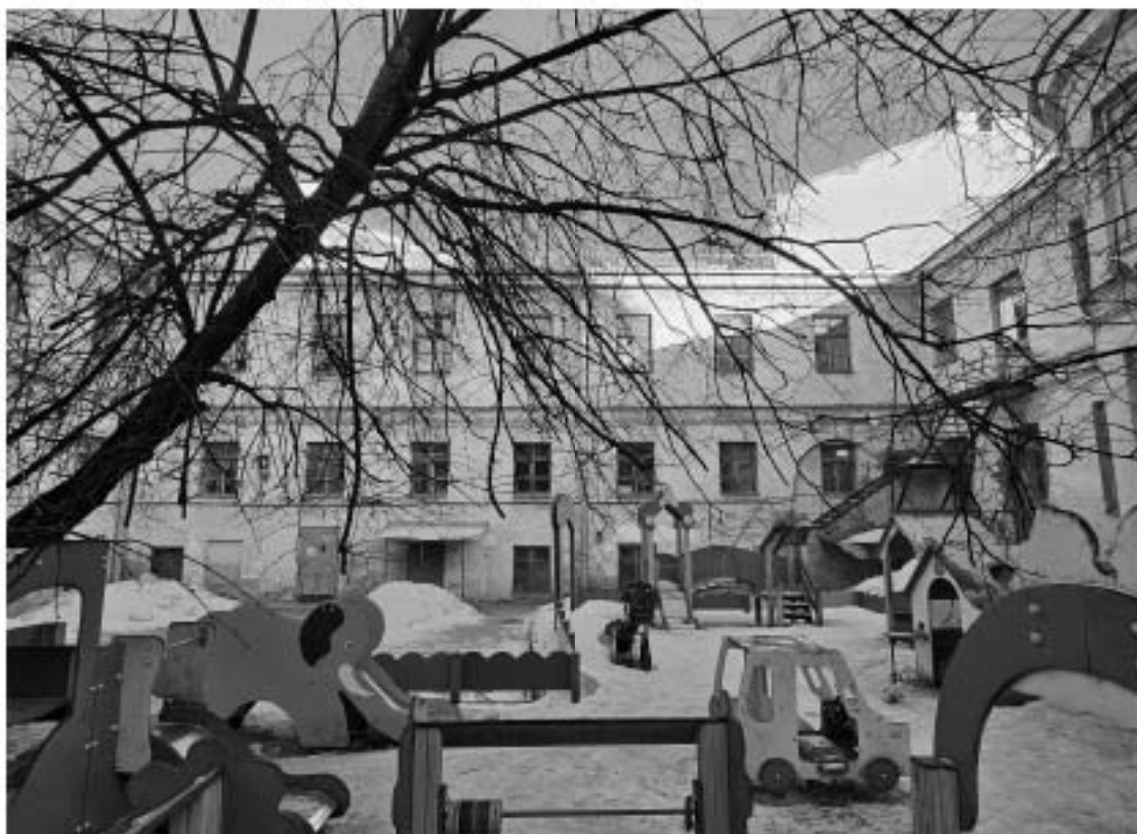
12. Общий вид юго-западного дворового фасада северо-восточного дворового корпуса выявленного объекта культурного наследия «Особняк Е.А. Брюн», по адресу: г. Санкт-Петербург, Почтамтская ул., д. 19-21, лит. А.
