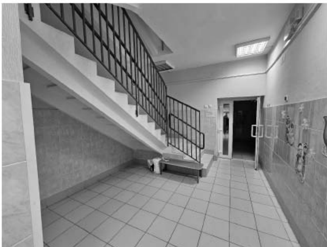
40. Выявленный объект культурного наследия «Особняк Корсаковой», по адресу: г. Санкт-Петербург, Почтамтская ул., д. 19-21, лит. А. Общий вид лестницы Л-2 в уровне 1-го этажа.
