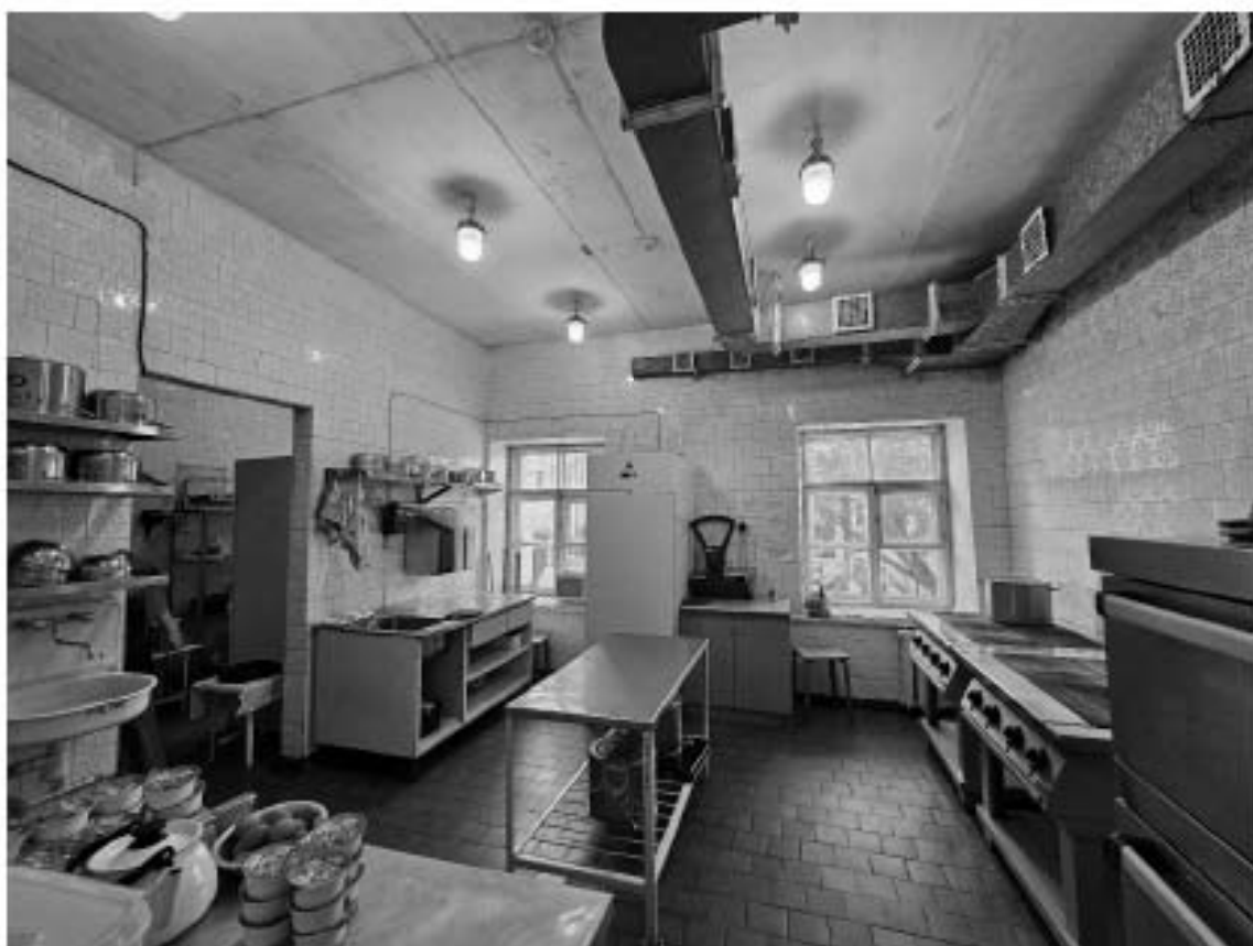
70. Выявленный объект культурного наследия «Особняк Е.А. Брюн», по адресу: г. Санкт-Петербург, Почтамтская ул., д. 19-21, лит. А. Общий вид пом. 8-Н (5) в уровне 1-го этажа.
