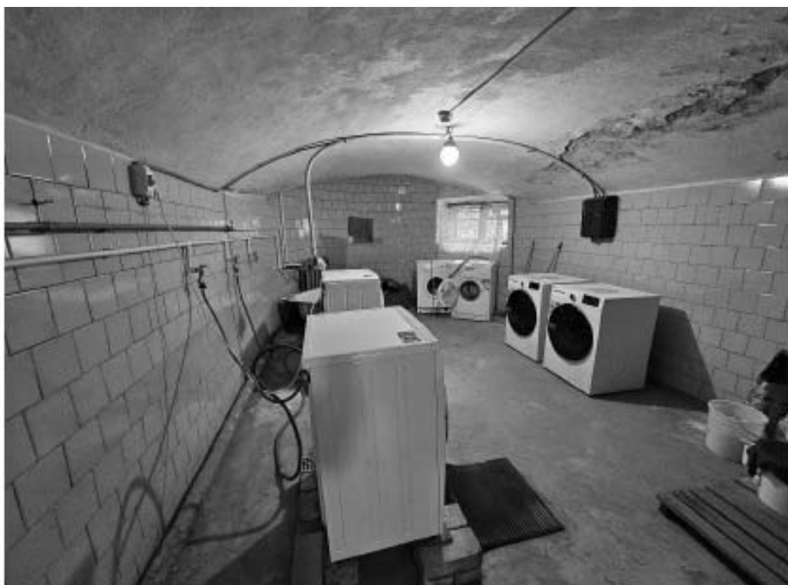
33. Выявленный объект культурного наследия «Особняк Е.А. Брюн», по адресу: г. Санкт-Петербург, Почтамтская ул., д. 19-21, лит. А. Общий вид пом. 1-Н (11) в уровне цокольного этажа.
