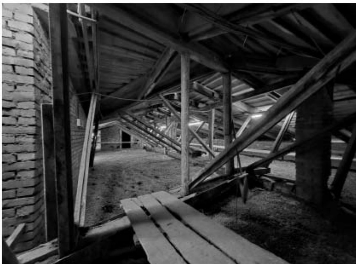
124. Выявленный объект культурного наследия «Особняк Корсаковой», по адресу: г. Санкт-Петербург, Почтамтская ул., д. 19-21, лит. А. Общий вид стропильной системы двускатной крыши лицевого корпуса.
