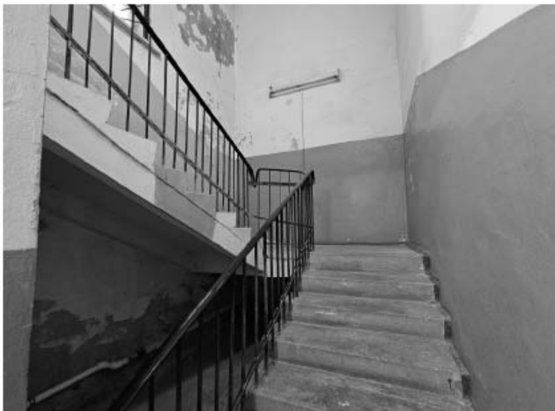
20. Выявленный объект культурного наследия «Особняк Е.А. Брюн», по адресу: г. Санкт-Петербург, Почтамтская ул., д. 19-21, лит. А. Общий вид лестницы Л-4 в уровне цокольного этажа.
