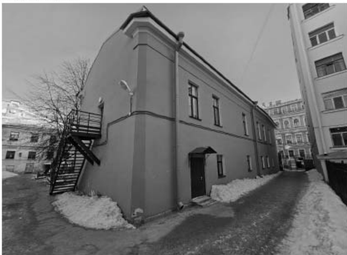
6. Выявленный объект культурного наследия «Особняк Корсаковой», по адресу: г. Санкт-Петербург, Почтамтская ул., д. 19-21, лит. А. Боковой юго-западный и торцевой северо-западный фасады дворового корпуса.
