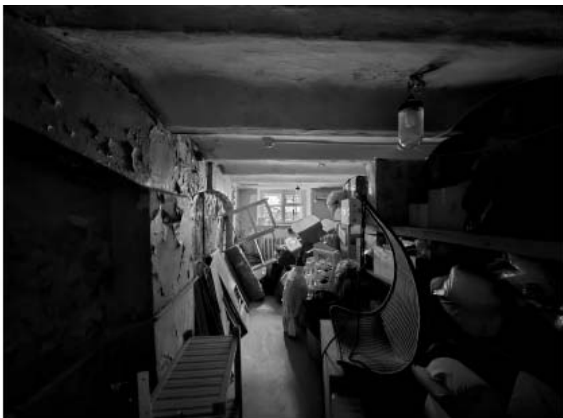
27. Выявленный объект культурного наследия «Особняк Е.А. Брюн», по адресу: г. Санкт-Петербург, Почтамтская ул., д. 19-21, лит. А. Общий вид пом. 1-Н (6) в уровне цокольного этажа.
