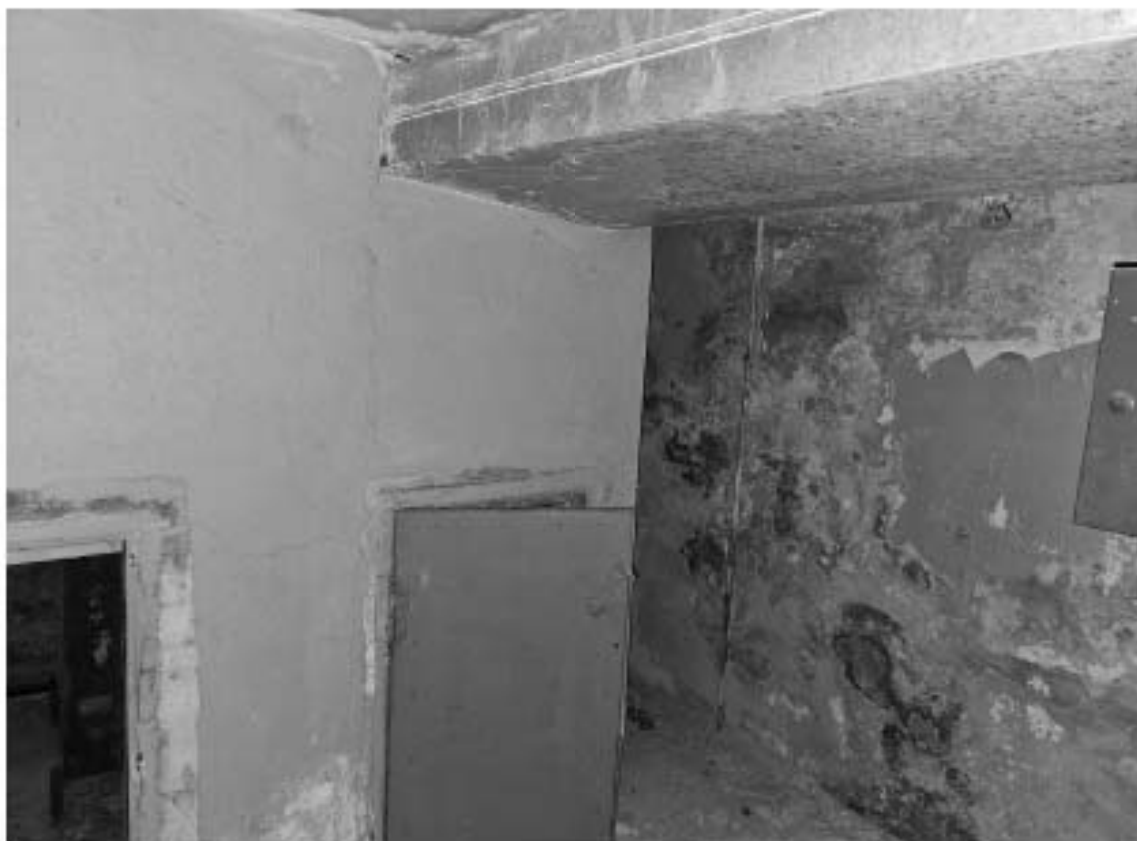
24. Выявленный объект культурного наследия «Особняк Е.А. Брюн», по адресу: г. Санкт-Петербург, Почтамтская ул., д. 19-21, лит. А. Фрагмент пом. 1-Н (3) в уровне цокольного этажа.
