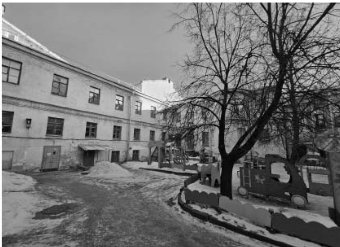
9. Общий вид северо-западного дворового фасада лицевого корпуса и юго-западного дворового фасада северо-восточного дворового корпуса выявленного объекта культурного наследия «Особняк Е.А. Брюн», по адресу: г. Санкт-Петербург, Почтамтская ул., д. 19-21, лит. А.
