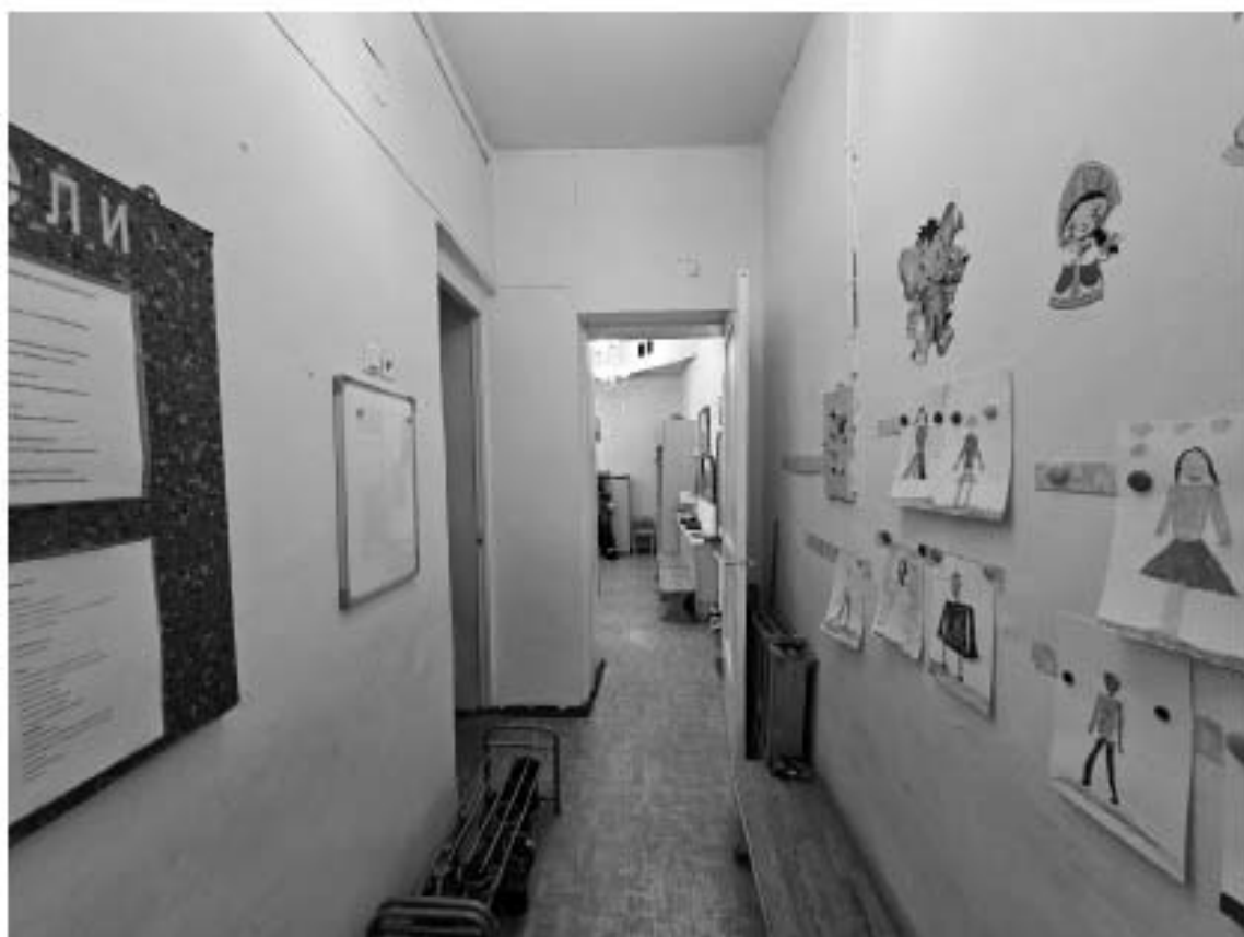
74. Выявленный объект культурного наследия «Особняк Е.А. Брюн», по адресу: г. Санкт-Петербург, Почтамтская ул., д. 19-21, лит. А. Общий вид пом. 9-Н (1) в уровне 1-го этажа.
