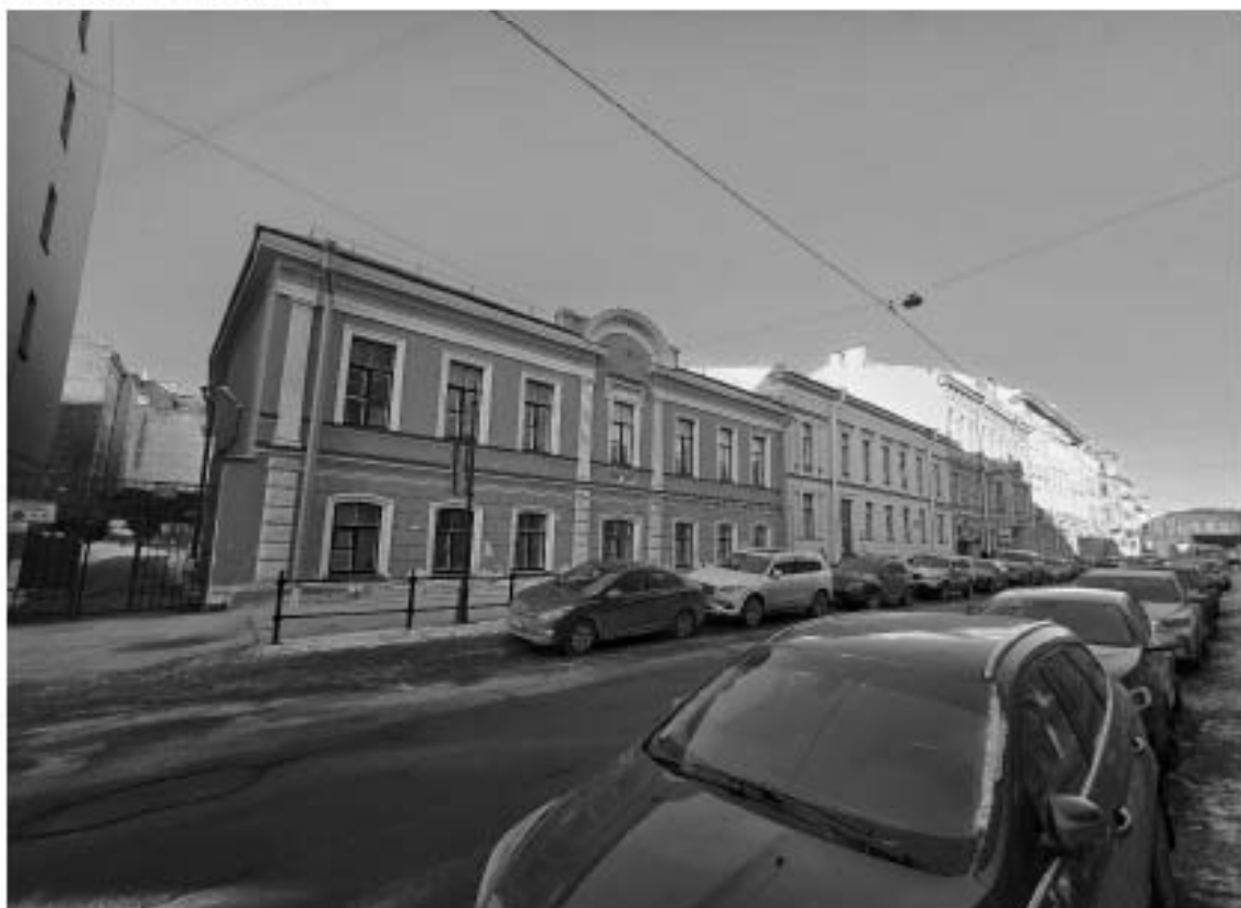
4. Выявленные объекты культурного наследия «Особняк Корсаковой» и «Особняк Е.А. Брюн» в перспективе Почтамтской улицы. На переднем плане лицевой юго-восточный фасад выявленного объекта культурного наследия «Особняк Корсаковой».
