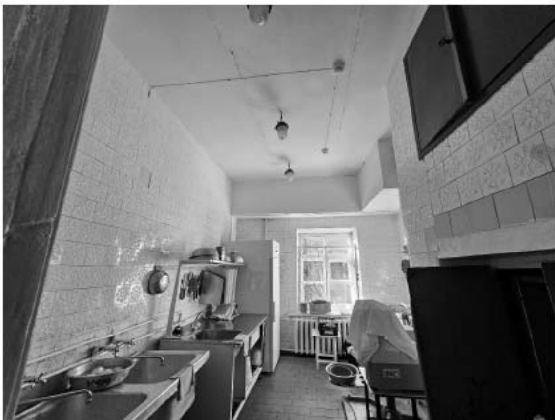
71. Выявленный объект культурного наследия «Особняк Е.А. Брюн», по адресу: г. Санкт-Петербург, Почтамтская ул., д. 19-21, лит. А. Общий вид пом. 8-Н (6) в уровне 1-го этажа.
