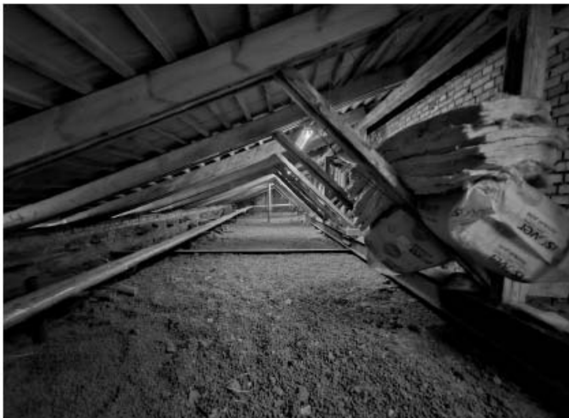
123. Выявленный объект культурного наследия «Особняк Корсаковой», по адресу: г. Санкт-Петербург, Почтамтская ул., д. 19-21, лит. А. Общий вид стропильной системы двускатной крыши дворового корпуса.
