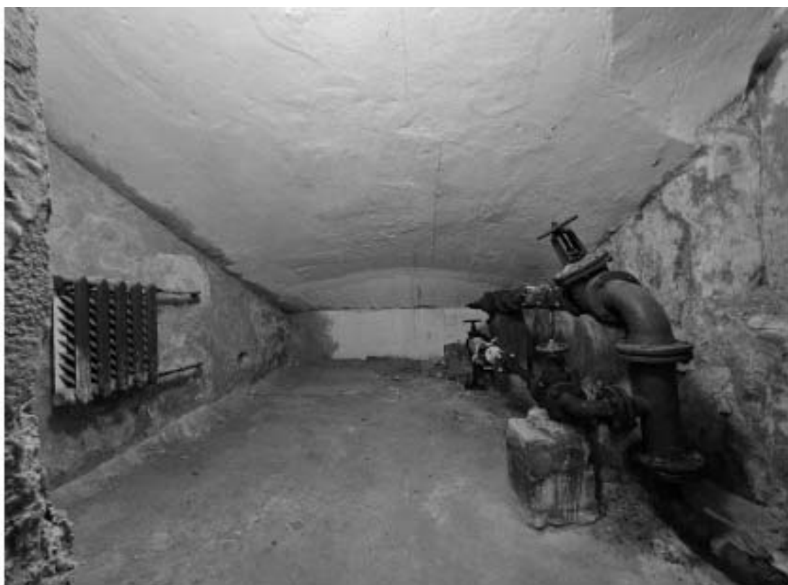
31. Выявленный объект культурного наследия «Особняк Е.А. Брюн», по адресу: г. Санкт-Петербург, Почтамтская ул., д. 19-21, лит. А. Общий вид пом. 1-Н (10) в уровне цокольного этажа.
