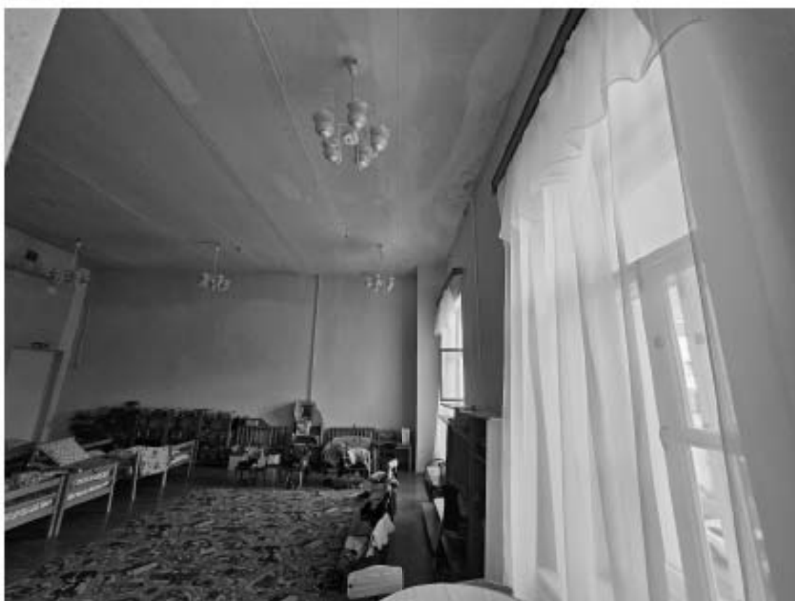
97. Выявленный объект культурного наследия «Особняк Е.А. Брюн», по адресу: г. Санкт-Петербург, Почтамтская ул., д. 19-21, лит. А. Общий вид пом. 12-Н (9) в уровне 2-го этажа.
