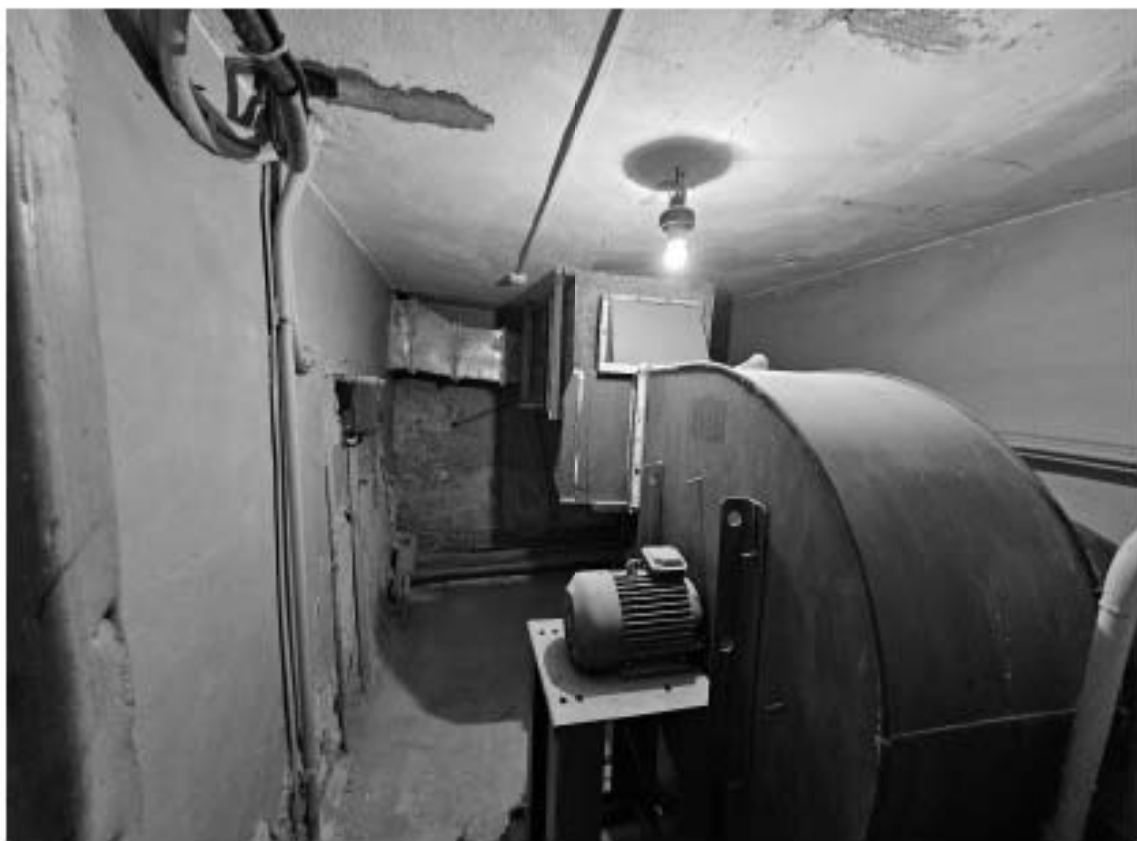
22. Выявленный объект культурного наследия «Особняк Е.А. Брюн», по адресу: г. Санкт-Петербург, Почтамтская ул., д. 19-21, лит. А. Общий вид пом. 1-Н (2) в уровне цокольного этажа.
