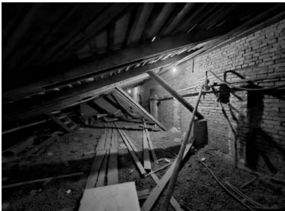
118. Выявленный объект культурного наследия «Особняк Е.А. Брюн», по адресу: г. Санкт-Петербург, Почтамтская ул., д. 19-21, лит. А. Фрагмент стропильной системы крыши северо-западного дворового корпуса.
