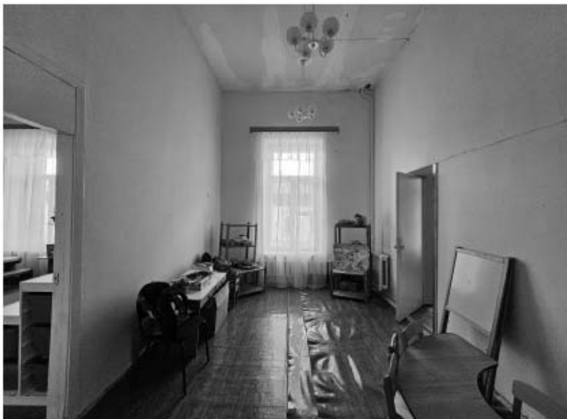
98. Выявленный объект культурного наследия «Особняк Е.А. Брюн», по адресу: г. Санкт-Петербург, Почтамтская ул., д. 19-21, лит. А. Общий вид пом. 12-Н (12) в уровне 2-го этажа.
