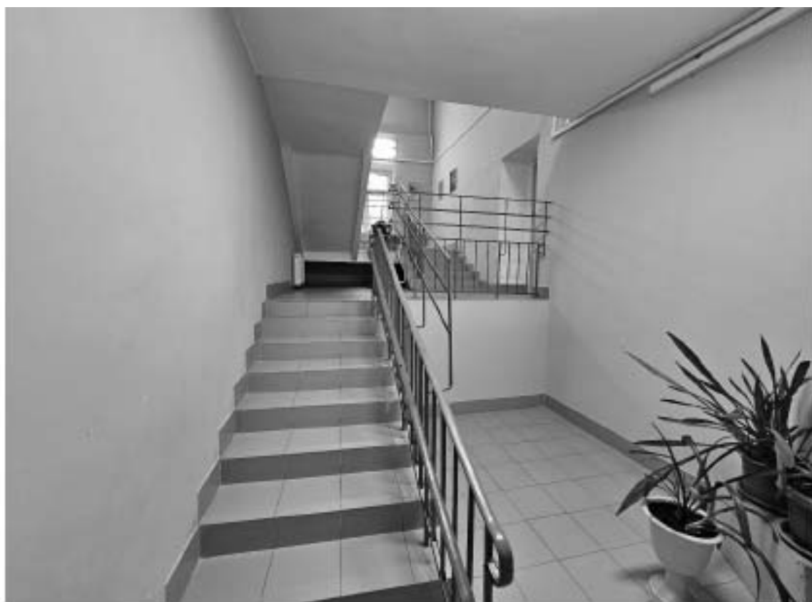
53. Выявленный объект культурного наследия «Особняк Е.А. Брюн», по адресу: г. Санкт-Петербург, Почтамтская ул., д. 19-21, лит. А. Междуэтажная лестница в западной части лицевого корпуса.
