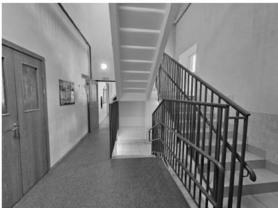
111. Выявленный объект культурного наследия «Особняк Корсаковой», по адресу: г. Санкт-Петербург, Почтамтская ул., д. 19-21, лит. А. Общий вид лестницы Л-2 в уровне 2-го этажа.
