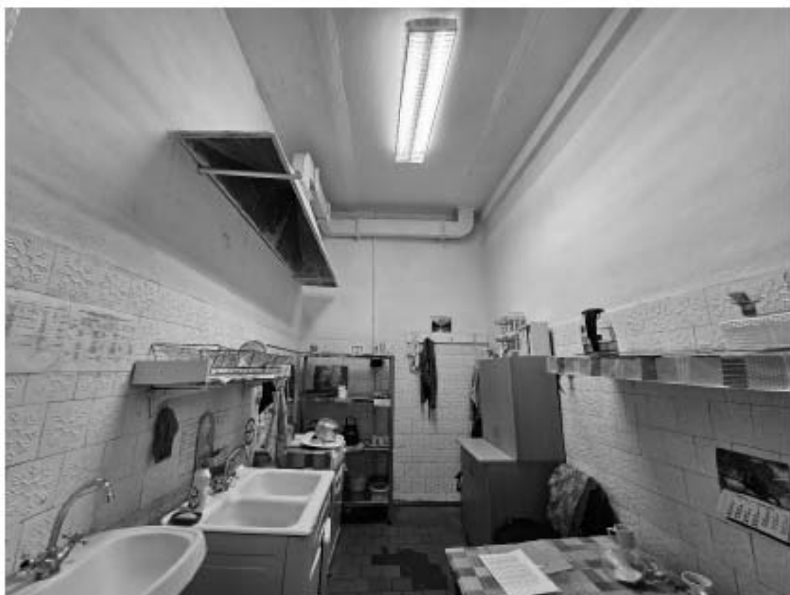
60. Выявленный объект культурного наследия «Особняк Е.А. Брюн», по адресу: г. Санкт-Петербург, Почтамтская ул., д. 19-21, лит. А. Общий вид пом. 7-Н(11) в уровне 1-го этажа.
