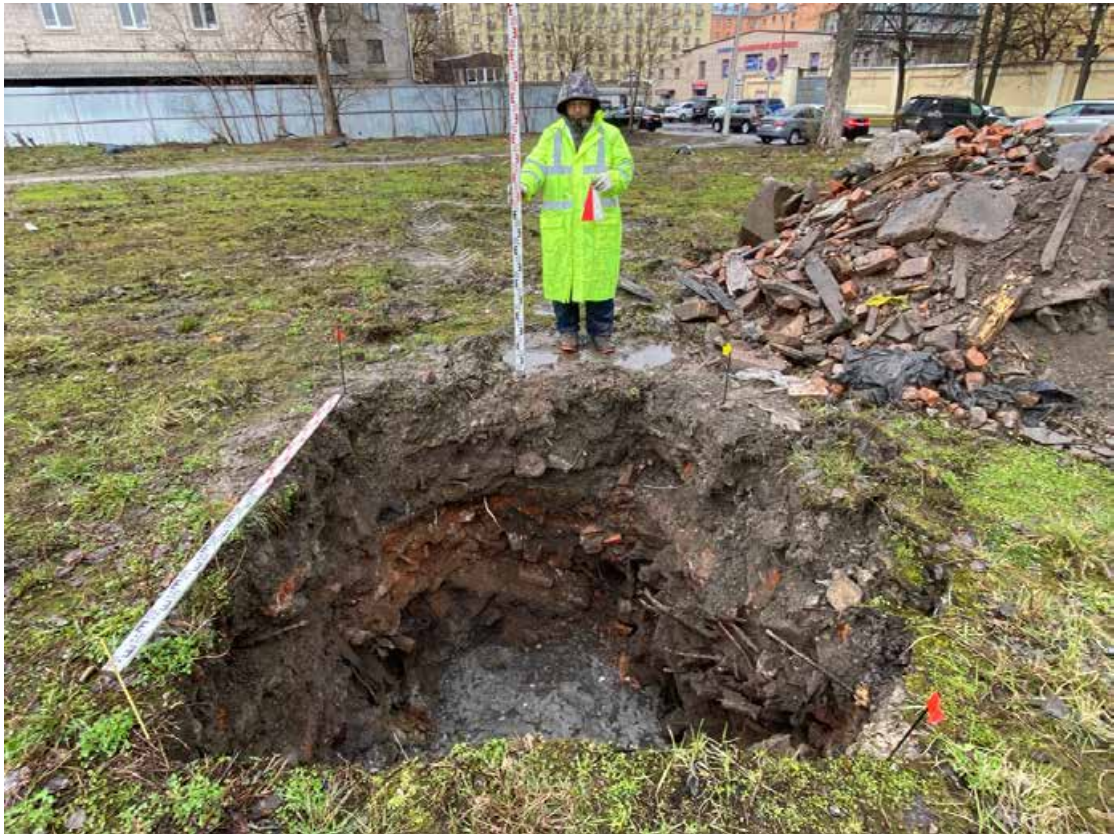
Рис. 43. СПб, Барочная улица, участок 1, (юго-восточнее дома 42, корпус 2, литера Д по улице Профессора Попова) (кадастровый номер: 78:07:0003203:110). Шурф 1. Уровень зачистки дна шурфа по слою строительного мусора. Вид с юга.
