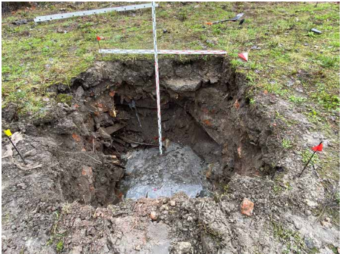
Рис. 44. СПб, Барочная улица, участок 1, (юго-восточнее дома 42, корпус 2, литера Д по улице Профессора Попова) (кадастровый номер: 78:07:0003203:110). Шурф 1. Уровень зачистки дна шурфа по слою строительного мусора. Вид с севера.
