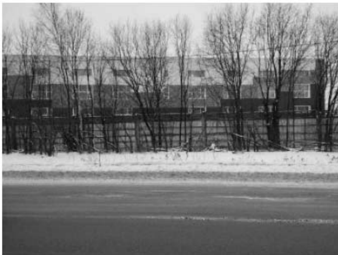
Илл. 13. Точка фотофиксации 2. Вид с севера.
