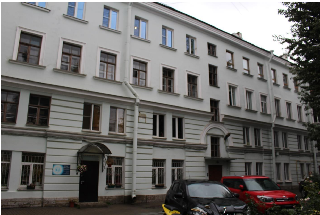
Фото 11. Вид на фасад дворового корпуса объекта культурного наследия регионального значения «Дом Васильевых».
