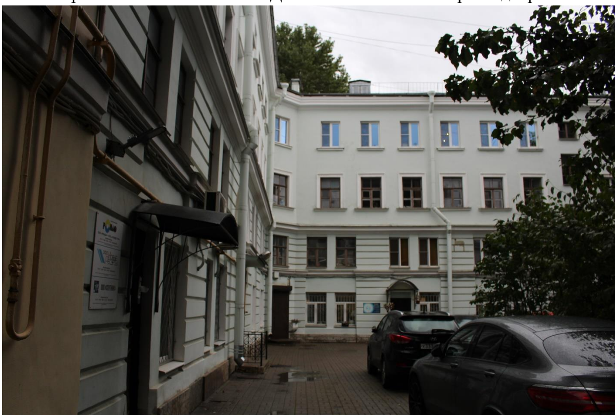
Фото 10. Вид на фасад дворового корпуса объекта культурного наследия регионального значения «Дом Васильевых».
