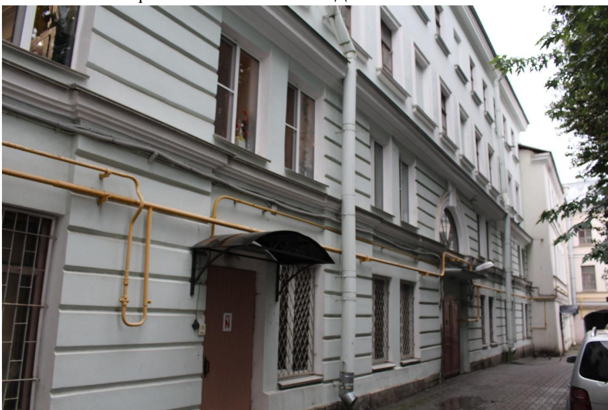
Фото 12. Вид на фасад дворового корпуса объекта культурного наследия регионального значения «Дом Васильевых».
