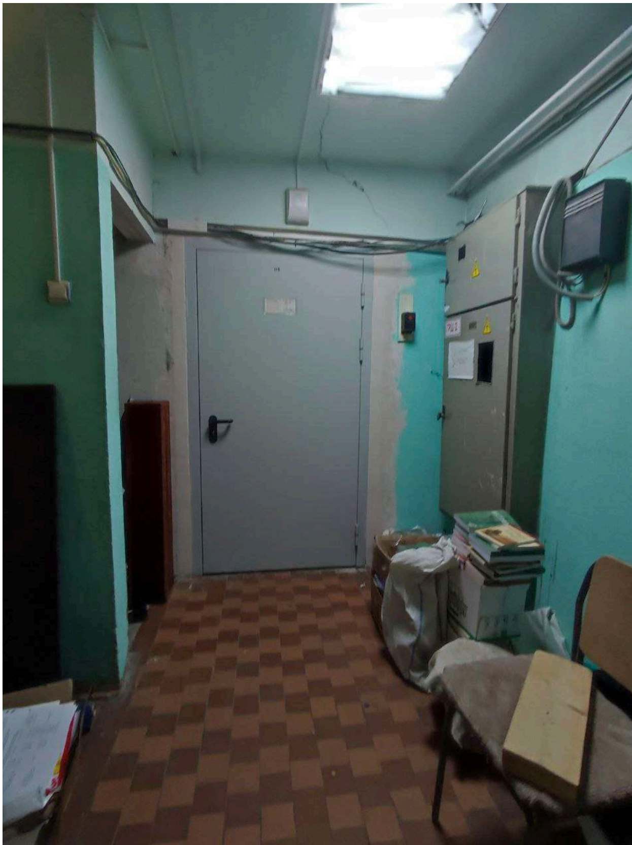
Фото 14. Общий вид на внутренние помещения 1-го этажа (№108).
