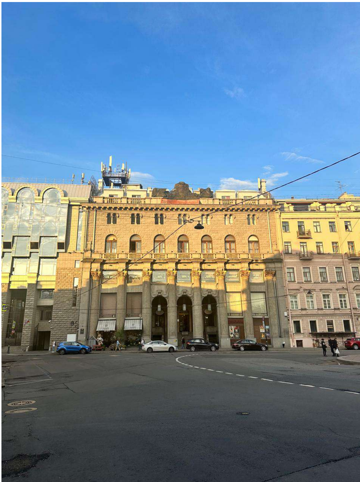
Фото 1. Общий вид лицевого фасада со стороны ул. Караванной объекта культурного наследия регионального значения «Дом Санкт-Петербургского губернского кредитного общества», расположенного по адресу: г. Санкт-Петербург, Караванная ул., 12, Фонтанки р.наб., 15.
