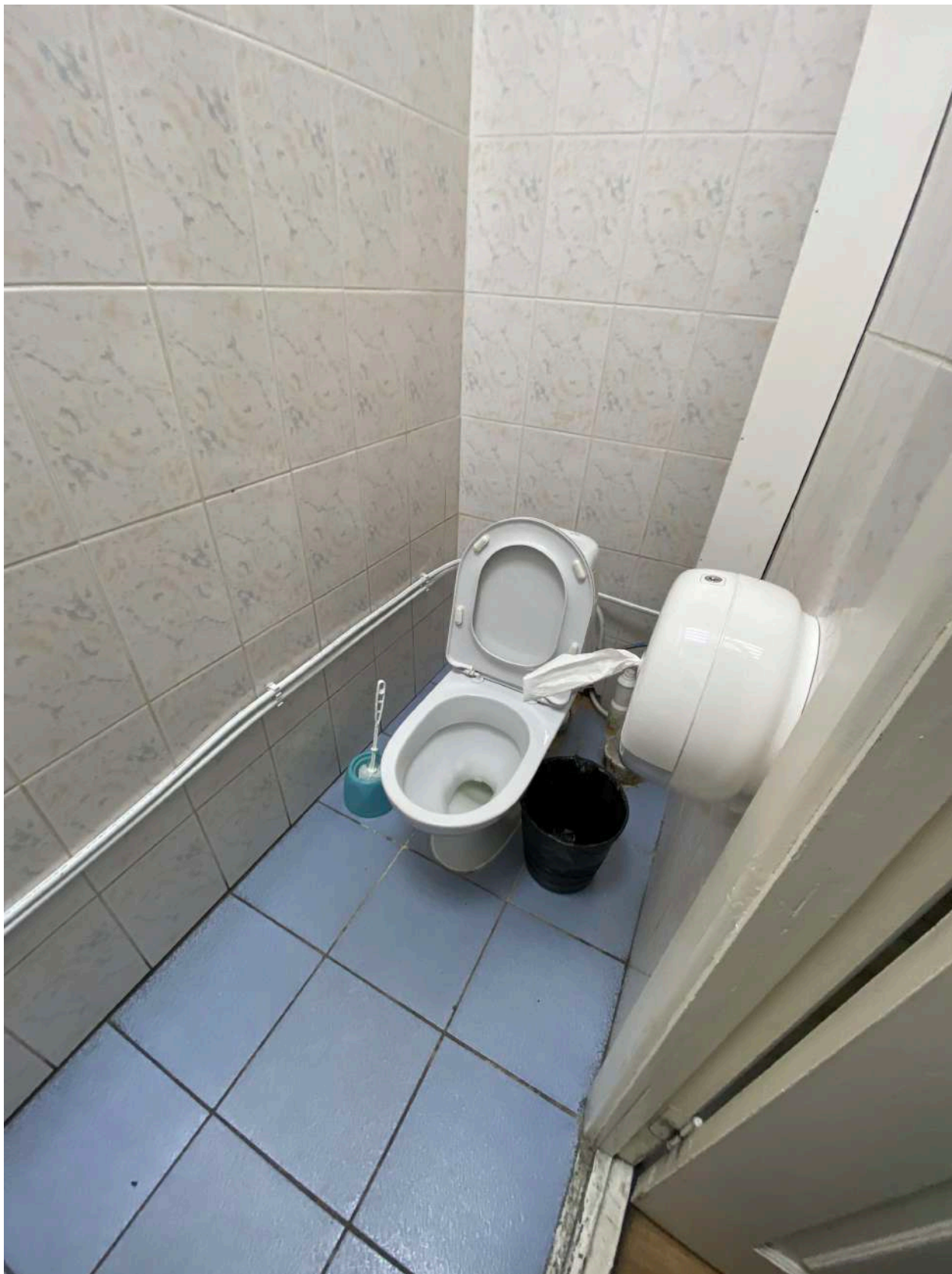
Фото 87. Общий вид на внутренние помещения 7-го этажа (№717).
