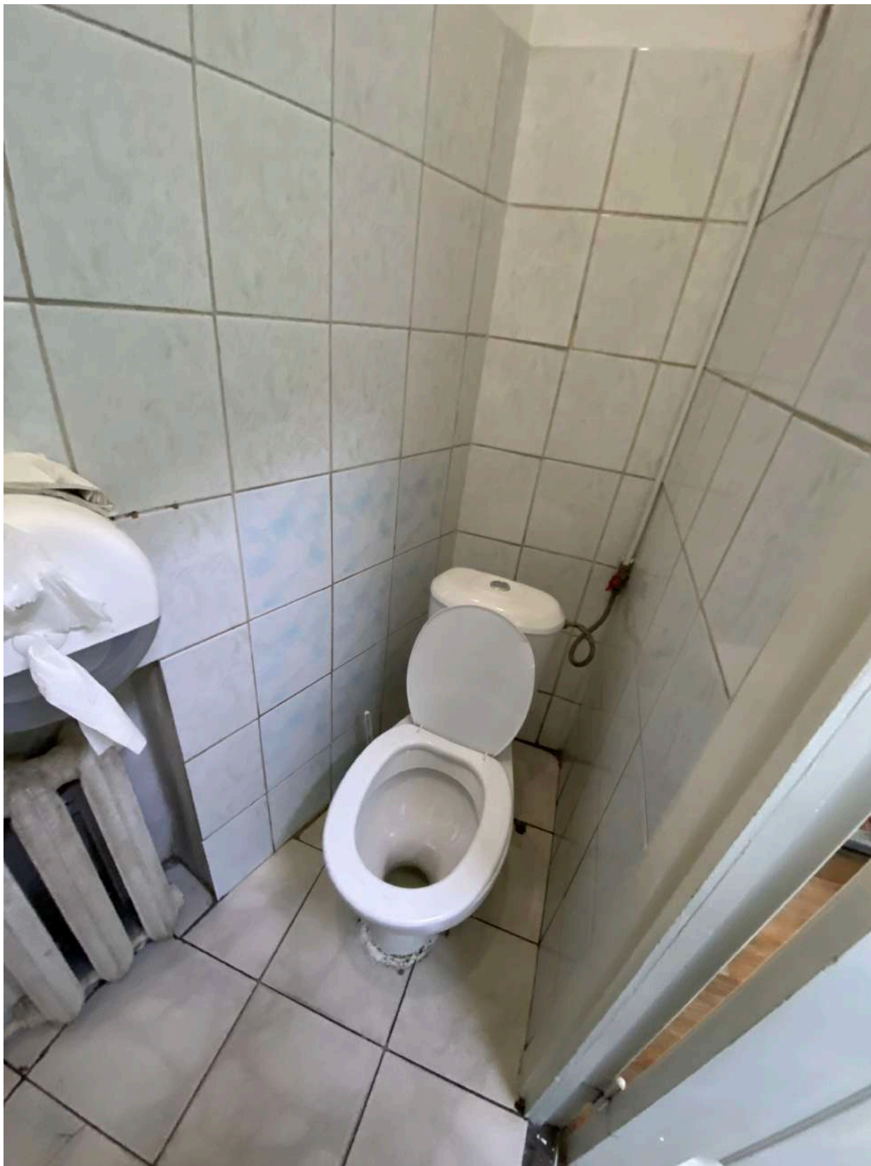
Фото 70. Общий вид на внутренние помещения 6-го этажа (№615).
