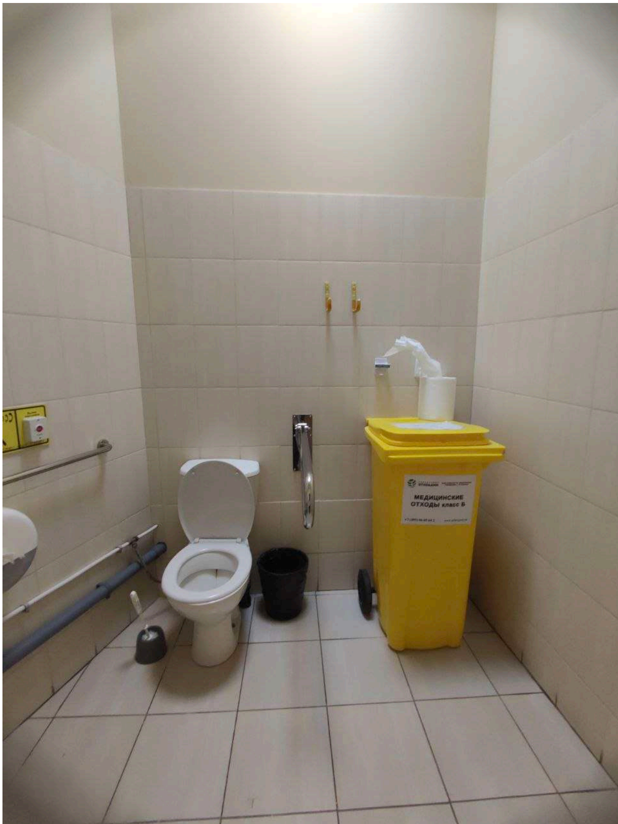
Фото 25. Общий вид на внутренние помещения 2-го этажа (№211).
