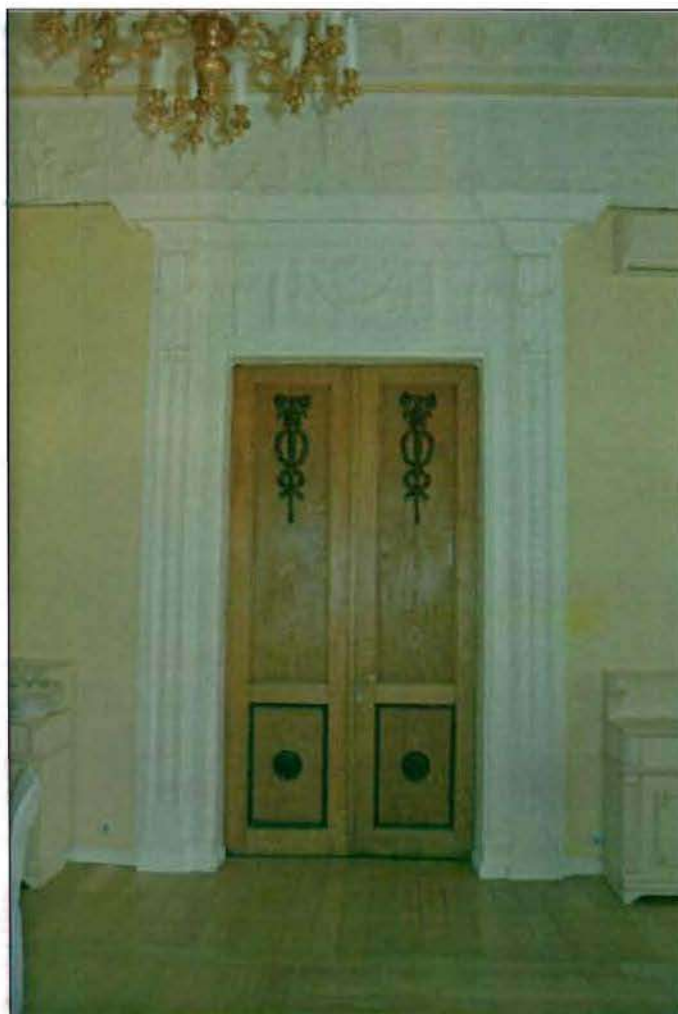
28. Оформление дверного проема (помещение 29-Н (ч. п. 3)).
