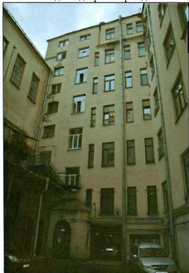
6. Северный дворовый фасад.
