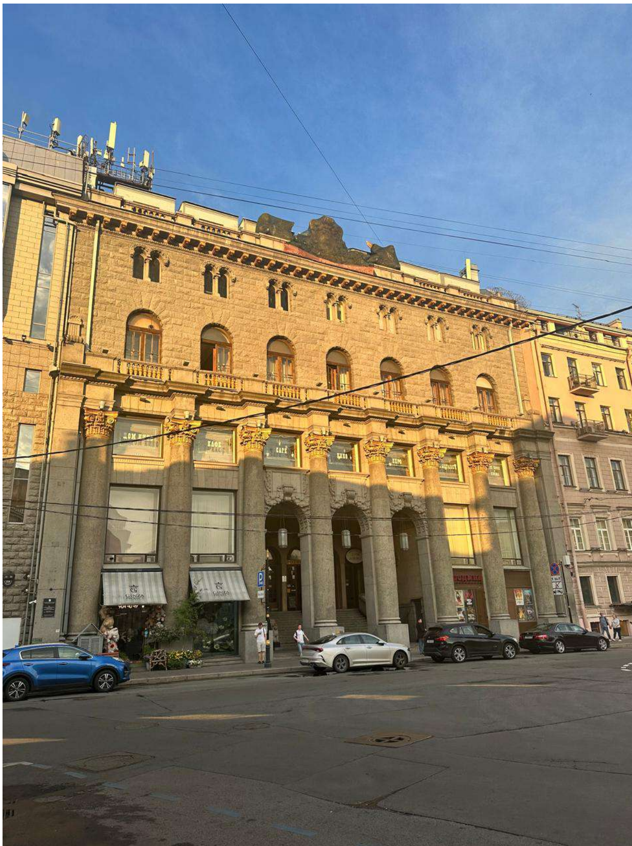
Фото 2. Общий вид лицевого фасада со стороны ул. Караванной объекта культурного наследия регионального значения «Дом Санкт–Петербургского губернского кредитного общества», расположенного по адресу: г. Санкт–Петербург, Караванная ул., 12, Фонтанки р.наб., 15.
