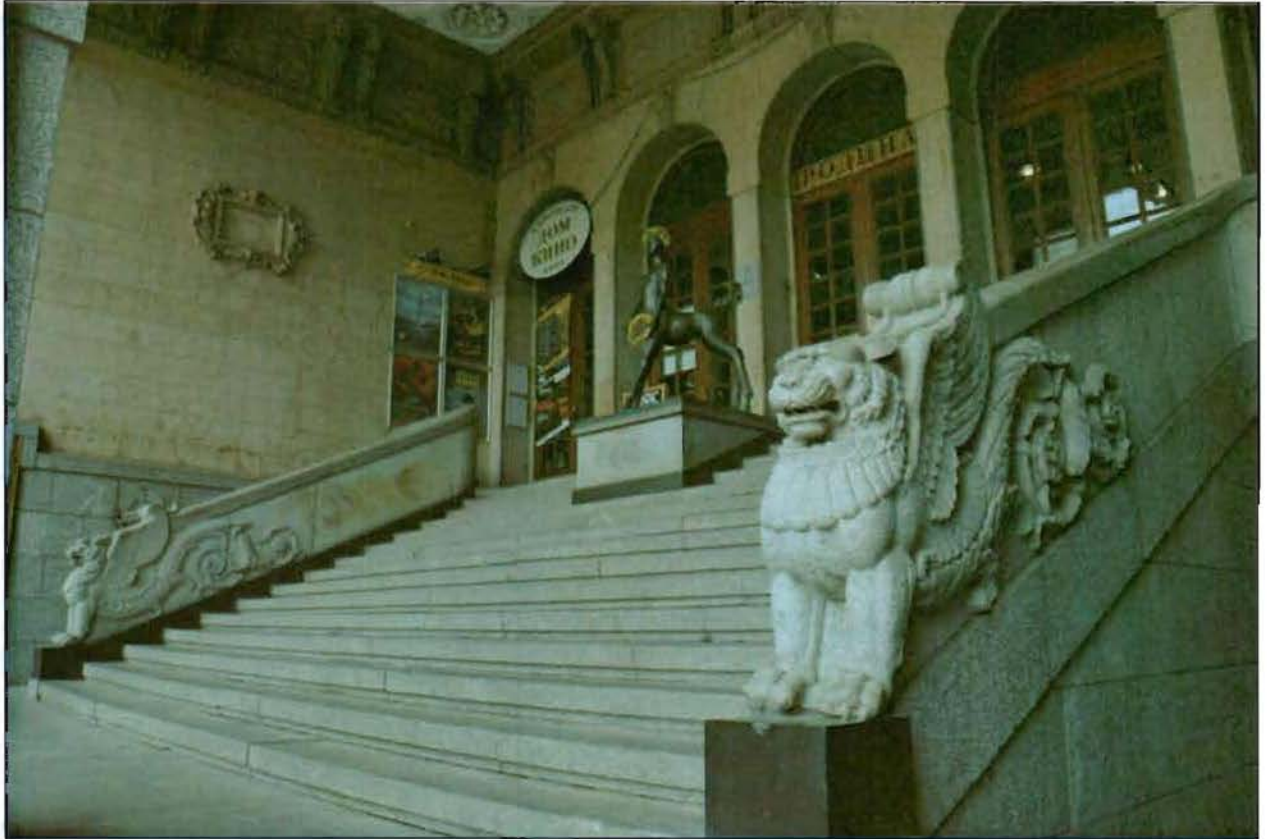
2. Лестница в лоджии (западный фасад).
