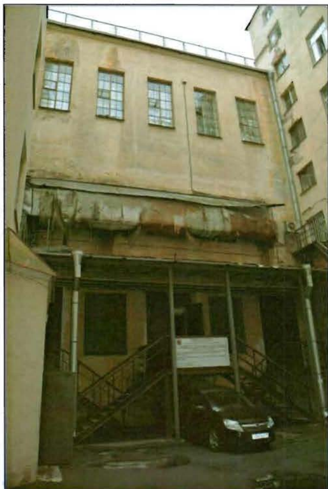
4. Западный дворовый фасад.
