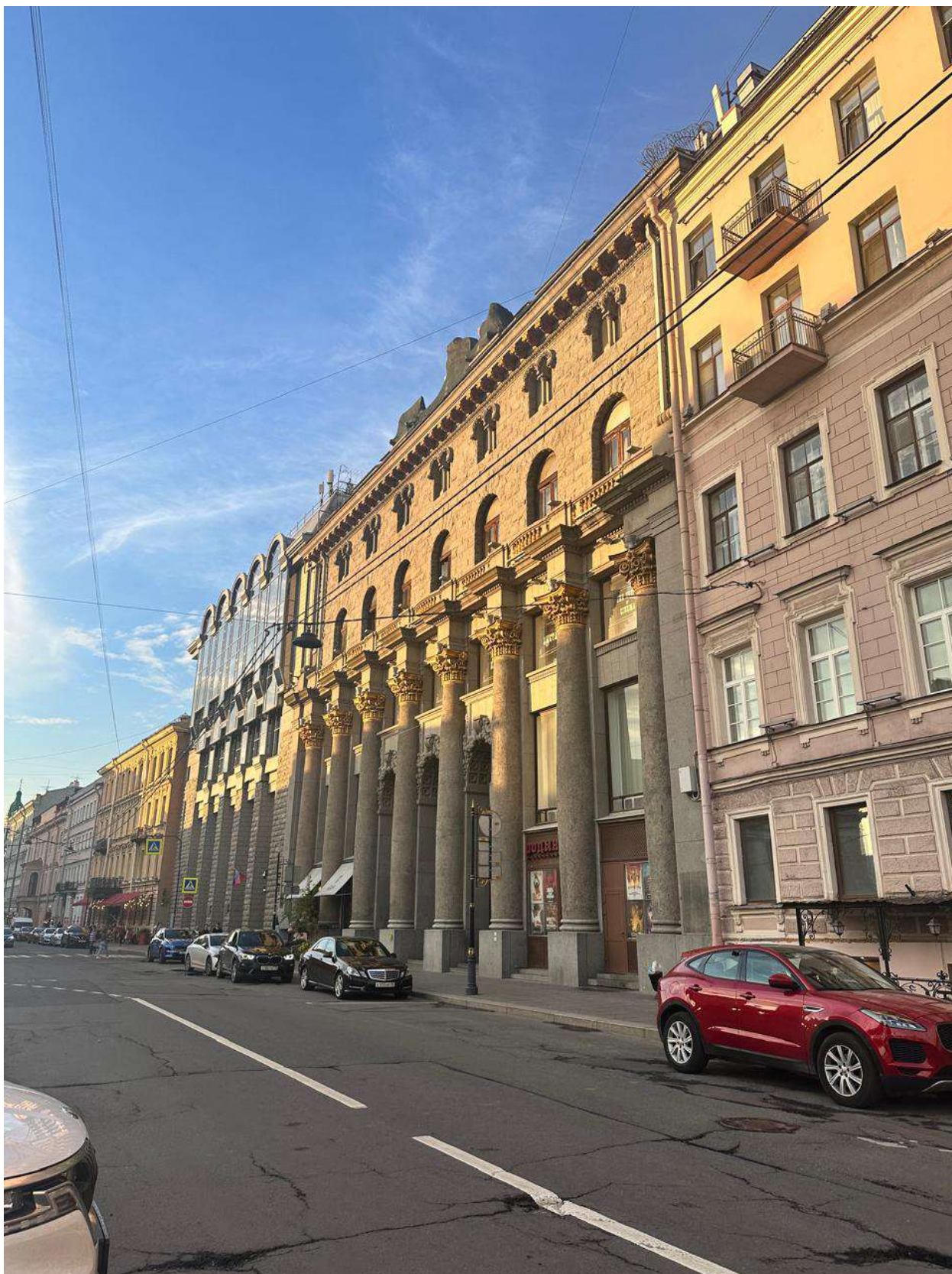
Фото 3. Общий вид лицевого фасада со стороны ул. Караванной объекта культурного наследия регионального значения «Дом Санкт–Петербургского губернского кредитного общества», расположенного по адресу: г. Санкт–Петербург, Караванная ул., 12, Фонтанки р.наб., 15.
