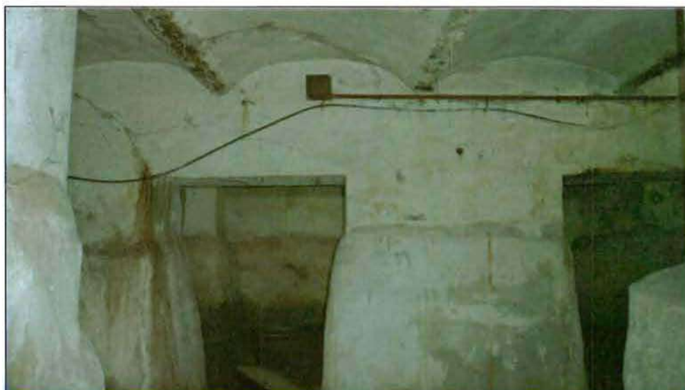
8. Прусские своды. Подвал.
